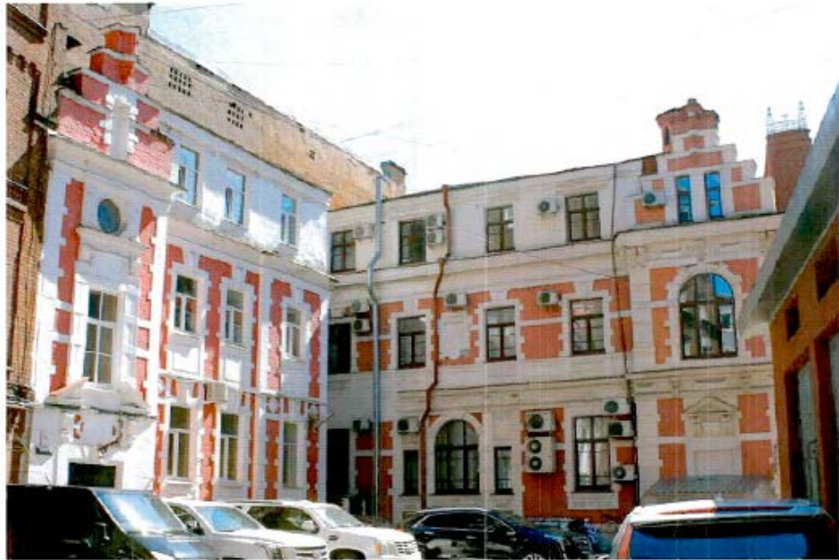
Фото №2. Вид со стороны внутреннего двора.
