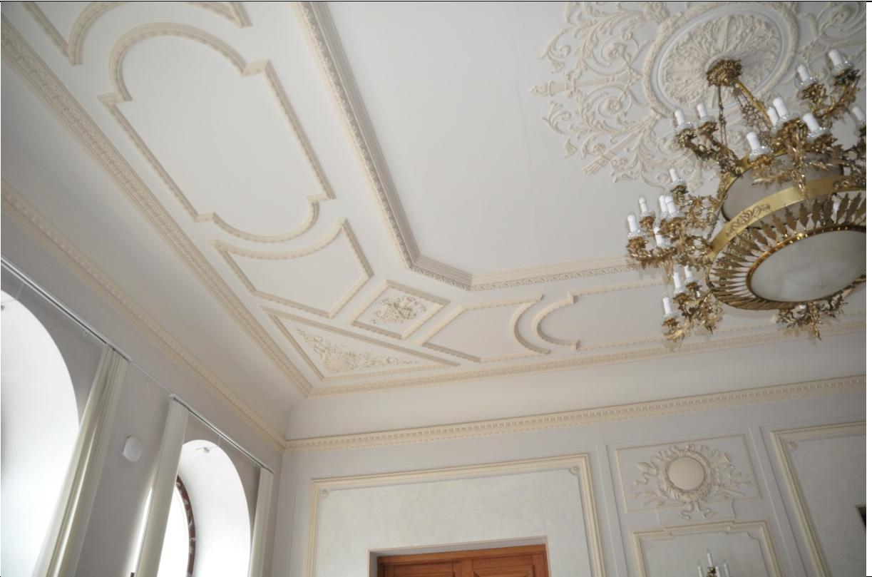
Фото 45. Помещение №8 в осях 2-3. (23.09.2020 г.)
