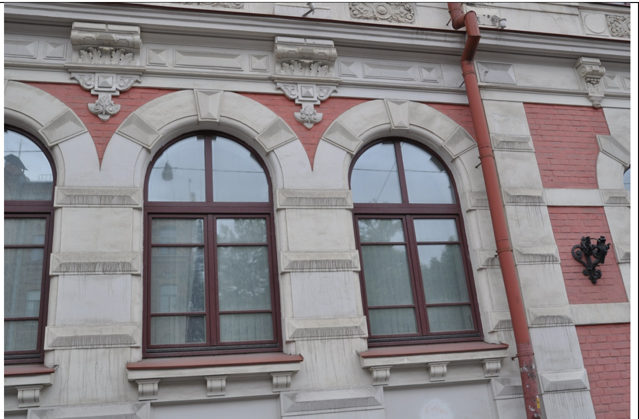
Фото 3. Фрагмент Юго-Восточного фасада на уровне первого этажа в осях 6-1 по улице Марата (23.09.2020 г.)
