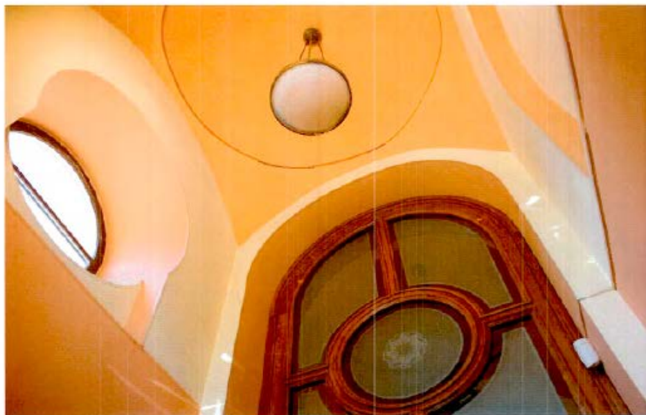
Фото №3. Тамбур главного входа.
