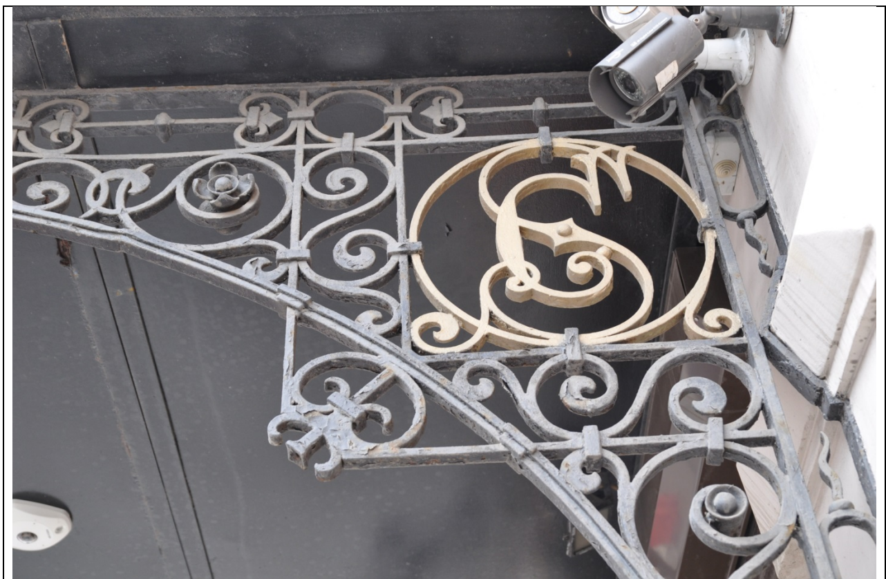
Фото 9. Фрагмент Юго-Восточного фасада на уровне первого этажа в осях 6-1 по улице Марата. Фрагмент кованого козырька(23.09.2020 г.)
