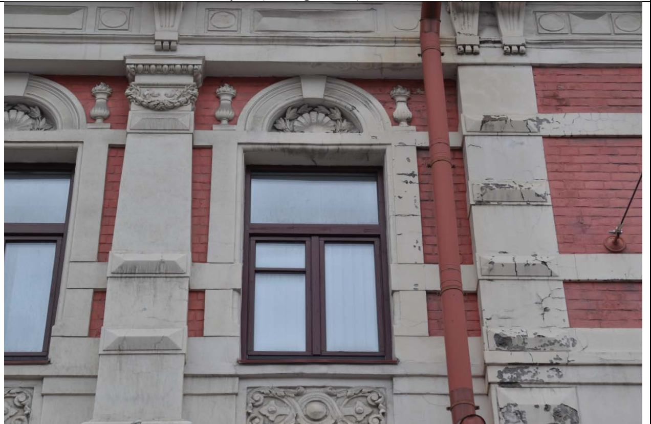
Фото 4. Фрагмент Юго-Восточного фасада на уровне второго этажа в осях 6-1 по улице Марата(23.09.2020 г.)
