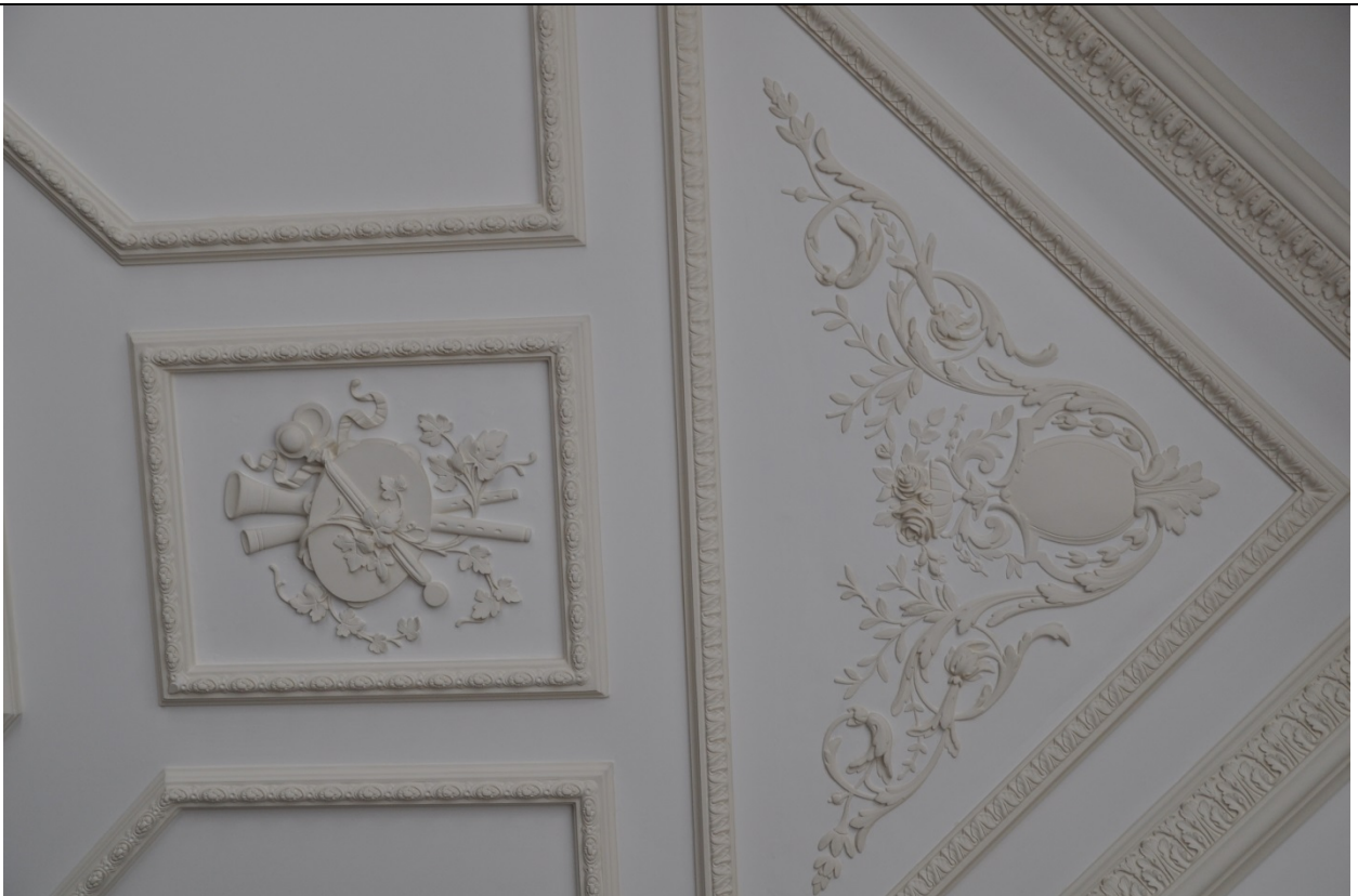
Фото 46. Помещение №8 в осях 2-3. Лепные композиции внутри филенок плафона. (23.09.2020 г.)
