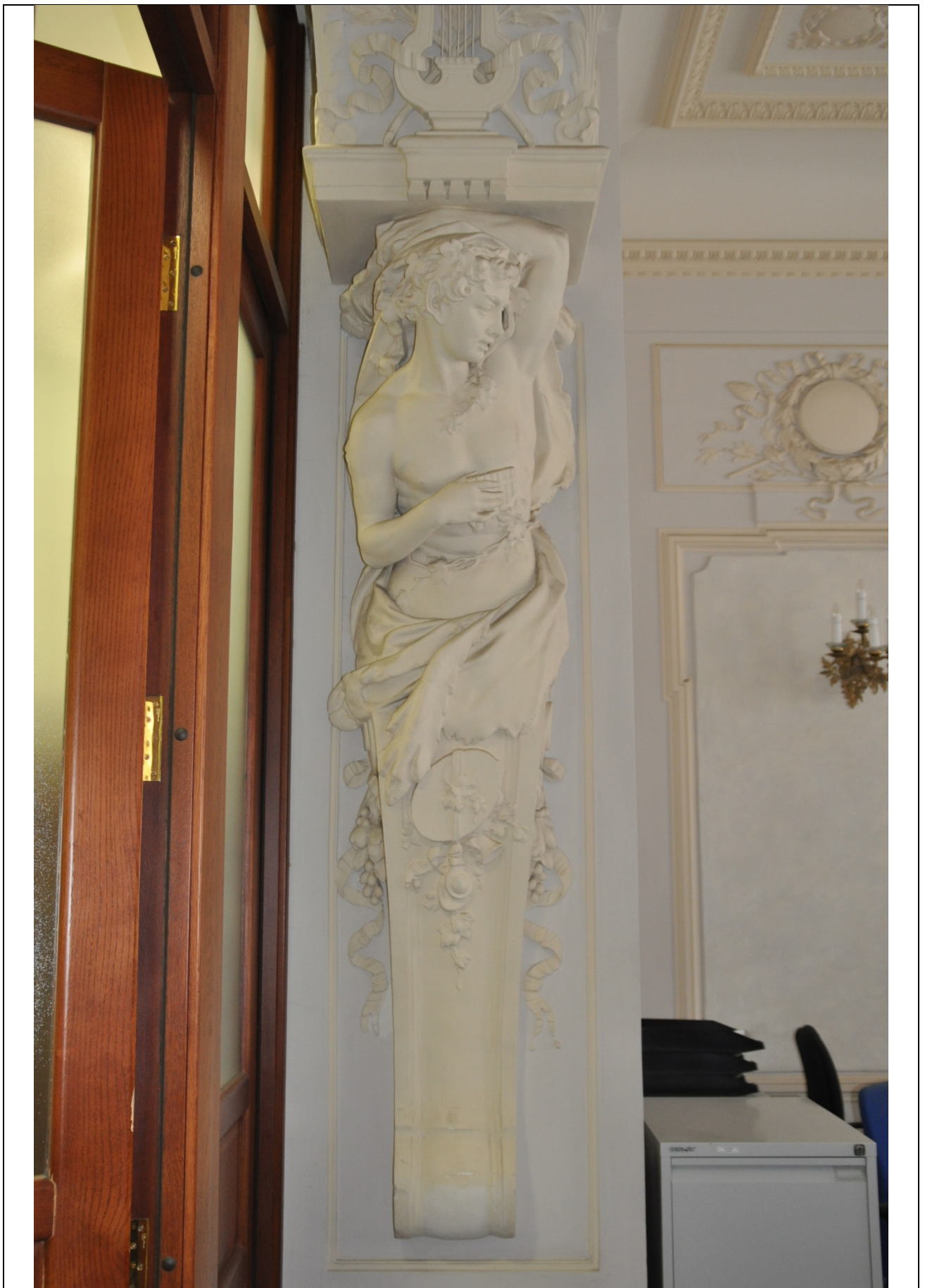
Фото 50. Помещение №8 в осях 2-3. Прямоугольный входной портал оформлен скульптурными композициями. Атлант. (23.09.2020 г.)
