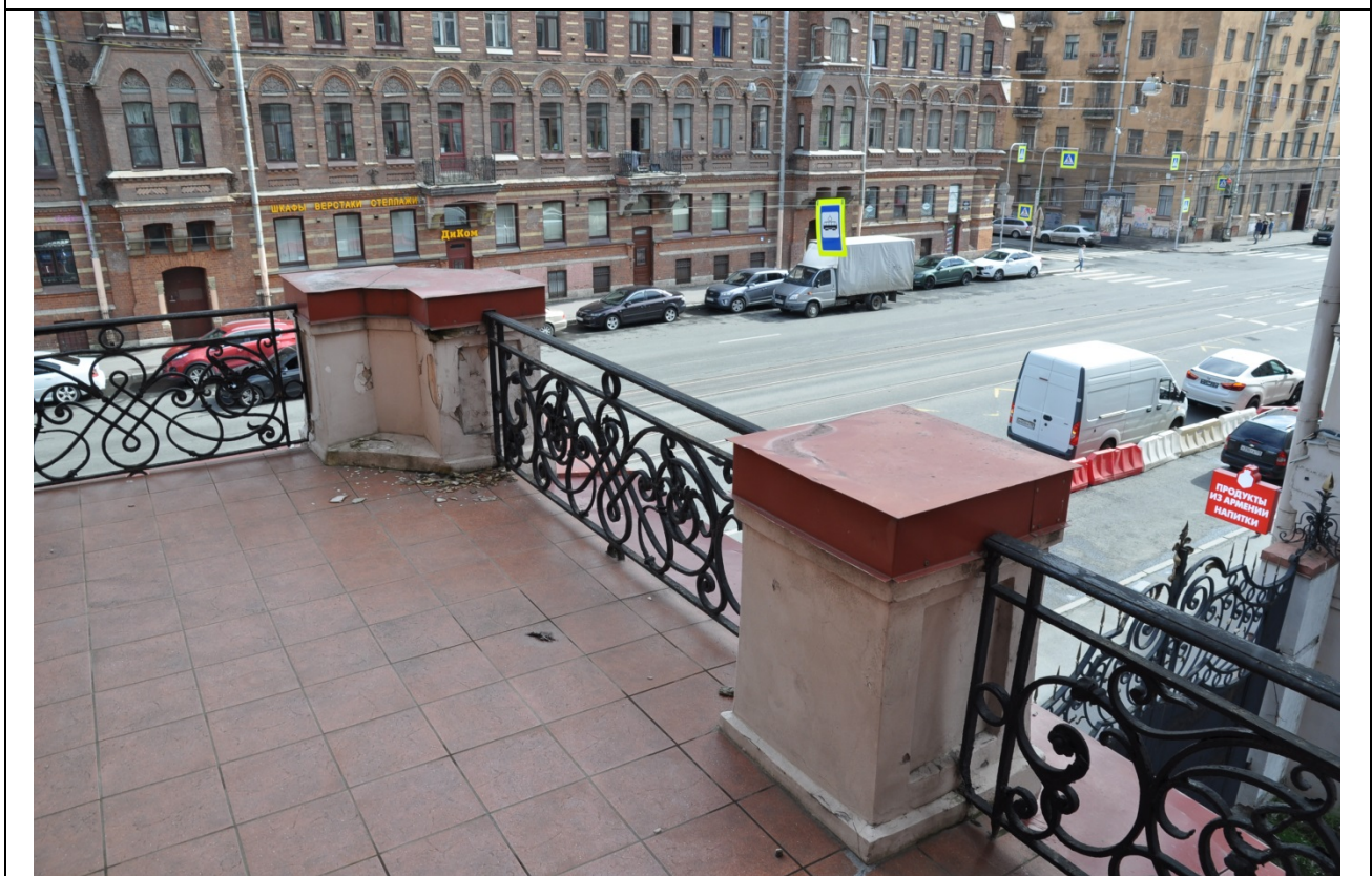
Фото 71. Вид на террасу в осях 4-5. (23.09.2020 г.)
