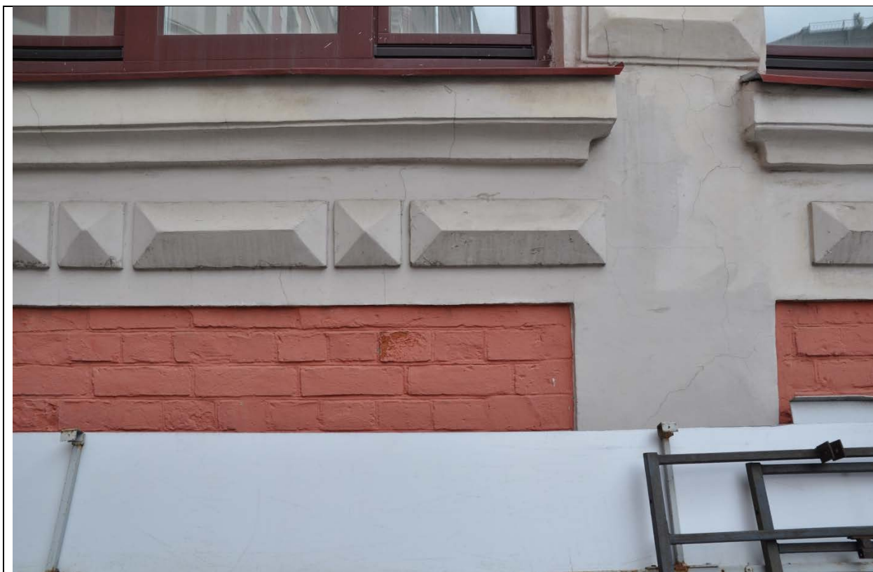
Фото 21. Фрагмент Северо-Западного фасада на уровне первого этажа в осях 1-6. (23.09.2020 г.)
