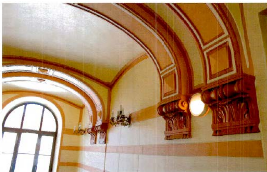
Фото №6. Перекрытие парадной лестницы.
