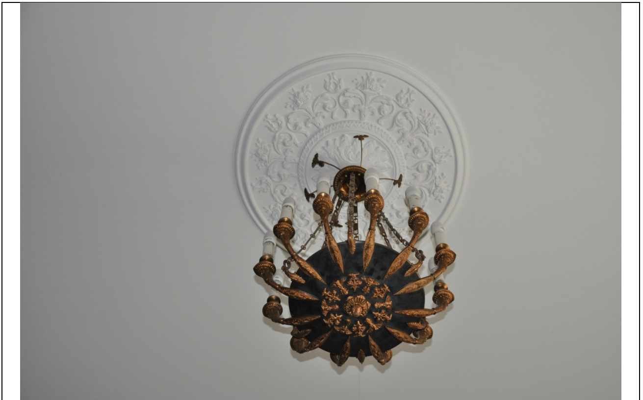
Фото 53. Помещение №7 в осях 1-2. Лепная розетка потолка(23.09.2020 г.)
