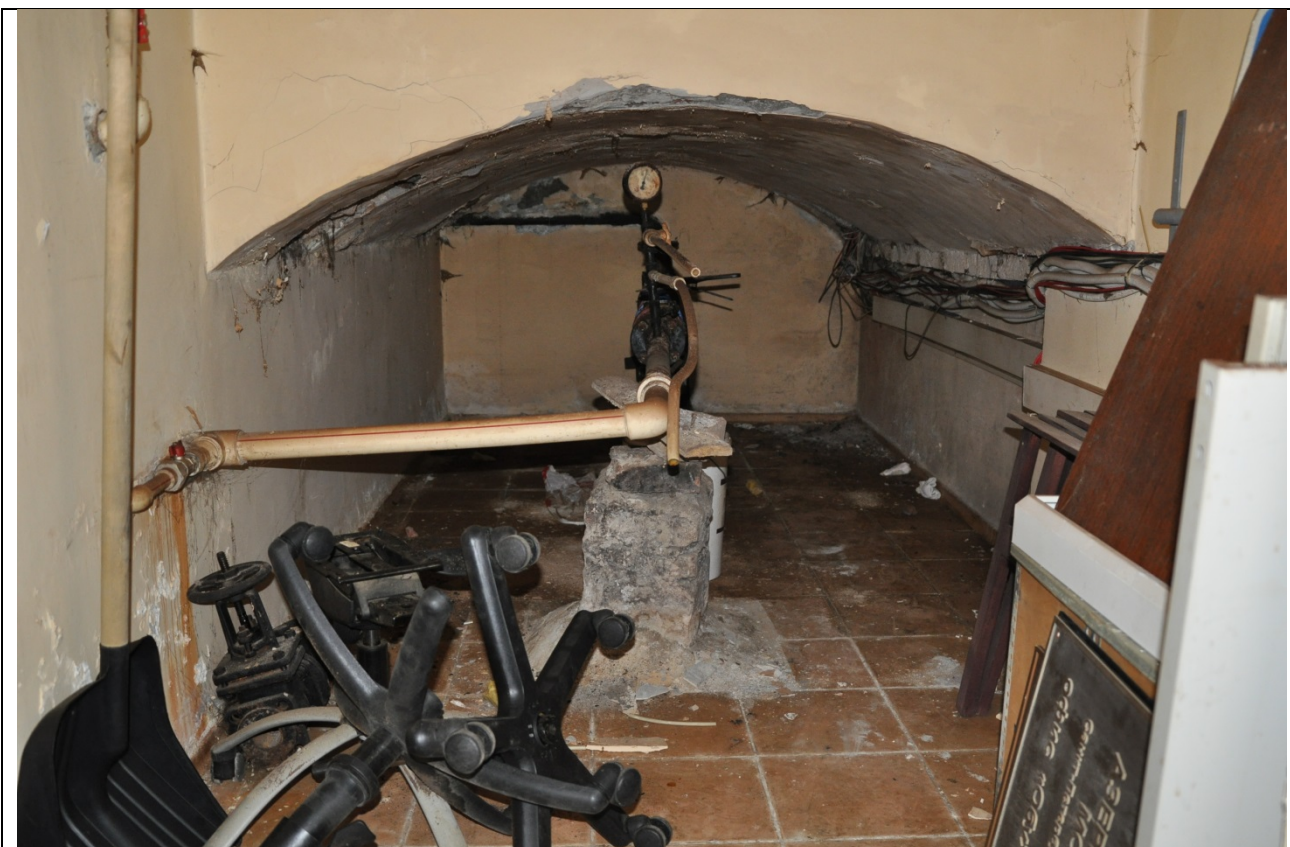
Фото 94. Помещение №33 в осях 3-5. (23.09.2020 г.)
