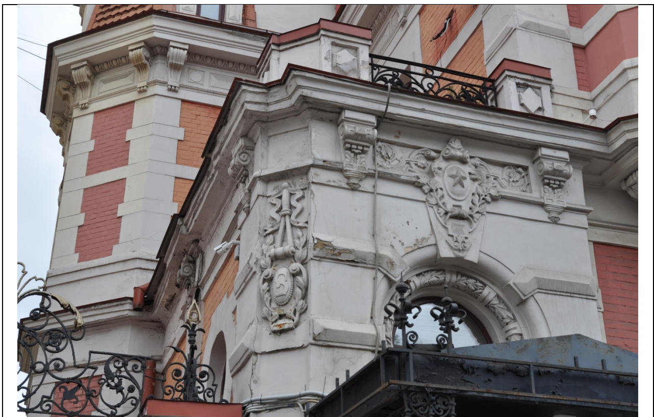
Фото 7. Фрагмент Юго-Восточного фасада на уровне второго этажа в осях 6-1 по улице Марата(23.09.2020 г.)
