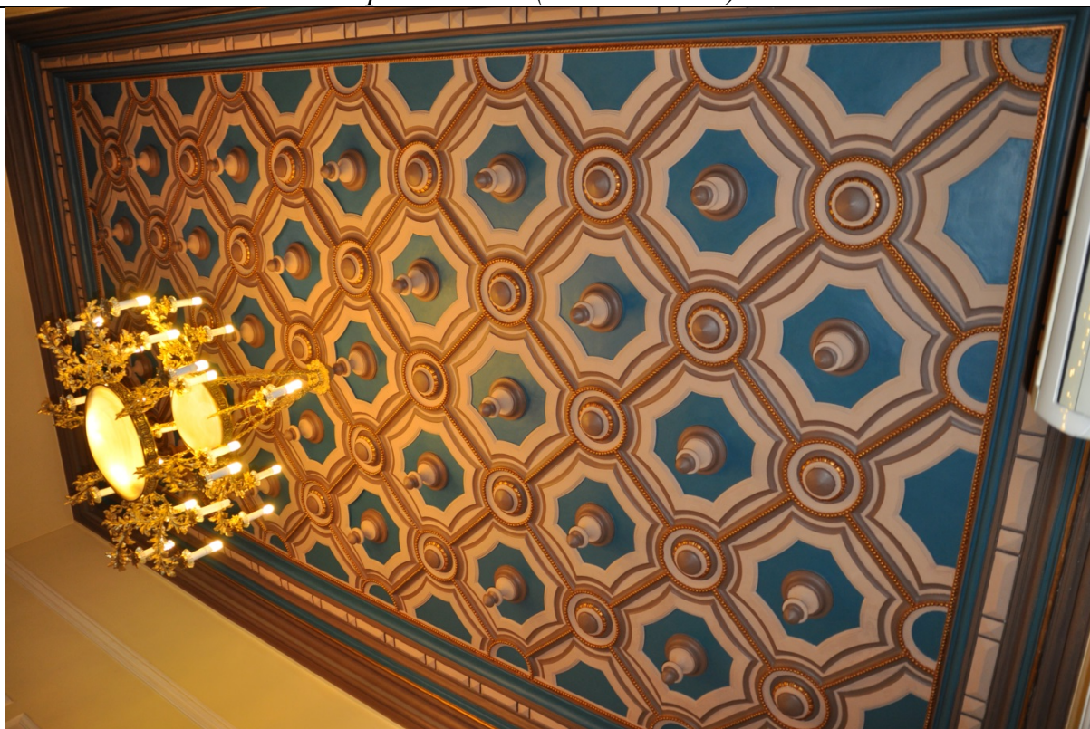
Фото 56. Помещение №9 в осях 3-4. (23.09.2020 г.)
