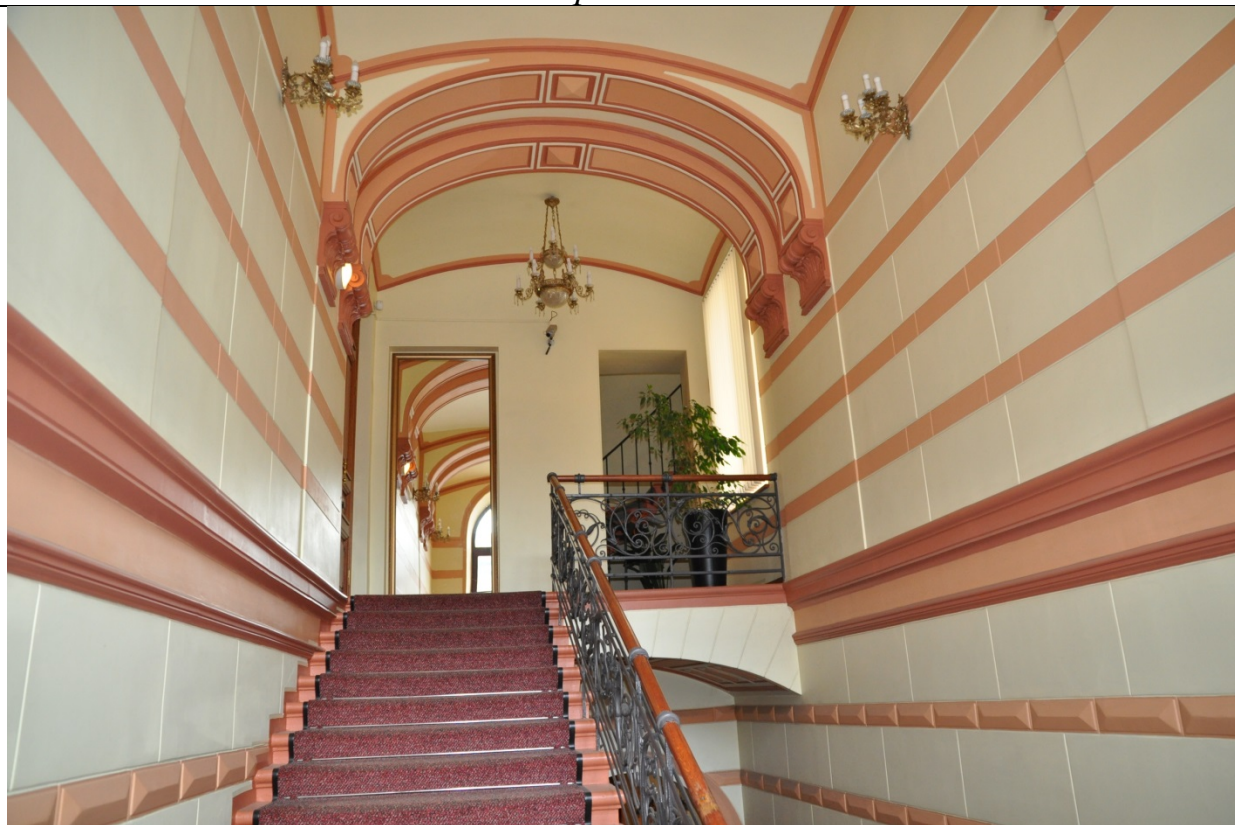
Фото 63. Вид на парадную лестницу в осях 4-5 в уровне второго этажа. (23.09.2020 г.)
