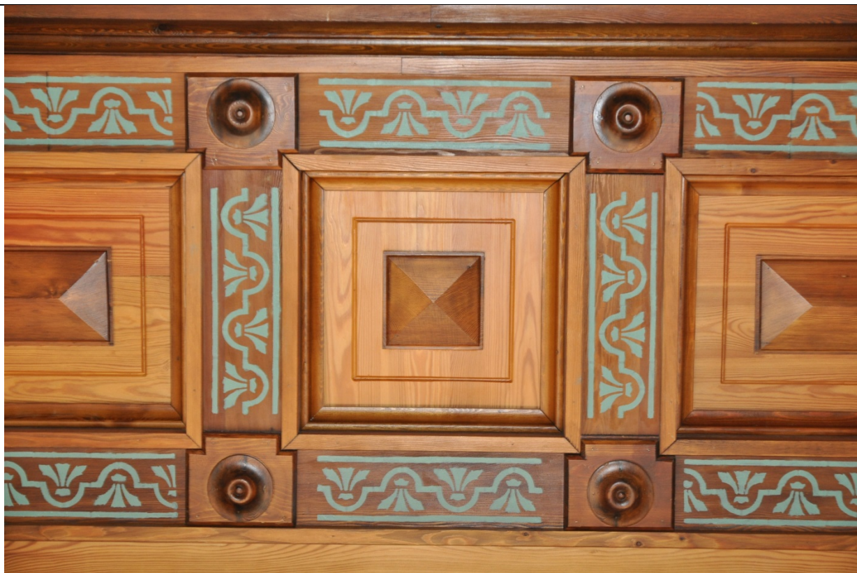
Фото 41. Помещение №3 в осях 2-3. Периметральный пояс деревянного плафона с элементами росписи(23.09.2020 г.)
