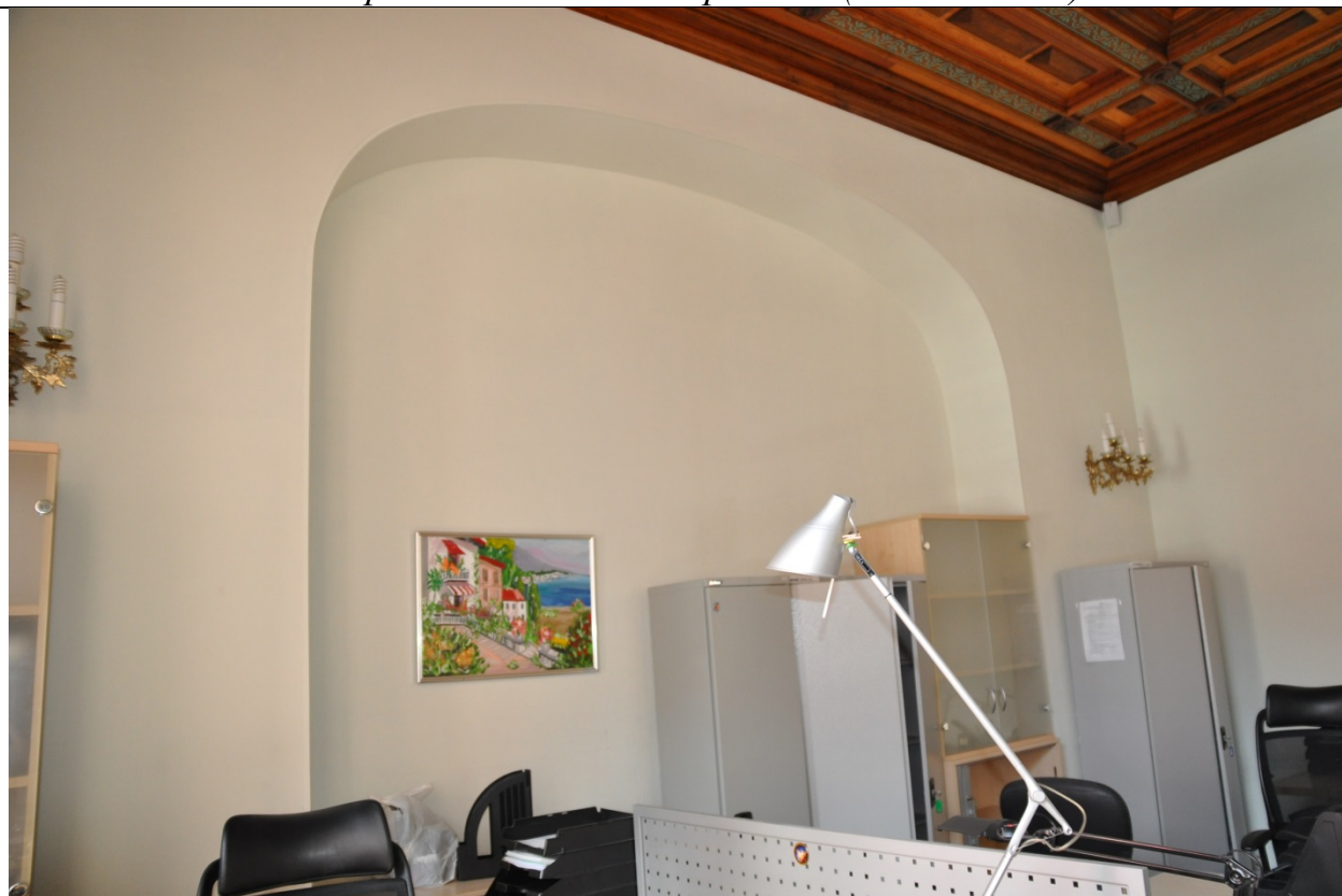
Фото 42. Помещение №3 в осях 2-3. (23.09.2020 г.)
