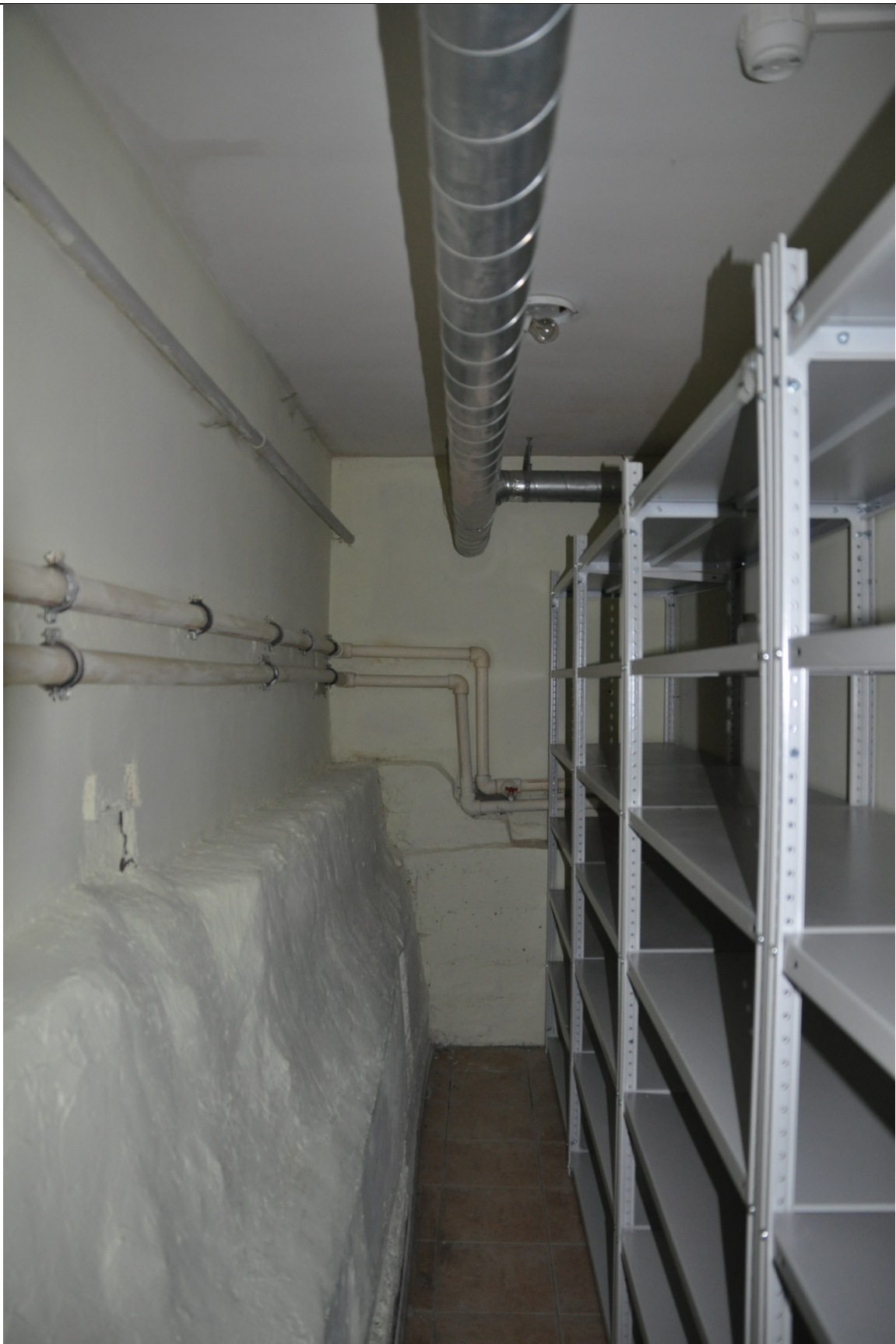
Фото 86. Помещение №25 в осях 1-2. (23.09.2020 г.)
