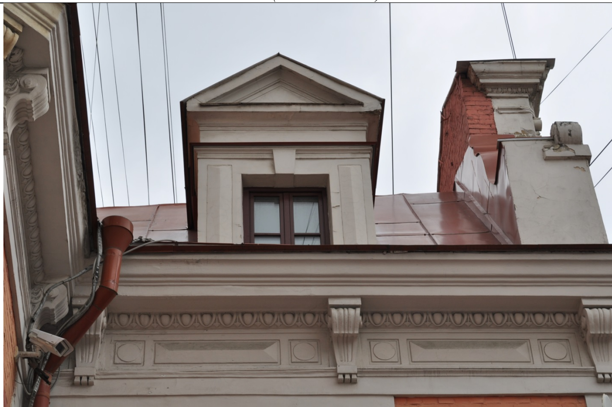
Фото 31. Фрагмент Юго-Западного фасада на уровне третьего этажа в осях В-А. (23.09.2020 г.)
