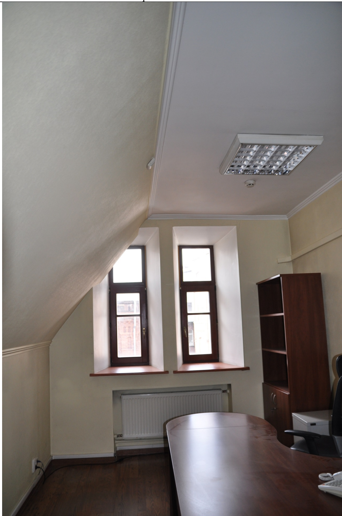
Фото 76. Помещение № 16 в осях 4-5. (23.09.2020 г.)
