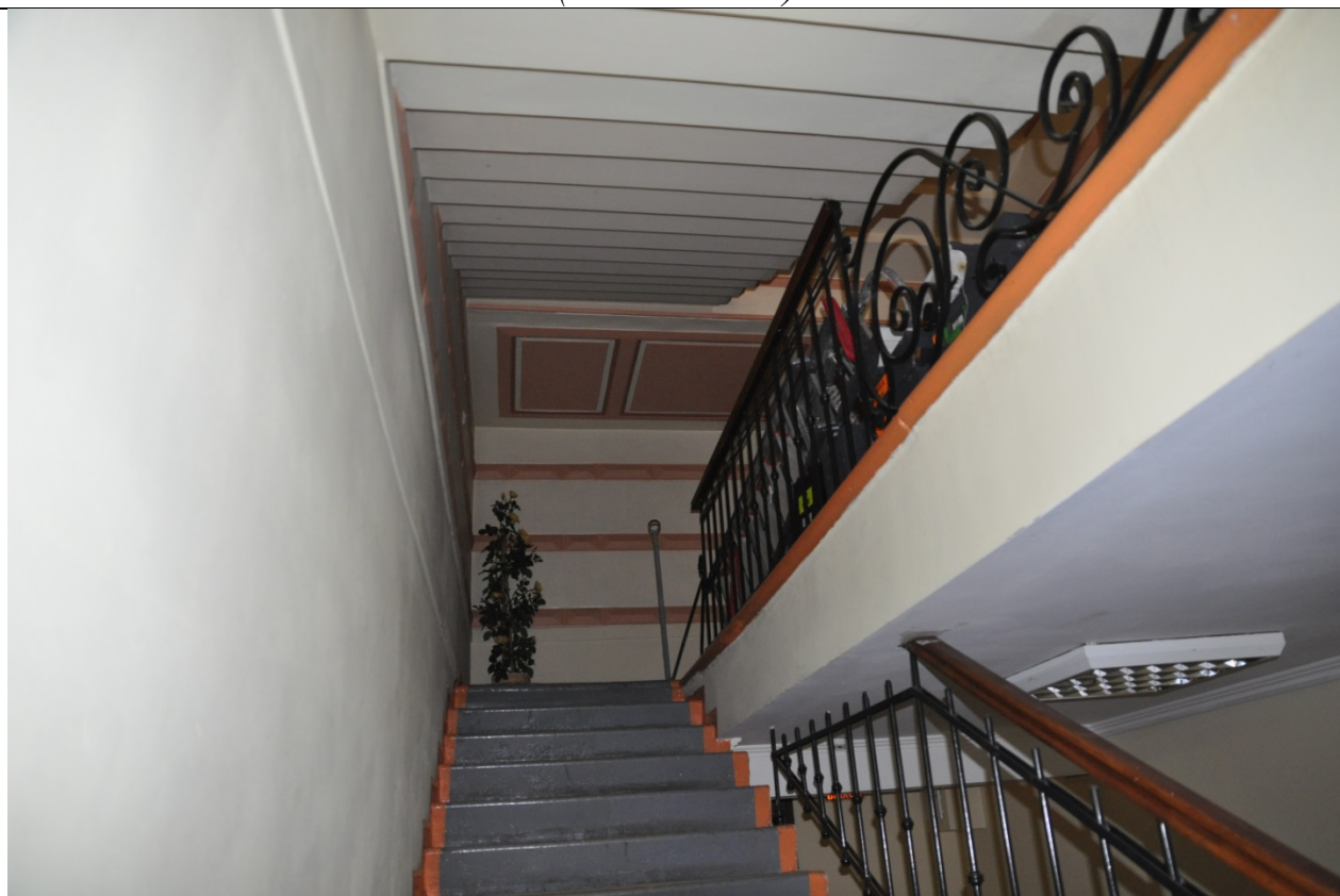
Фото 98. Лестничный марш в подвал в осях 4-5. (23.09.2020 г.)
