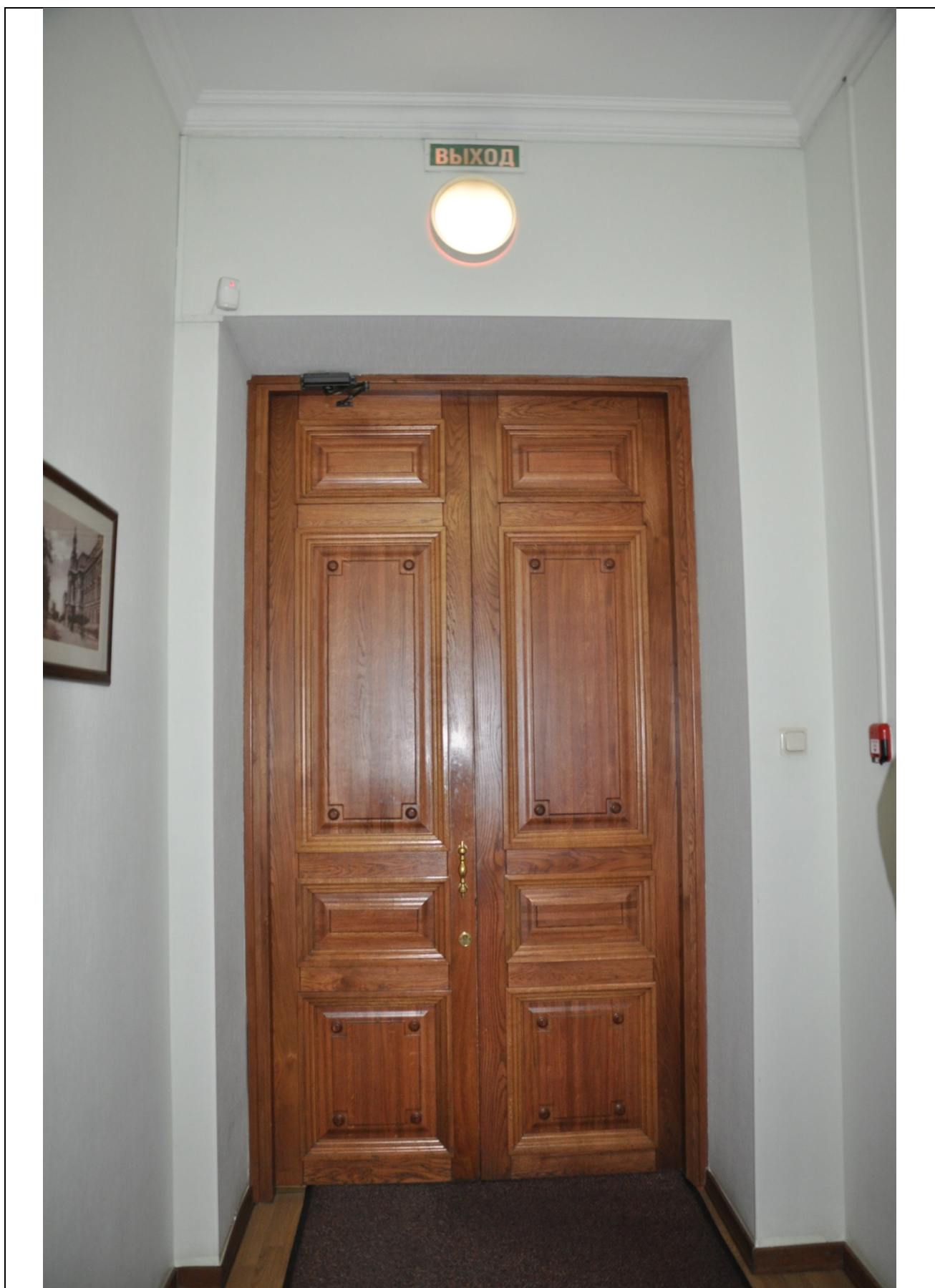
Фото 65. Коридор в осях 2-4. Входная дверь в коридор 2 этажа. Столярное двустворчатое филенчатое заполнение(23.09.2020 г.)
