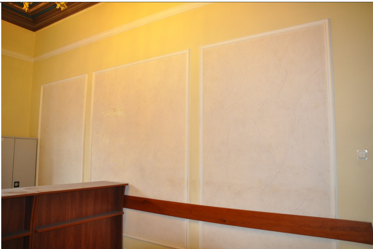
Фото 55. Помещение №9 в осях 3-4. Оформление стен прямоугольными филенками. (23.09.2020 г.)
