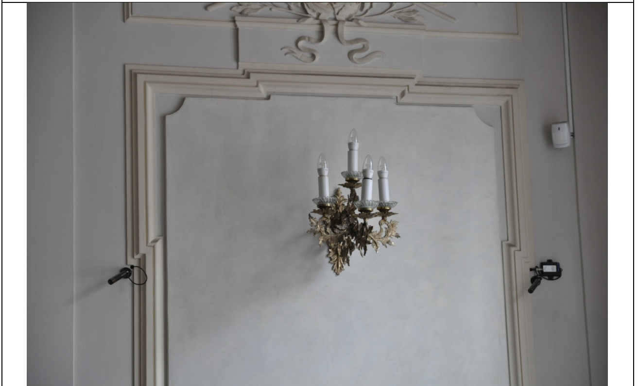
Фото 44. Помещение №8 в осях 2-3. (23.09.2020 г.)
