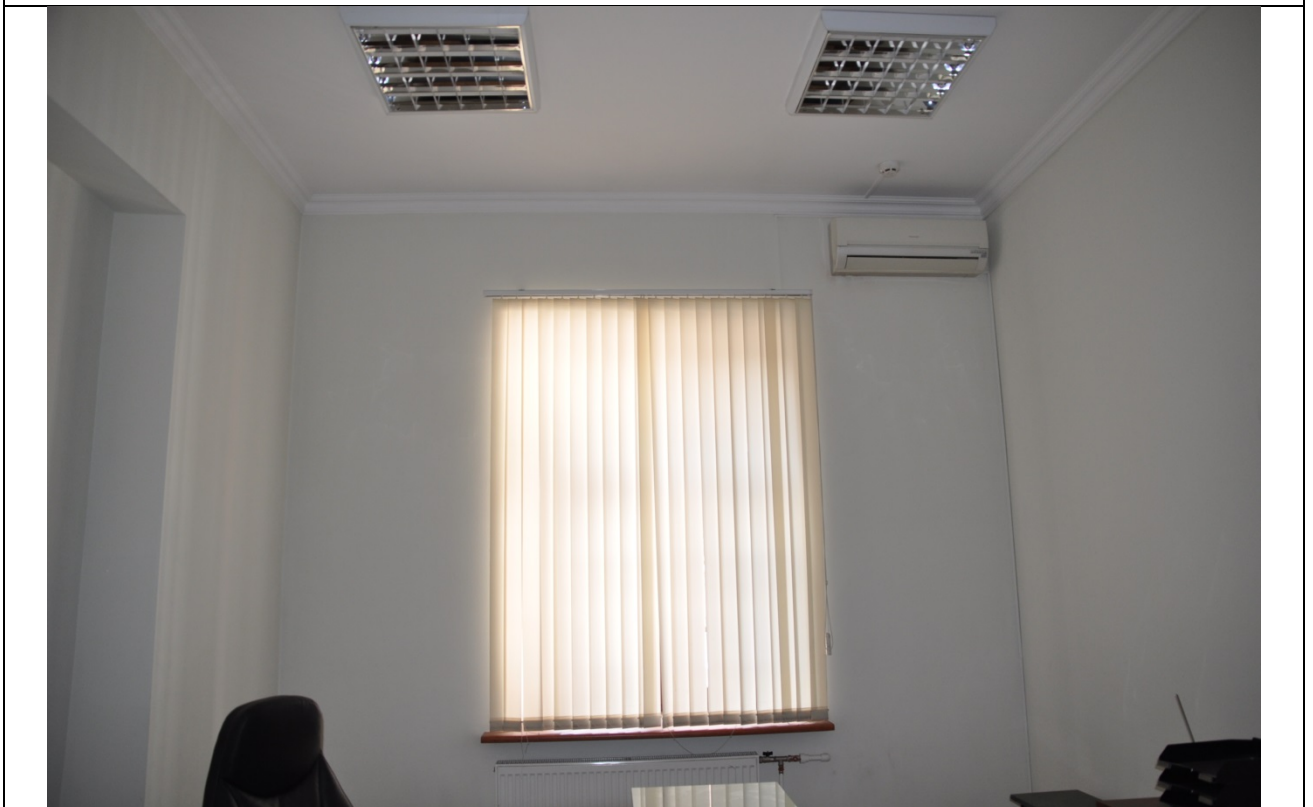
Фото 73. Помещение №10 в осях 3-4. (23.09.2020 г.)
