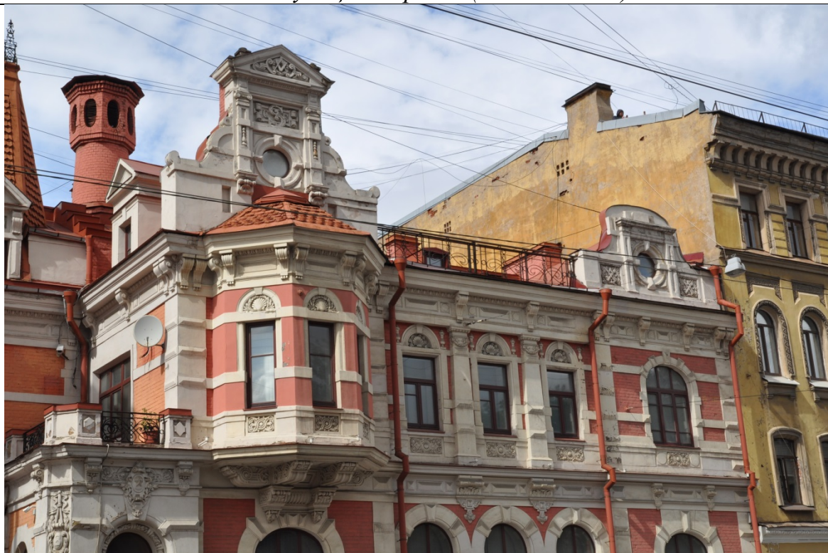
Фото 2. Фрагмент Юго-Восточного фасада на уровне второго этажа в осях 6-1 по улице Марата. (23.09.2020 г.)
