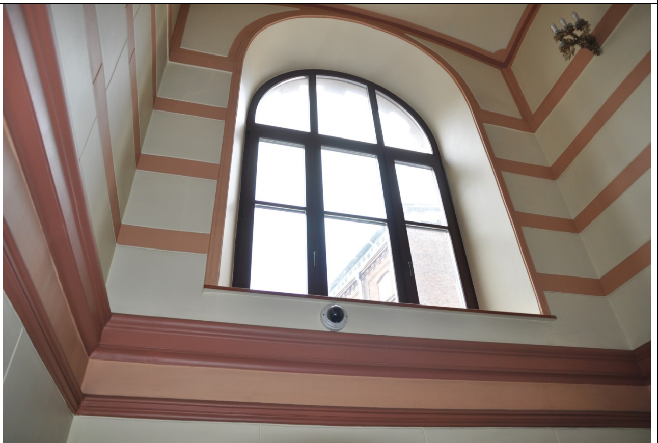
Фото 62. Вид на лестницу в осях 4-5. Оконный проем лестничной клетки. (23.09.2020 г.)
