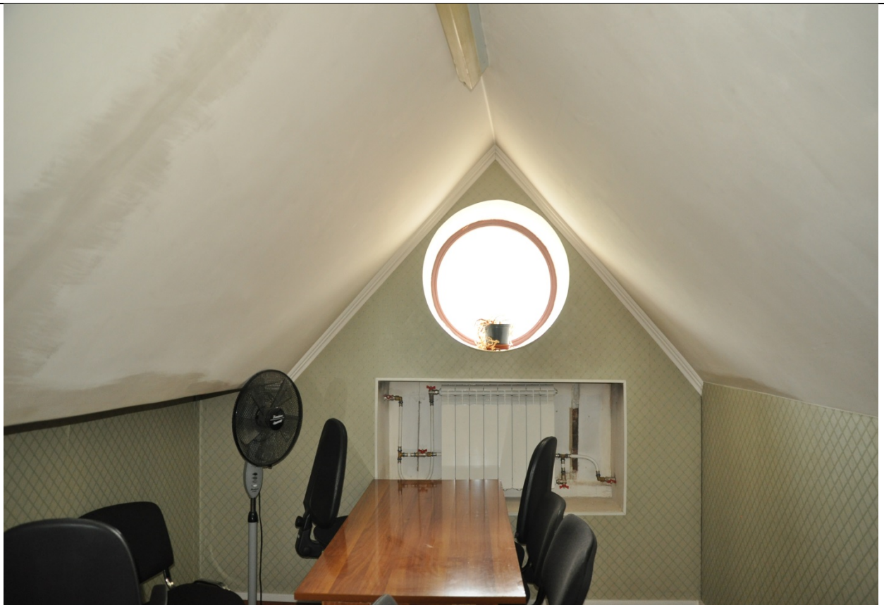
Фото 83. Помещение №22 в осях 1-3. (23.09.2020 г.)
