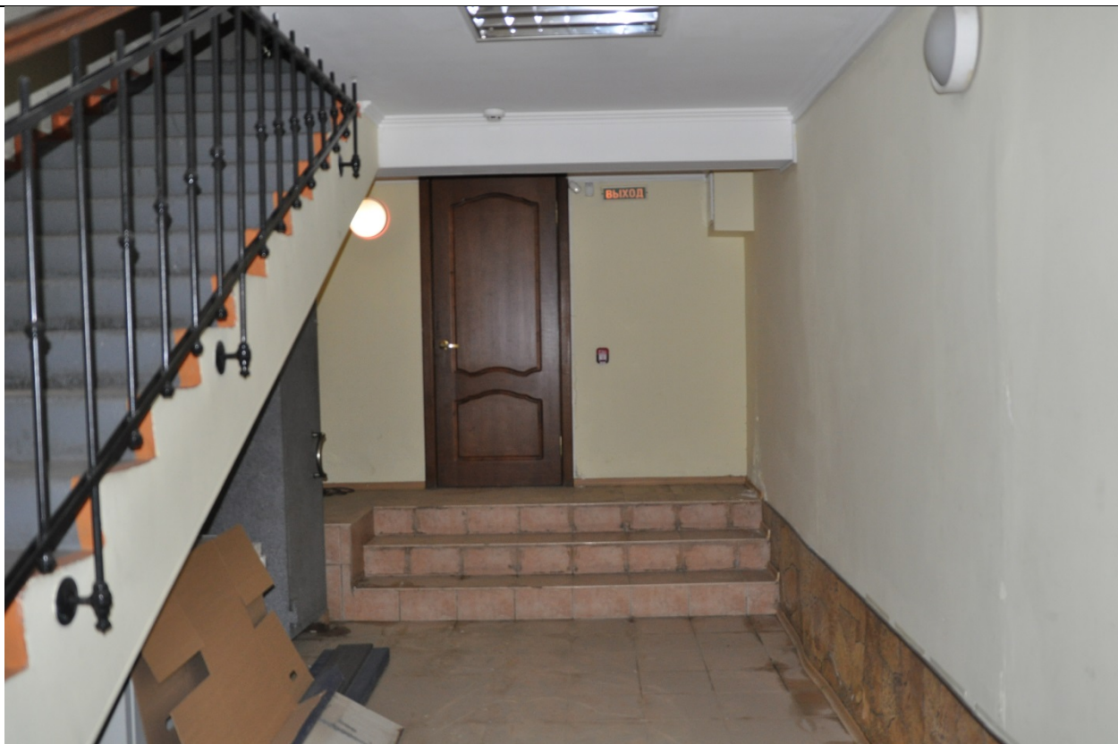
Фото 97. Подлестничное пространство в осях 4-5 – эвакуационный выход. (23.09.2020 г.)
