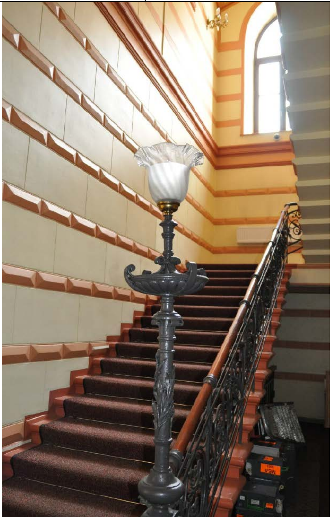
Фото 34. Вид на лестницу в осях 4-5. (23.09.2020 г.)
