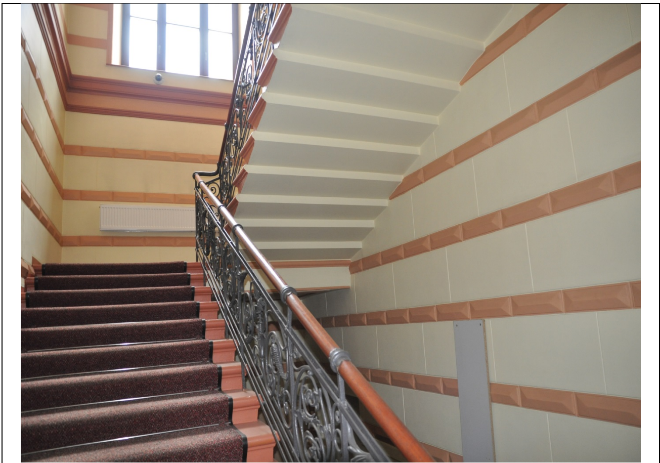
Фото 61. Вид на парадную лестницу в осях 4-5. (23.09.2020 г.)
