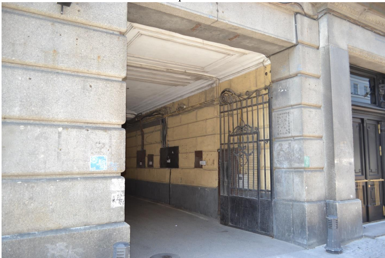
Фото 2. Лицевой фасад. Воротный проезд в первый двор-колодец. Вид с востока
