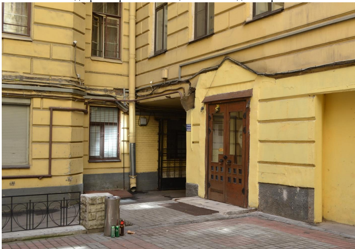
Фото 10. Угол северо-восточного и северо-западного фасадов первого двора-колодца. Южный входной проем в помещении 3-Н. Вид с северо-востока
