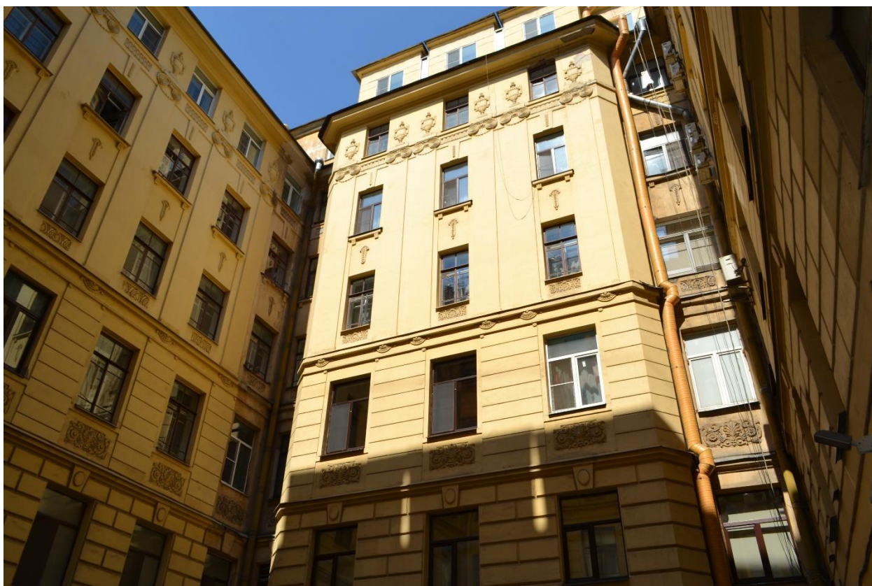
Фото 3. Юго-восточный фасад первого двора-колодца. Вид с юго-востока
