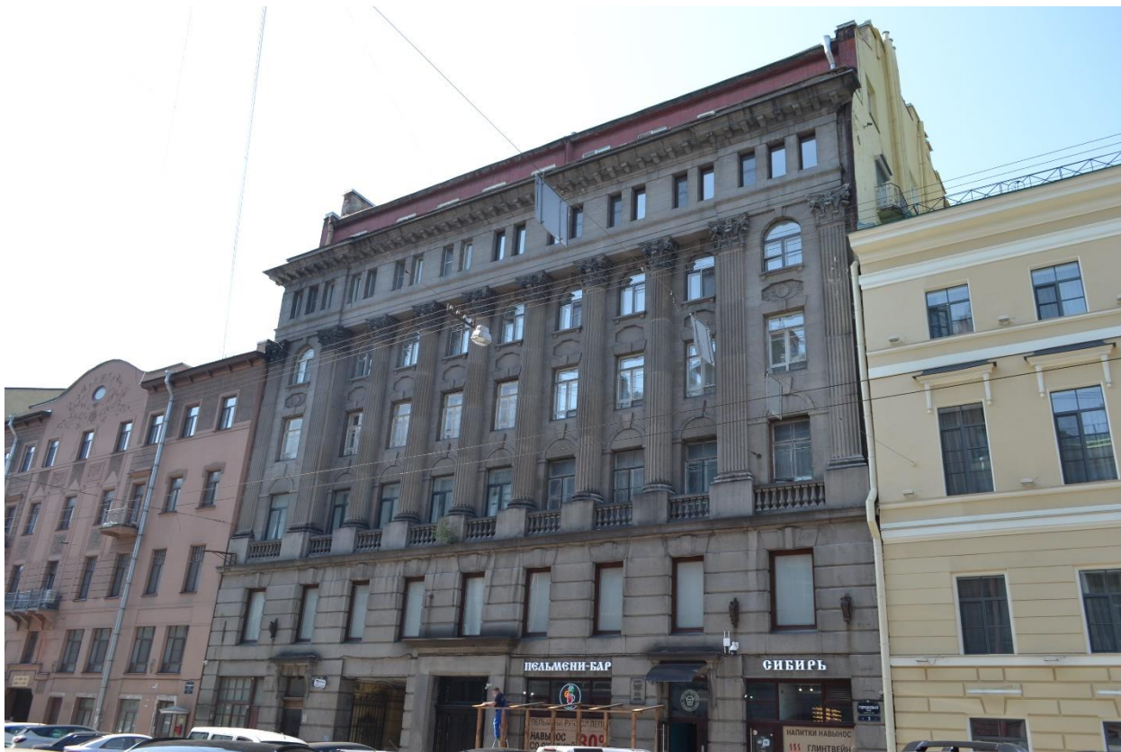
Фото 1. Лицевой фасад объекта культурного наследия регионального значения «Дом Второго Российского общества страхования от огня с флигелями», расположенного по адресу: г. Санкт-Петербург, ул. Гороховая д. 3, лит. А. Вид с северо-востока
