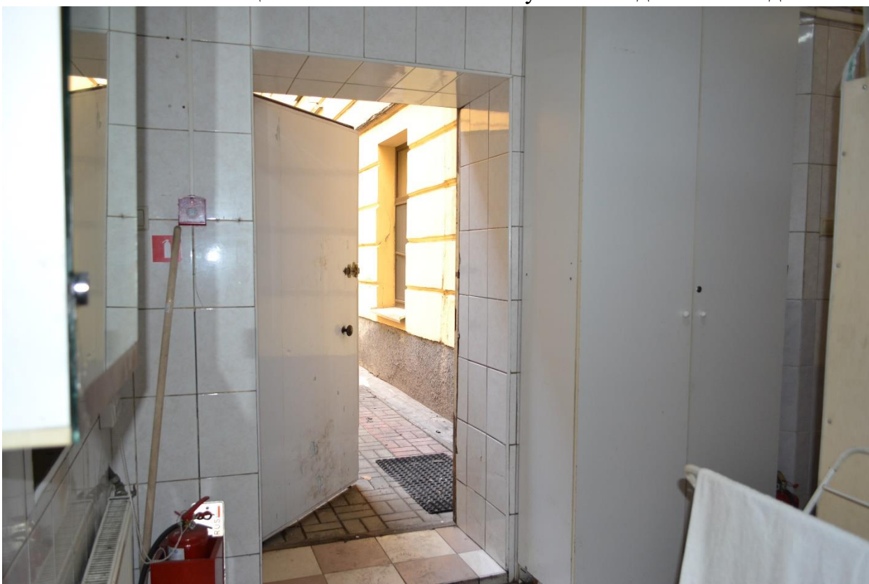
Фото 26. Помещение №10 согласно плану ПИБ. Вид с северо-запада
