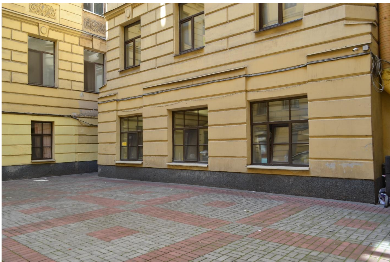
Фото 5. Угол юго-восточного и северо-восточного фасадов первого двора-колодца. Оконные проемы помещения 3-Н. Вид с юго-востока
