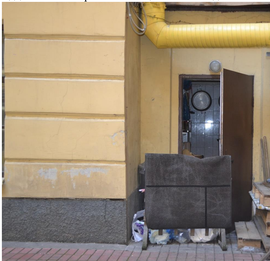
Фото 6. Восточный входной проем в помещение 3-Н. Вид с юго-востока
