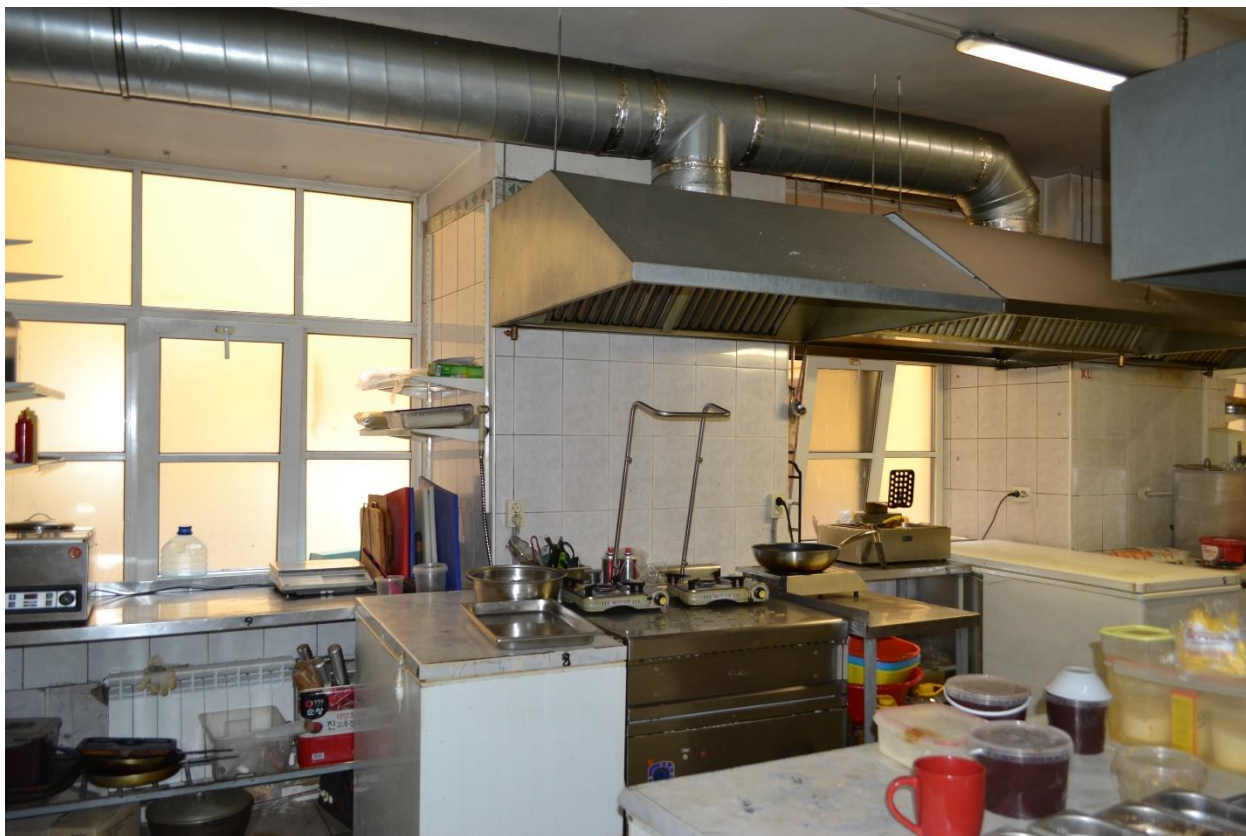
Фото 27. Помещение №12, №13 согласно плану ПИБ. Вид с северо-запада
