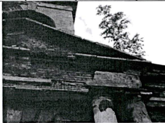
8. Фрагмент юго-западного фасада
