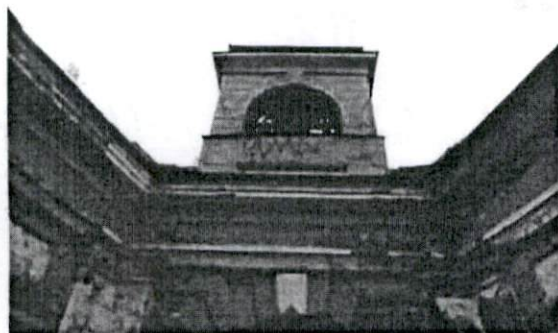
3. Фрагмент северо-восточного фасада
