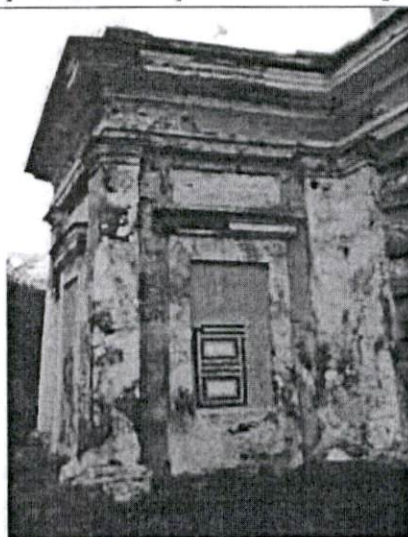
5. Фрагмент северо-восточного фасада
