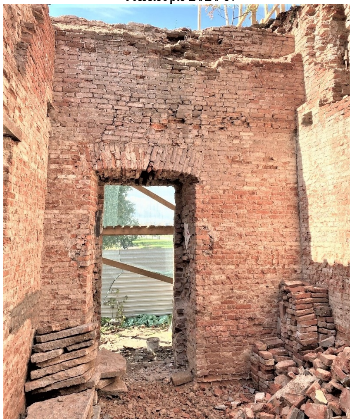
23. Объект культурного наследия регионального значения «Александровские ворота Охтинских пороховых заводов» по адресу: г. Санкт-Петербург, Химиков ул., д. 20 сооружение 1, Литера А. Вид внутренних помещений. Фрагмент. Дата съемки: 30 сентября 2020 г.
