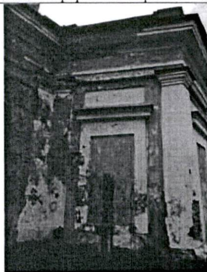
6. Фрагмент северо-восточного фасада
