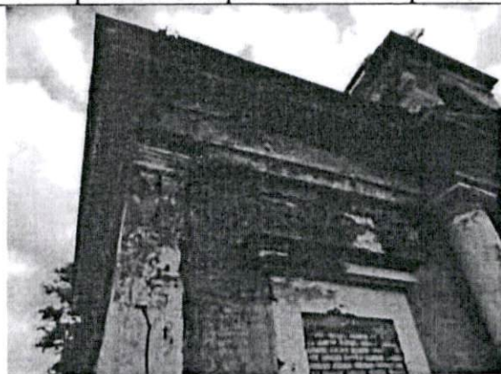
7. Фрагмент юго-западного фасада
