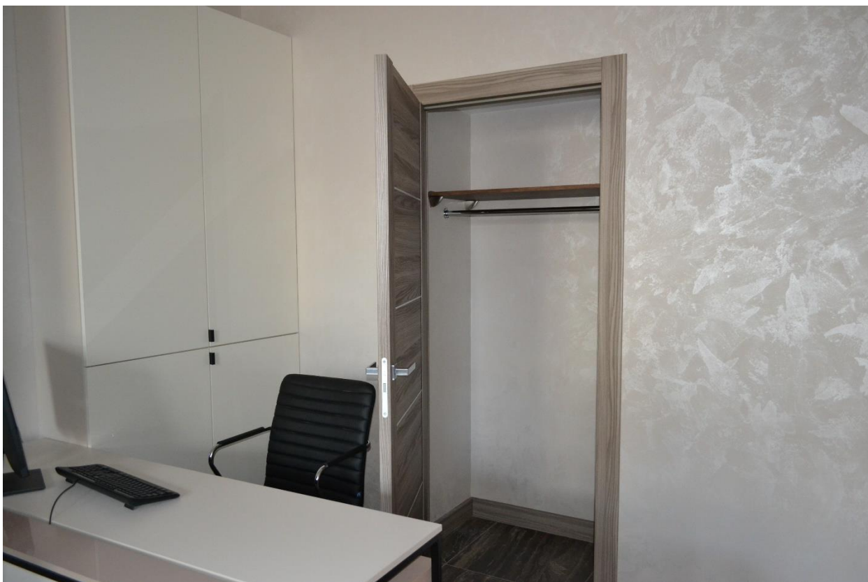
Фото 13. Встроенный шкаф в бывшем дверном проеме помещения №5 – комната.
