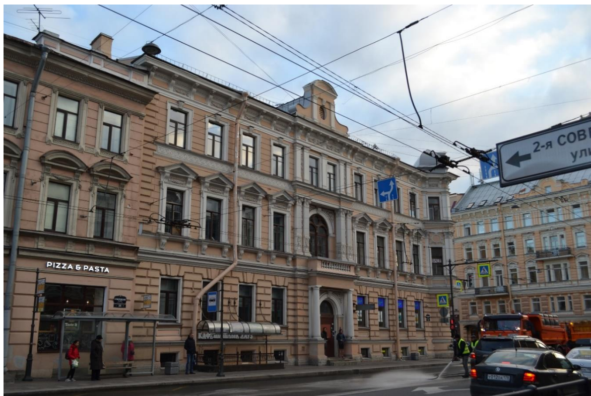
Фото 2. Лицевой (северо-западный) фасад. Вид с северо-запада.
