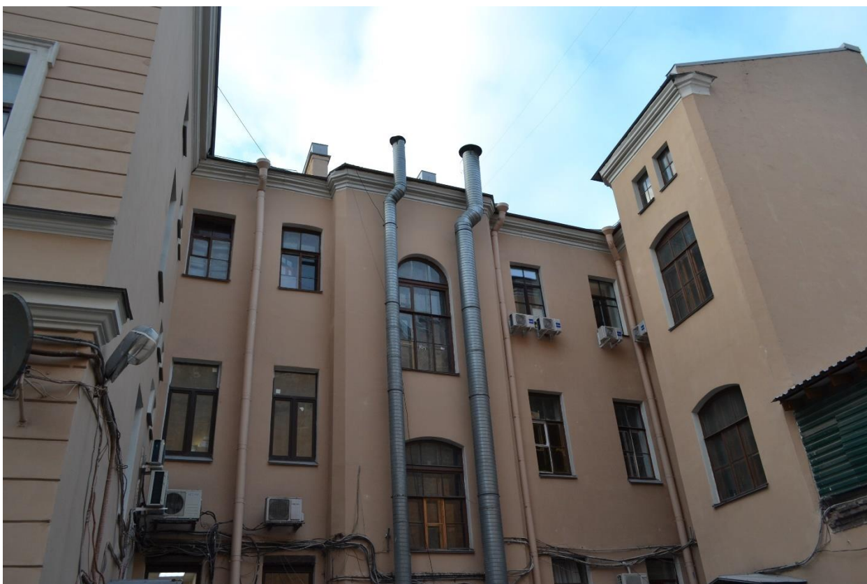
Фото 4. Дворовой фасад. Вид с юго-востока.
