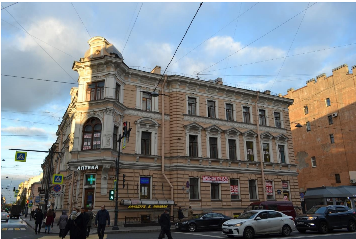
Фото 3. Лицевой (юго-западный) фасад. Вид с юго-запада.
