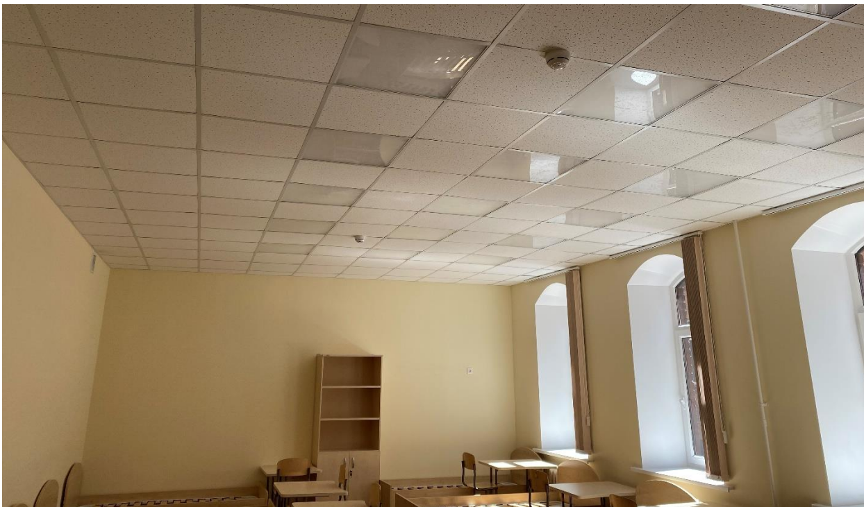
Фото 20. Нежилое помещение 6Н. Помещение № 5 согласно техническому паспорту. Вид с северо-запада
