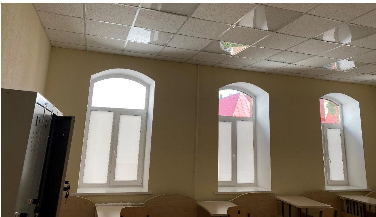
Фото 18. Нежилое помещение 6Н. Помещение № 4 согласно техническому паспорту. Вид с юго-запада
