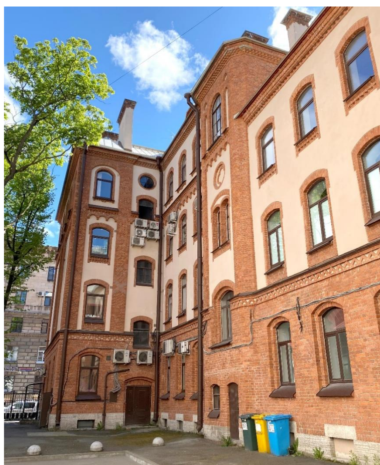
Фото 4. Дворовые фасады. Вид с северо-запада
