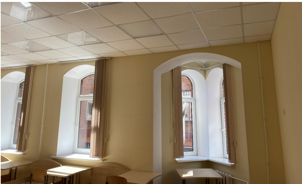
Фото 21. Нежилое помещение 6Н. Помещение № 5 согласно техническому паспорту. Вид с северо-востока
