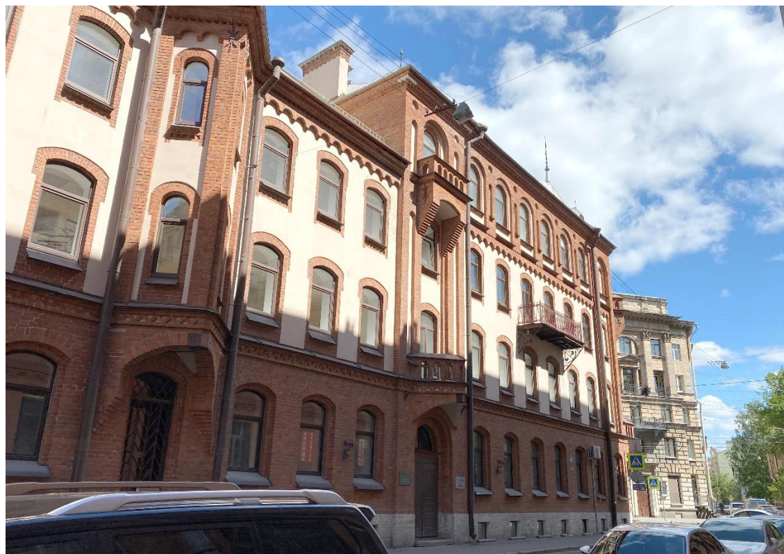
Фото 2. Юго-западный лицевой фасад. Вид с запада
