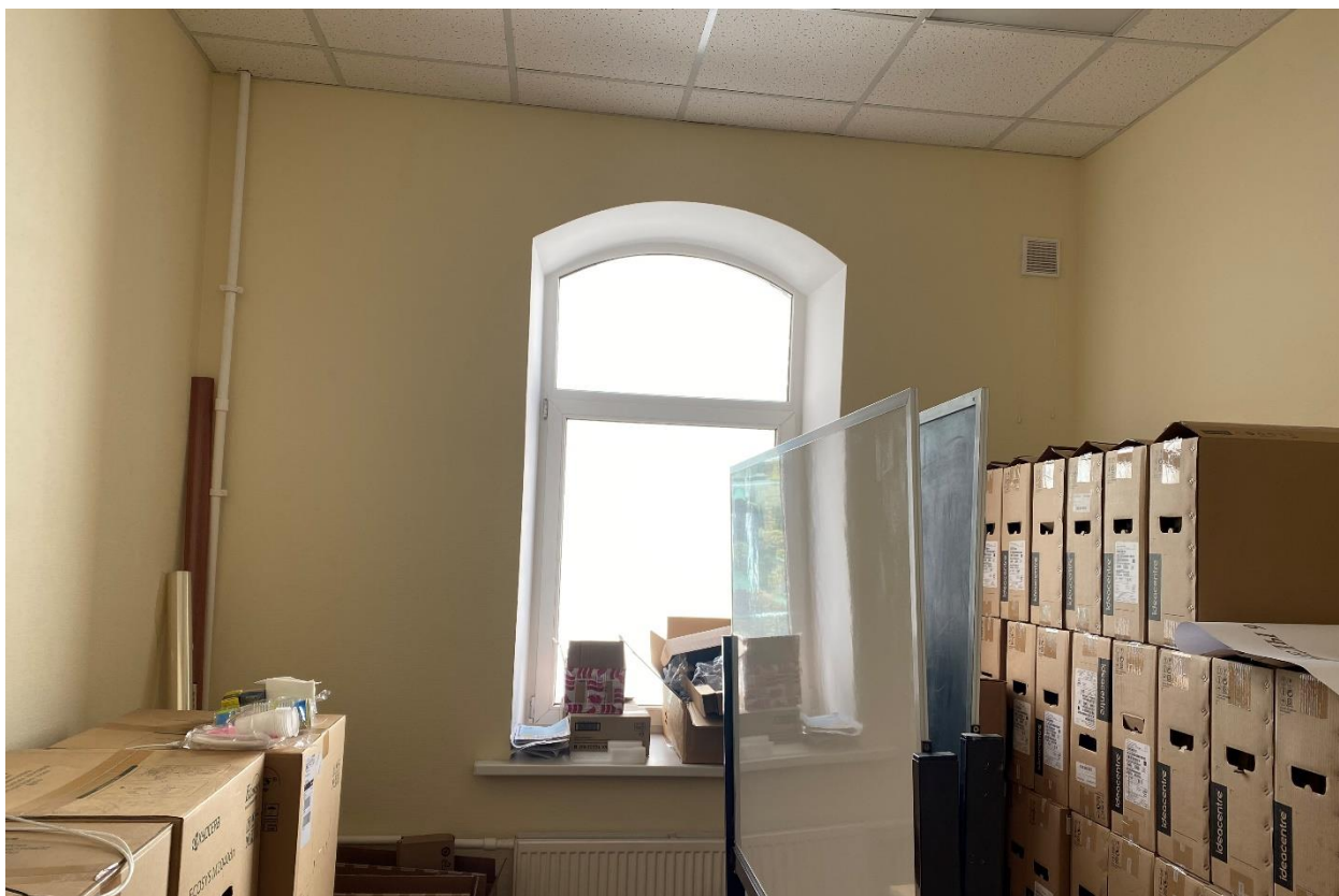
Фото 7. Нежилое помещение бН. Помещение № 12 согласно техническому паспорту. Вид с юго-запада
