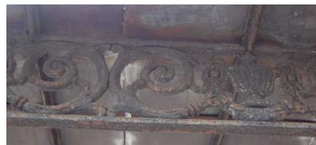
один флагодержатель – материал (металл), техника исполнения (ковка), конструкция (в виде волютообразного кронштейна);
