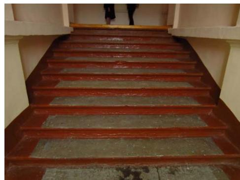
две лестницы в северном и южном крыльях – тип (двухмаршевые), ступени (из путиловской плиты), конструкция (с опорой на стены и два пилон в начале и конце маршей), ограждение – материал (металл), техника исполнения (ковка), конструкция (отдельные вертикальные стержни).
