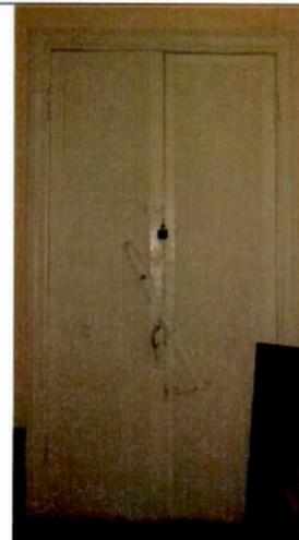
помещение 1Н (54): два дверных проема - конфигурация, местоположение и габариты; историческое заполнение дверного проема - конструкция (двухстворчатое, филенчатое с плоским штукатурным), конфигурация и материал (дерево, окрашенное);
