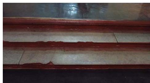
парадная лестница – тип (трехмаршевая), ступени (из путиловской плиты), конструкция (с опорой на стены и два продольных несущих пилона), латунные кольца ковродержателей;
