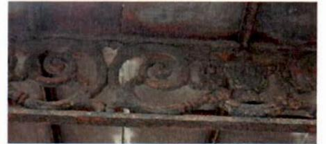
один флагодержатель – материал (металл), техника исполнения (ковка), конструкция (в виде волнитообразного кронштейна);
