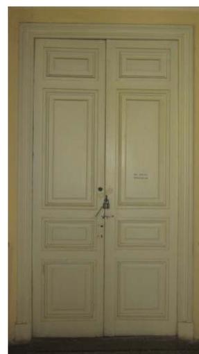
дверной проем - конфигурация, местоположение и габариты; историческое заполнение дверного проема - конструкция (двухстворчатое, филенчатое, профилированный наличник), конфигурация и материал (металл обшитый деревом, окрашенное);
