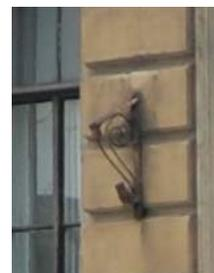
шестнадцать оконных решеток (в уровне цокольного этажа) – материал (металл), техника исполнения (ковка), рисунок (переплетение ромбами с перехватом);
