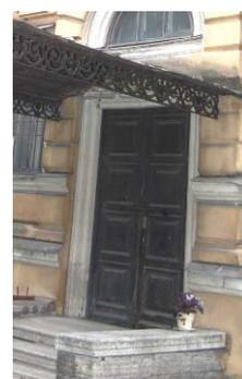
оконные проемы – габариты, конфигурация (прямоугольной и арочной формы), местоположение, оформление (заглубленные наличники (оконные проемы цокольного этажа), профилированные наличники, фланкирующие пилястры, профилированные архивольты, замковые камни, подоконные филенки, плоские сандрики);
