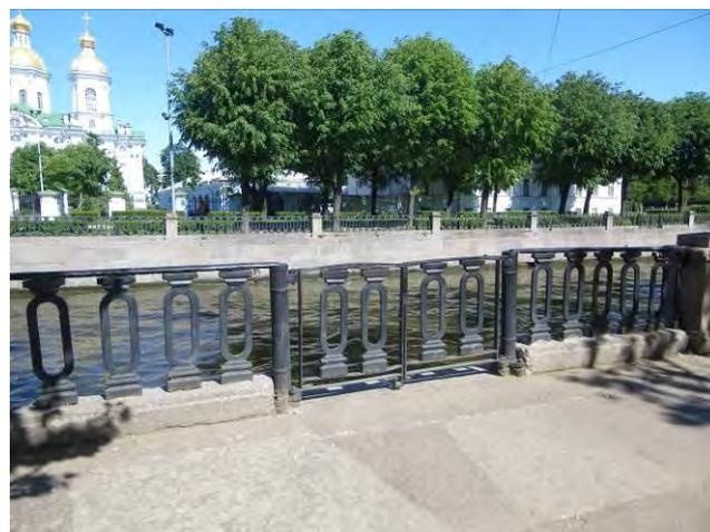
металлические звенья от р. Мойки до Адмиралтейского канала – литые металлические звенья между опорными гранитными тумбами – местоположение, габариты, конфигурация, рисунок звеньев (четырёхугольные остроконечные филенки с трехчастной филенкой внутри, разделенные вертикальными стойками с декором; по верхнему поясу фриз из колец, по нижнему – прямоугольные перекрещенные филенки с перехватами);
