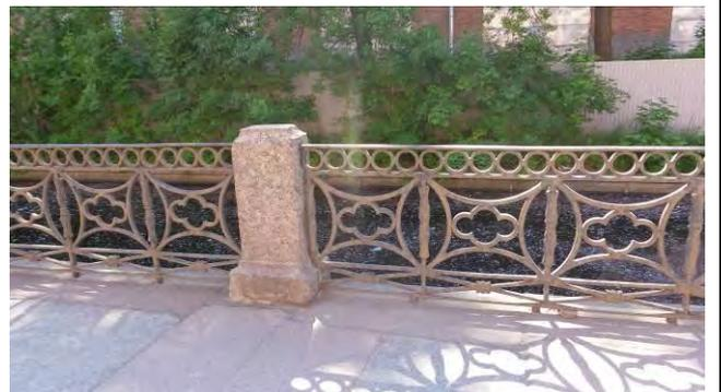
металлические звенья от р. Фонтанки до пересечения с р. Мойкой – профилированный гранитный плинт, литые металлические звенья между опорными гранитными тумбами – местоположение, габариты, конфигурация, рисунок звеньев (стилизованные балясины из вытянутых овалов со ступенчатым основанием и наверху);
