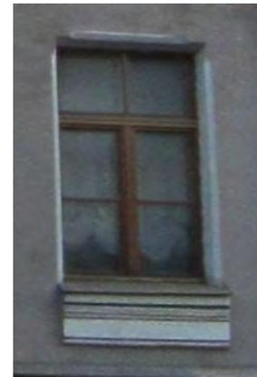
оформление оконных проемов 3 этажа – профилированные наличники, ступенчатые подоконные доски;
