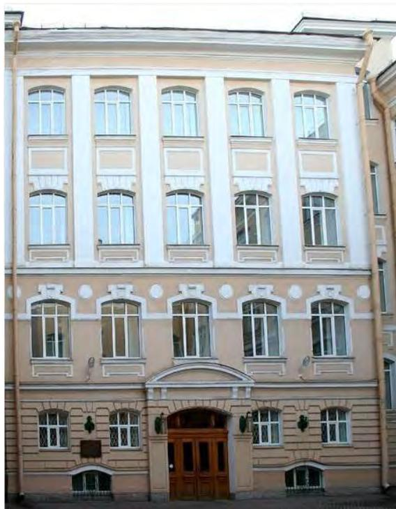
заполнение дверного проема – материал (дерево), конструкция (двери четырехстворчатые, полусветлые, с остекленной фрамугой с лучковым завершением), оформление (лопатки, каннелированные кронштейны, профилированные филенки, пояски с патерами);
