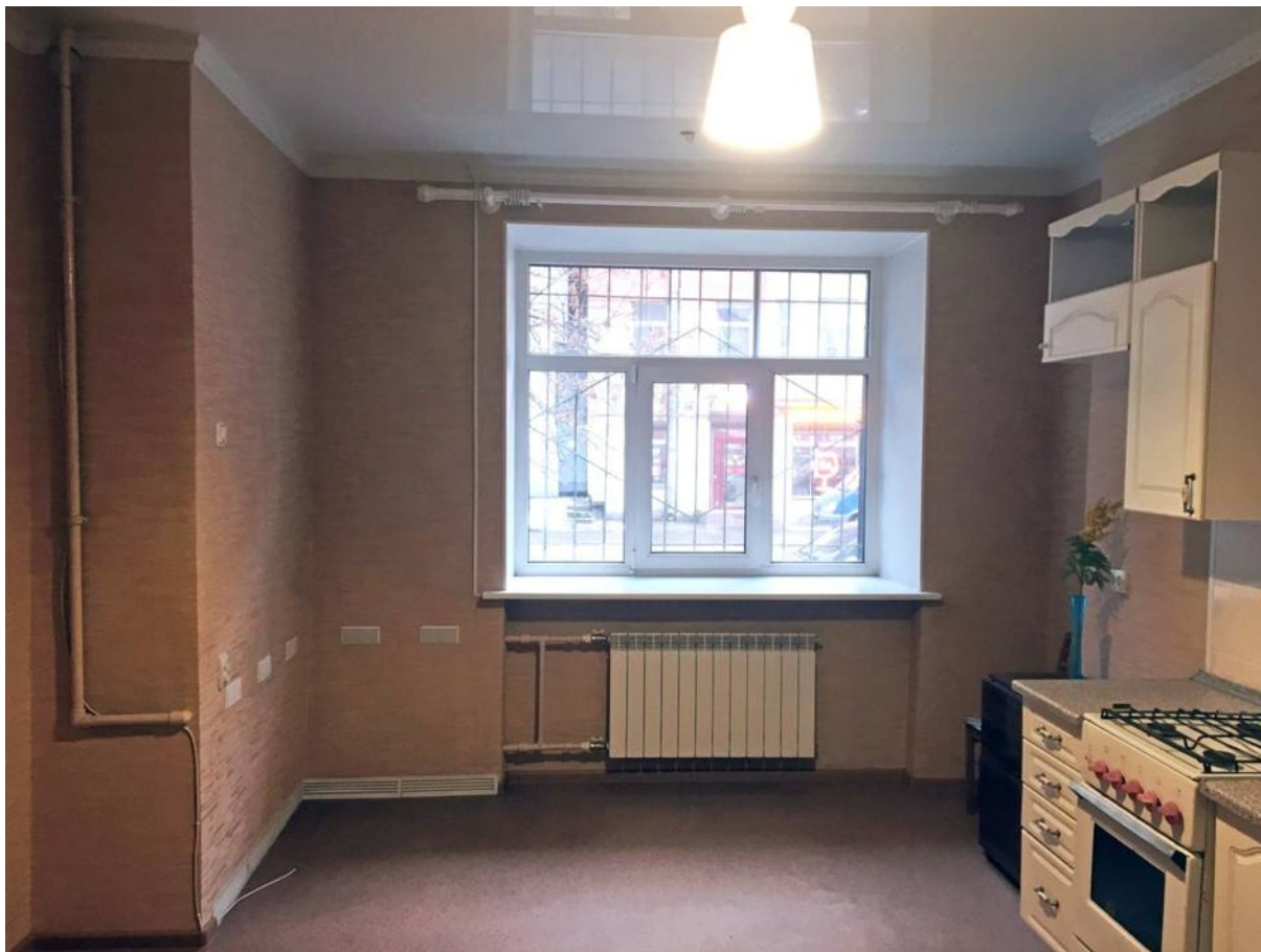
36. Вид внутри квартиры №194 (пом. 4).
