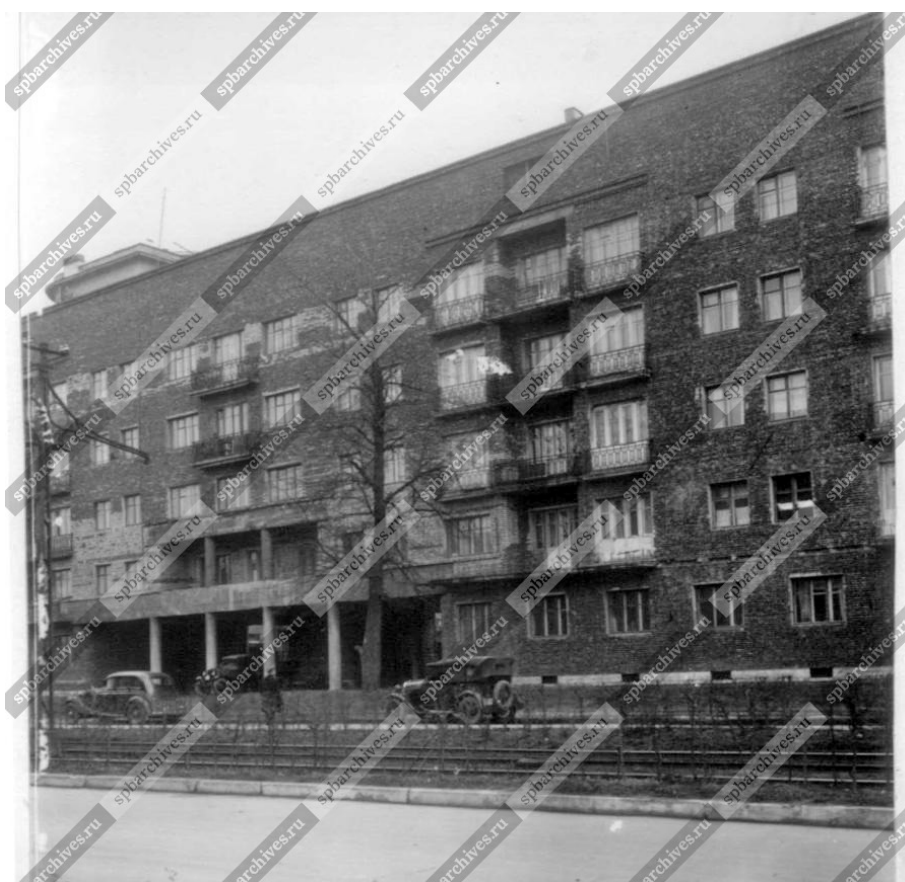
Илл. 11. Фрагмент фасада дома для специалистов №61 корп.1 (лит.А) на Лесном проспекте на этапе строительства. Архитектор Г.А. Симонов. Фото 1934-1936-х гг. ЦГАКФФД СПб. Вр 73820.
