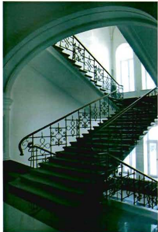
Фото №3, 4, 5. Парадная трехмаршевая распашная межэтажная лестница.
