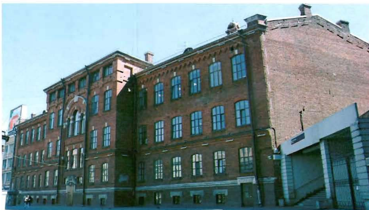
Фото №1. Вид на западный фасад и брандмауэрную южную стену со стороны Лиговского проспекта.
