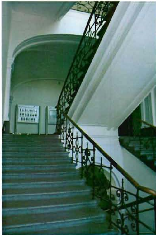
Фото №3, 4, 5. Парадная трехмаршевая распашная межэтажная лестница.
