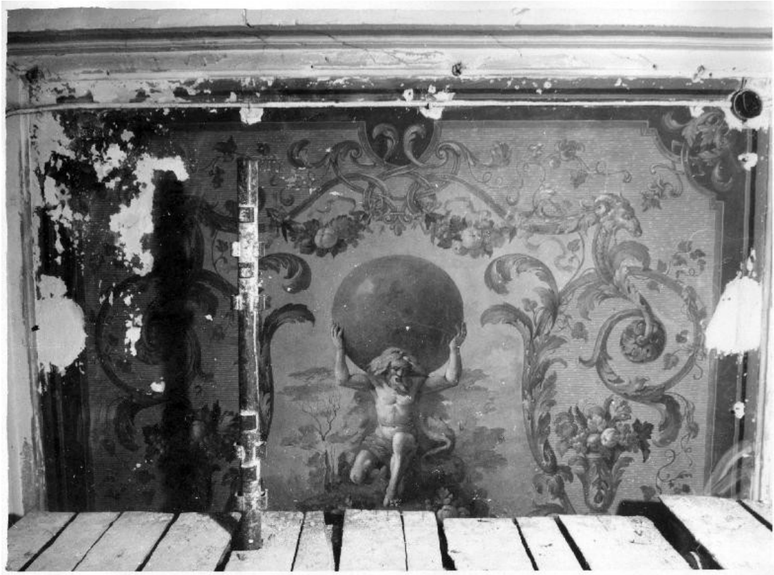
Илл. 53. Состояние стеного панно «Аллегория Земли» после расчистки СНПО «Реставратор». Фотография. 1985 г. Архив КГИОП
