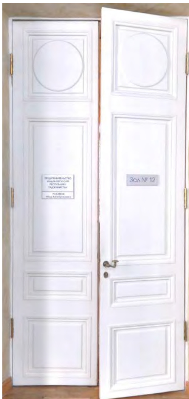
10. Заполнение дверного проема северной стены помещения зала №12 (пом. 1-Н (136) в уровне 1-ого этажа объекта культурного наследия федерального значения «Дворец Таврический. Дворец». 10.05.2021
