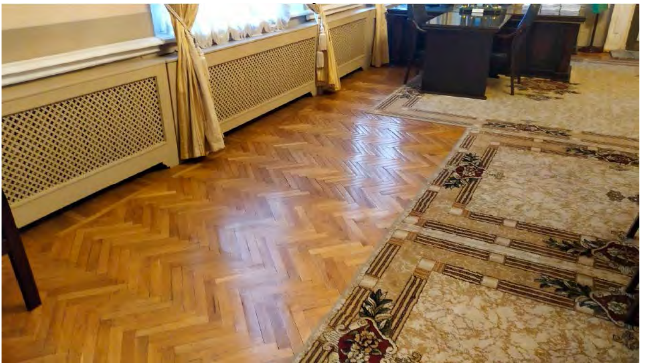
12. Покрытие пола зала №12 (пом. 1-Н (136) в уровне 1-ого этажа объекта культурного наследия федерального значения «Дворец Таврический. Дворец», расположенного по адресу: г. Санкт-Петербург, ул. Шпалерная, д. 47, лит. А. 10.05.2021
