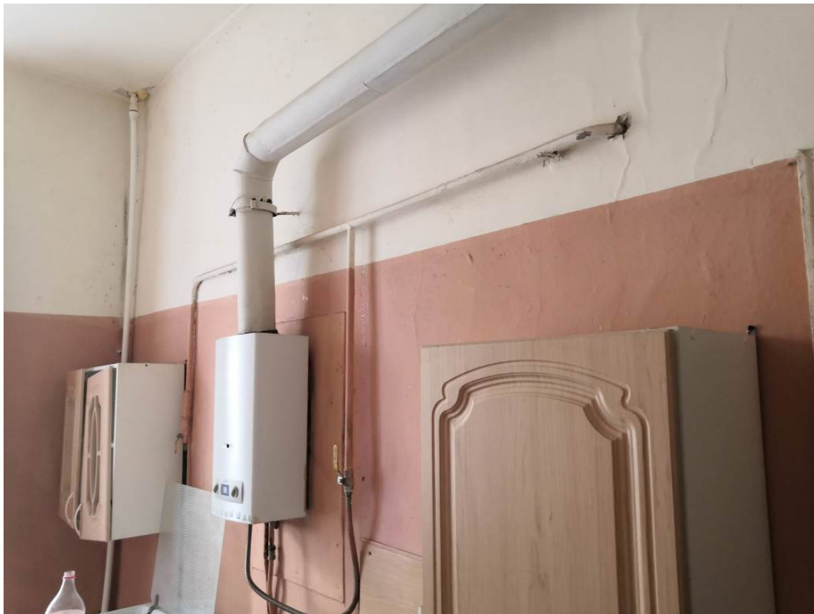
18. Выявленный ОКН «Дом К.А.Шрейбера» г. Санкт-Петербург, Фурштатская улица, дом 25, литера А. Помещение 6 в кв.№ 8. Кухня.
