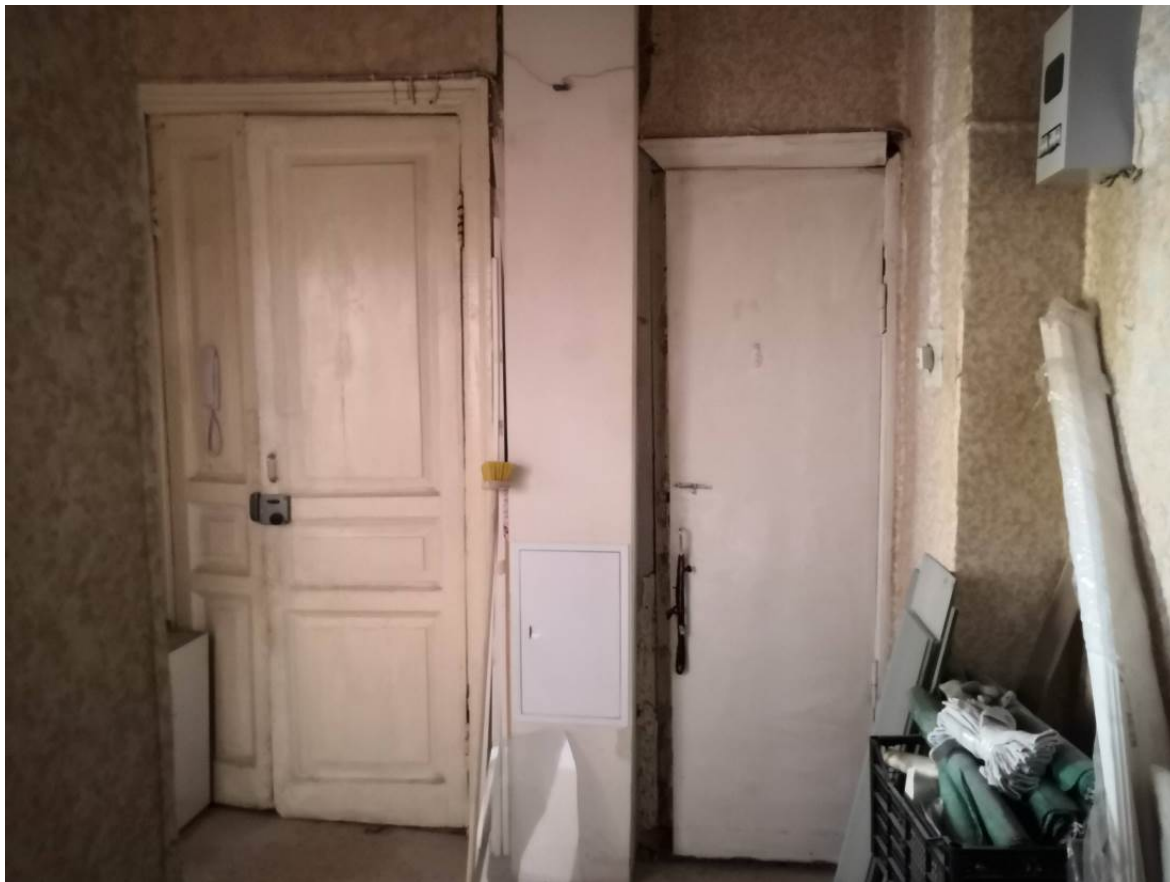
9. Выявленный ОКН «Дом К.А.Шрейбера» г. Санкт-Петербург, Фурштатская улица, дом 25, литера А. Помещение 2 кв. № 8.Коридор
