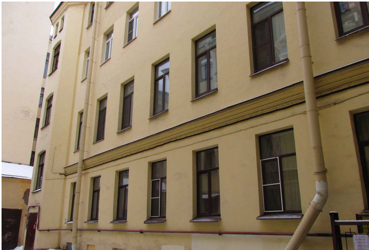
3. Выявленный ОКН «Дом К.А.Шрейбера» г. Санкт-Петербург, Фурштатская улица, дом 25, литера А. Дворовый фасад.
