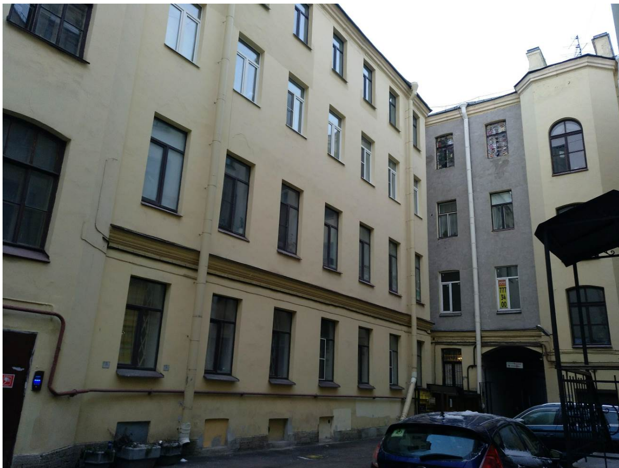
4. Выявленный ОКН «Дом К.А.Шрейбера» г. Санкт-Петербург, Фурштатская улица, дом 25, литера А. Дворовый фасад.
