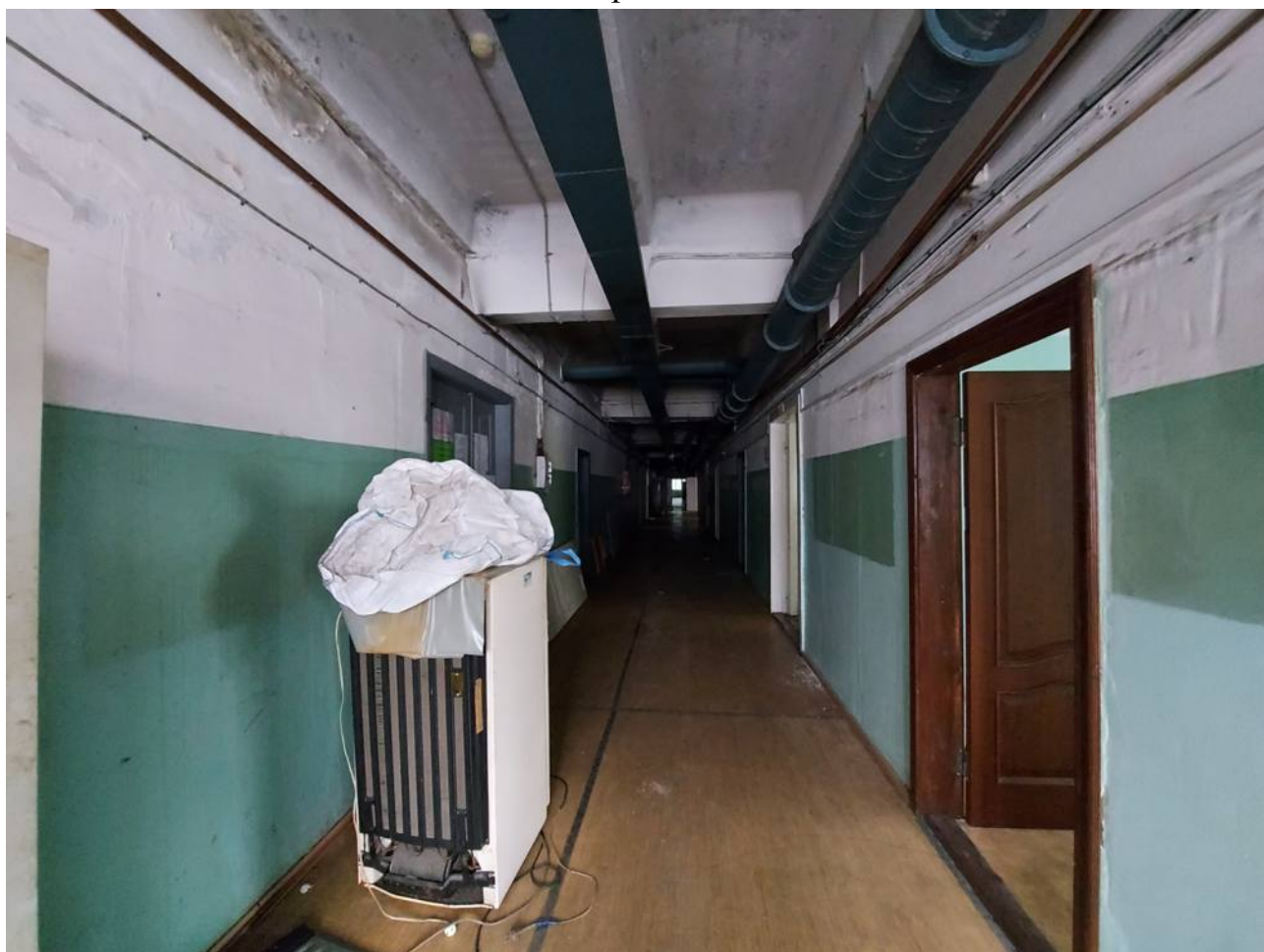
Фото № 30. Вид 2-го этажа с юга здания по Кожевенной лин. № 39 корп. 8.
