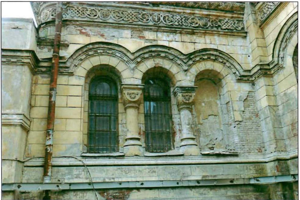
9. Западный фасад. Фрагмент.
