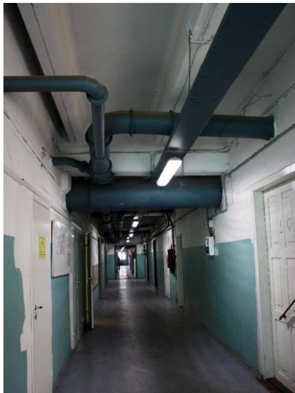
Фото № 32. Вид 2-го этажа с севера здания по Кожевенной лин. № 39 корп.
