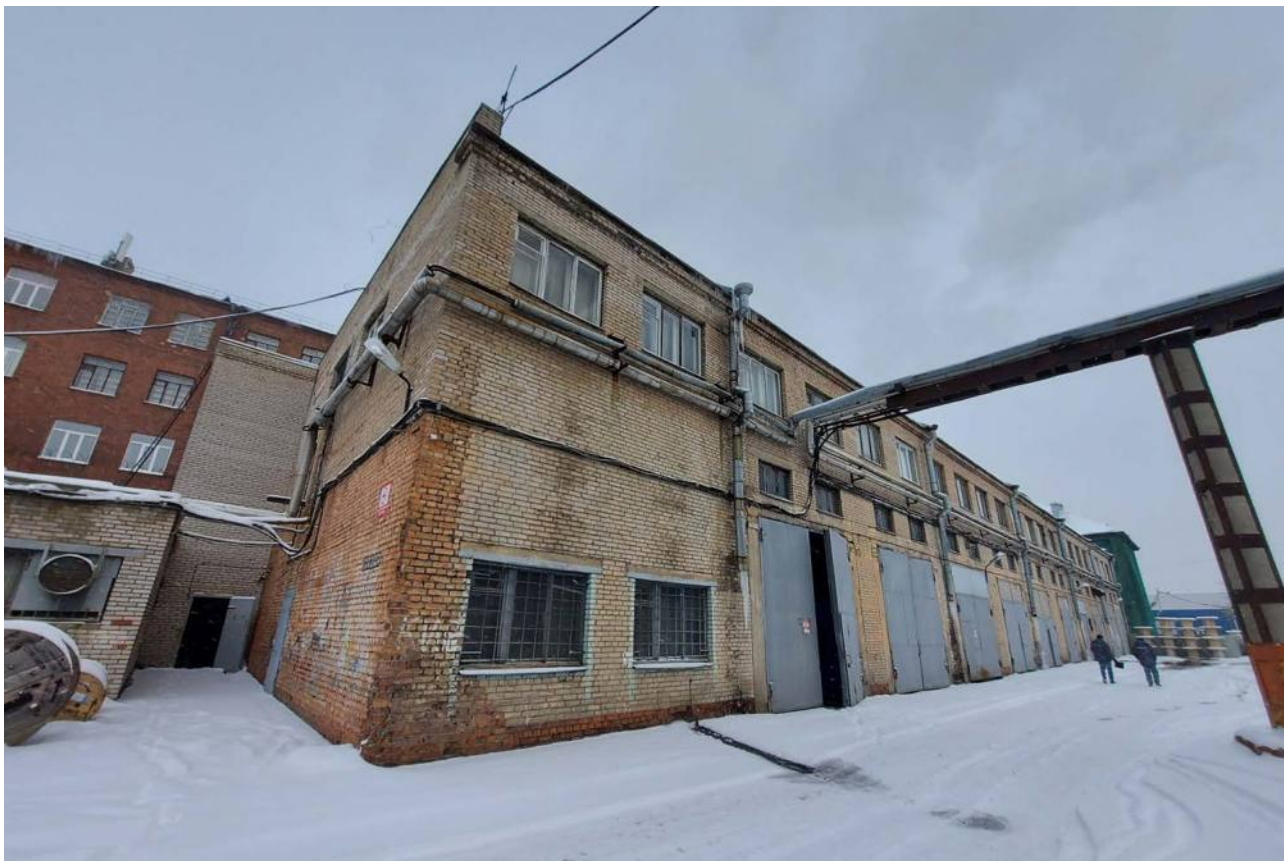
Фото № 11. Общий вид здания по Кожевенной лин. № 39 корп. 8 с юга.
