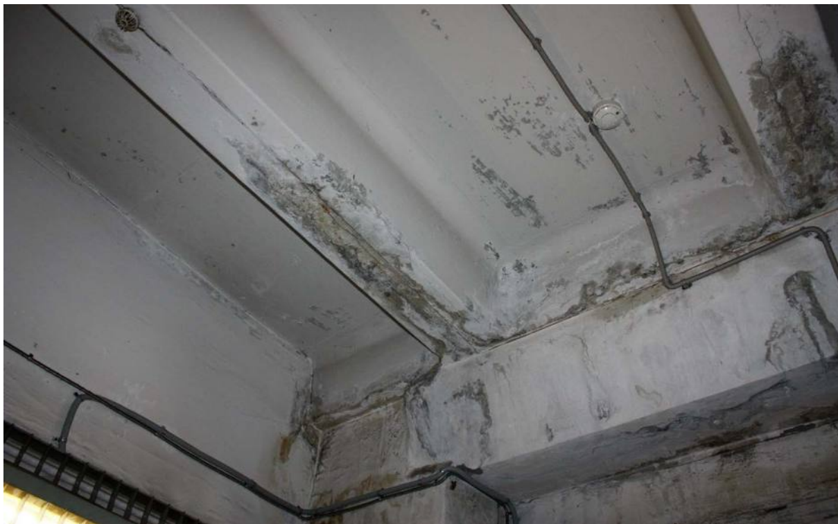
Фото № 29. Конструкция перекрытия 2-го этажа здания по Кожевенной лин. № 39 корп. 8.
