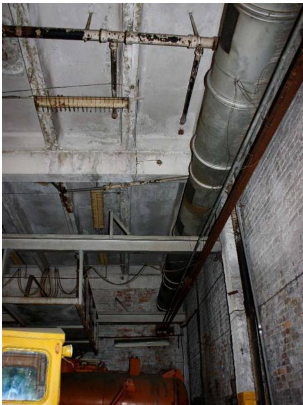
Фото № 25. Вид вдоль северной стены пом.1 здания по Кожевенной лин. № 39 корп. 8.
