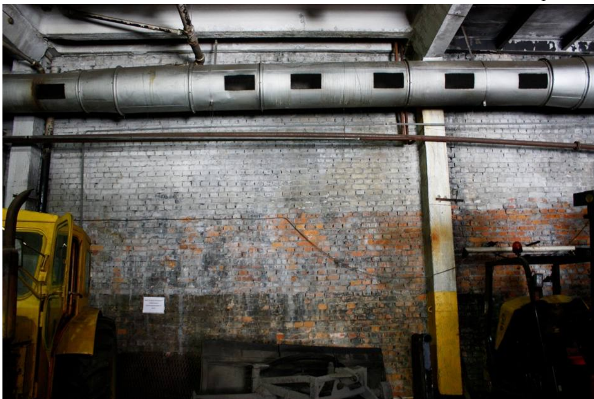
Фото № 24. Северная стена пом. 1 здания по Кожевенной лин. № 39 корп. 8.
