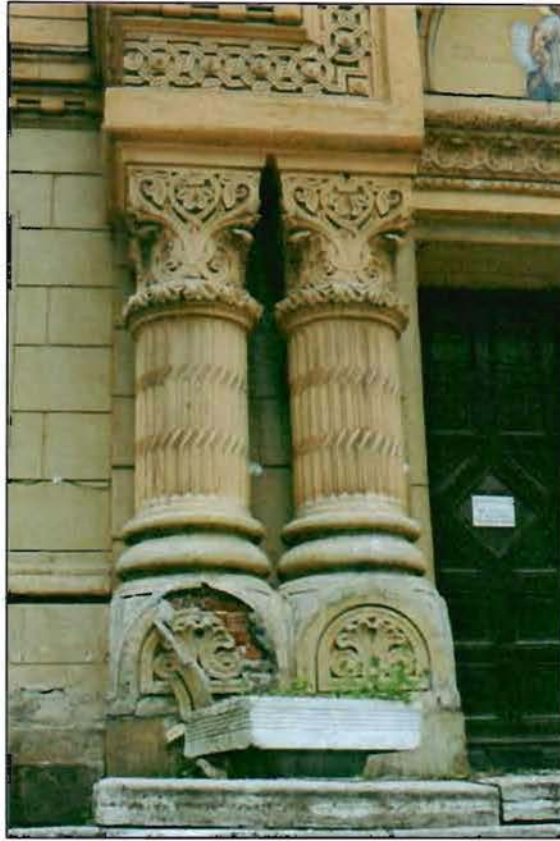
10. Западный фасад. Фрагмент.
