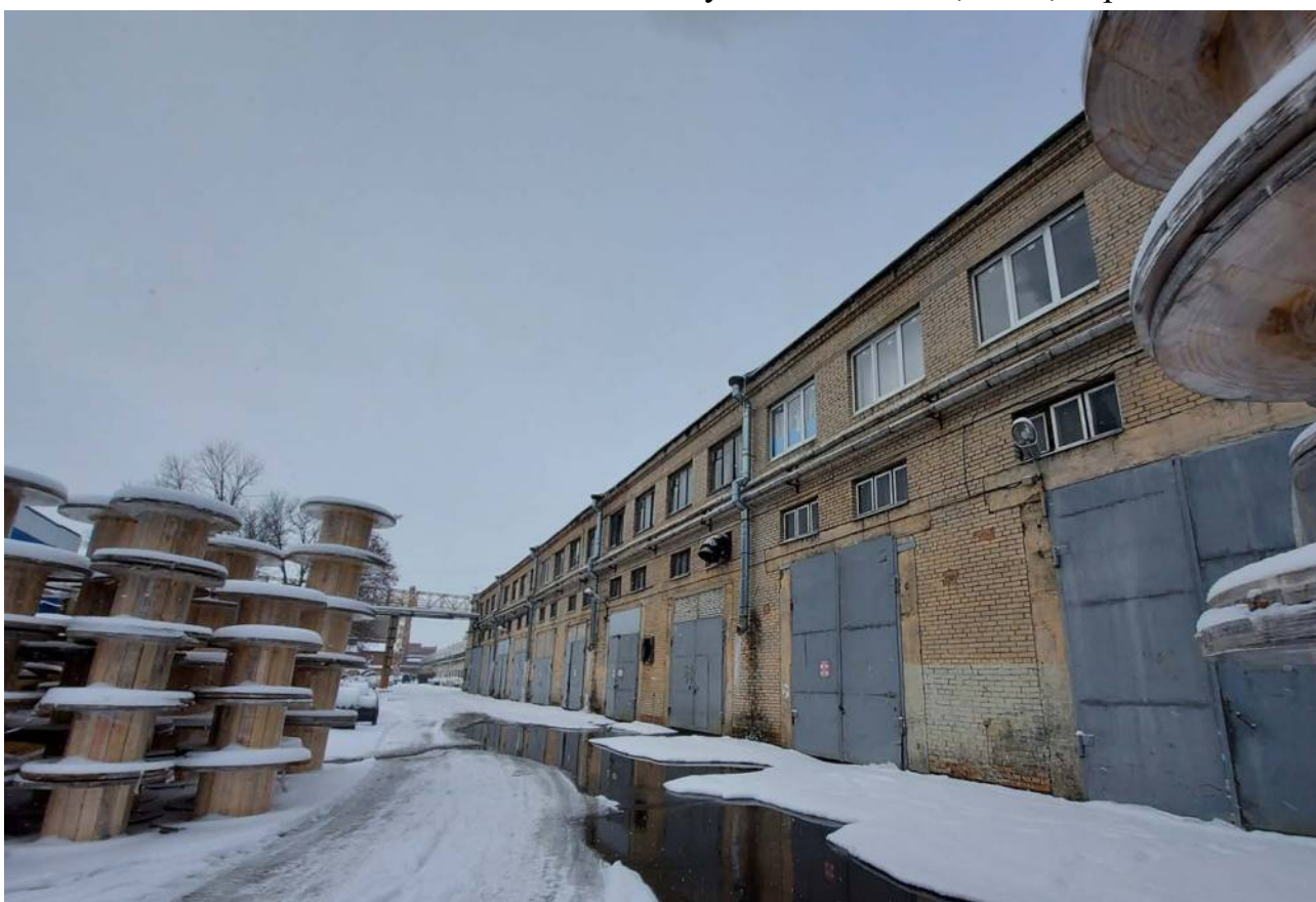
Фото № 14. Вид здания по ул. Кожевенной, д. 39, корп. 8 с востока.
