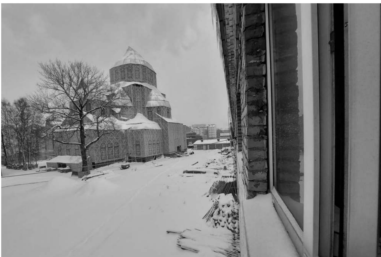
Фото № 8. Вид с юго-запада вдоль северо-западного фасада здания по ул. Кожевниковой, д. 39, корп. 8.
