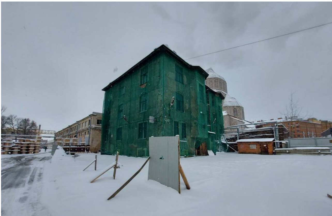
Фото № 18. Общий вид зданий с востока.
