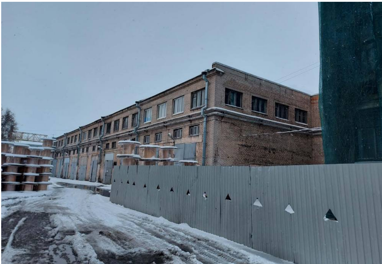
Фото № 17. Вид здания по ул. Кожевенной, д. 39, корп. 8 с востока.
