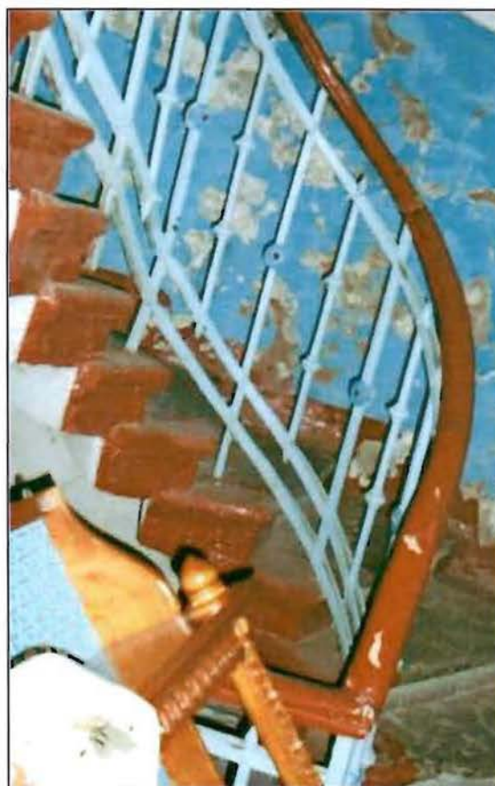
15. Интерьер. Фрагмент. Лестница на хоры
