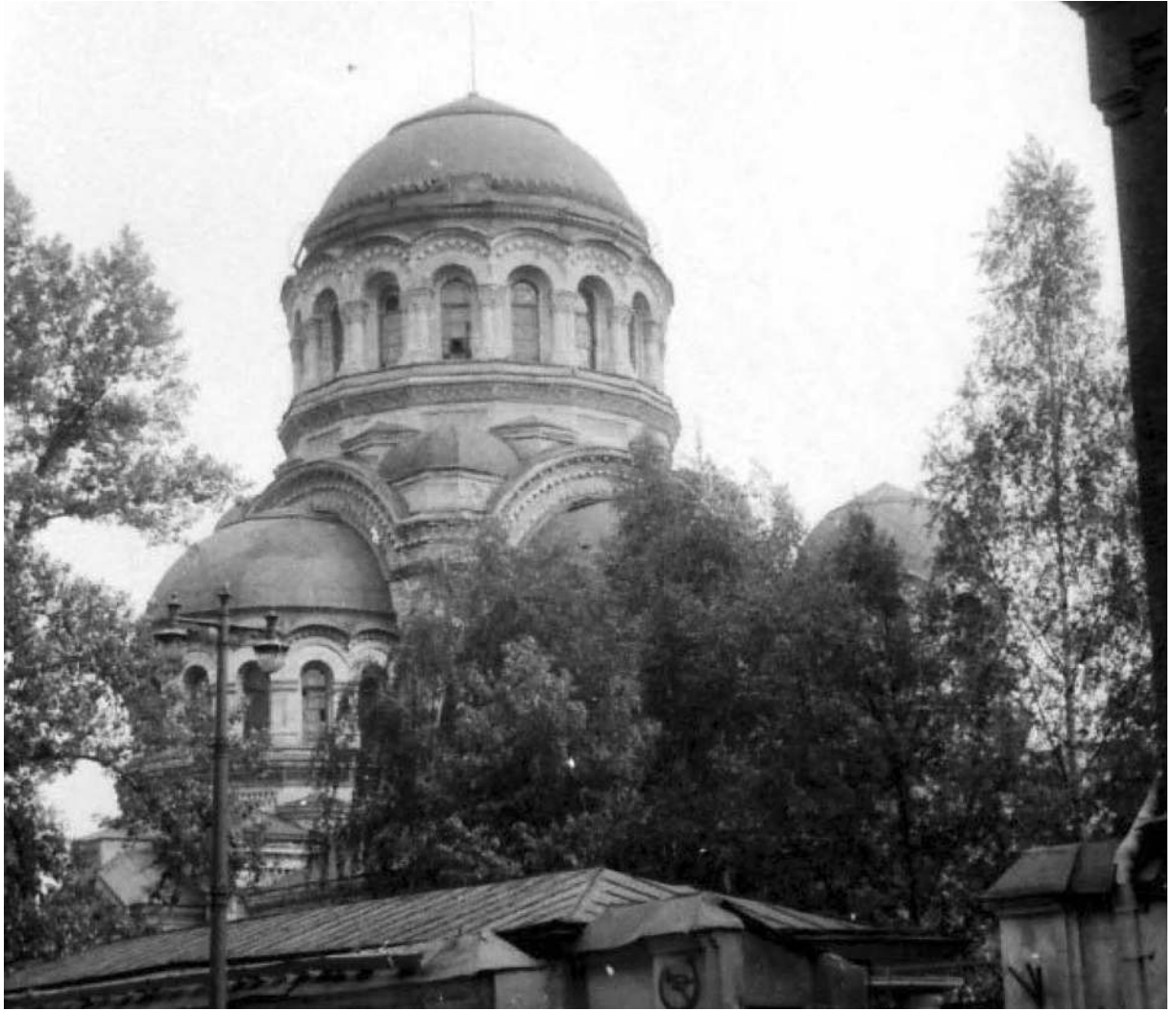
Илл. 41. Церковь Божией Матери Милующей. После реконструкции. 2 пол. XX в. Историческая записка. Шифр 154/18-М-И. ООО «СтройТехПроект».
