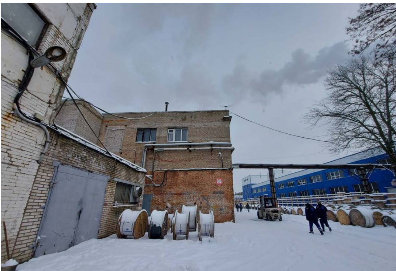
Фото № 10. Юго-западный фасад здания по ул. Кожевенной, д. 39, корп. 8.
