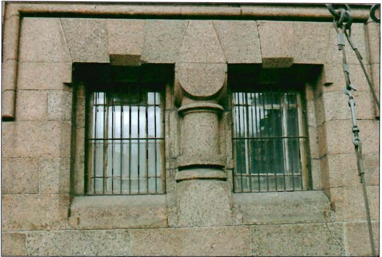
8. Южный фасад. Фрагмент. Окна притвора первого яруса.
