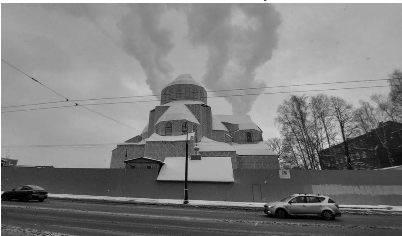
Фото № 2. Вид церкви с северо-запада.
