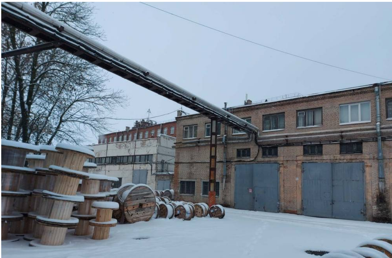
Фото № 13. Южная часть здания по ул. Кожевенной, д. 39, корп. 8.
