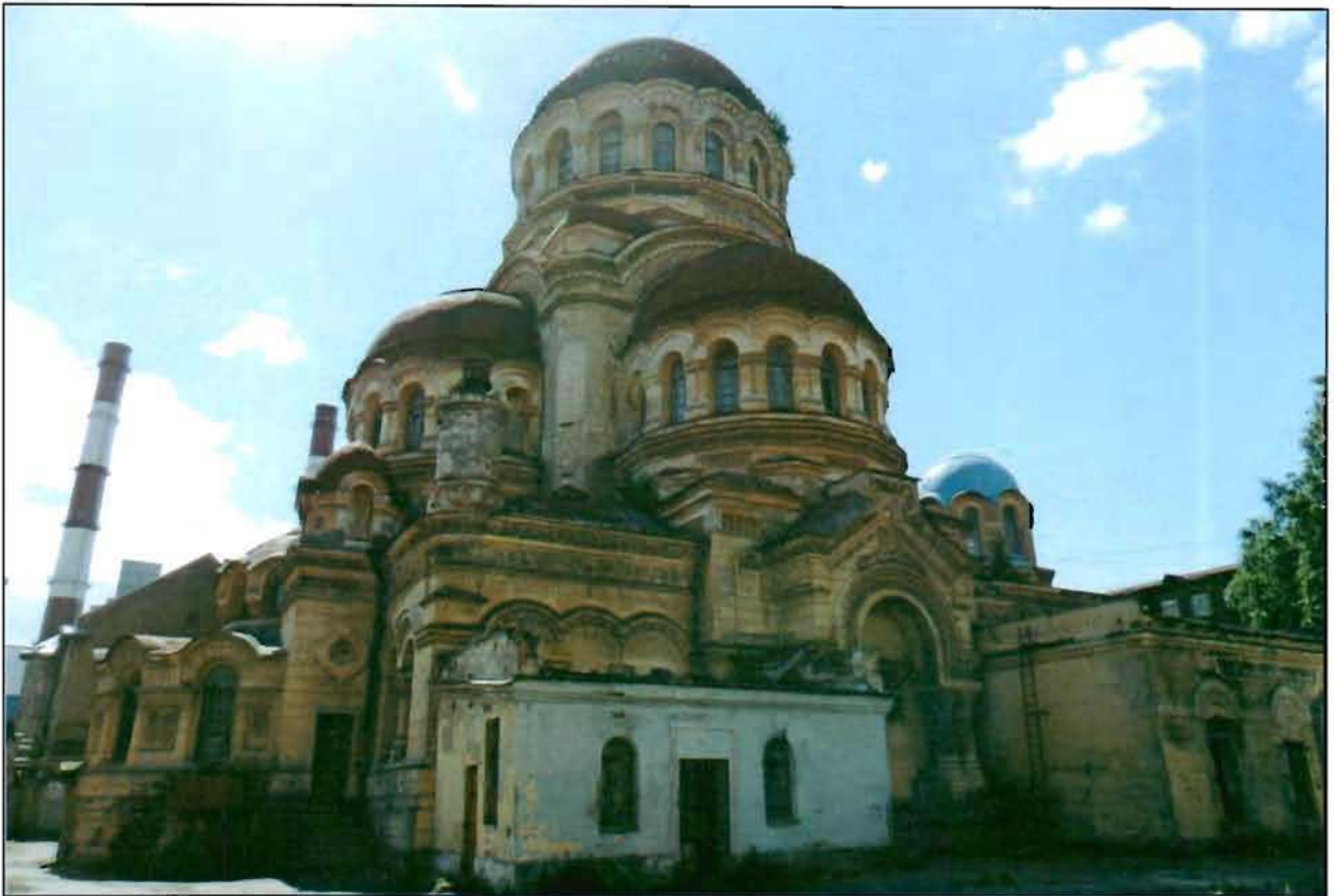
2. Общий вид с северо-востока.
