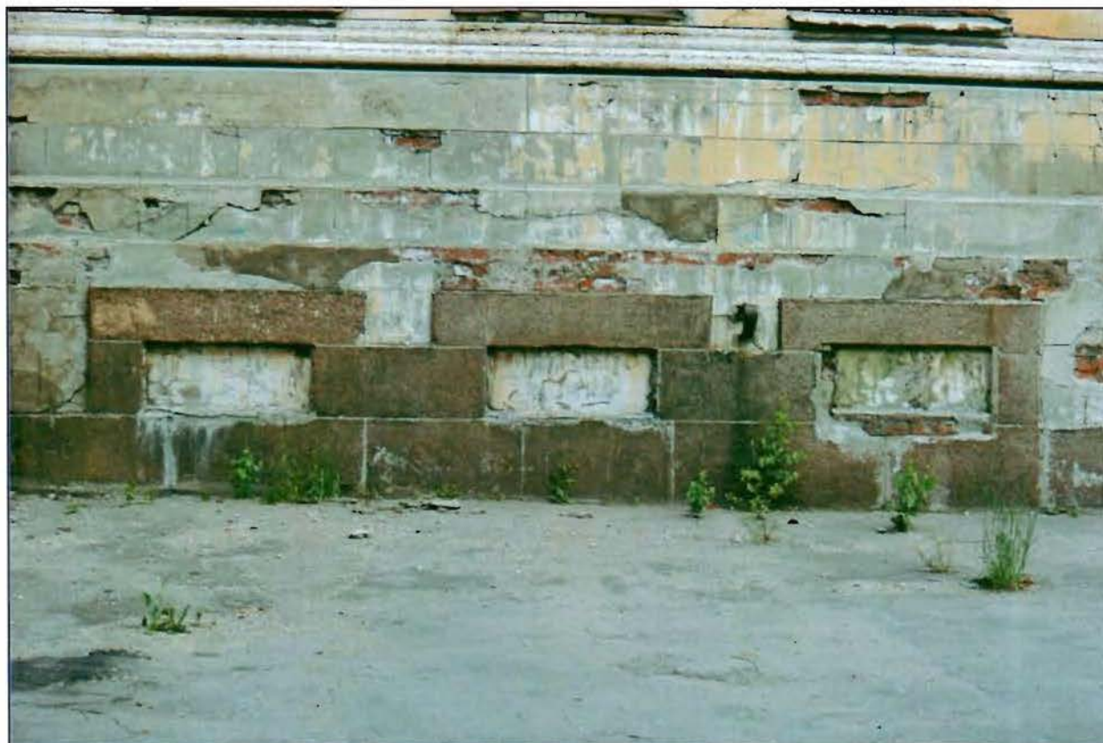
7. Западный фасад. Фрагмент. Цоколь.
