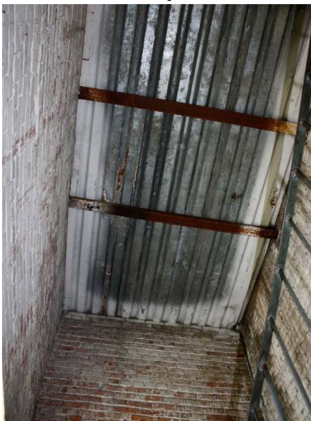
Фото № 27. Покрытие южной лестничной клетки здания по Кожевенной лин. № 39 корп. 8.
