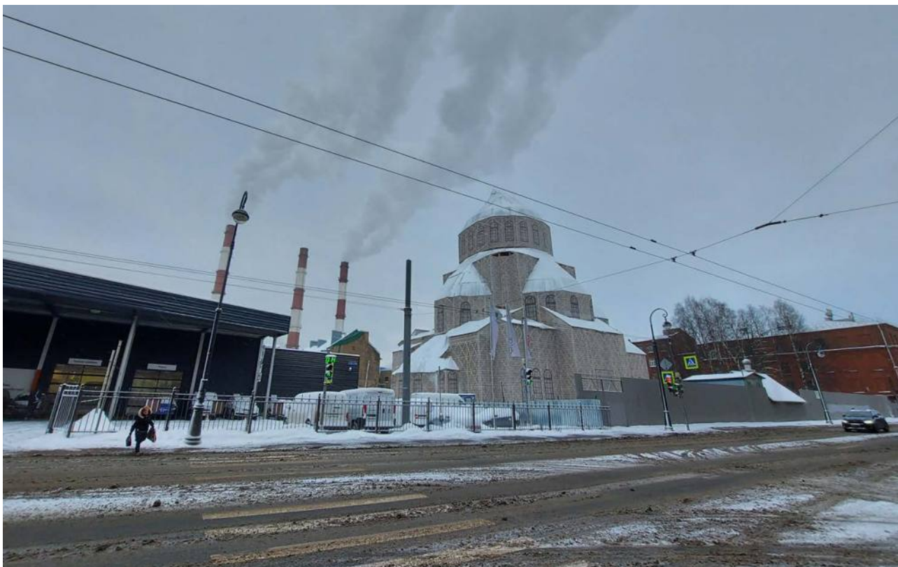
Фото № 1. Общий вид с севера.
