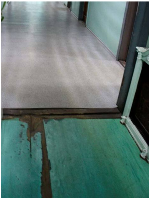
Фото № 31. Покрытие полов 2-го этажа здания по Кожевенной лин. № 39 корп.
