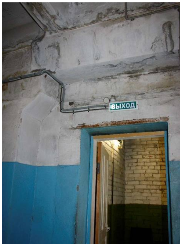
Фото № 28. Выход на лестничную клетку здания по Кожевенной лин. № 39 корп. 8.
