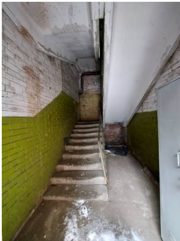
Фото № 26. Южная лестница на 2 этаж здания по Кожевенной лин. № 39 корп. 8.
