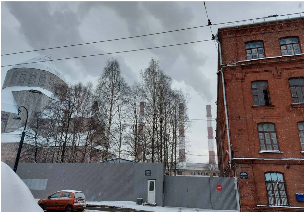
Фото № 3. Вид с северо-запада в створе зданий по Большому проспекту В.О. д. 100 (церковь) и д. 102.
