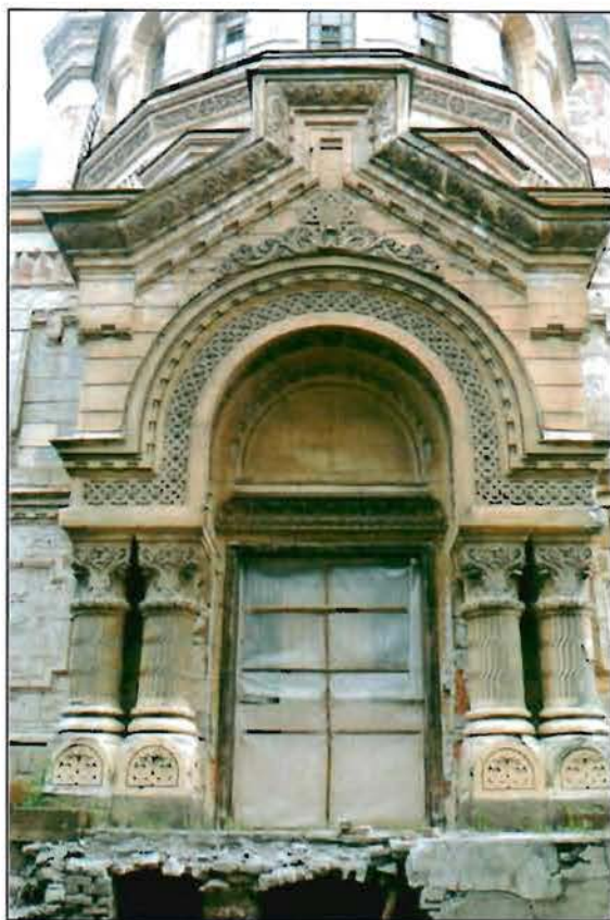
6. Южный фасад. Фрагмент.
