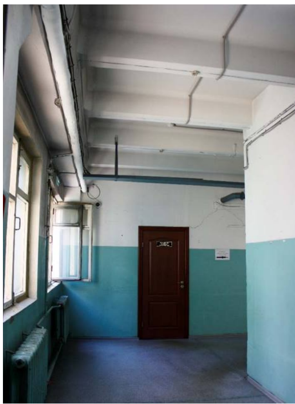
Фото № 34. Фрагмент северного коридора здания по Кожевенной лин. № 39 корп. 8.
