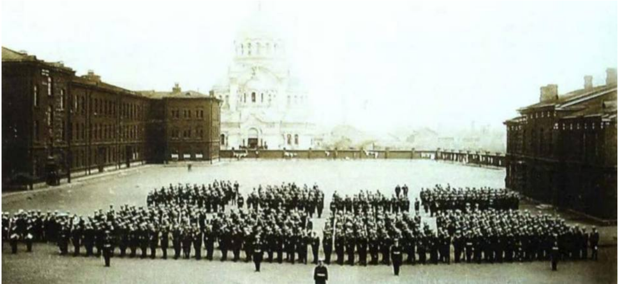
Илл. 17. Церковь Божией Матери Милующей. Парад военных моряков на площади у Дерябинских казарм. 1890-1900. Историческая записка. Шифр 154/18-М-И. ООО «СтройТехПроект».
