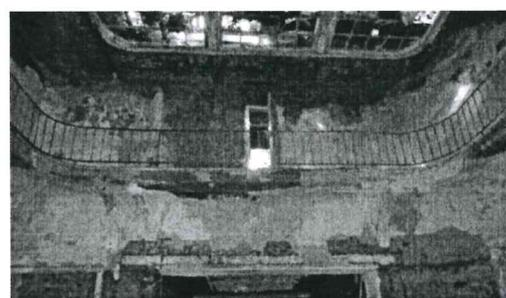
световые фонари над объемом парадной лестницы (пом. 21), в уровне второго и третьего этажей центральной части здания: исторические конструкция, материал, рисунок расстекловки заполнения;
