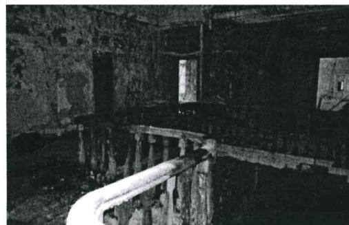
обходная галерея в уровне третьего этажа объема парадной лестницы – историческое местоположение, габариты, конфигурация, ограждение;
