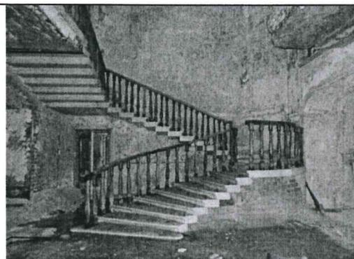
обходная галерея в уровне второго этажа объема парадной лестницы – историческое местоположение, габариты, конфигурация, обрамление идентичное ограждений маршей лестницы;
