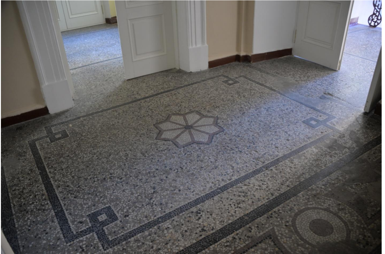
52. Напольное покрытие в помещении №51
