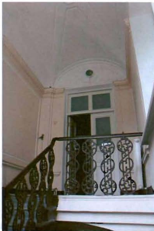
Фото №13. Лестница в цокольный этаж.
