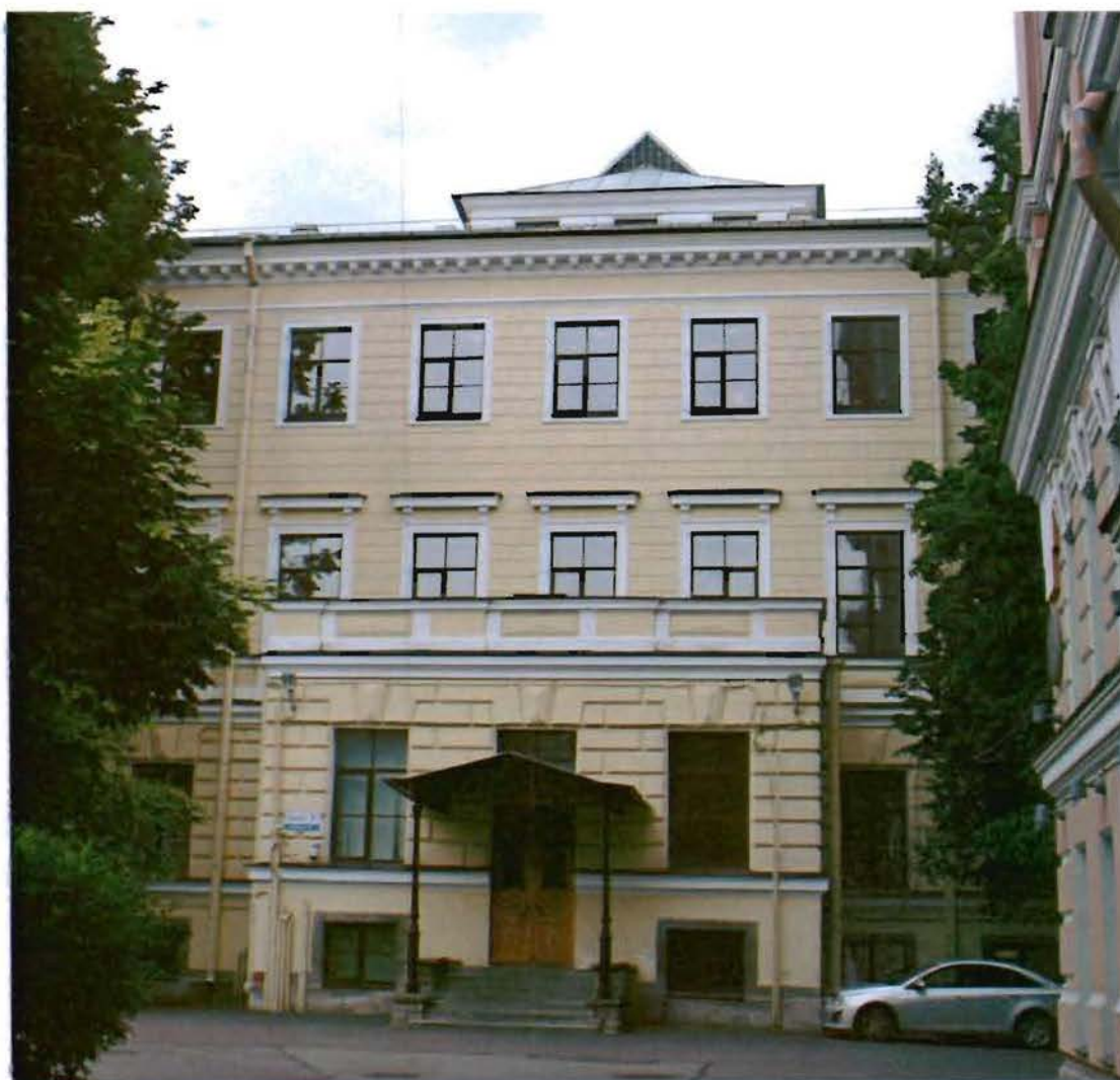
Фото №1. Вид на восточный (парадный) фасад со стороны внутреннего двора.
