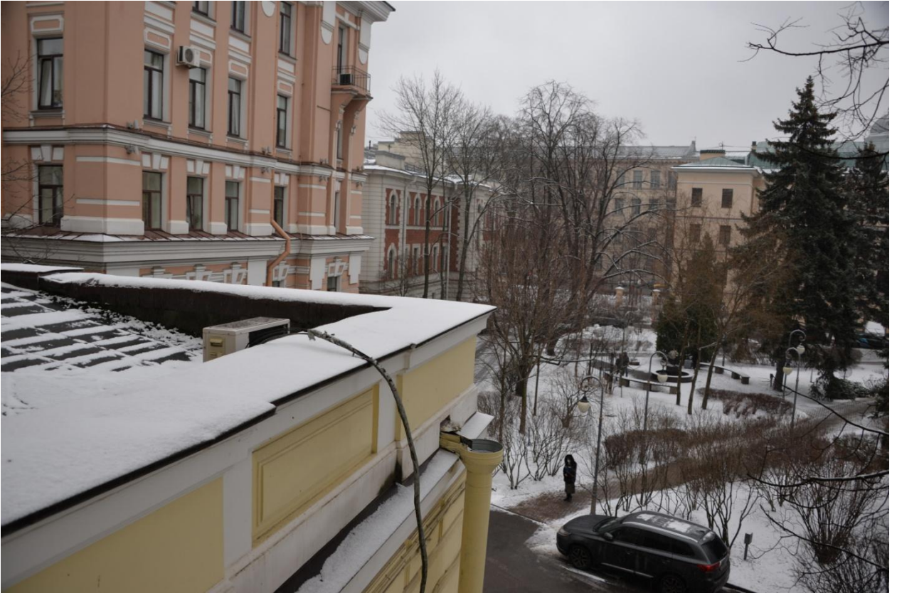
55. Вид на кровлю из помещения №88
