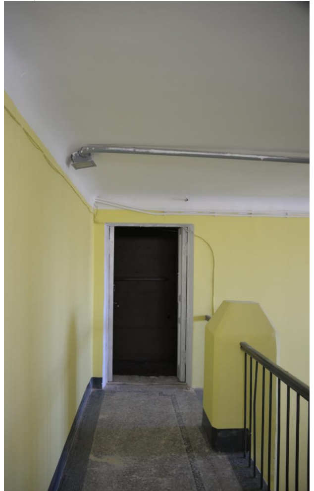
73. Вид на дверь в помещение №151
