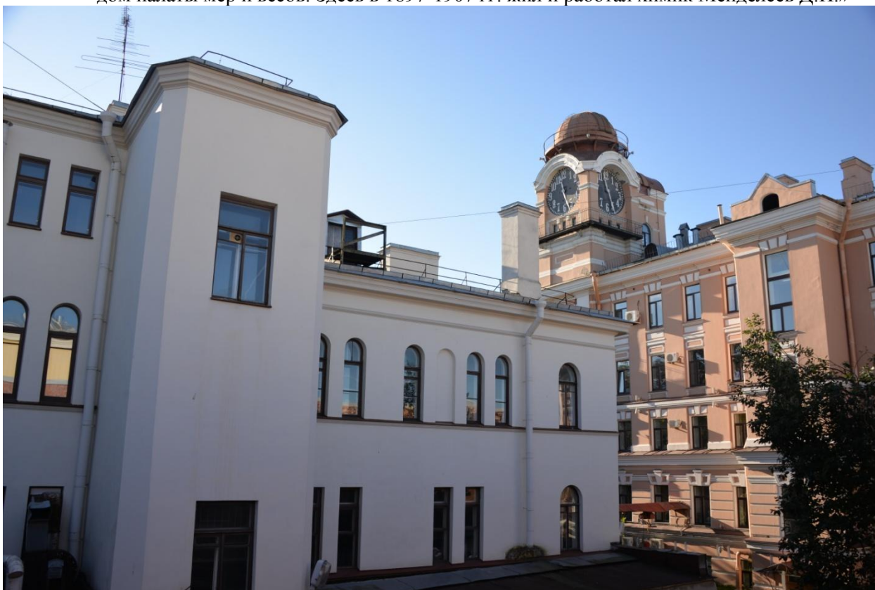
10. Фрагмент северного фасада объекта культурного наследия федерального значения «Жилой дом палаты мер и весов. Здесь в 1897-1907 гг. жил и работал химик Менделеев Д.И.»
