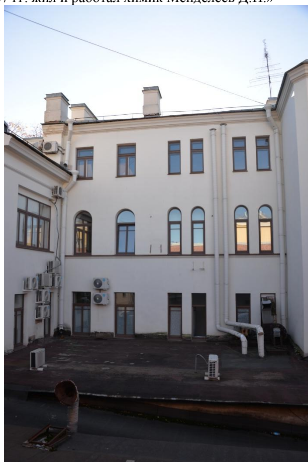
8. Фрагмент северного фасада объекта культурного наследия федерального значения «Жилой дом палаты мер и весов. Здесь в 1897-1907 гг. жил и работал химик Менделеев Д.И.»
