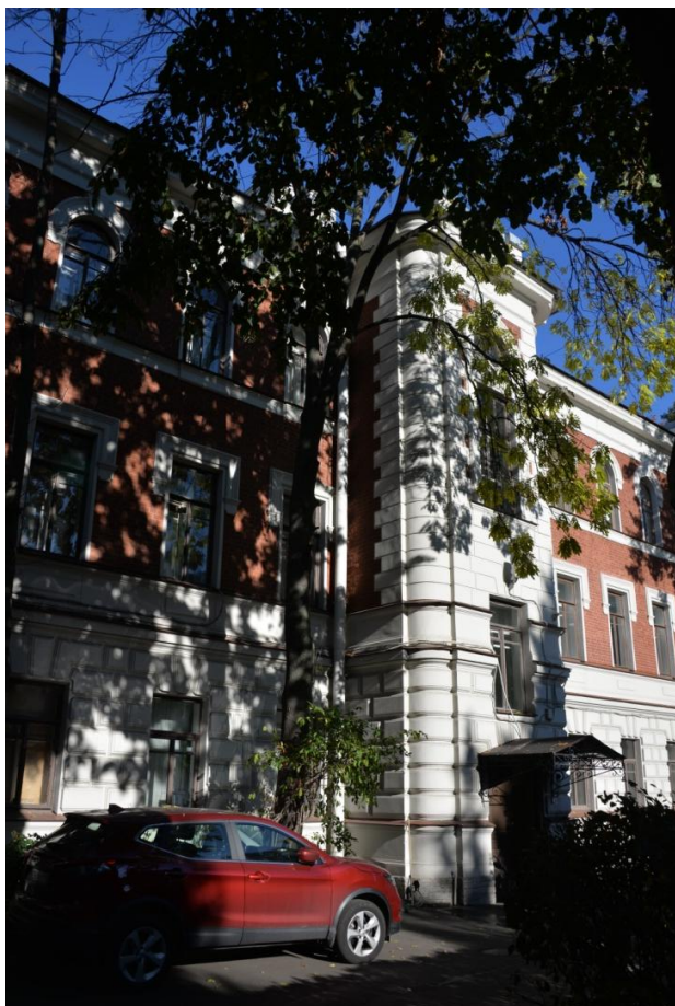
3. Фрагмент южного фасада объекта культурного наследия федерального значения «Жилой дом палаты мер и весов. Здесь в 1897-1907 гг. жил и работал химик Менделеев Д.И.»
