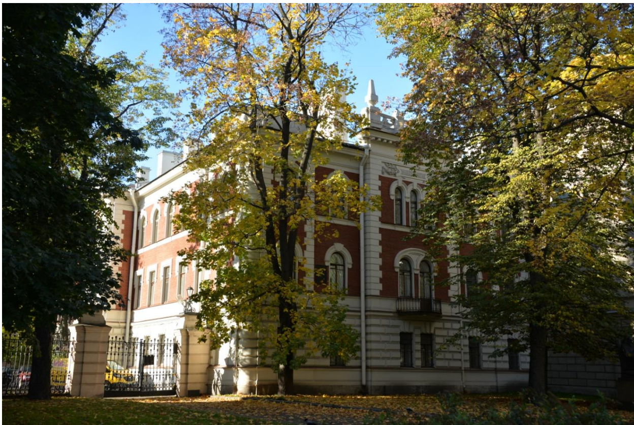
1. Восточный фасад объекта культурного наследия федерального значения «Жилой дом палаты мер и весов. Здесь в 1897-1907 гг. жил и работал химик Менделеев Д.И.»
