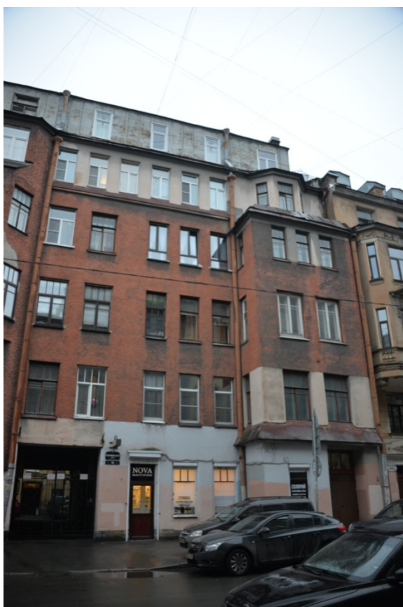
Фото 3. Фрагмент лицевого фасада выявленного объекта культурного наследия «Дом Ф.Ф. Лумберга»
