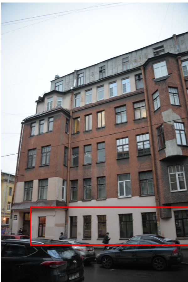
Фото 1. Фрагмент лицевого фасада выявленного объекта культурного наследия «Дом Ф.Ф. Лумберга»
