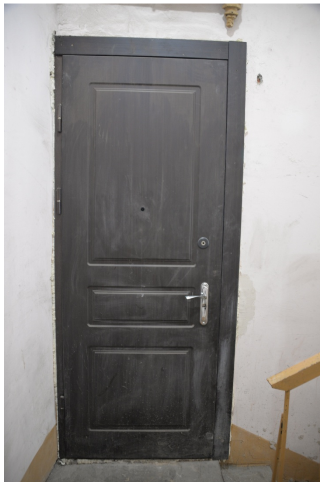
Фото 7. Входная дверь в квартиру №2
