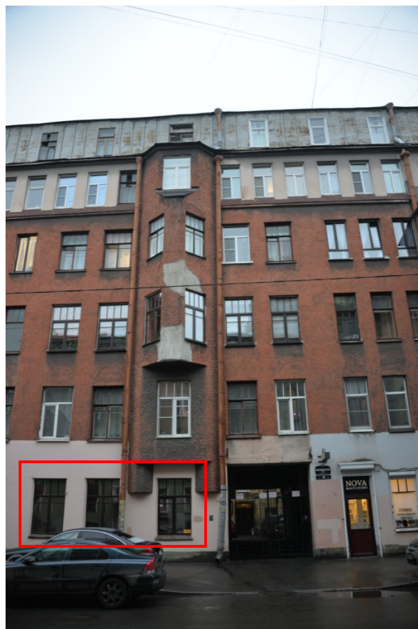
Фото 2. Фрагмент лицевого фасада выявленного объекта культурного наследия «Дом Ф.Ф. Лумберга»
