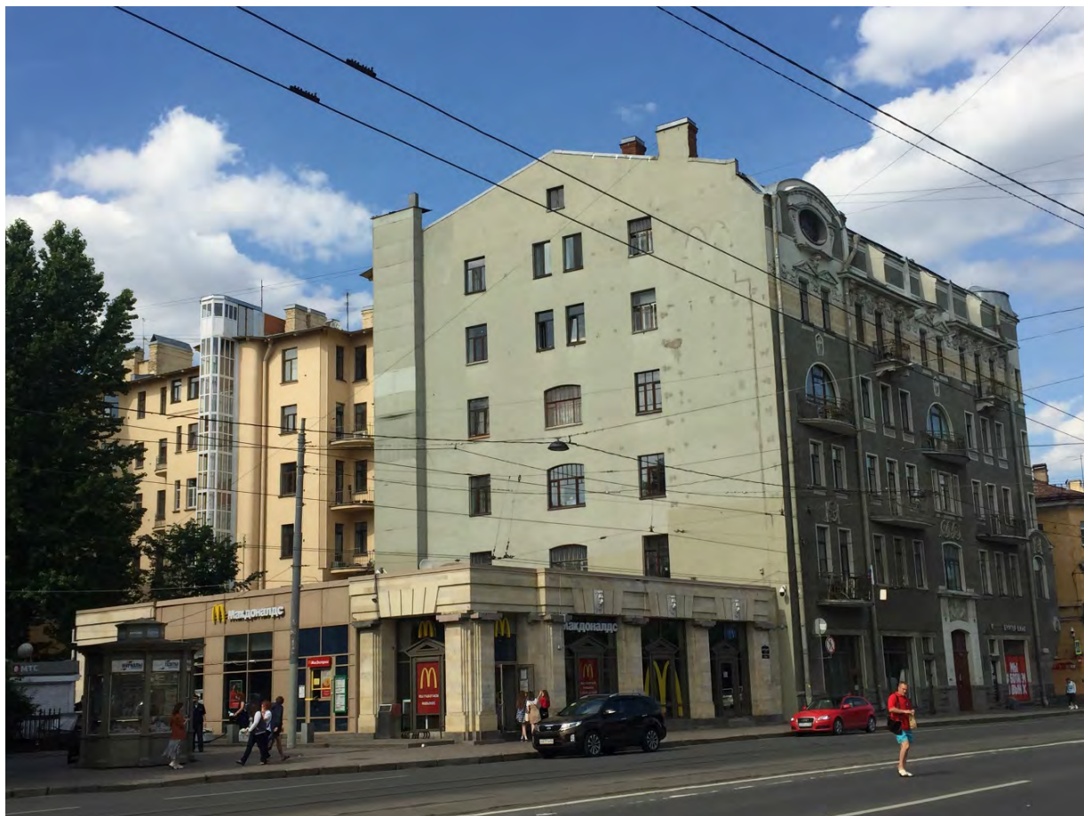
Илл. 3. Общий вид торцевого юго-западного фасада по Загородному проспекту. Вид с юго-востока.
