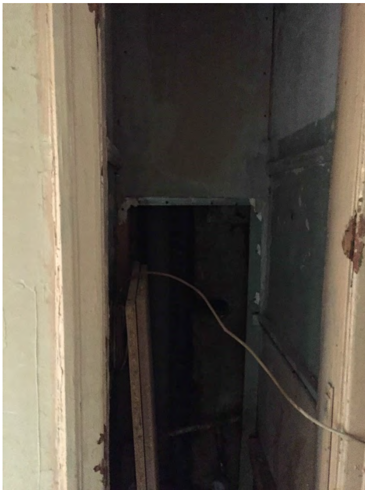
Илл. 32. Кладовая (помещение № 13). Вид с юго-востока.
