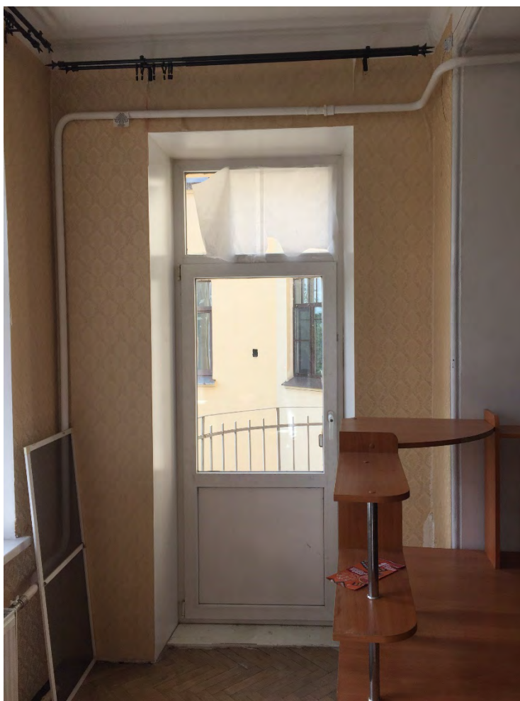
Илл. 44. Выход на балкон из помещения № 8. Вид с юго-востока.
