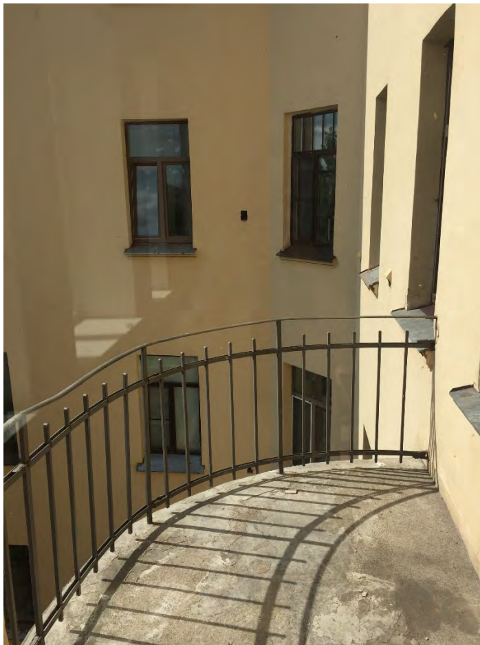
Илл. 45. Балкон из помещения № 8. Вид с юго-востока.
