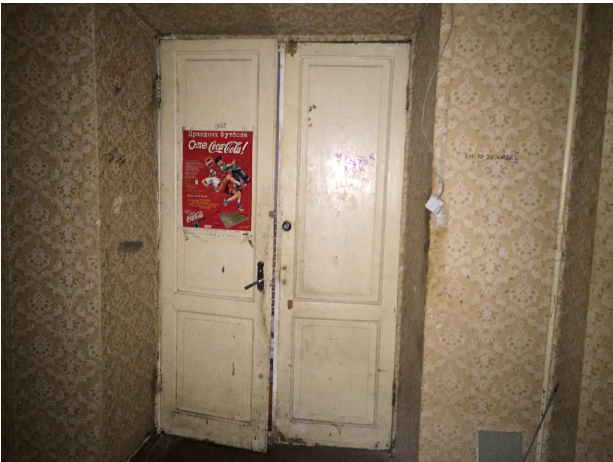
Илл. 11. Общий вид коридора (помещение № 7). Дверное заполнение. Вид с юго-востока.
