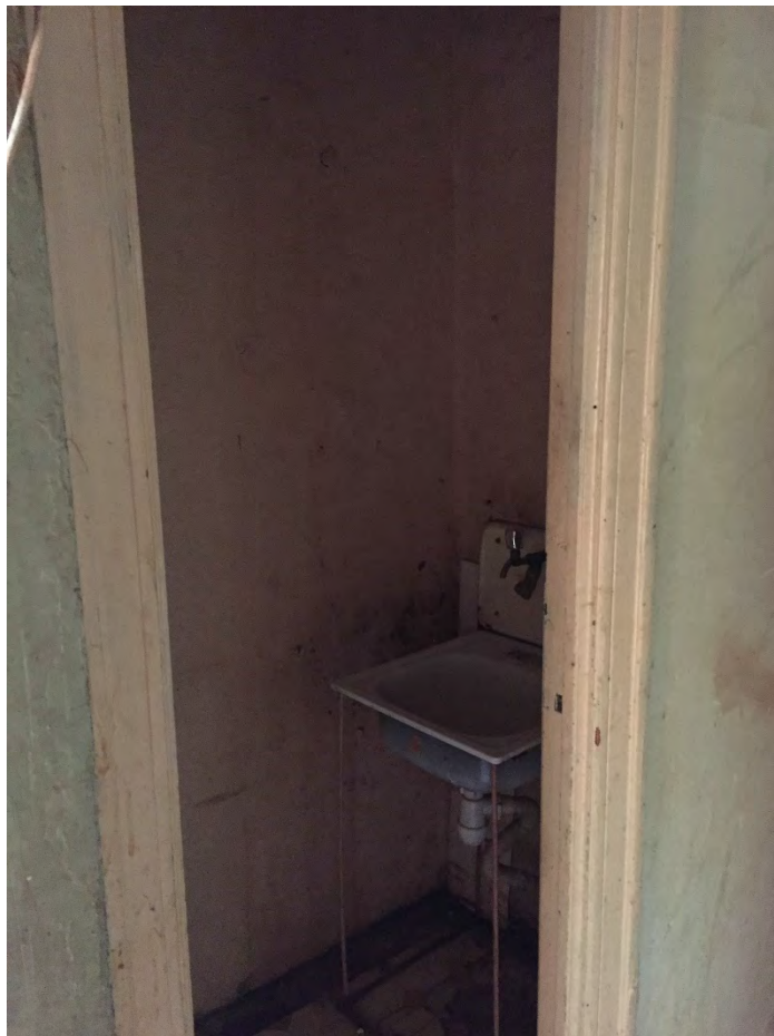
Илл. 33. Умывальная (помещение № 14). Вид с северо-востока.
