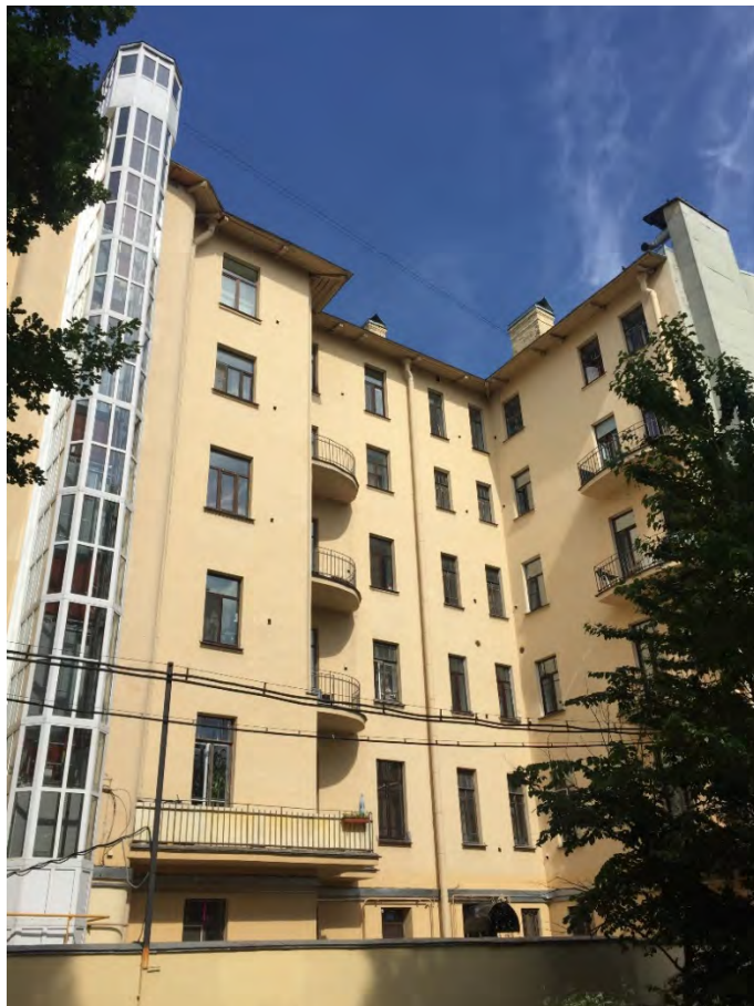
Илл. 5. Фрагмент дворового юго-западного фасада со стороны Лазаретного переуллка. Вид с юго-запада.
