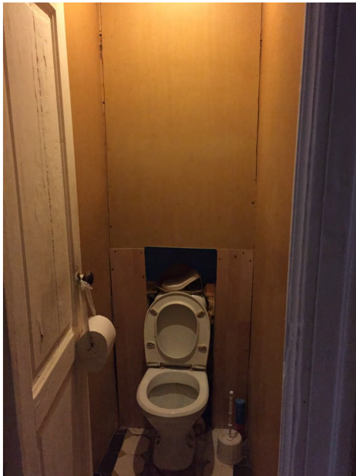
Илл. 31. Туалет (помещение № 12). Вид с северо-востока.
