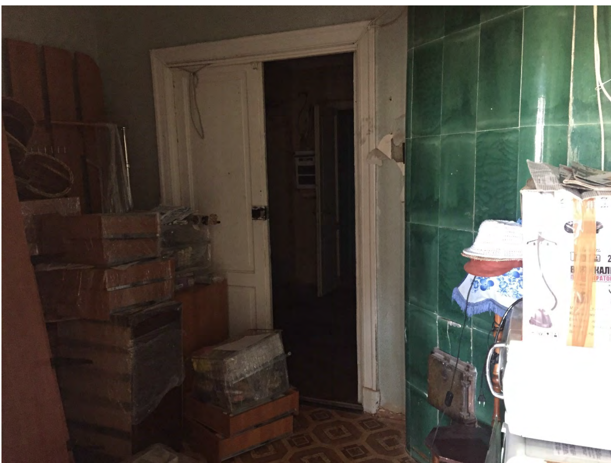
Илл. 12. Общий вид коридора (помещение № 17). Вид с севера.
