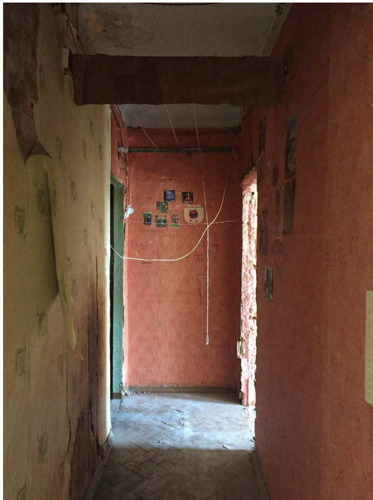
Илл. 35. Общий вид коридора (помещение № 15). Вид с северо-запада.
