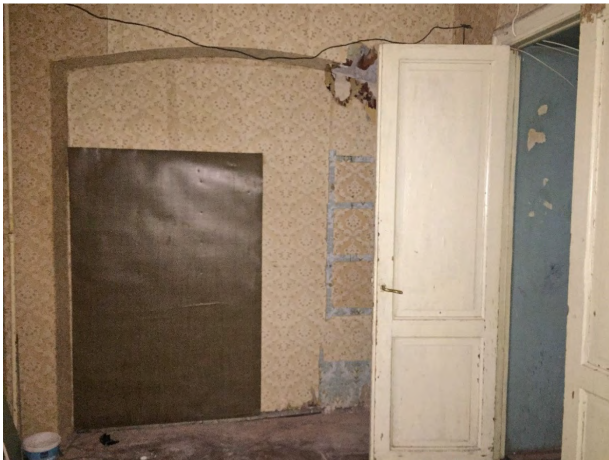
Илл. 9. Общий вид дверного заполнения в коридоре (помещение № 7). Вид с северо-востока
