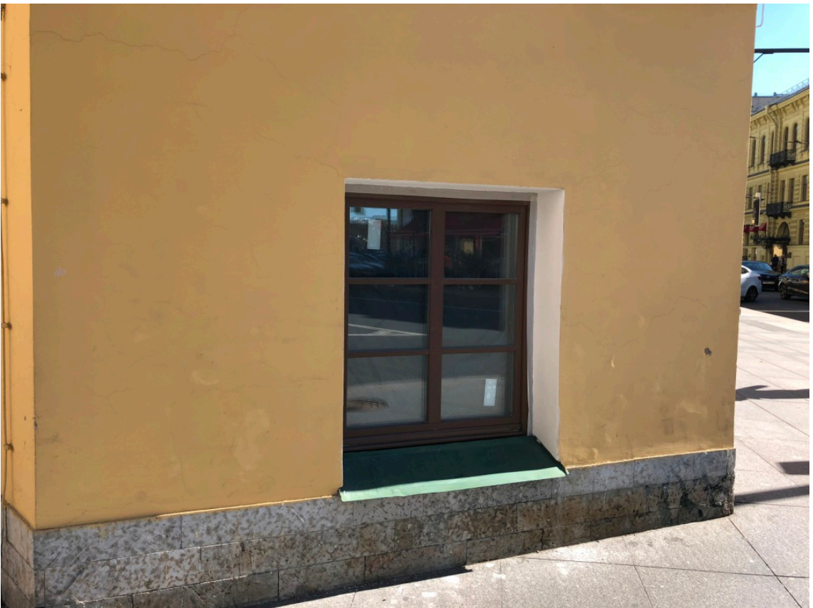
Фото 6. Фрагмент лицевого фасада с оконным проемом помещения 1-Н (ч.п. 3-34).
