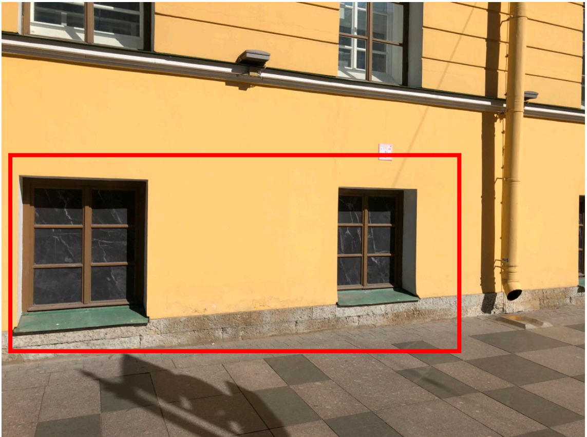
Фото 4. Фрагмент лицевого фасада с оконными проемами помещения 1-Н (ч.п. 3-34).
