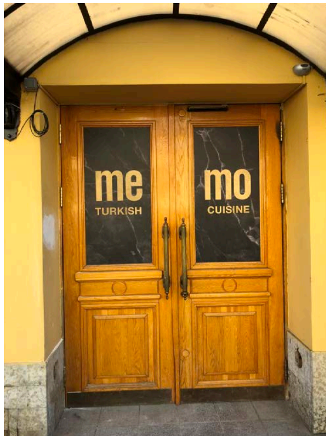
Фото 8. Входной дверной проем помещения 1-Н (ч.п. 3-34) со стороны Вознесенского пр.
