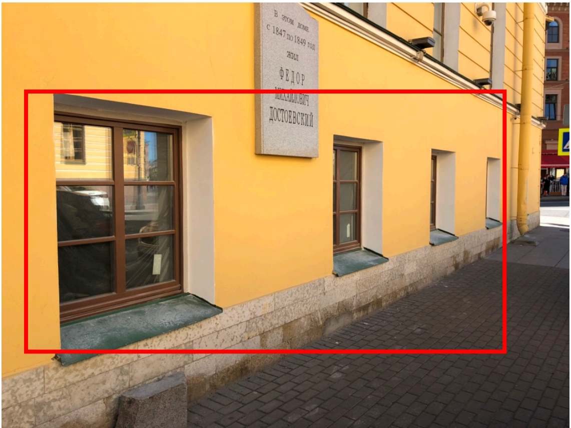
Фото 7. Фрагмент лицевого фасада с оконным проемом помещения 1-Н (ч.п. 3-34).
