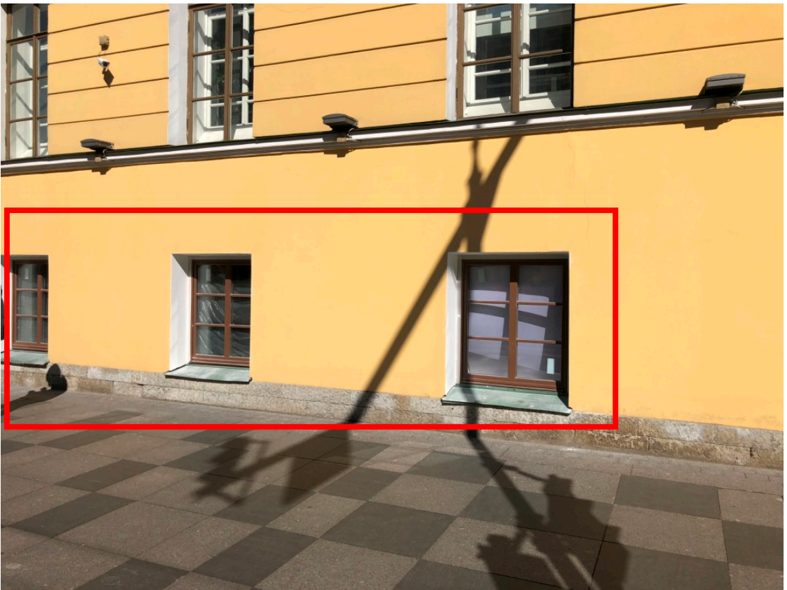
Фото 5. Фрагмент лицевого фасада с оконными проемами помещения 1-Н (ч.п. 3-34).
