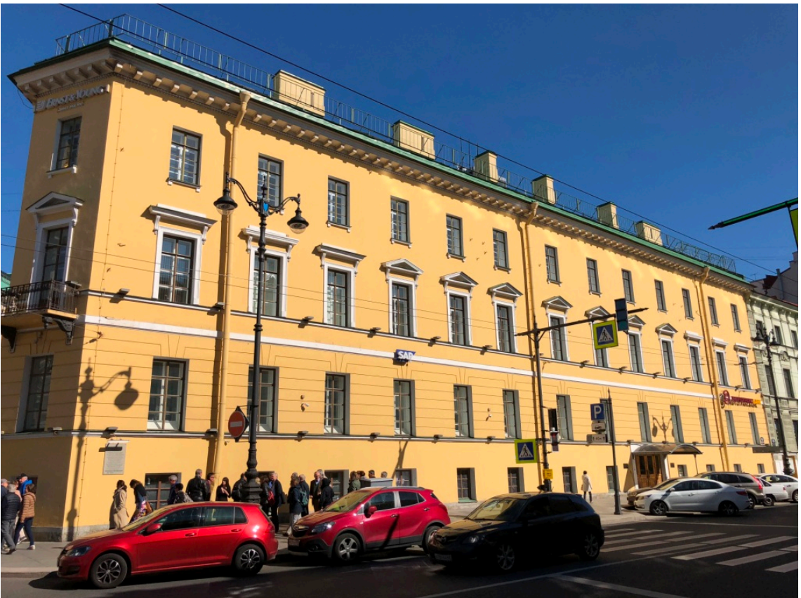
Фото 2. Лицевой фасад со стороны Малой Морской улицы.
