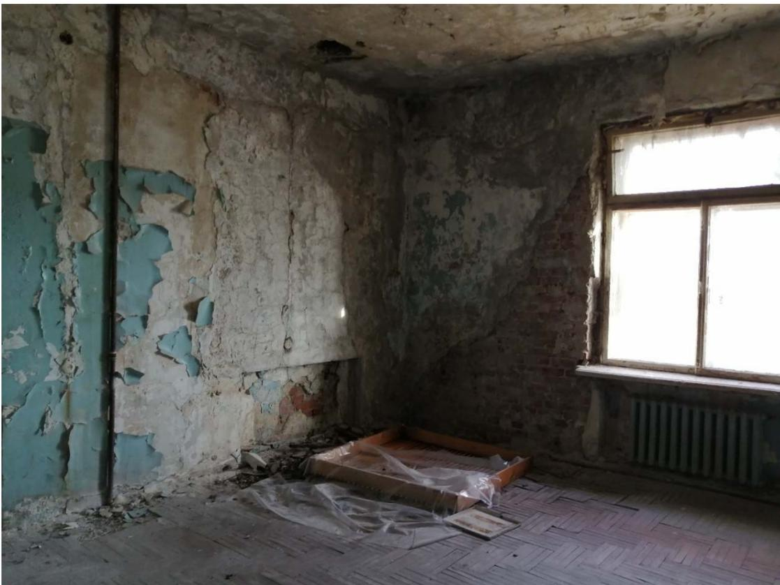
Фото 15. Общий вид помещения 5.132. Частичная утрата штукатурного покрытия стен, красочного покрытия.
