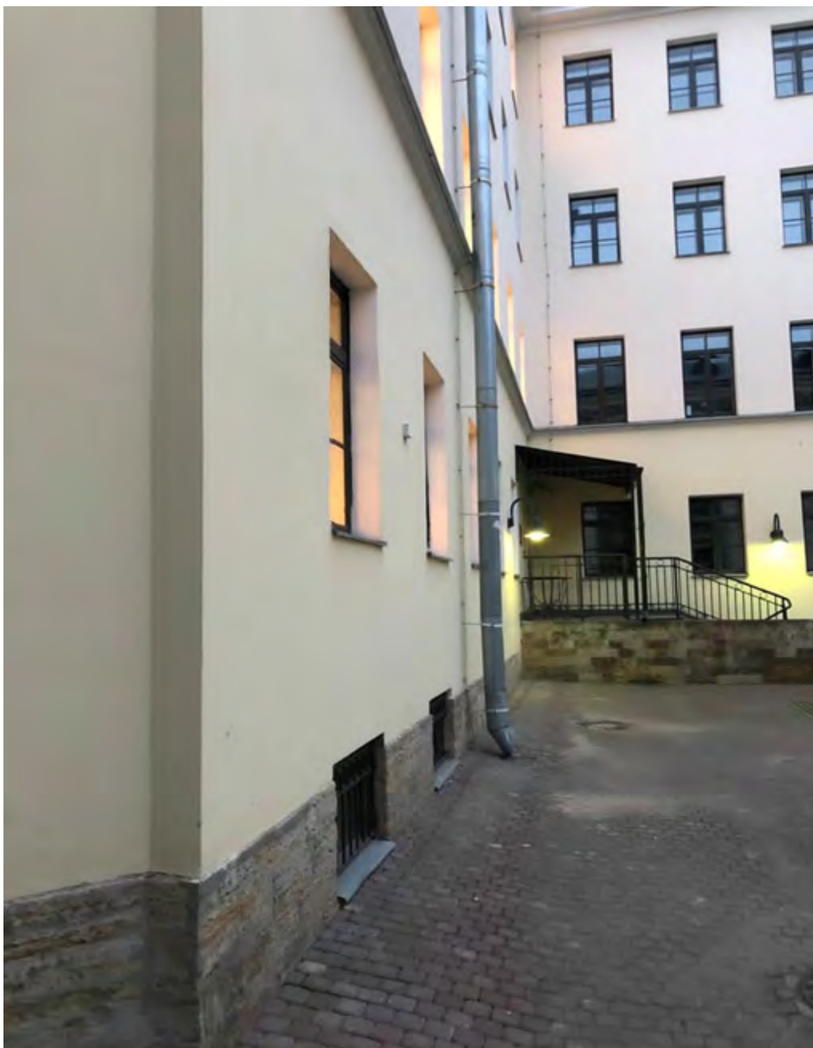
7. “Дом, в котором в 1890-1918 гг. жил экономист Даниельсон Н.Ф.”. Большая Конюшенная ул., 4-6-8, лит. А. Северный дворовый фасад. Фото: 15.12.2020.
