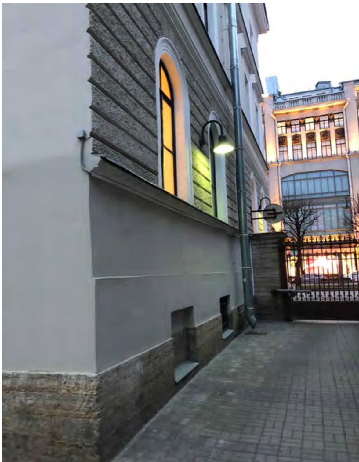
6. “Дом, в котором в 1890-1918 гг. жил экономист Даниельсон Н.Ф.”. Большая Конюшенная ул., 4-6-8, лит. А. Северный дворовый фасад. Фото: 15.12.2020.
