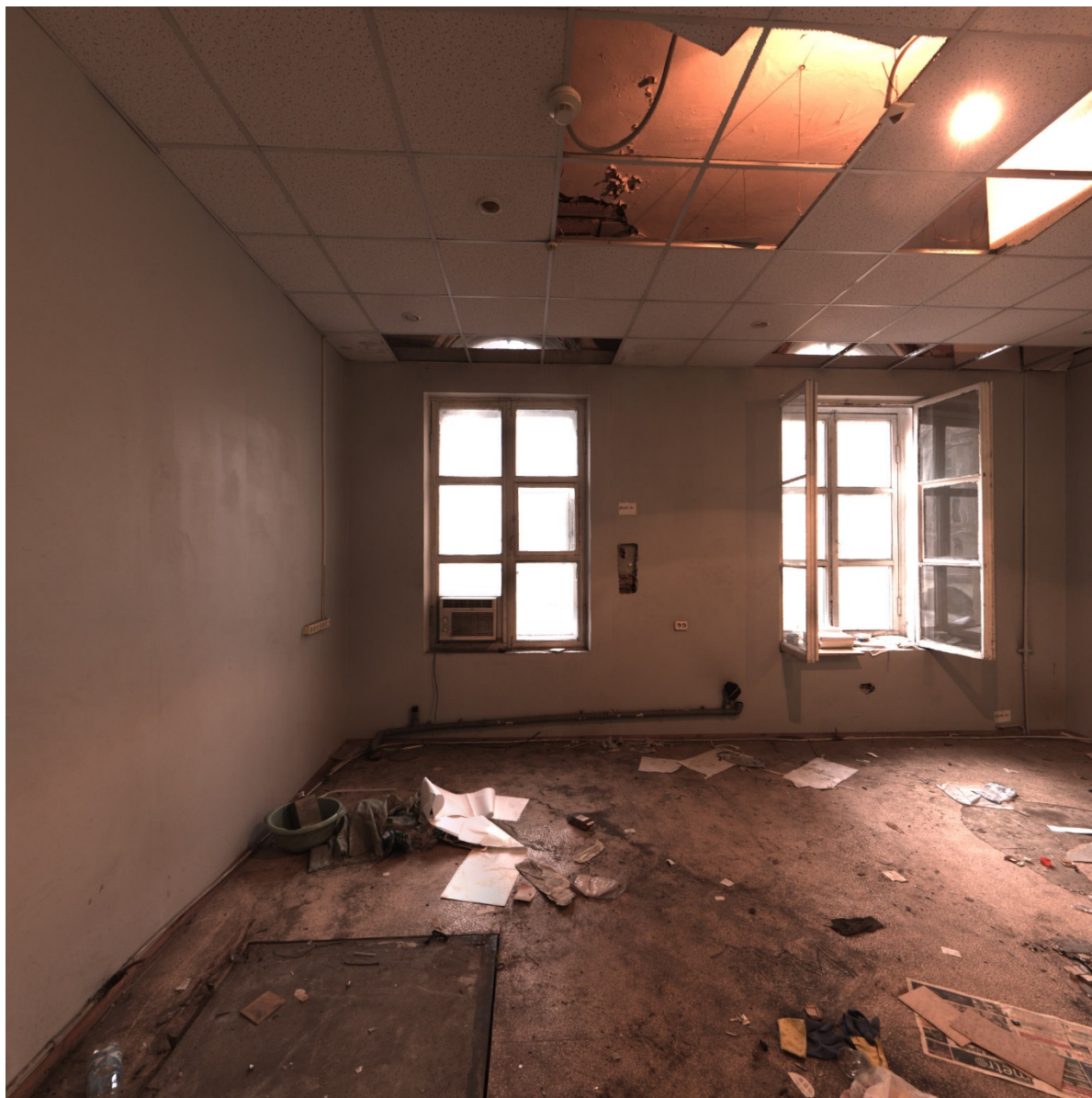
33. Помещение №28 в уровне 2-го этажа объекта культурного наследия федерального значения «Флигели (два). Флигель», расположенного по адресу: г. Санкт-Петербург, ул. Рентгена, д. 1 лит. Б. 31.07.2020.
