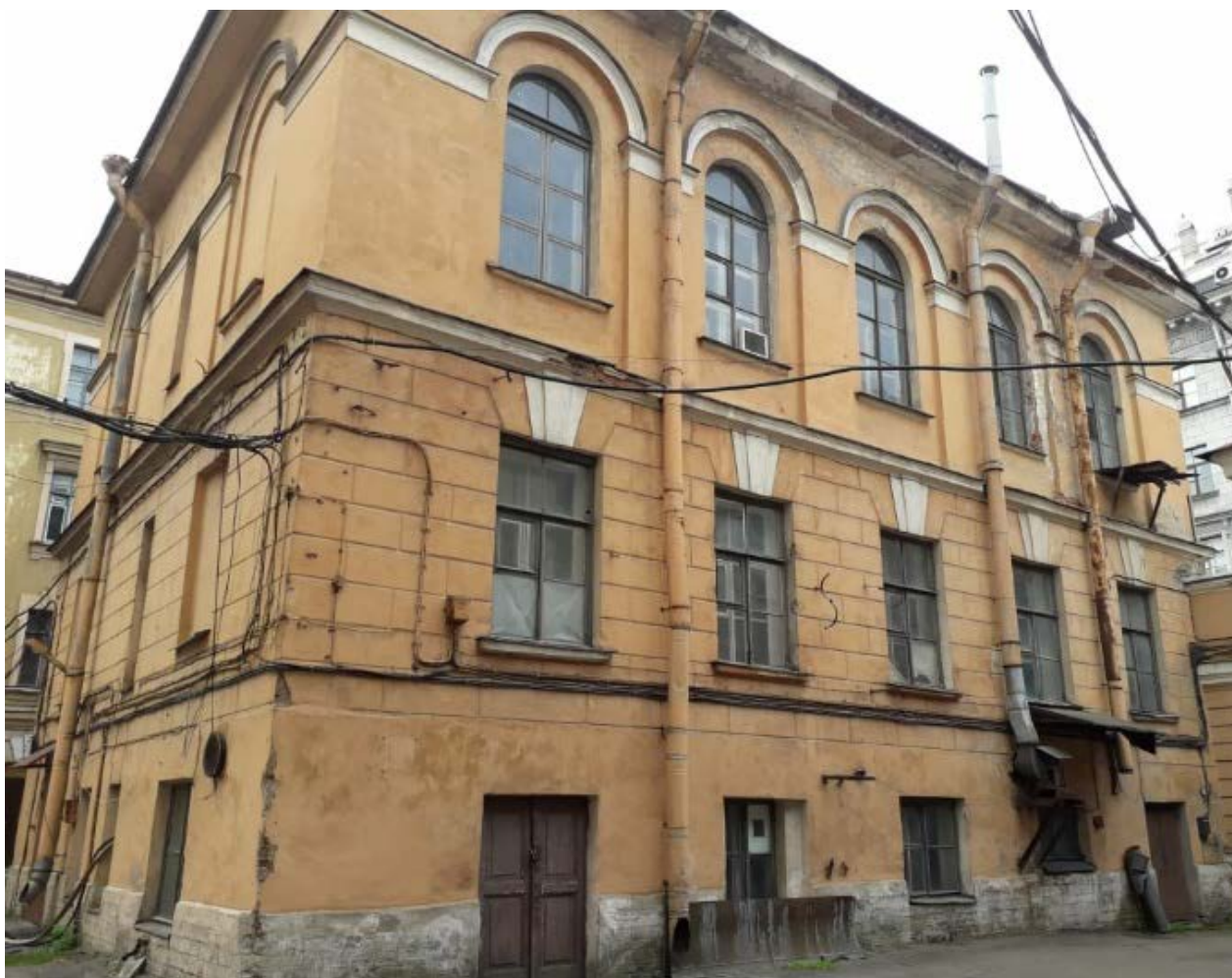
6. Северо-восточный фасад объекта культурного наследия федерального значения «Флигели (два). Флигель», расположенного по адресу: г. Санкт-Петербург, ул. Рентгена, д. 1 лит. Б, входящего в состав объекта культурного наследия федерального значения «Лицей Императорский Александровский». 31.07.2020.
