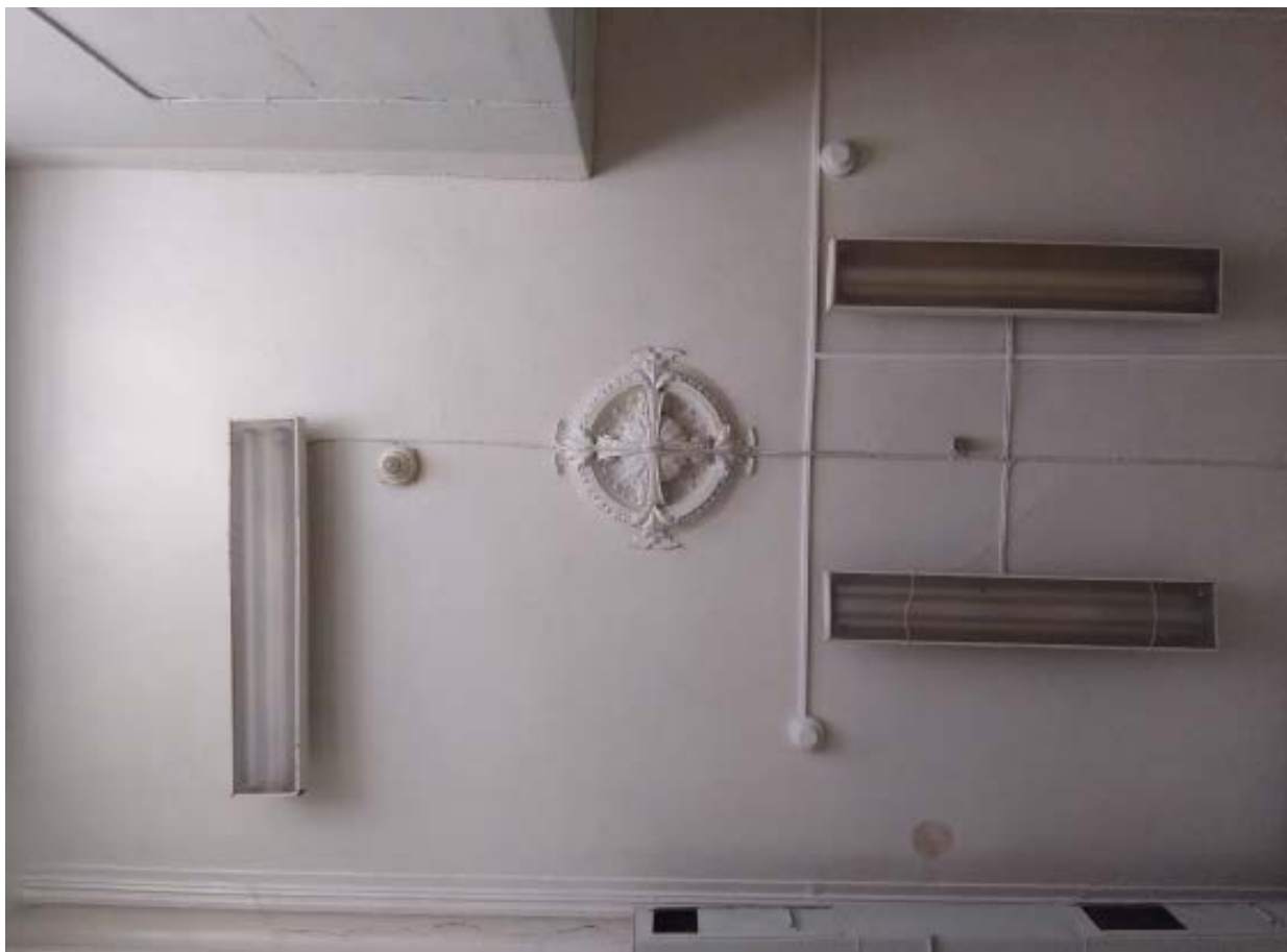
26. Помещение №12 в уровне 1-го этажа объекта культурного наследия федерального значения «Флигели (два). Флигель», расположенного по адресу: г. Санкт-Петербург, ул. Рентгена, д. 1 лит. Б. 31.07.2020.
