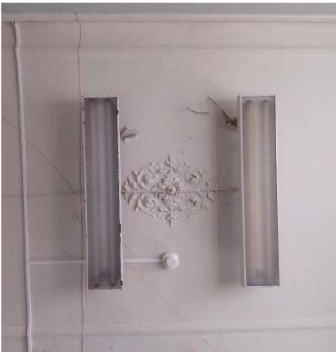
21. Помещение №17 (1-Н) в уровне 1-го этажа объекта культурного наследия федерального значения «Флигели (два). Флигель». 31.07.2020.
