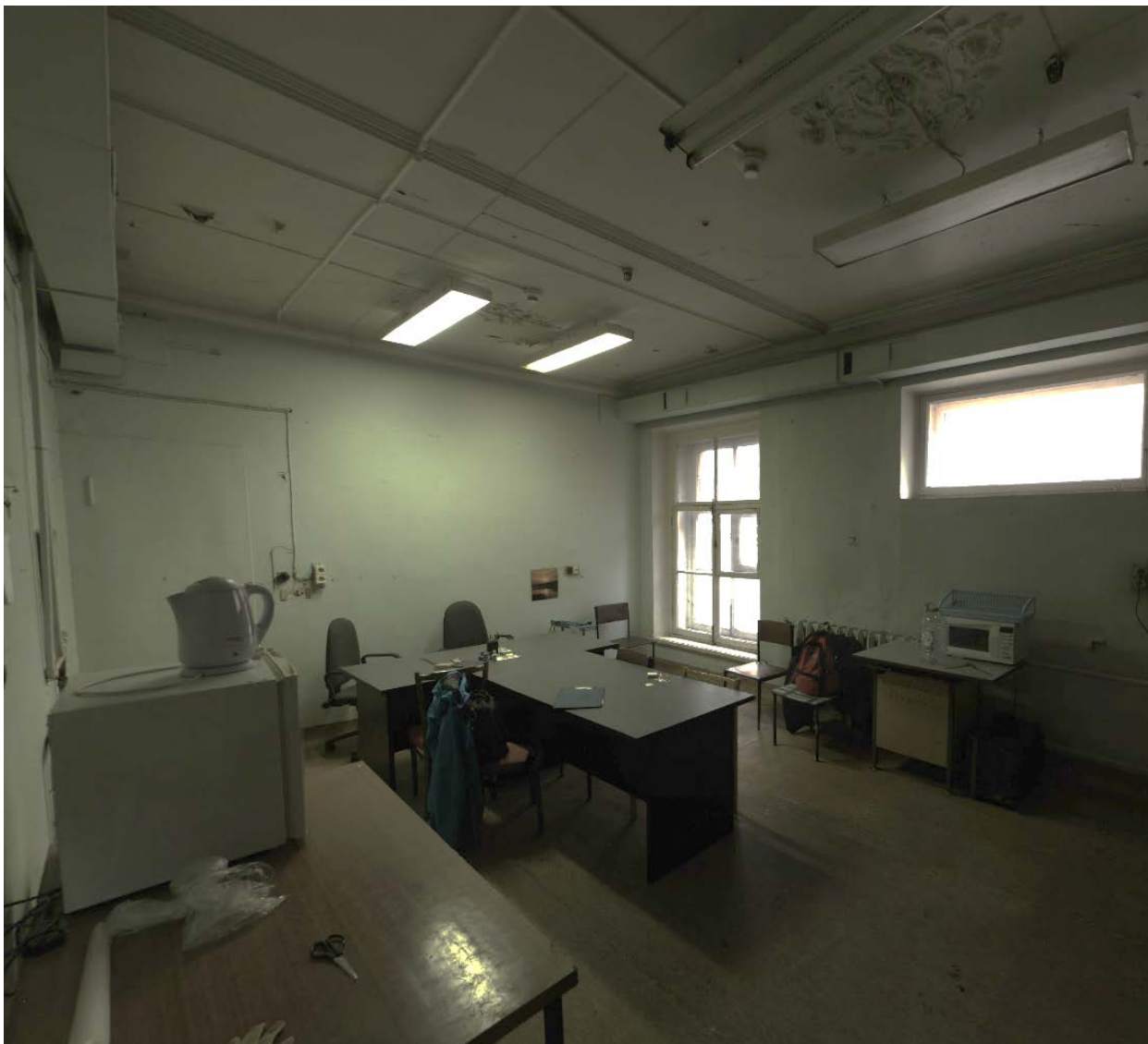
20. Помещение №17 (1-Н) в уровне 1-го этажа объекта культурного наследия федерального значения «Флигели (два). Флигель». 31.07.2020.
