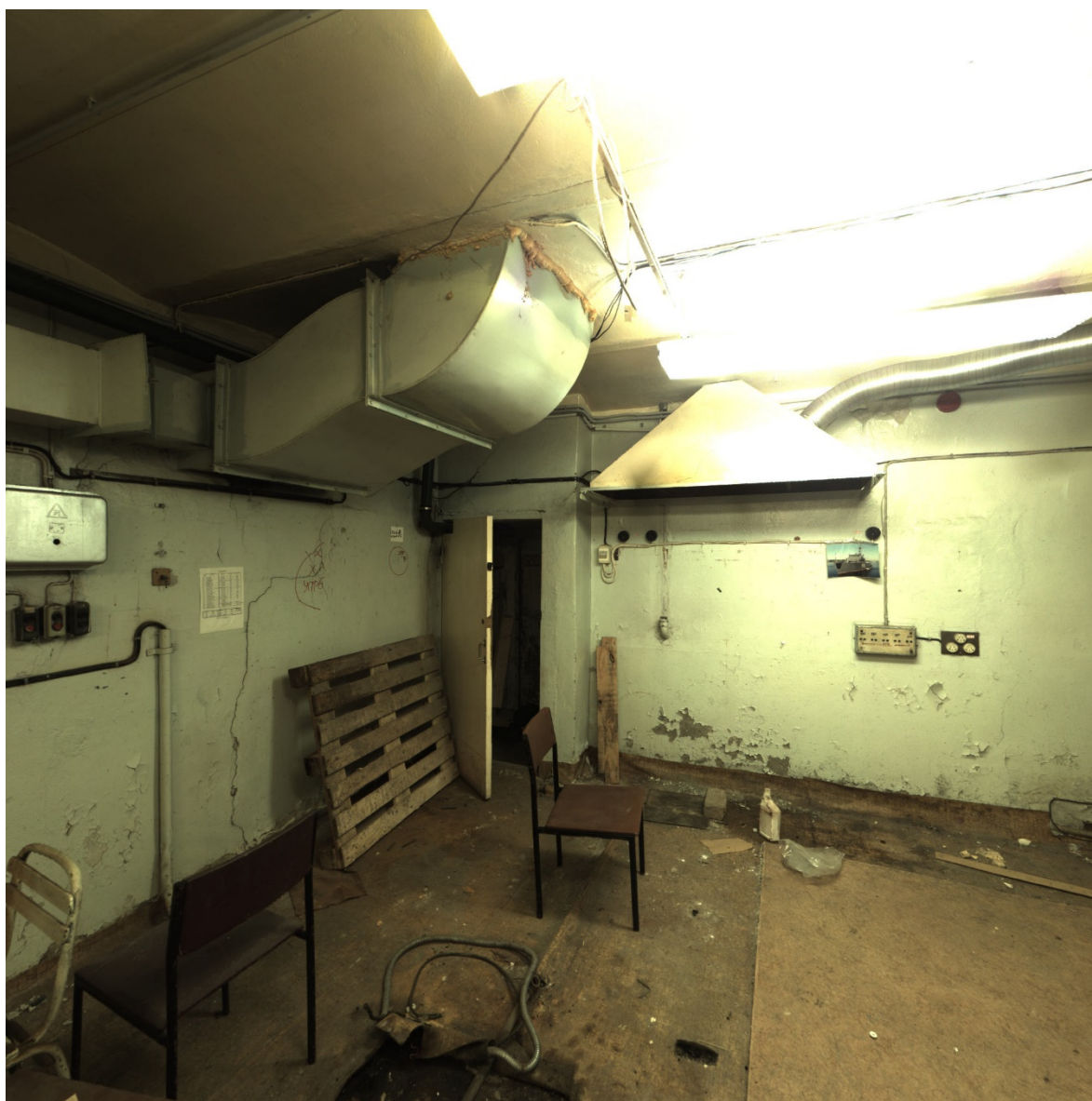
12. Помещение №3 (1-Н) в уровне цокольного этажа объекта культурного наследия федерального значения «Флигели (два). Флигель», расположенного по адресу: г. Санкт-Петербург, ул. Рентгена, д. 1 лит. Б. 31.07.2020.
