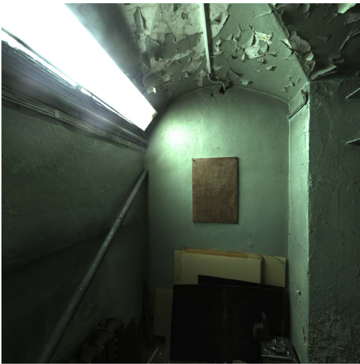
14. Помещение №2 (1-Н) в уровне цокольного этажа объекта культурного наследия федерального значения «Флигели (два). Флигель», расположенного по адресу: г. Санкт-Петербург, ул. Рентгена, д. 1 лит. Б. 31.07.2020.
