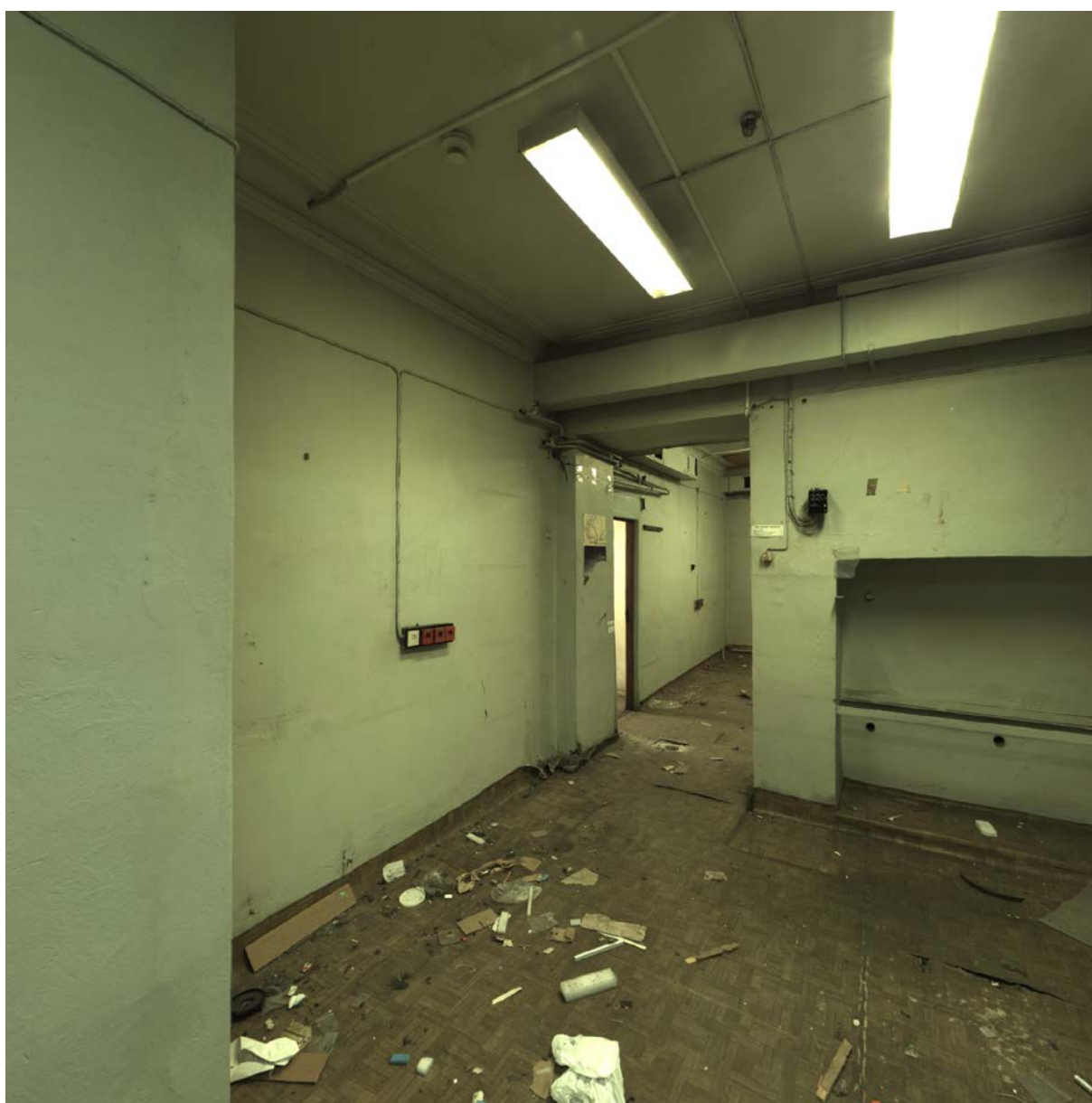
25. Помещение №12 в уровне 1-го этажа объекта культурного наследия федерального значения «Флигели (два). Флигель», расположенного по адресу: г. Санкт-Петербург, ул. Рентгена, д. 1 лит. Б. 31.07.2020.
