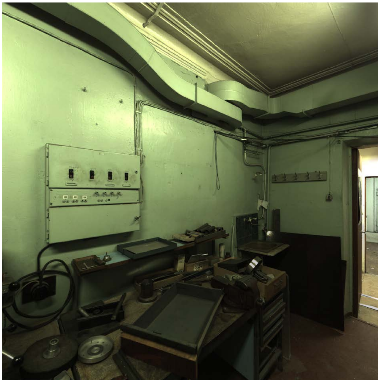
23. Помещение №13 (1-Н) в уровне 1-го этажа объекта культурного наследия федерального значения «Флигели (два). Флигель». 31.07.2020.
