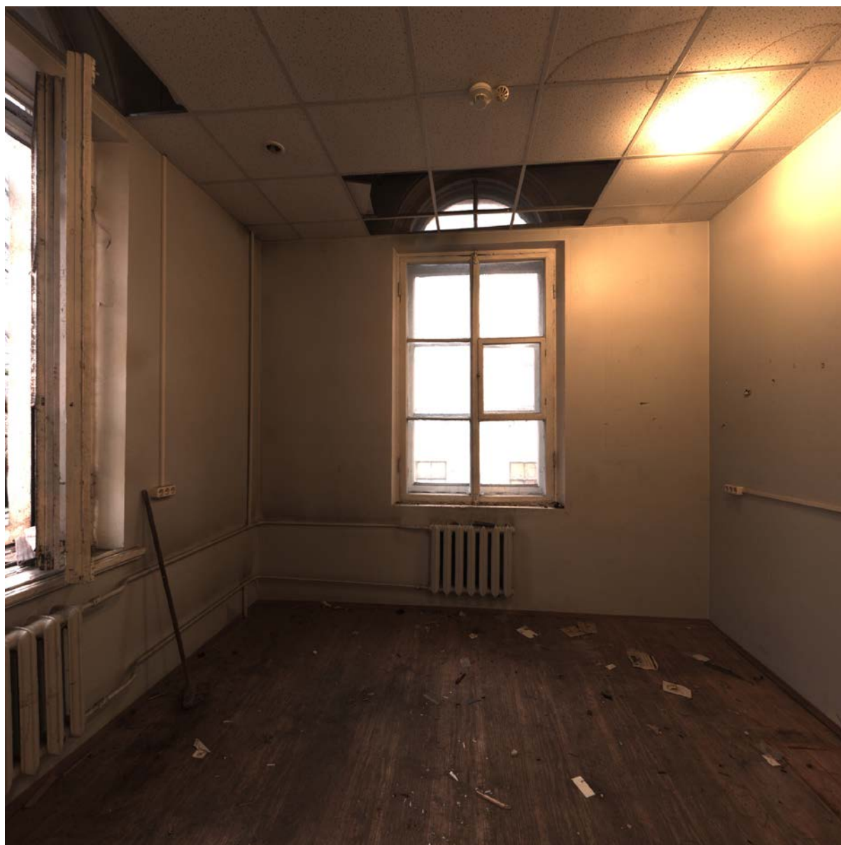
41. Помещение №29 в уровне 2-го этажа объекта культурного наследия федерального значения «Флигели (два). Флигель», расположенного по адресу: г. Санкт-Петербург, ул. Рентгена, д. 1 лит. Б. 31.07.2020.
