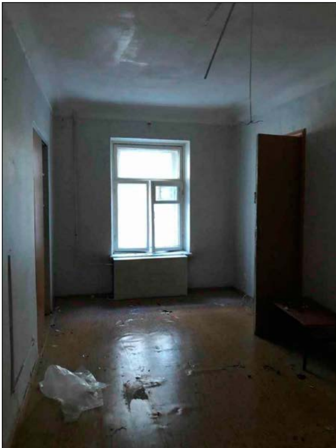
7. Помещение №10 кв. №11 в уровне 1-го этажа объекта культурного наследия регионального значения «Дом кн. Л.Д. Вяземского», расположенного по адресу: г. Санкт-Петербург, Галерная ул., д. 67, литера А. 07.12.2020.
