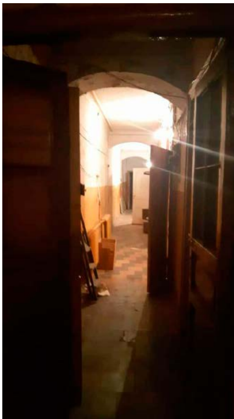
4. Помещение №13 кв. №11 в уровне 1-го этажа объекта культурного наследия регионального значения «Дом кн. Л.Д. Вяземского», расположенного по адресу: г. Санкт-Петербург, Галерная ул., д. 67, литера А. 07.12.2020.
