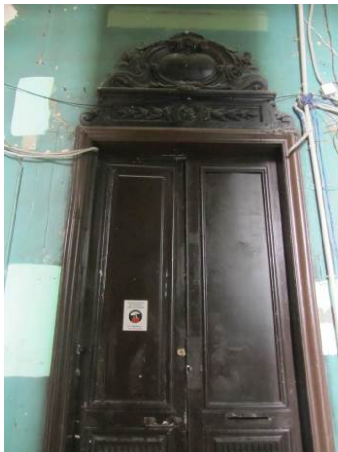
10. ОКН регионального значения «Жилой дом страхового общества “Россия” с садом и оградой» (г. Санкт-Петербург, Моховая ул., 27-29) Парадная лестница.
