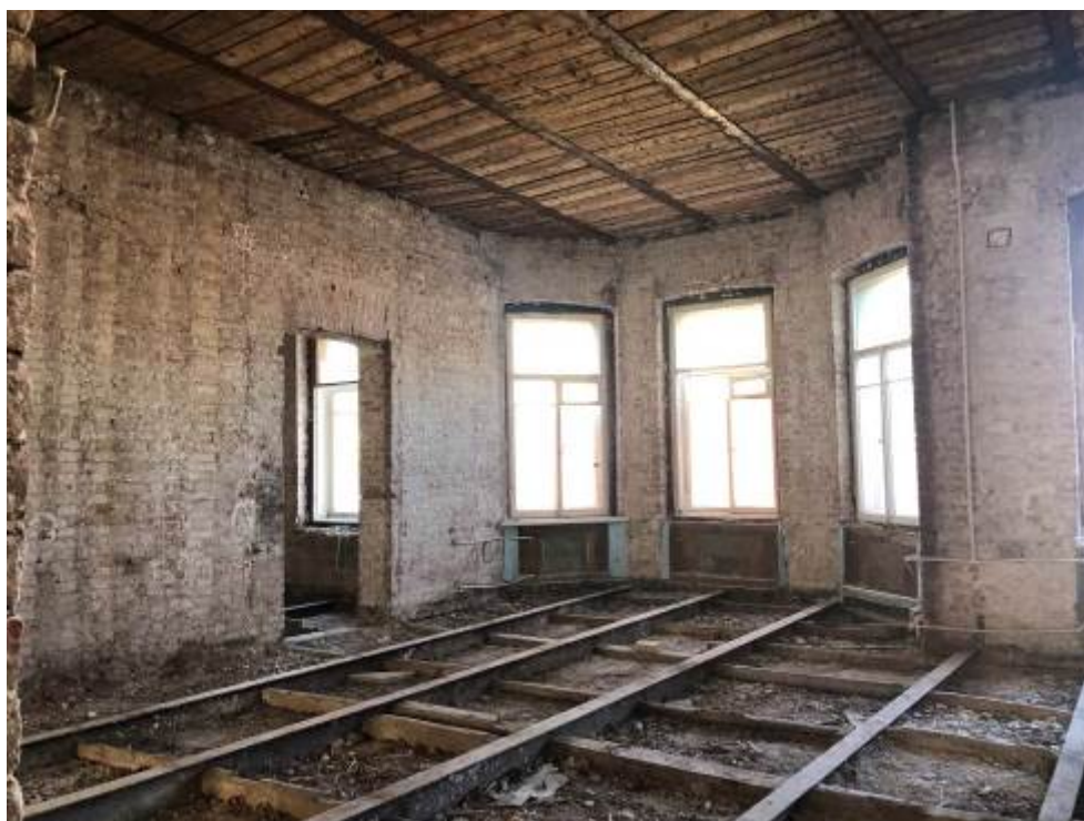
29. ОКН регионального значения «Жилой дом страхового общества “Россия” с садом и оградами» (г. Санкт-Петербург, Моховая ул., 27-29) Помещение квартиры №36
