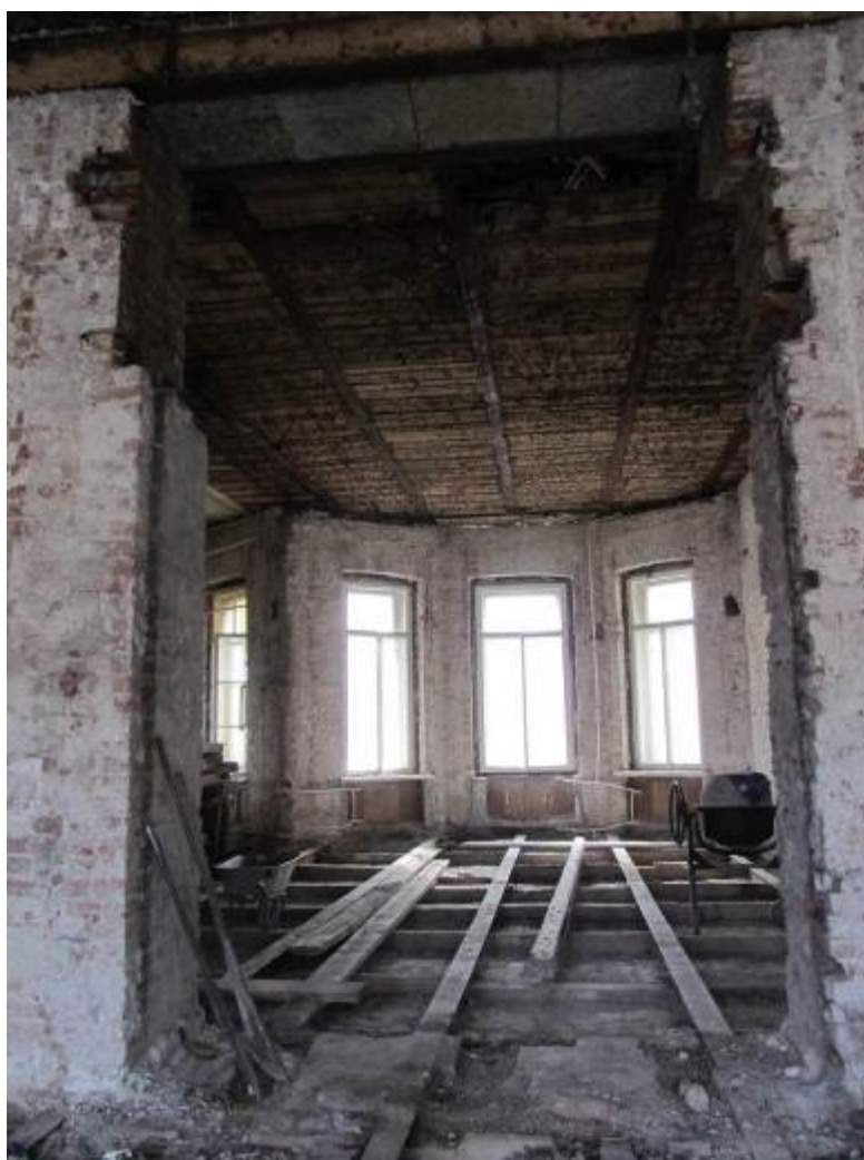
17. ОКН регионального значения «Жилой дом страхового общества “Россия” с садом и оградами» (г. Санкт-Петербург, Моховая ул., 27-29) Помещение квартиры №36
