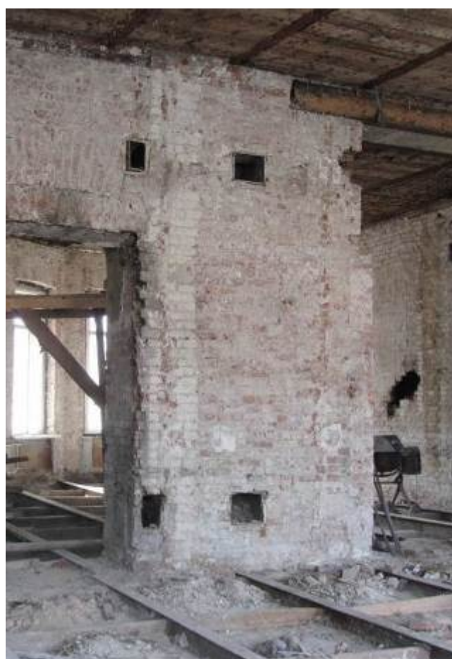
13. ОКН регионального значения «Жилой дом страхового общества «Россия» с садом и оградами» (г. Санкт-Петербург, Моховая ул., 27-29) Помещение квартиры №36
