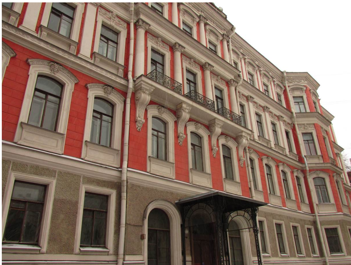
5. ОКН регионального значения «Жилой дом страхового общества “Россия” с садом и оградой» (г. Санкт-Петербург, Моховая ул., 27-29) Курдонер.
