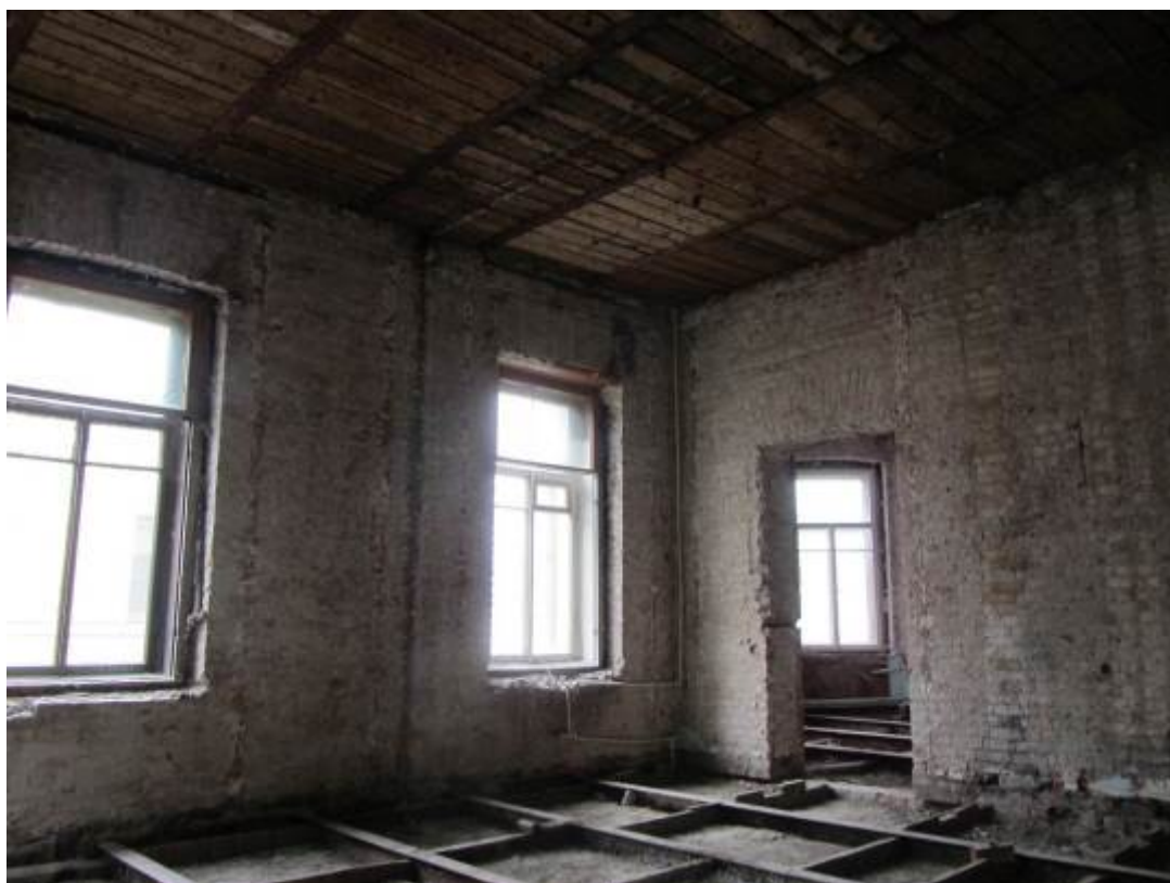
35. ОКН регионального значения «Жилой дом страхового общества «Россия» с садом и оградами» (г. Санкт-Петербург, Моховая ул., 27-29) Помещение квартиры №36
