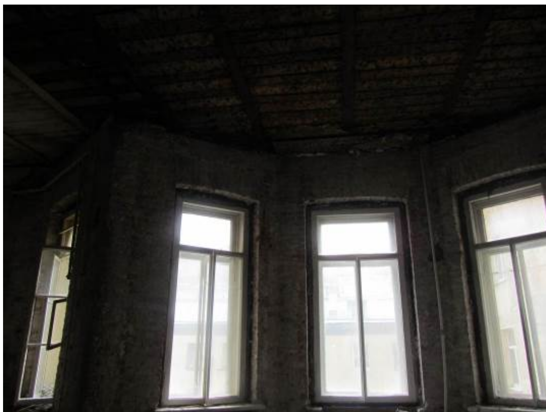
22. ОКН регионального значения «Жилой дом страхового общества «Россия» с садом и оградами» (г. Санкт-Петербург, Моховая ул., 27-29) Помещение квартиры №36
