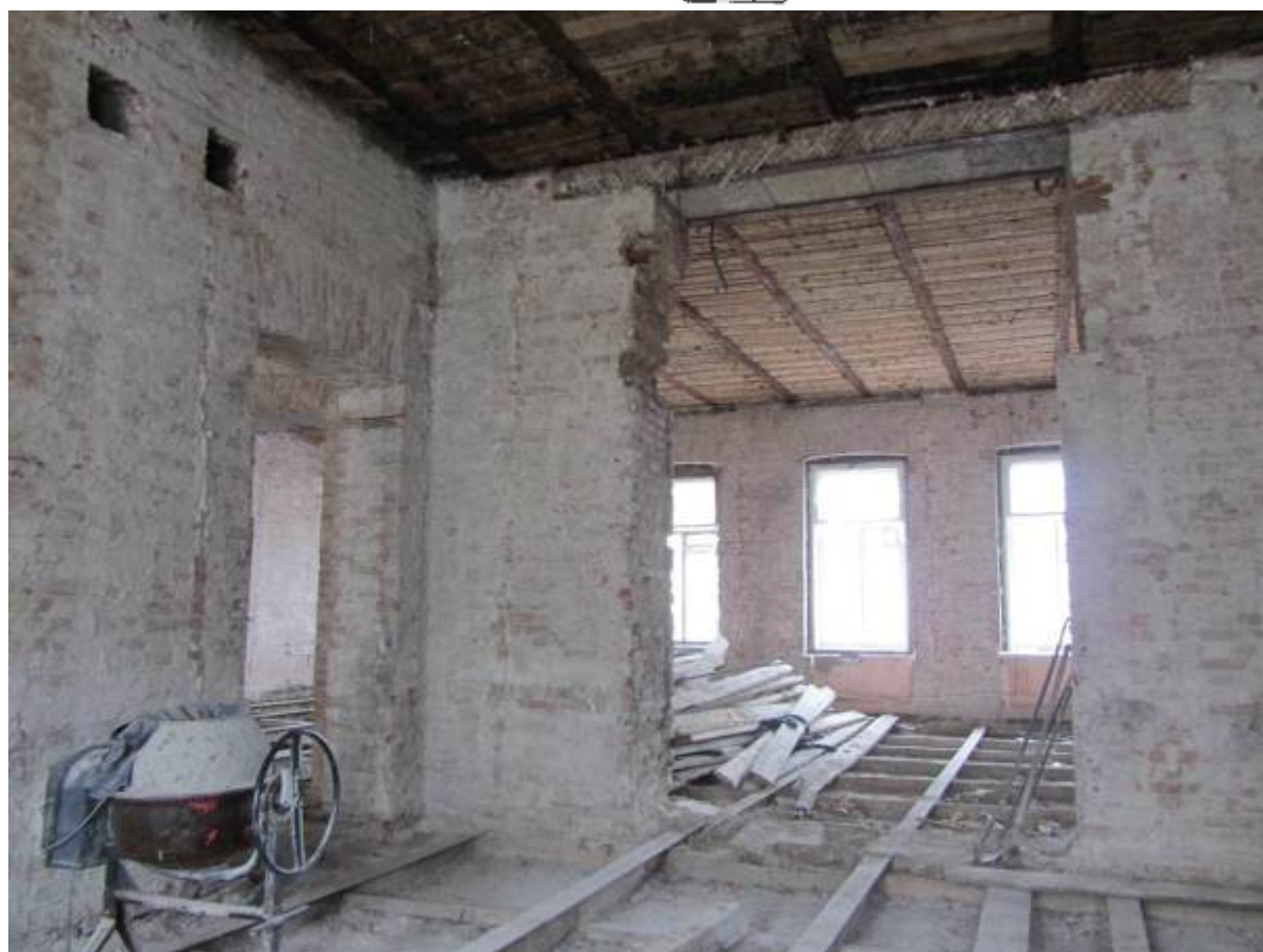
27. ОКН регионального значения «Жилой дом страхового общества «Россия» с садом и оградами» (г. Санкт-Петербург, Моховая ул., 27-29) Помещение квартиры №36
