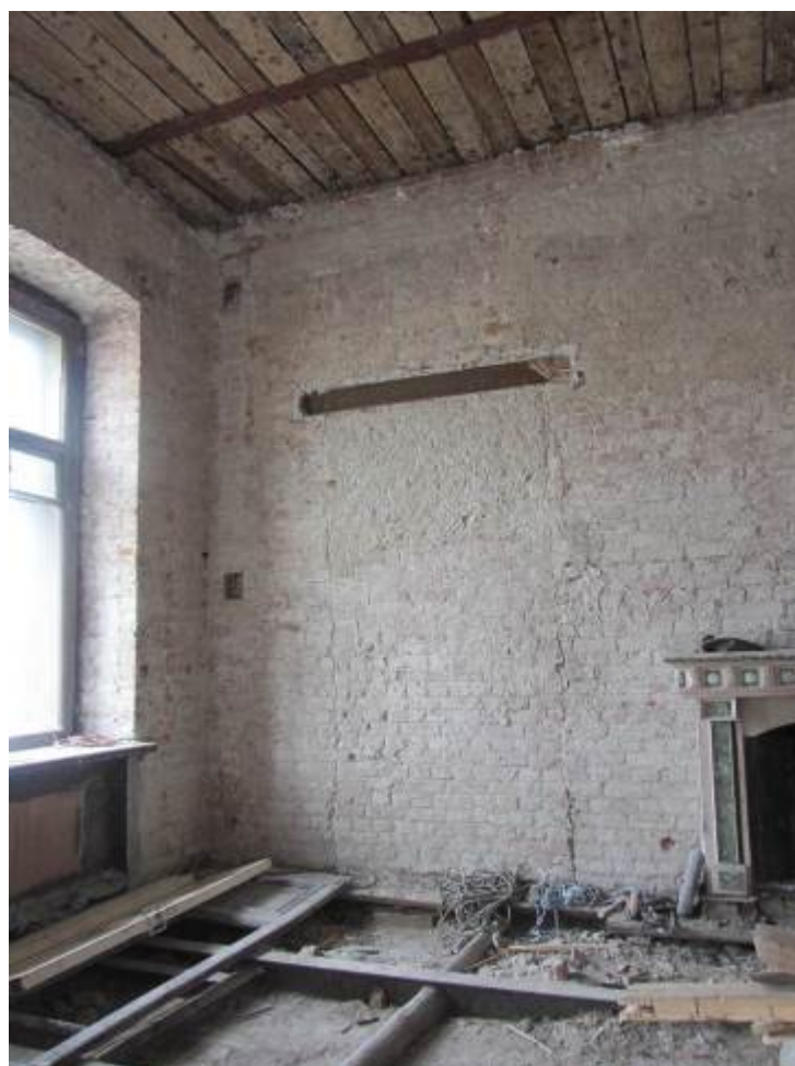
15. ОКН регионального значения «Жилой дом страхового общества «Россия» с садом и оградами» (г. Санкт-Петербург, Моховая ул., 27-29) Помещение квартиры №36
