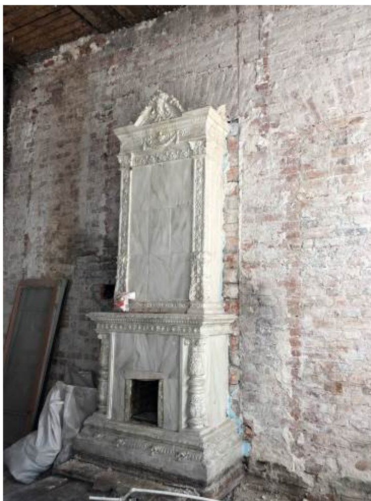
41. ОКН регионального значения «Жилой дом страхового общества «Россия» с садом и оградами» (г. Санкт-Петербург, Моховая ул., 27-29) Помещение квартиры №36.
