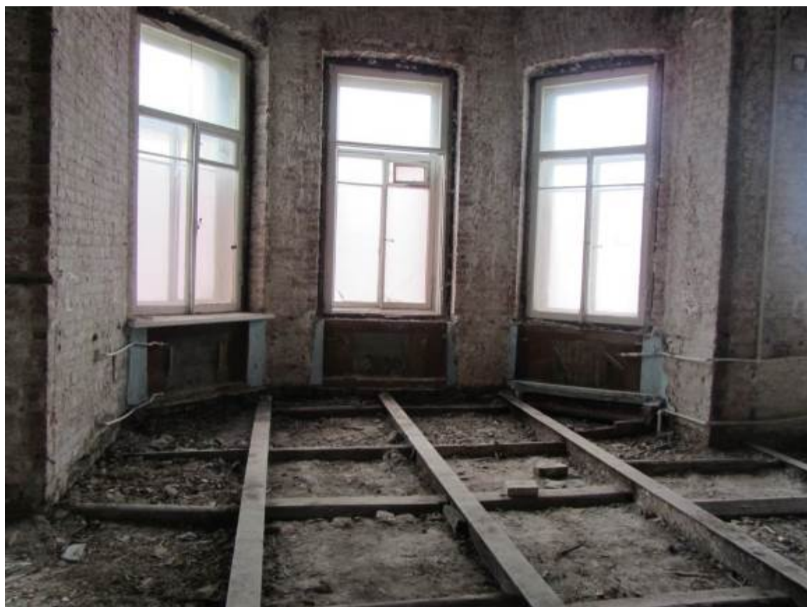
45. ОКН регионального значения «Жилой дом страхового общества «Россия» с садом и оградами» (г. Санкт-Петербург, Моховая ул., 27-29) Помещение квартиры №36
