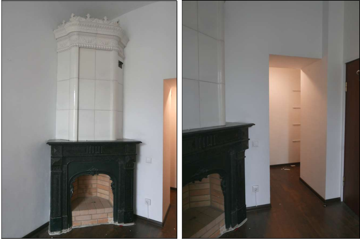
11. Помещение № 17 комната [согласно инвентарному плану]. Угловой двухъярусный печь-камин.
