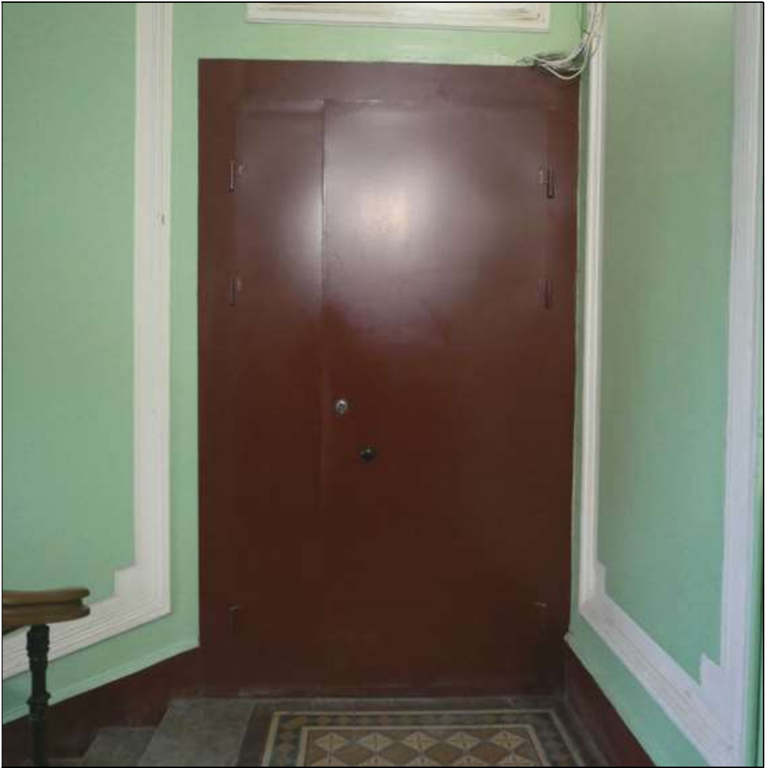
4. Дом В.А. Ратькова-Рожнова. Парадная лестница (2 ЛК), третий этаж. Вход в квартиру № 14.
