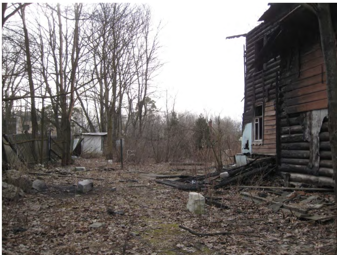
4. ОКН РЗ «Дача Гербель» по адресу: г.Санкт-Петербург, ул. Межозёрная, дом 4, литера А. Вид на юго-западную часть земельного участка и фрагмент южного фасада здания. Дата съёмки: 06.04.2016 г.
