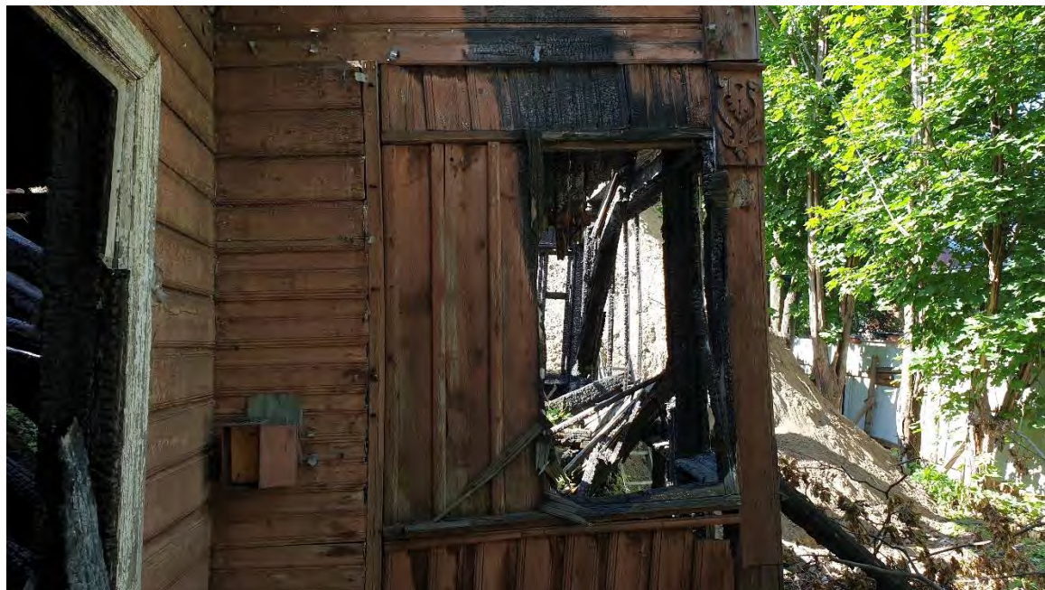
23. ОКН РЗ «Дача Гербель» по адресу: г. Санкт-Петербург, ул. Межозёрная, дом 4, литера А. Восточный фасад. Дата съёмки: 19.06.2019 г.
