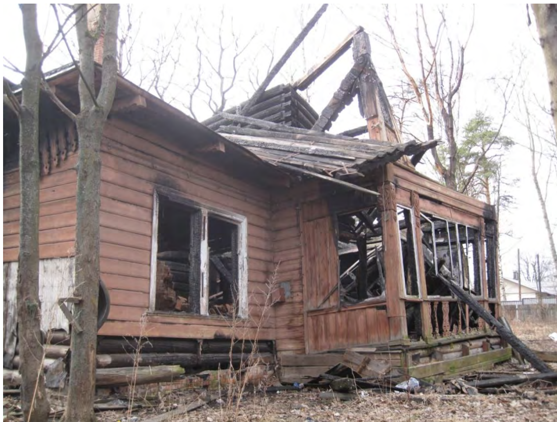
2. ОКН РЗ «Дача Гербель» по адресу: г.Санкт-Петербург, ул. Межозёрная, дом 4, литера А. Восточный фасад. Дата съёмки: 06.04.2016 г.
