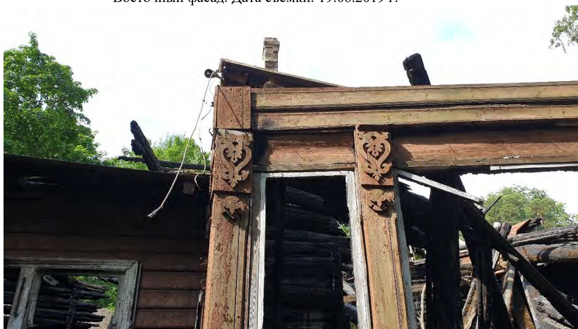
22. ОКН РЗ «Дача Гербель» по адресу: г. Санкт-Петербург, ул. Межозёрная, дом 4, литера А. Восточный фасад. Дата съёмки: 19.06.2019 г.
