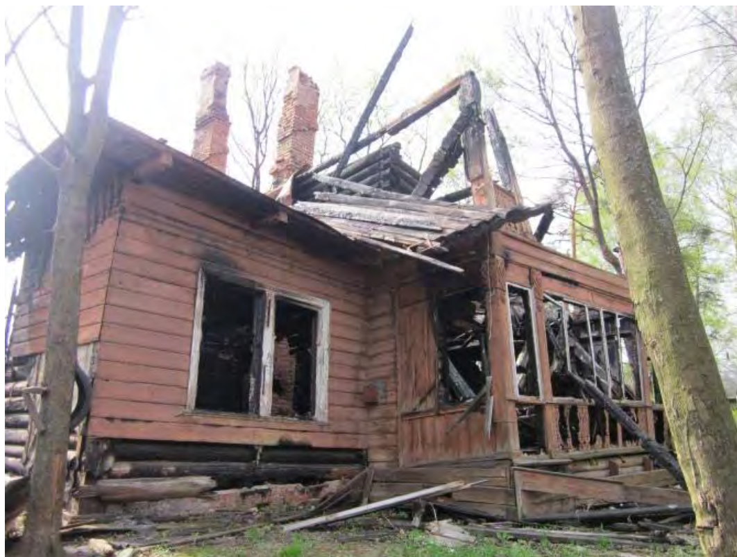
36. Дача Гербель (Межозёрная ул., д. 4, лит. А). Восточный фасад. Фото 2015 г. ( www.citywalls.ru )
