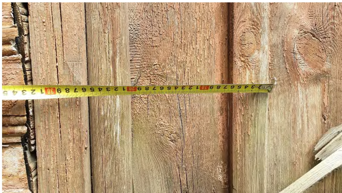
31. ОКН РЗ «Дача Гербель» по адресу: г. Санкт-Петербург, ул. Межозёрная, дом 4, литера А. Фрагмент дощатой обшивки вертикальной со штапиками. Дата съёмки: 19.06.2019 г.
