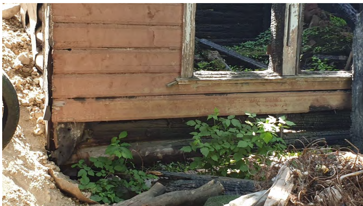
20. ОКН РЗ «Дача Гербель» по адресу: г.Санкт-Петербург, ул. Межозёрная, дом 4, литера А. Восточный фасад, фрагмент цоколя. Дата съёмки: 19.06.2019 г.
