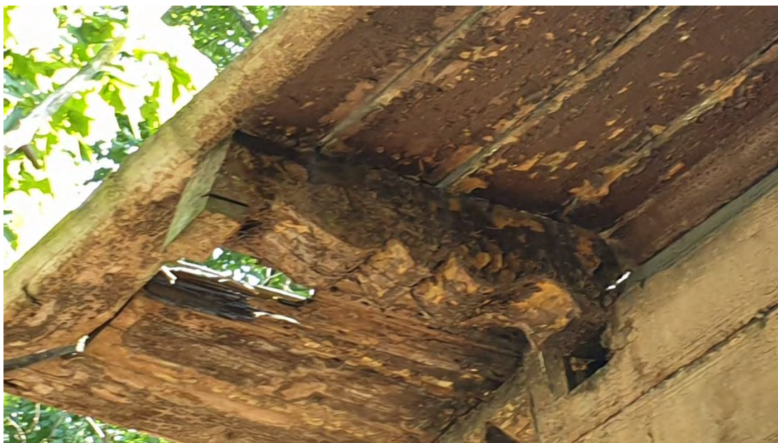
19. ОКН РЗ «Дача Гербель» по адресу: г.Санкт-Петербург, ул. Межозёрная, дом 4, литера А. Восточный фасад, фрагмент карниза. Дата съёмки: 19.06.2019 г.
