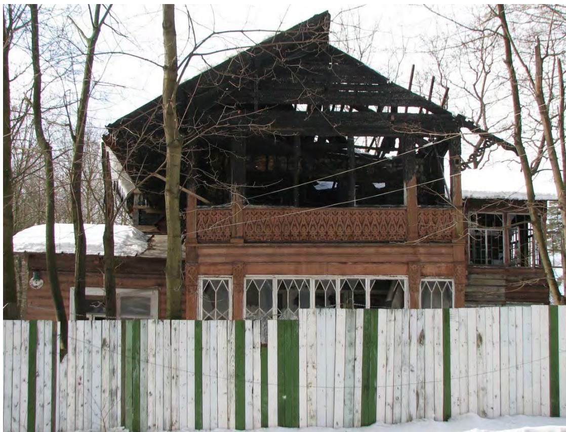
34. Дача Гербель (Межозёрная ул., д. 4, лит. А). Восточный фасад. Фото 2013 г. ( www.citywalls.ru )
