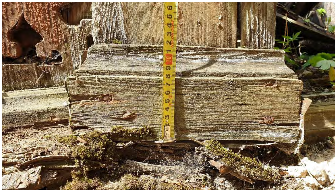
36. ОКН РЗ «Дача Гербель» по адресу: г. Санкт-Петербург, ул. Межозёрная, дом 4, литера А. Фрагмент фасадной панели. Дата съёмки: 19.06.2019 г.
