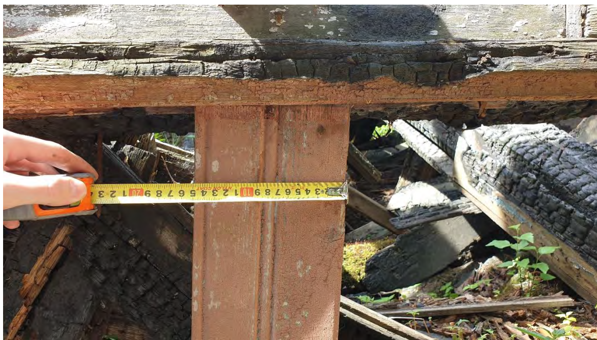
30. ОКН РЗ «Дача Гербель» по адресу: г. Санкт-Петербург, ул. Межозёрная, дом 4, литера А. Фрагмент дощатой обшивки фасада. Дата съёмки: 19.06.2019 г.
