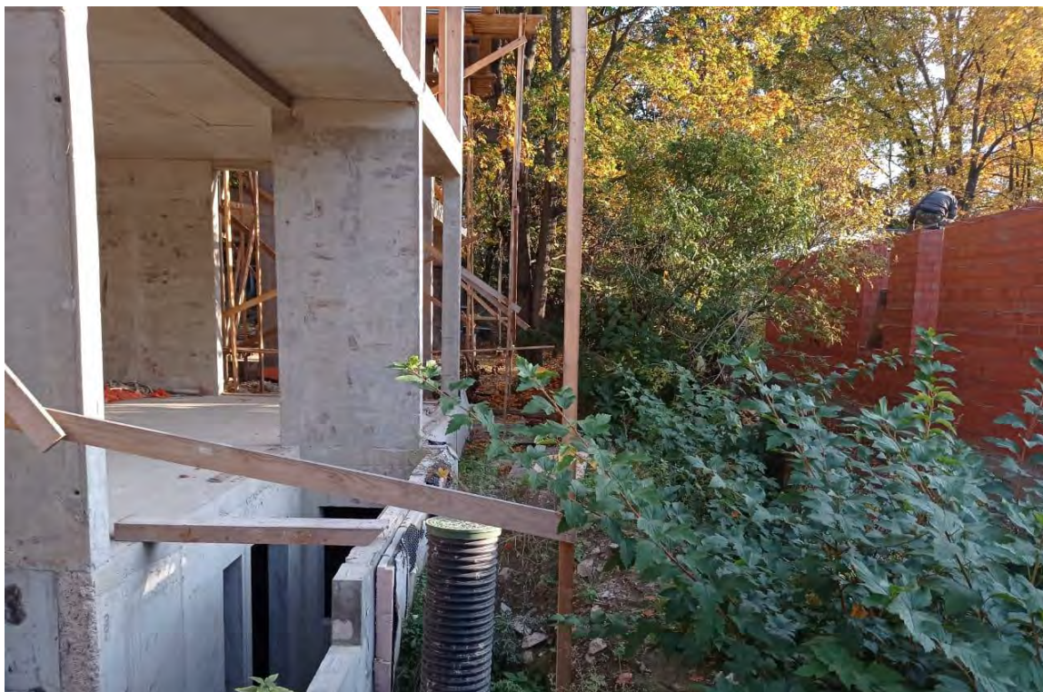
50. ОКН РЗ «Дача Гербель» по адресу: г. Санкт-Петербург, ул. Межозёрная, дом 4, литера А. Вид на западный фасад. Дата съёмки: 24.09.2020 г.
