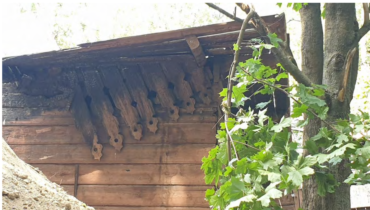
32. ОКН РЗ «Дача Гербель» по адресу: г. Санкт-Петербург, ул. Межозёрная, дом 4, литера А. Южный фасад, фрагмент фронтона. Дата съёмки: 19.06.2019 г.
