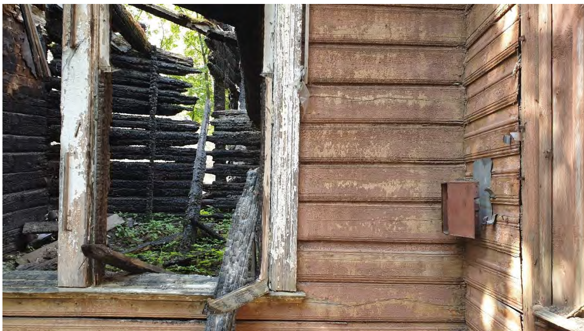
26. ОКН РЗ «Дача Гербель» по адресу: г. Санкт-Петербург, ул. Межозёрная, дом 4, литера А. Восточный фасад. Дата съёмки: 19.06.2019 г.
