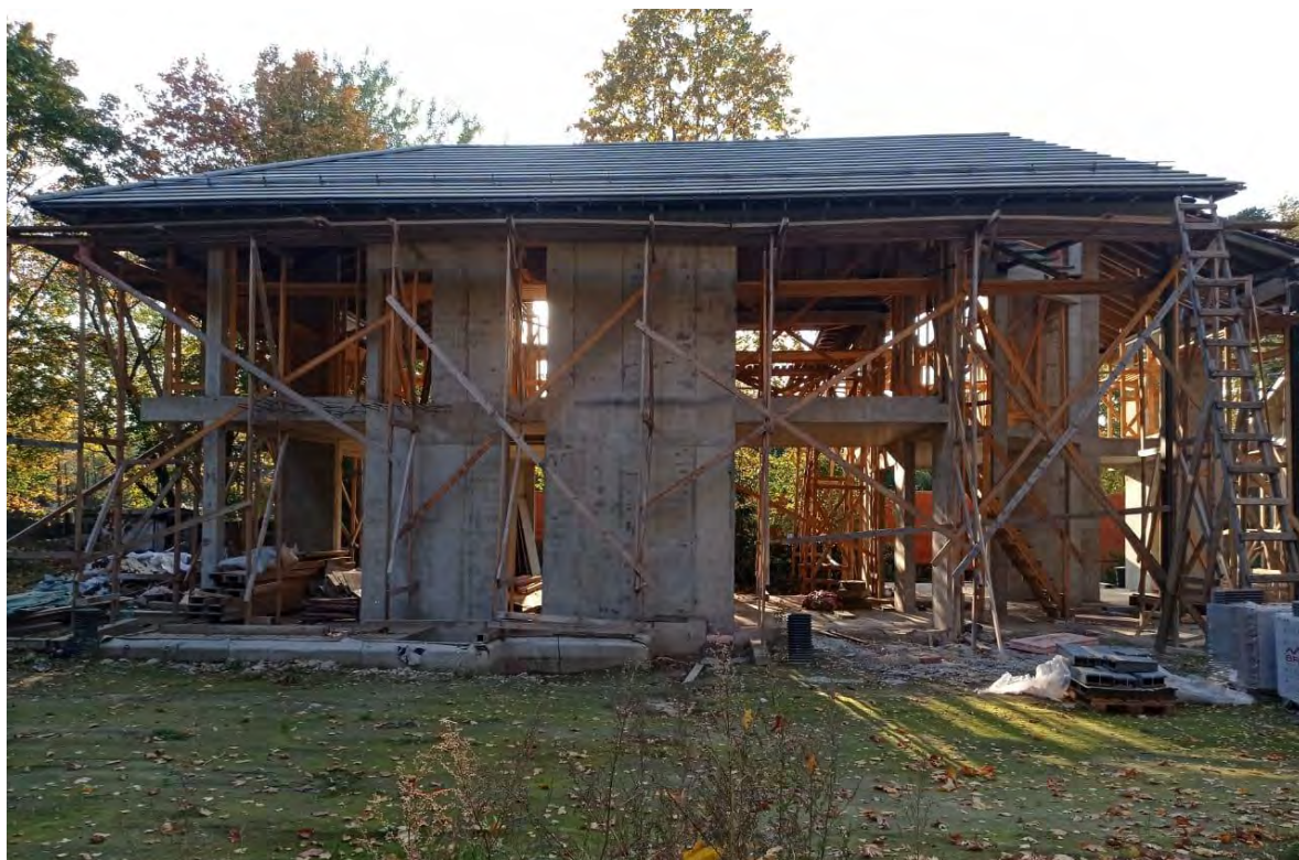
45. ОКН РЗ «Дача Гербель» по адресу: г. Санкт-Петербург, ул. Межозёрная, дом 4, литера А. Вид на восточный фасад от Межозерной улицы. Дата съёмки: 24.09.2020 г.
