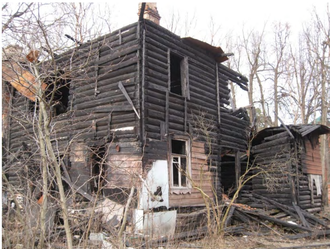
5. ОКН РЗ «Дача Гербель» по адресу: г.Санкт-Петербург, ул. Межозёрная, дом 4, литера А. Западный и южный фасады. Дата съёмки: 06.04.2016 г.
