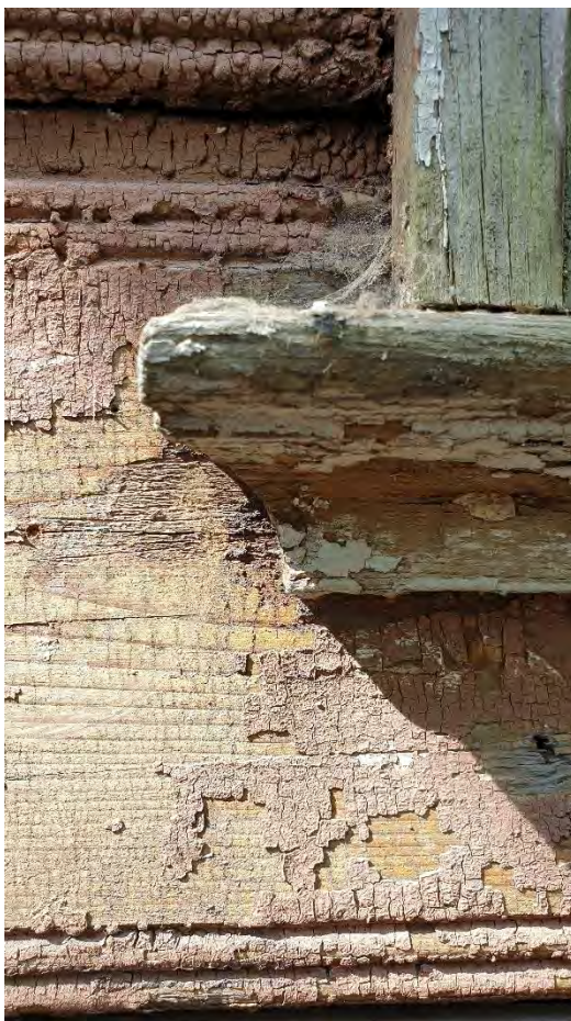
35. ОКН РЗ «Дача Гербель» по адресу: г. Санкт-Петербург, ул. Межозёрная, дом 4, литера А. Фрагмент подоконника. Дата съёмки: 19.06.2019 г.
