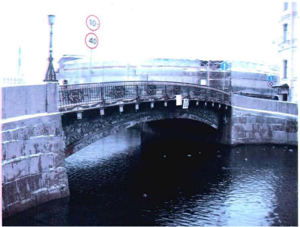
7. Вид моста со стороны низового фасада
