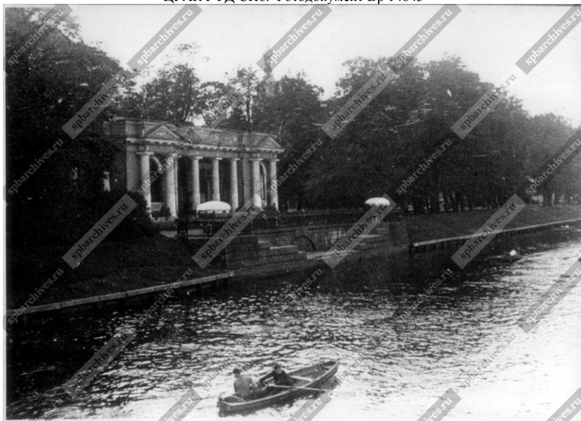
13. Вид на садовый павильон с пристанью ("павильон Росси", 1825 г., архитектор К.И.Росси) на набережной реки Мойки в саду МОПРа (Международной организации помощи борцам революции). Август-сентябрь 1934 г. ЦГАКФФД СПб. Фотодокумент Ар 39595
