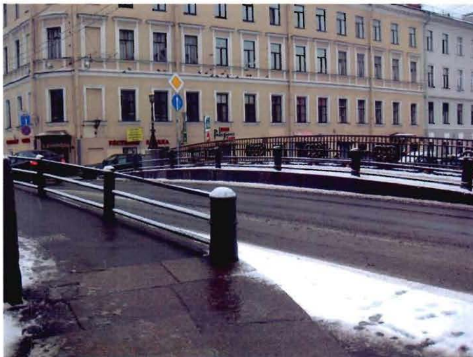
1. Вид на поверхность моста и силовое ограждение
