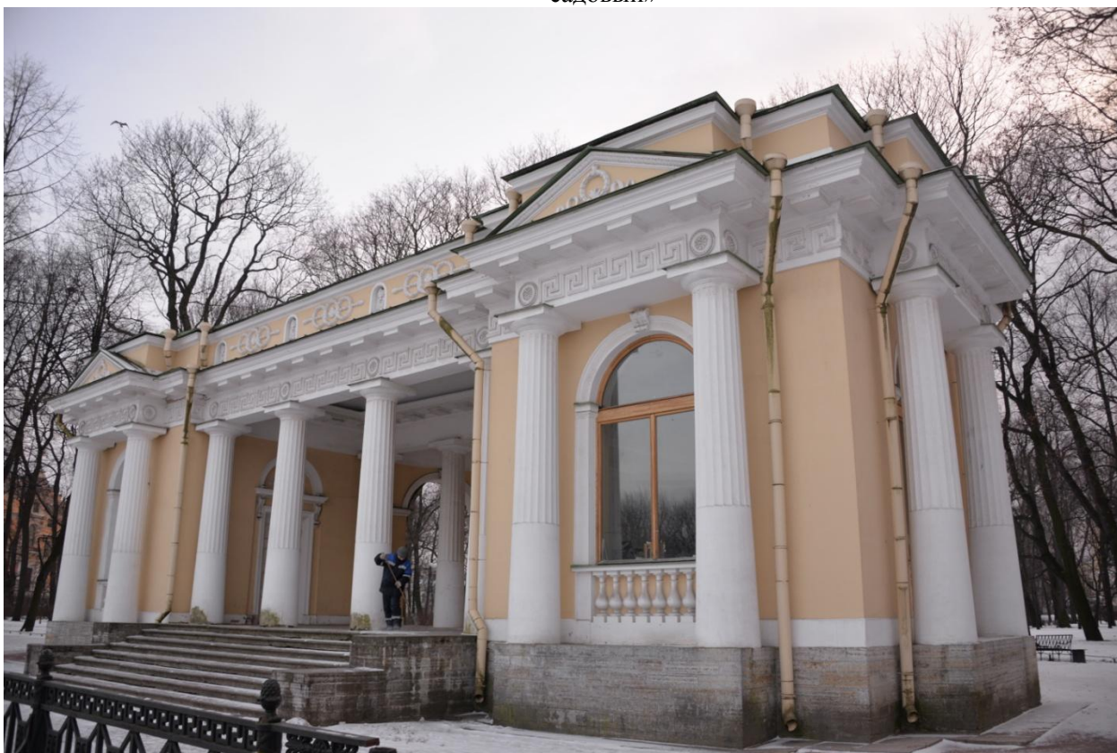
12. Южный фасад объекта культурного наследия федерального значения «Павильон садовый»
