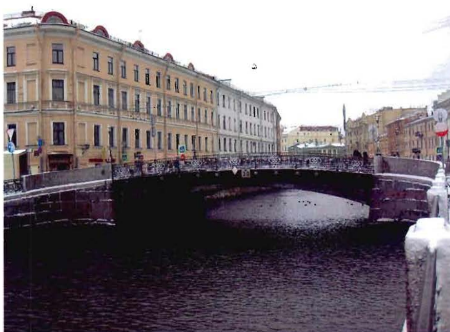
2. Вид моста со стороны верхового фасада
