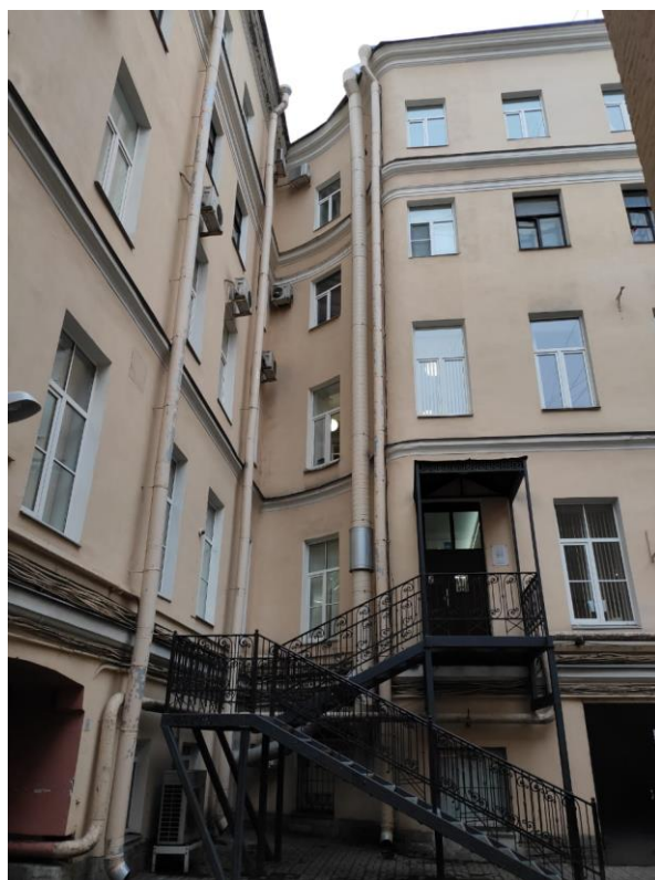
Фото №6. Фрагмент дворовых фасадов. Арочный проезд.
