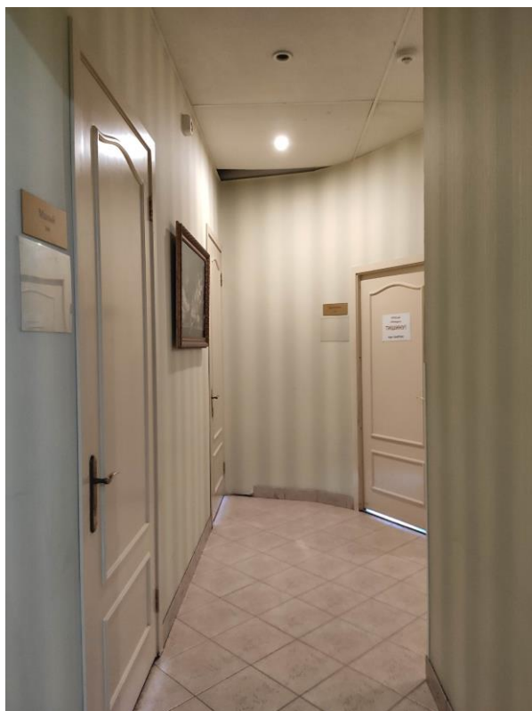
Фото №25. Помещение коридора кв. 51
