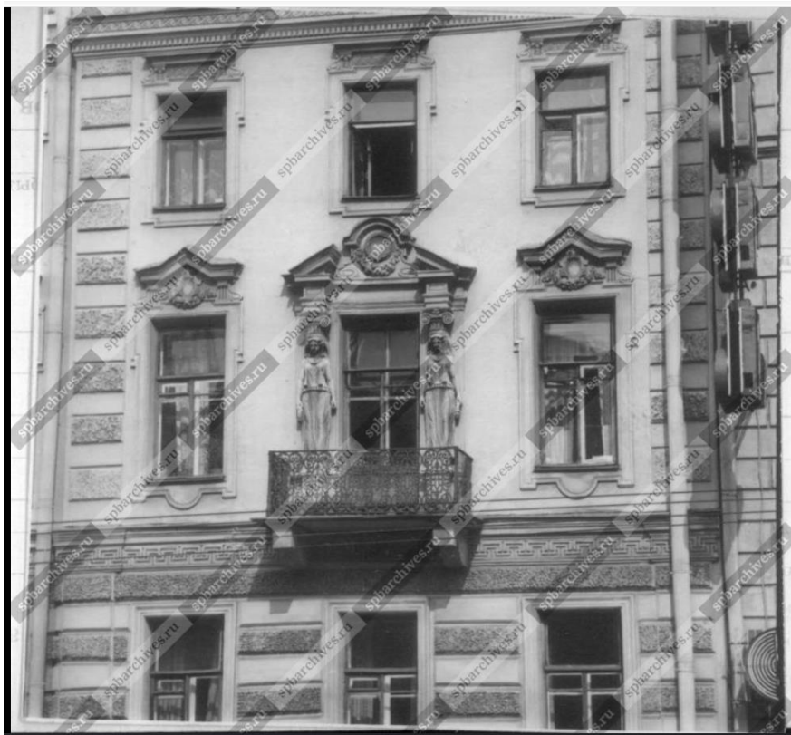
Илл. 31. Вид части фасада дома №78 на Невском проспекте. ЦГАКФФД СПб. Фотодокумент. Бр 45726. 1983 г.
