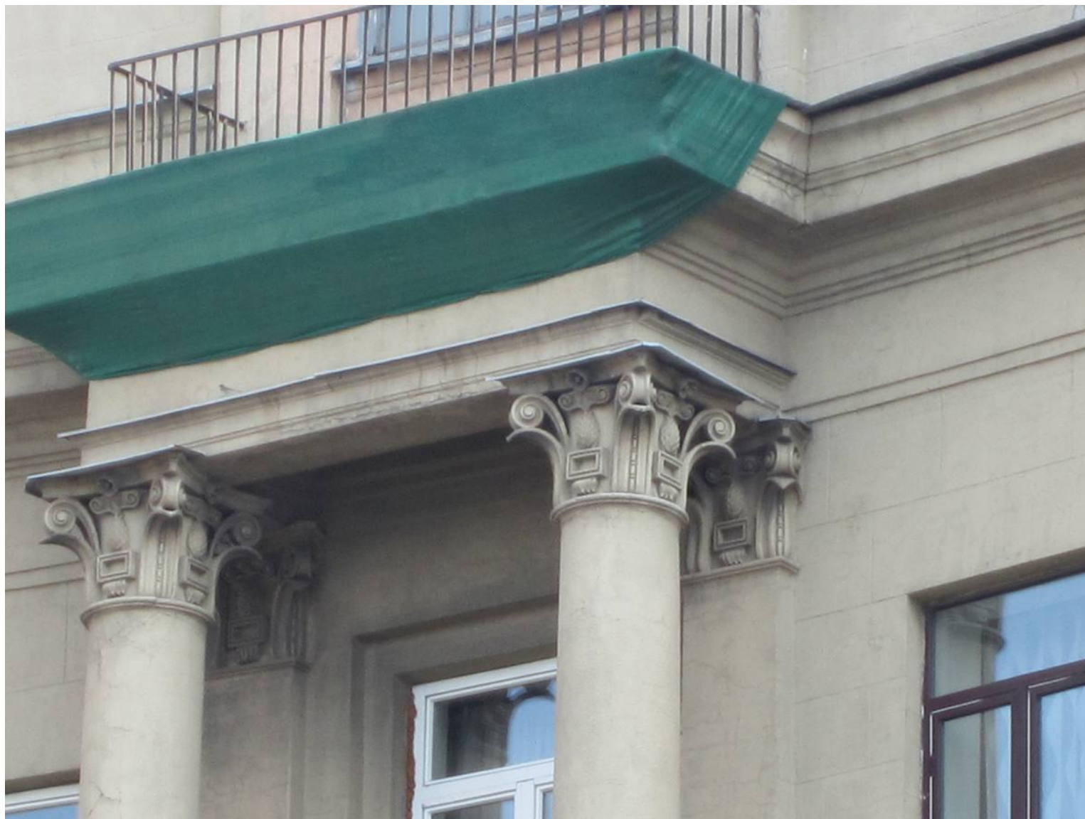
8. Объект культурного наследия регионального значения «Комплекс жилых домов (6 зданий)», расположенный по адресу: Санкт-Петербург, Красногвардейский район, Малоохтинский пр., 86, лит. А Фрагмент лицевого фасада. Межэтажный карниз, колонны и пилястры дорического ордера Съемка: 14 декабря 2020 г.
