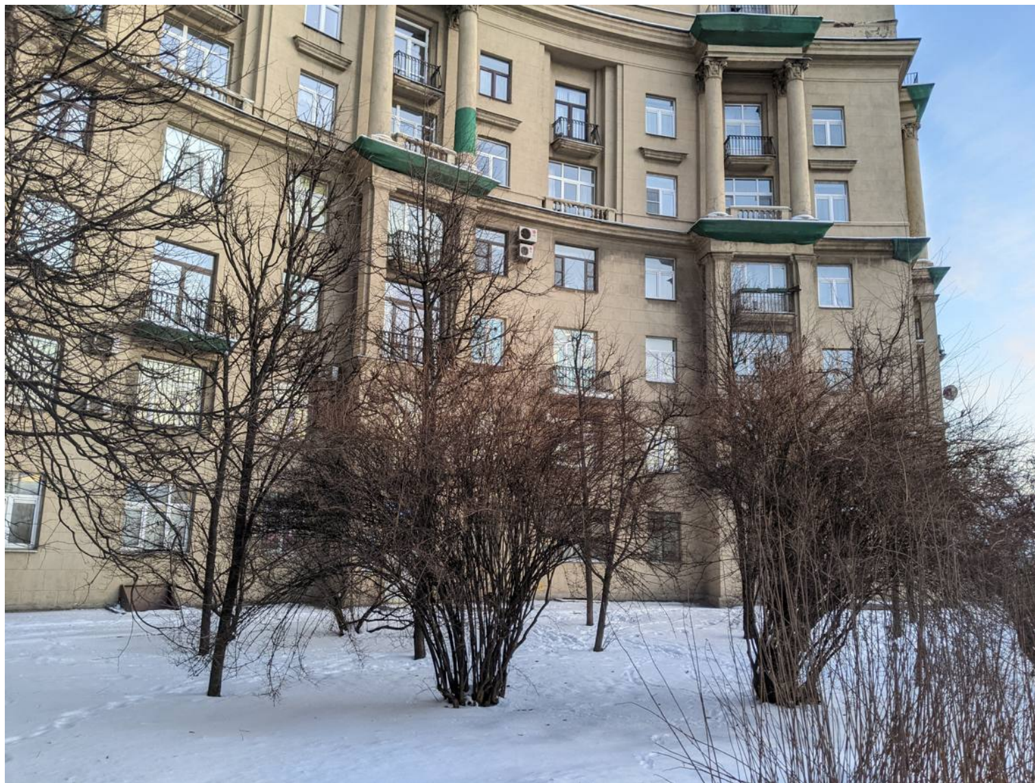
4. Объект культурного наследия регионального значения «Комплекс жилых домов (6 зданий)», расположенный по адресу: Санкт-Петербург, Красногвардейский район, Малоохтинский пр., 86, лит. А Фрагмент облицовки цоколя, заполнение оконных проемов в уровне 1-го этажа Съемка: 14 декабря 2020 г.
