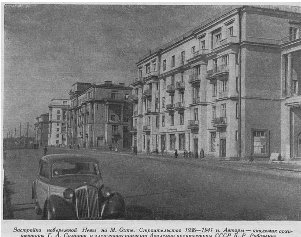
11. Застройка набережной Невы на Малой Охте. 1947 – 1948 гг. Источник: Баранов Н.В. "Архитектура и строительство Ленинграда", Л., 1948 г.
