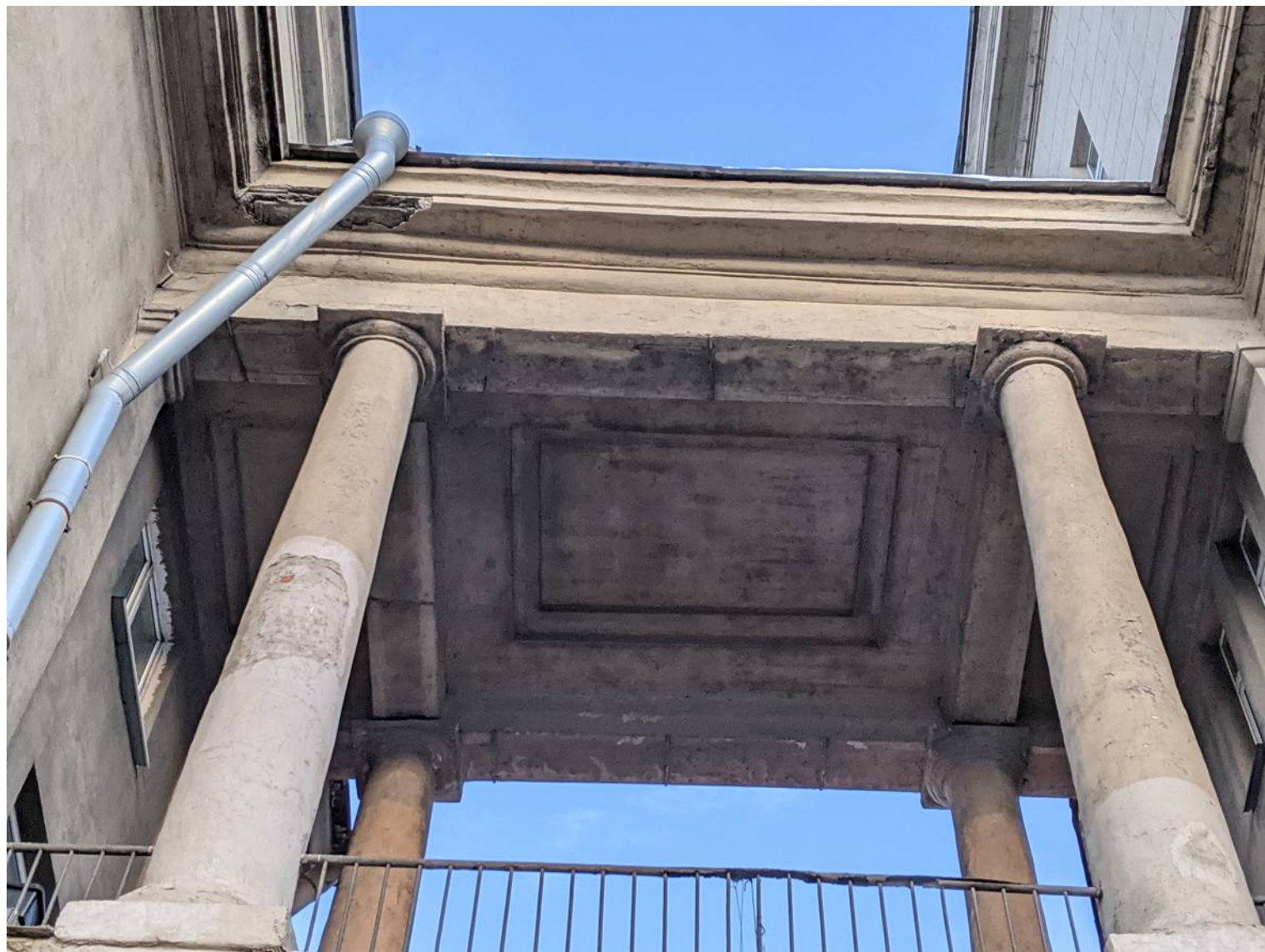
18. Объект культурного наследия регионального значения «Комплекс жилых домов (6 зданий)», расположенный по адресу: Санкт-Петербург, Красногвардейский район, Малоохтинский пр., 86, лит. А Профилированный венчающий карниз северной пристройки, стилизованные колонны Съемка: 14 декабря 2020 г.
