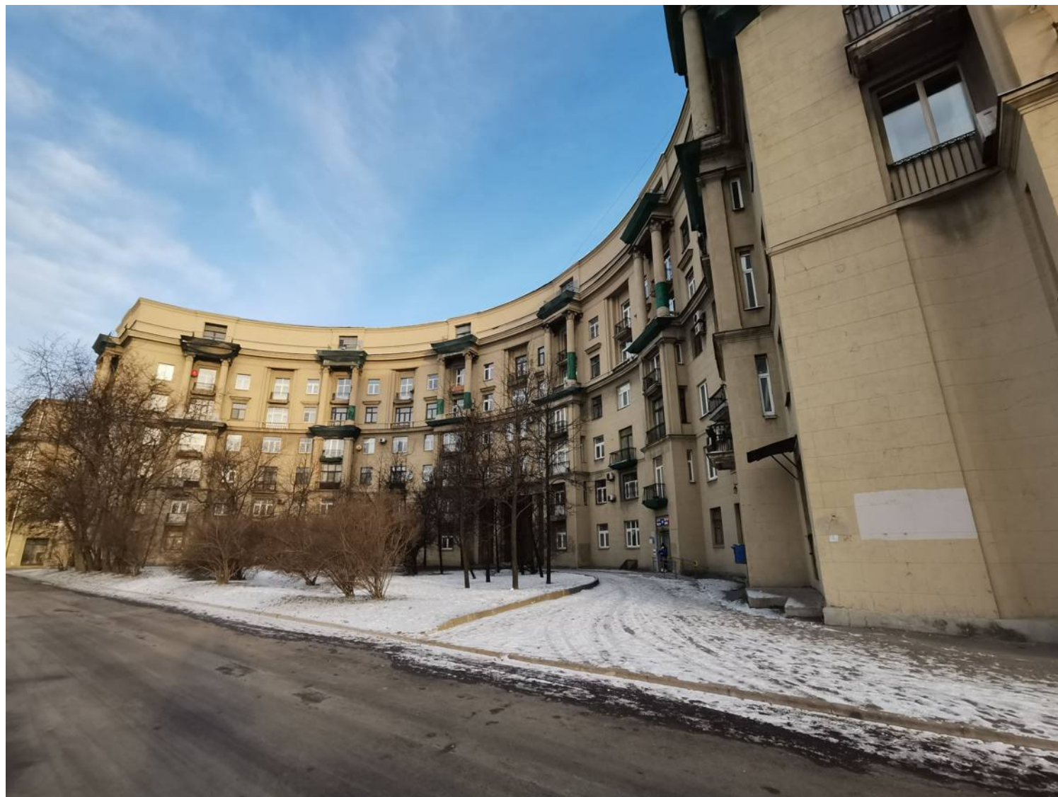
2. Объект культурного наследия регионального значения «Комплекс жилых домов (6 зданий)», расположенный по адресу: Санкт-Петербург, Красногвардейский район, Малоохтинский пр., 86, лит. А Вид лицевого фасада с Малоохтинского проспекта. Эркеры на высоту 1-2 этажей, завершенные 2-х ярусными порталами (с пилонами на уровне 3-4 этажей и колоннами на уровне 5-6 этажей) Съемка: 14 декабря 2020 г. .
