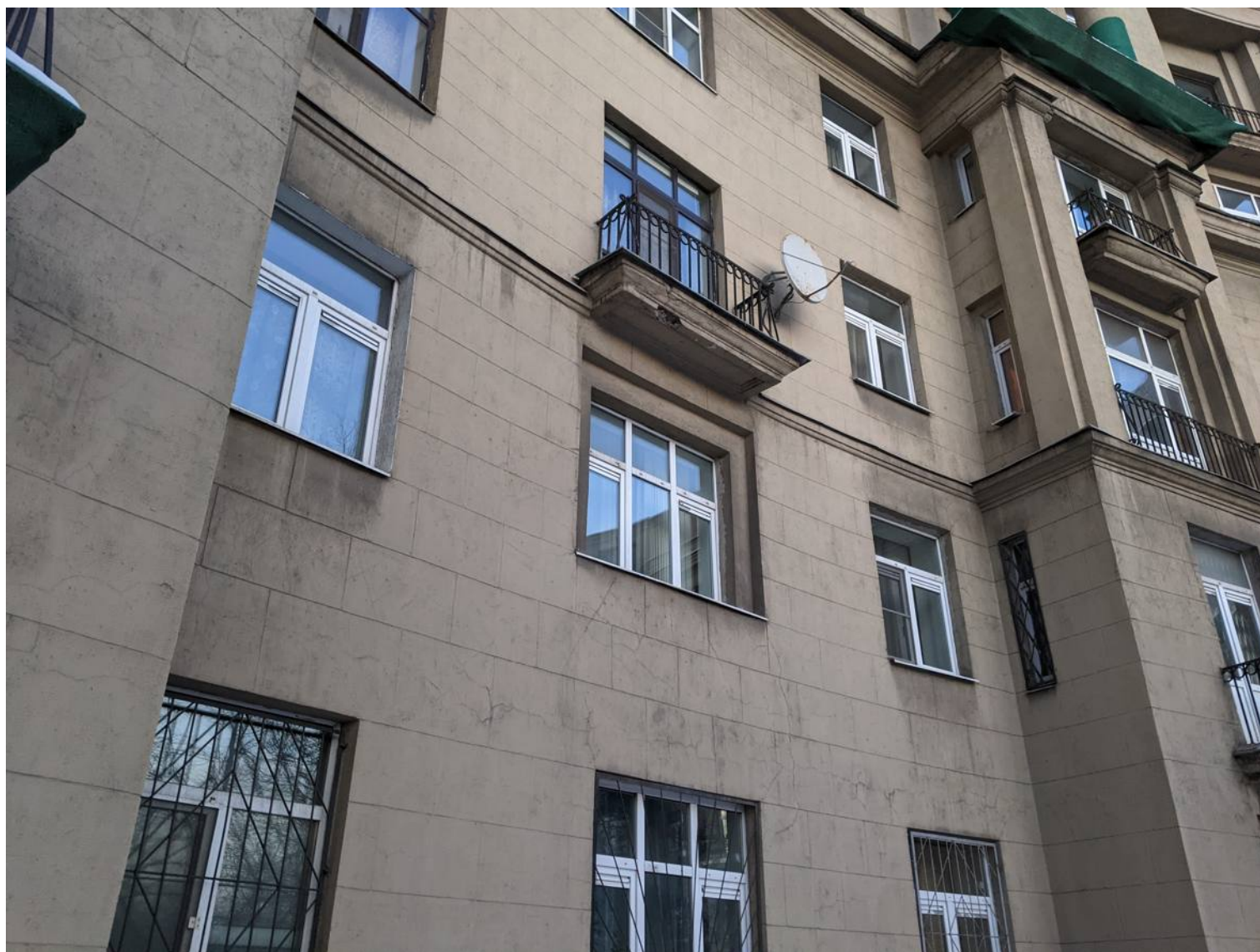
5. Объект культурного наследия регионального значения «Комплекс жилых домов (6 зданий)», расположенный по адресу: Санкт-Петербург, Красногвардейский район, Малоохтинский пр., 86, лит. А Фрагмент лицевого фасада, один из восьми экранов на высоту 1-2 этажей Съемка: 14 декабря 2020 г.
