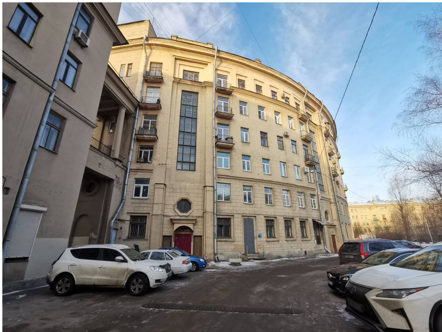
15. Объект культурного наследия регионального значения «Комплекс жилых домов (6 зданий)», расположенный по адресу: Санкт-Петербург, Красногвардейский район, Малоохтинский пр., 86, лит. А Фрагмент дворового фасада. Южная пристройка к основному объему здания Съемка: 14 декабря 2020 г.
