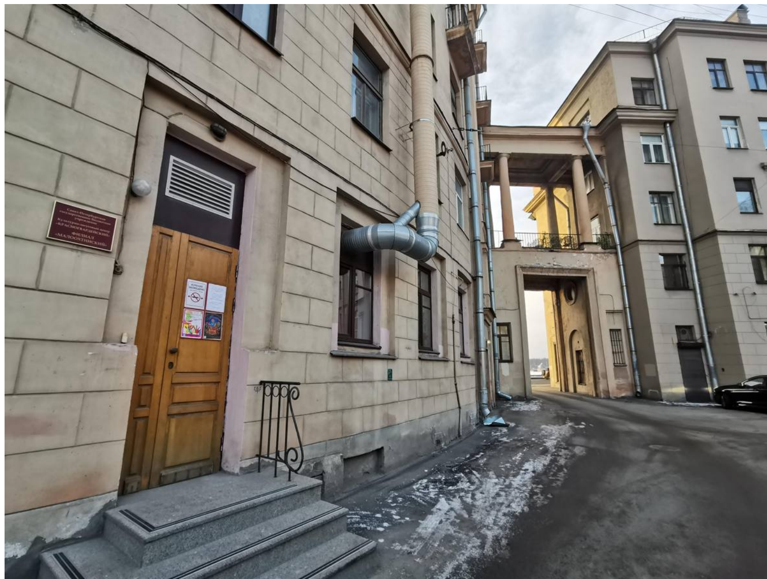
13. Объект культурного наследия регионального значения «Комплекс жилых домов (6 зданий)», расположенный по адресу: Санкт-Петербург, Красногвардейский район, Малоохтинский пр., 86, лит. А. Фрагмент дворового фасада. Облицовка цоколя, заполнение оконных проемов в уровне 1-го этажа Съемка: 14 декабря 2020 г.
