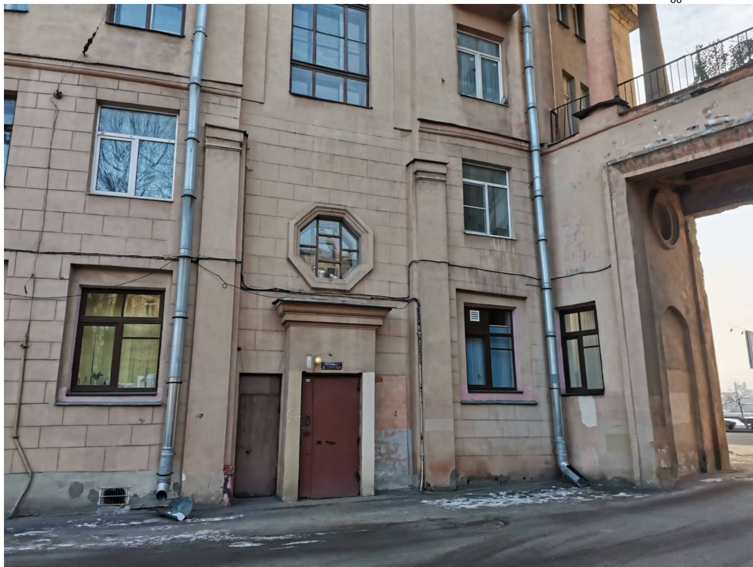
12. Объект культурного наследия регионального значения «Комплекс жилых домов (6 зданий)», расположенный по адресу: Санкт-Петербург, Красногвардейский район, Малоохтинский пр., 86, лит. А Фрагмент дворового фасада. Профилированный наличник восьмигранного окна, прямой сандрик над дверным проемом Съемка: 14 декабря 2020 г.
