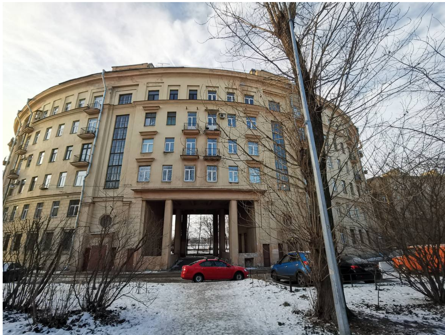
14. Объект культурного наследия регионального значения «Комплекс жилых домов (6 зданий)», расположенный по адресу: Санкт-Петербург, Красногвардейский район, Малоохтинский пр., 86, лит. А Центральный воротный проезд на пилонах с плоским кессонированным перекрытием Съемка: 14 декабря 2020 г.
