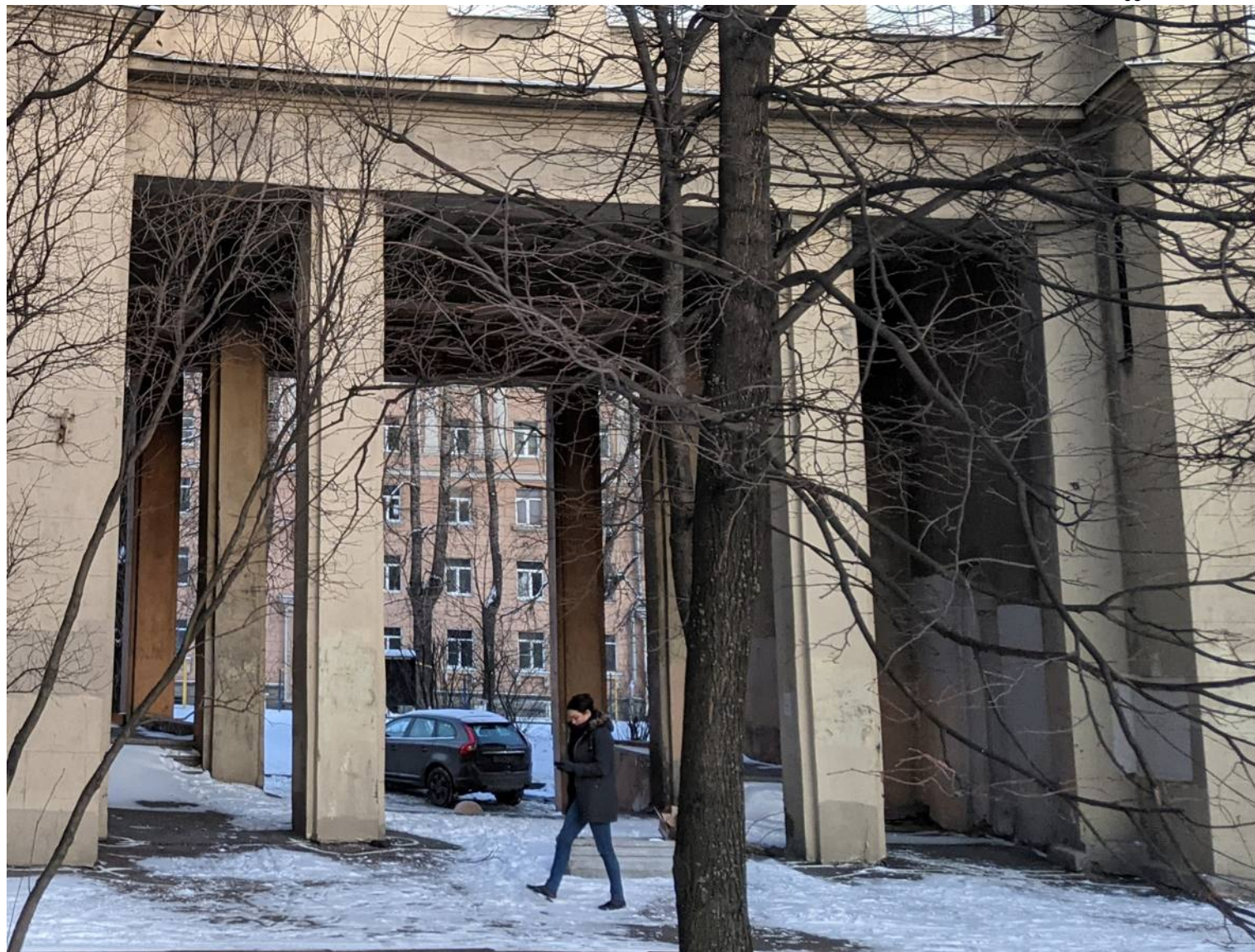
20. Объект культурного наследия регионального значения «Комплекс жилых домов (6 зданий)», расположенный по адресу: Санкт-Петербург, Красногвардейский район, Малоохтинский пр., 86, лит. А Вид воротного проезда на пилонах с юга Съемка: 14 декабря 2020 г.
