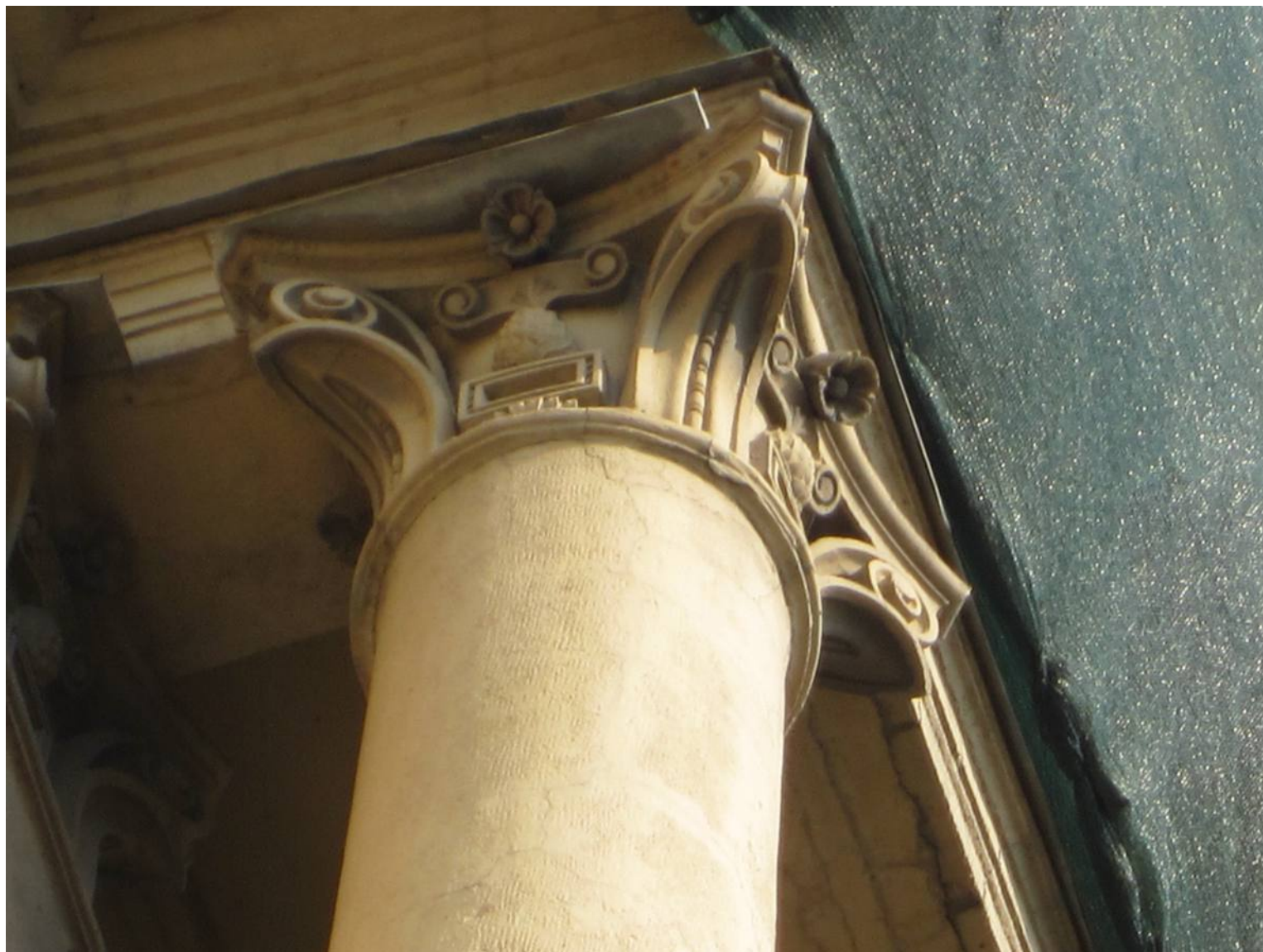
9. Объект культурного наследия регионального значения «Комплекс жилых домов (6 зданий)», расположенный по адресу: Санкт-Петербург, Красногвардейский район, Малоохтинский пр., 86, лит. А Фрагмент фасада. Стилизованная дорическая колонна в эркере на уровне 6 этажа Съемка: 14 декабря 2020 г.
