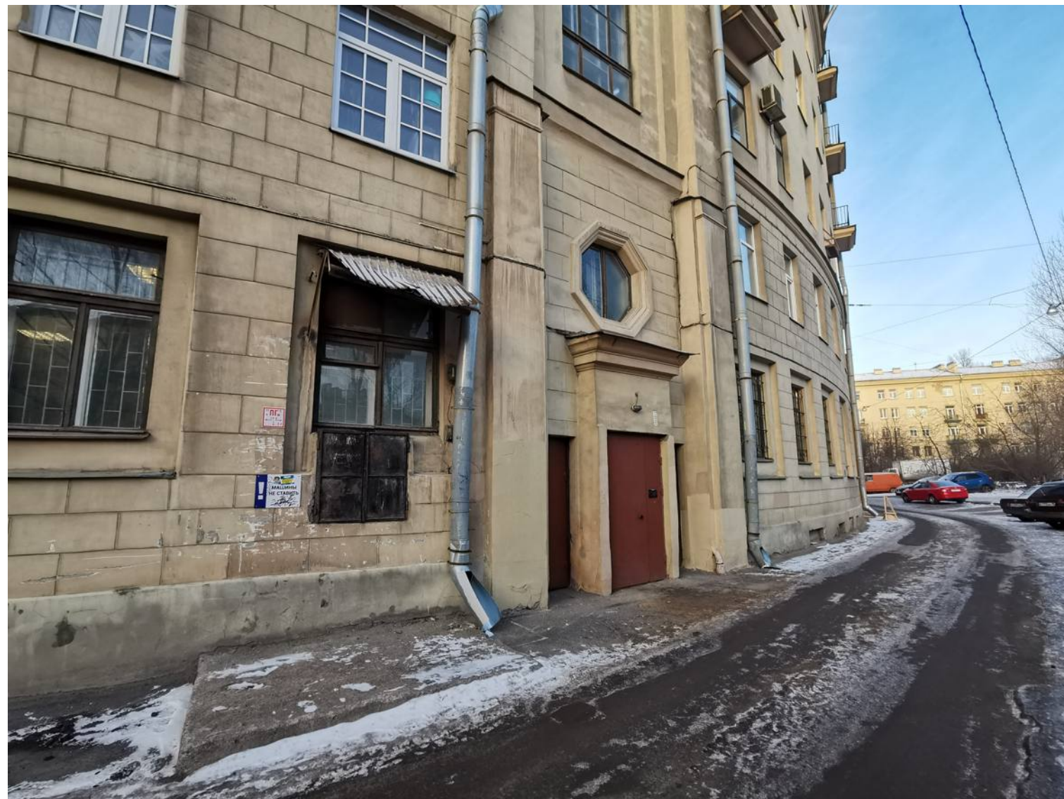
16. Объект культурного наследия регионального значения «Комплекс жилых домов (6 зданий)», расположенный по адресу: Санкт-Петербург, Красногвардейский район, Малоохтинский пр., 86, лит. А Фрагмент рассматриваемого объекта. Заполнение оконных проемов в уровне 1-го этажа. Профилированный наличник восьмигранного окна Съемка: 14 декабря 2020 г.
