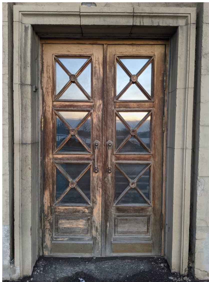
7. Объект культурного наследия регионального значения «Комплекс жилых домов (6 зданий)», расположенный по адресу: Санкт-Петербург, Красногвардейский район, м Фрагмент лицевого фасада. Оформление дверного проема Съемка: 14 декабря 2020 г.
