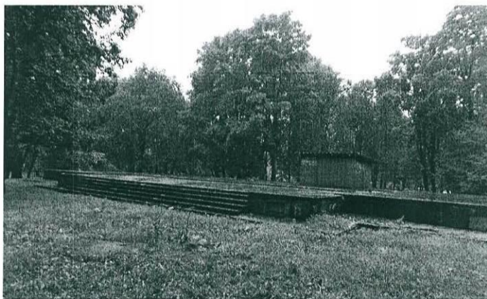
Фундамент Екатерингофского дворца (фрагмент, западная часть парка).
