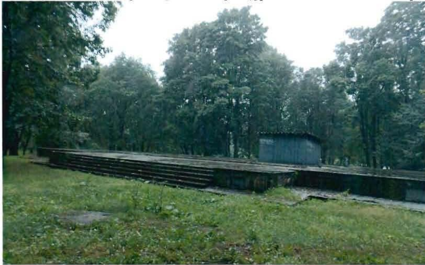
18. Фундамент Екатерингофского дворца (фрагмент, западная часть парка).
