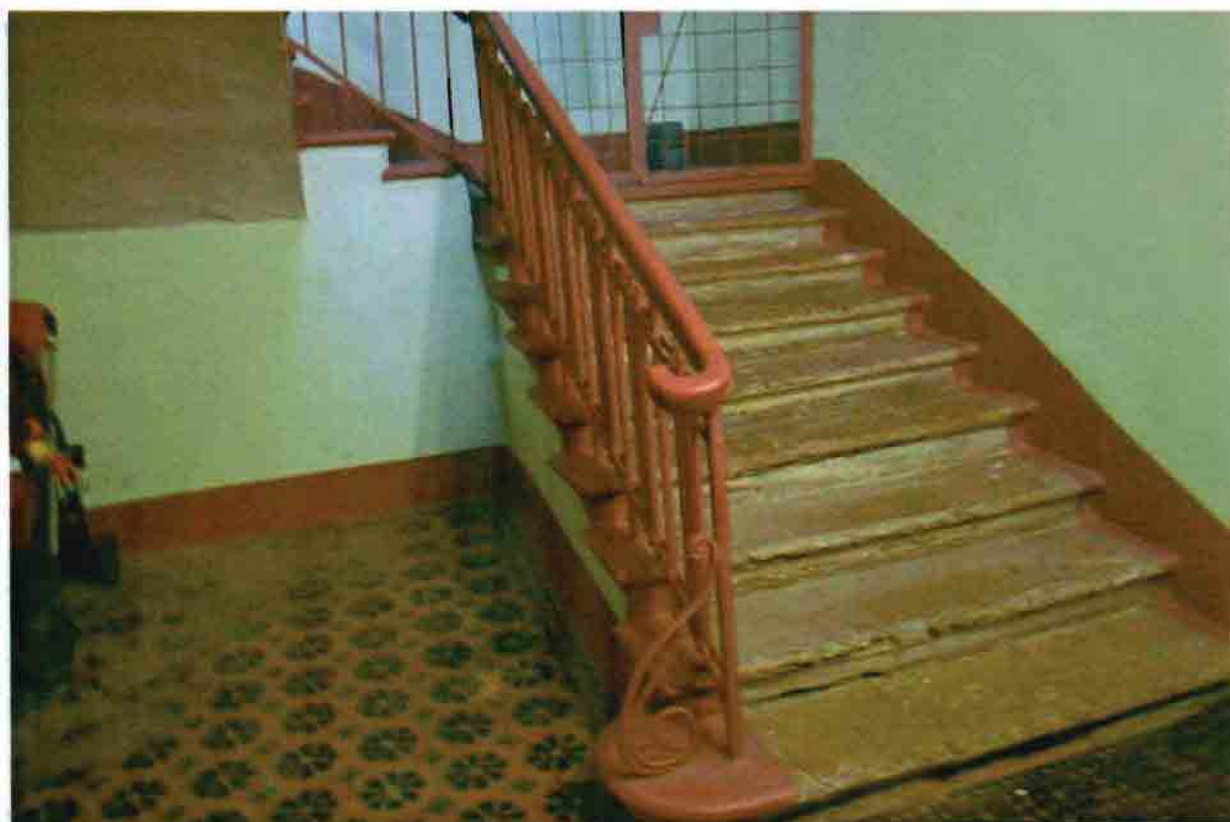
Фото 8. Лестница в третьем подьезде.
