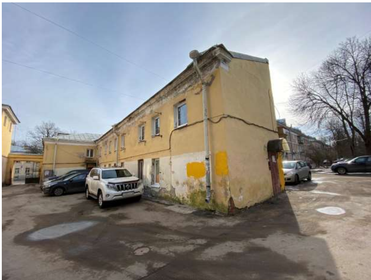
Фото 11. Общий вид западного и северного дворовых фасадов флигеля. Вид с северо-запада.
