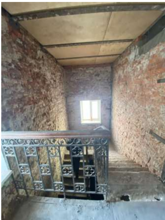
Фото 21. Общий вид лестницы в уровне 2-го этажа. Вид с юга.
