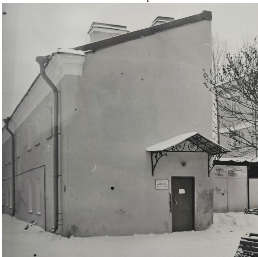
Илл. 17. Флигель жилого дома. Западный фасад. 1989 г. // Архив КГИОП. П. 215. Пр-1. Часть 2
