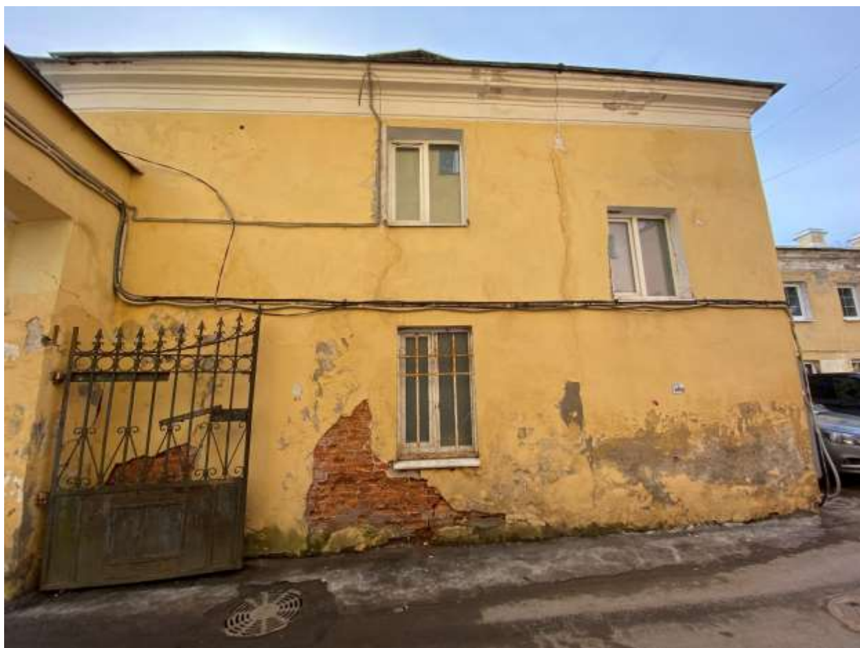
Фото 16. Фрагмент северного дворового фасада флигеля. Сворка воротного заполнения. Вид с севера.
