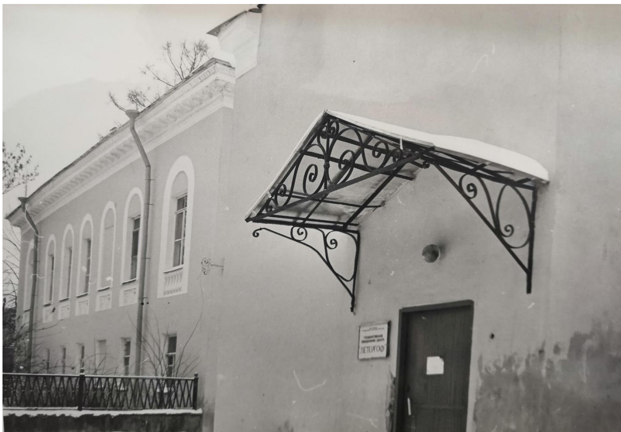
Илл. 18. Флигель жилого дома. Фрагмент западного фасада. Козырек над «черным» входом. 1989 г. // Архив КГИОП. П. 215. Пр-1. Часть 2
