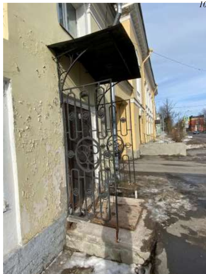
Фото 7. Общий вид позднего кованного металлического ограждения крыльца восточного лицевого фасада. Вид с юго-востока.
