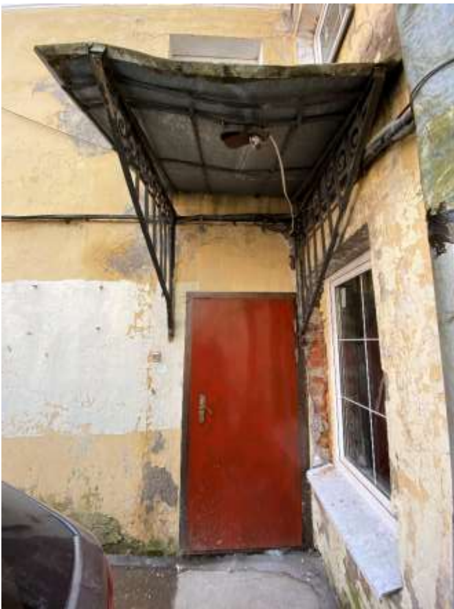
Фото 17. Современное дверное заполнение и кованый металлический козырек западного дворового фасада флигеля. Вид с запада.
