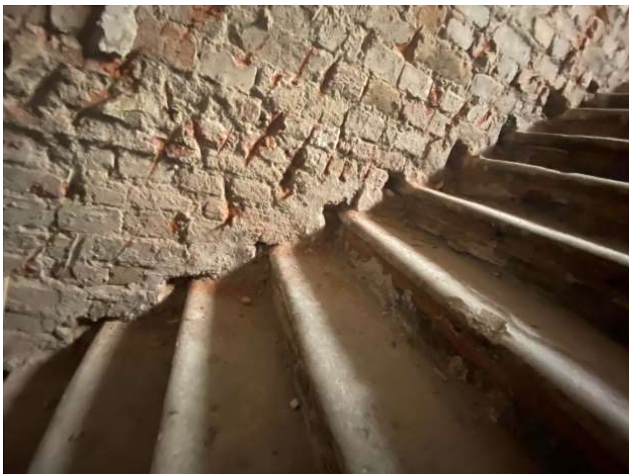
Фото 23. Отверстия в кирпичной кладке, свидетельствующие об изменении первоначального местоположения лестницы. Вид с востока.
