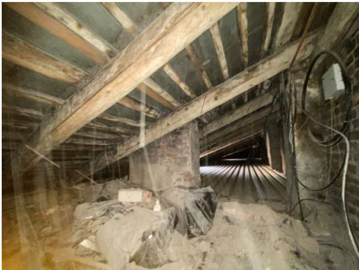
Фото 26. Общий вид чердачного пространства. Вид с запада.
