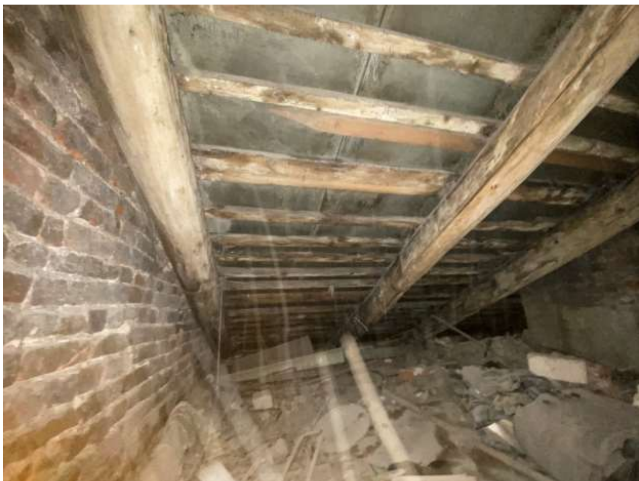
Фото 27. Чердачное пространство. Состояние стропильной системы здания. Вид с запада.
