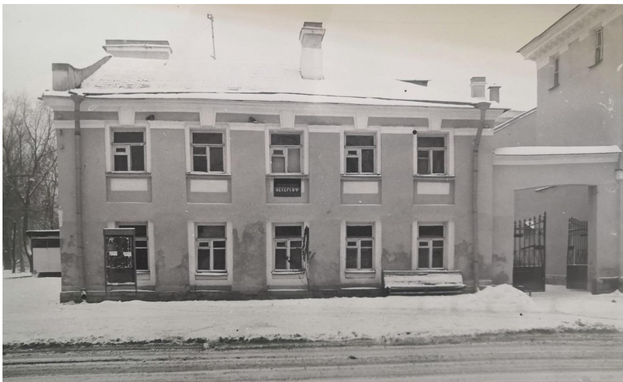
Илл. 12. Флигель жилого дома. Восточный фасад. 1989 г. // Архив КГИОП. П. 215. Пр-1. Часть 2
