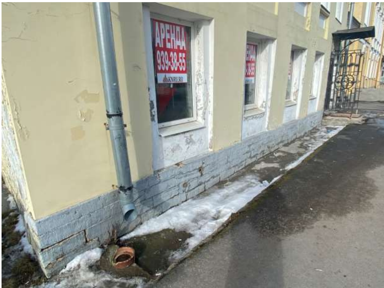
Фото 3. Бетонная отмостка со стороны восточного фасада флигеля.
