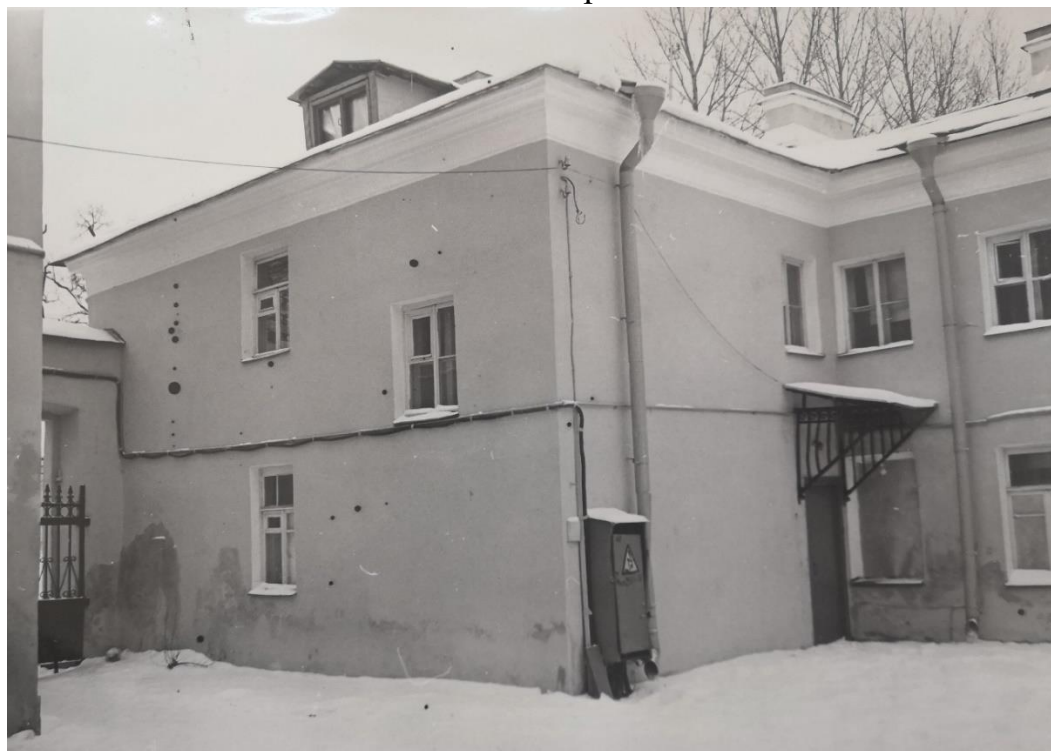
Илл. 15. Флигель жилого дома. Часть северного фасада. Вид со двора. 1989 г. // Архив КГИОП. П. 215. Пр-1. Часть 2
