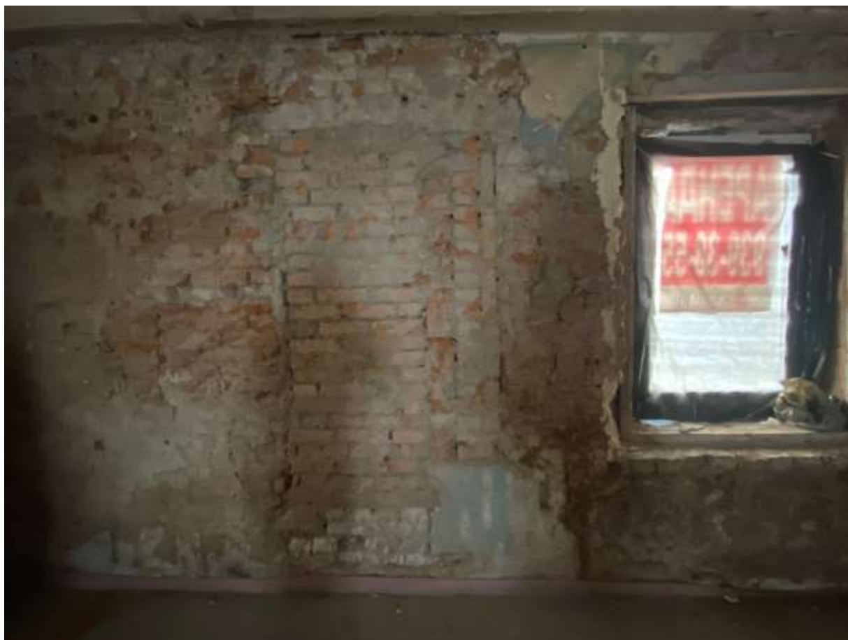
Фото 25. Общий вид ранее существовавшего заложеного проема в кирпичной капитальной стене южного дворового фасада флигеля со стороны внутренних помещений. Вид с востока.
