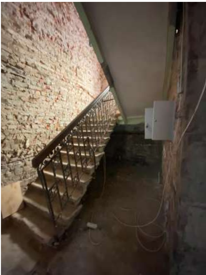
Фото 19. Общий вид лестницы в уровне 1-го этажа. Вид с юго-востока.
