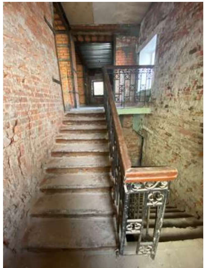
Фото 20. Общий вид лестницы в уровне 2-го этажа. Вид с севера.
