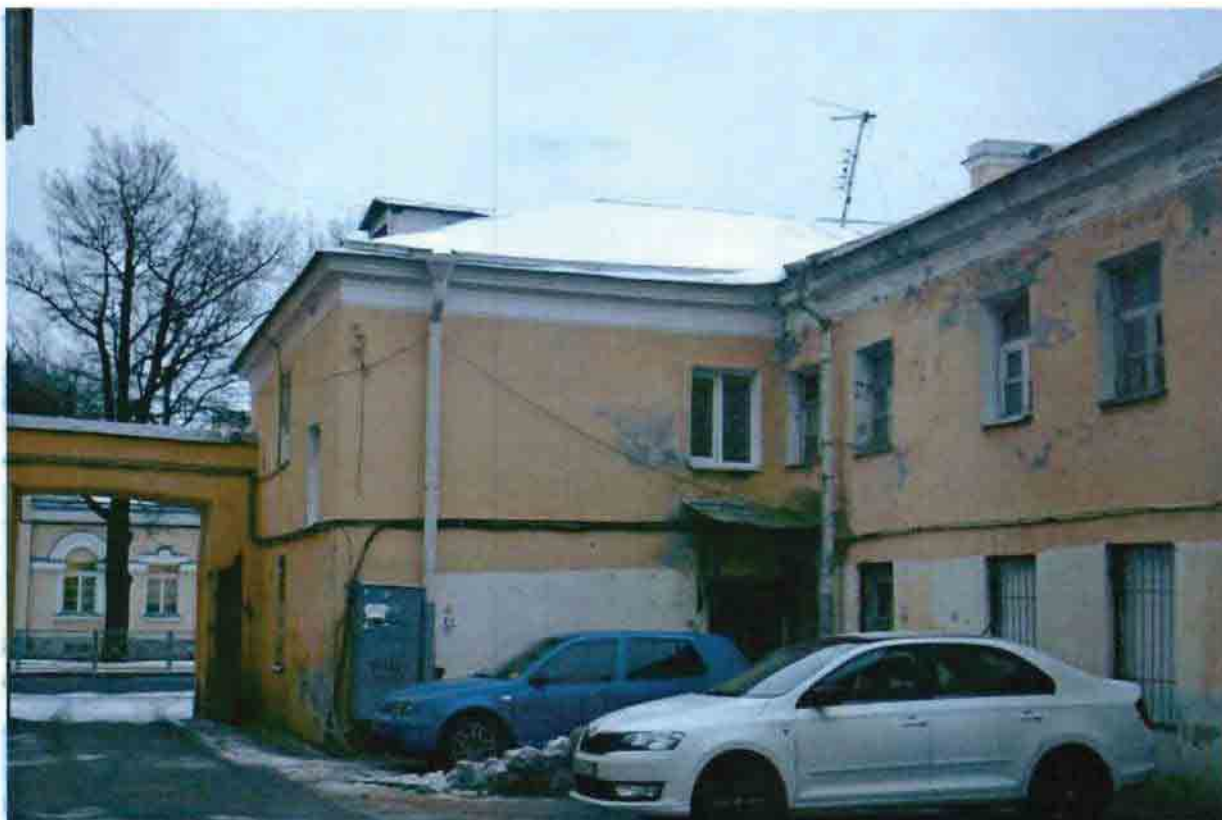
Фото 13. Часть дворового фасада.
