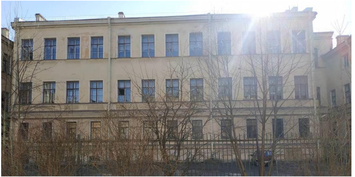
11. Здание Петровского коммерческого училища Санкт-Петербургского купеческого общества (с флигелями, сквером, металлической оградой). Северо-восточный фасад. Штиглиц М.С. 30.11.2020.
