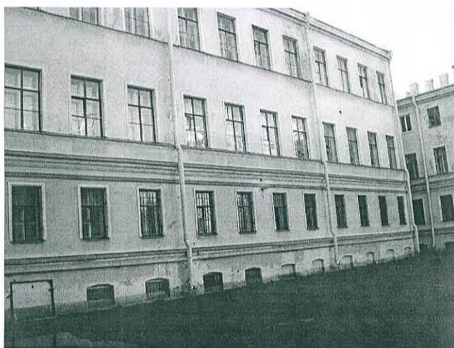
23. Фасад дворового корпуса.
