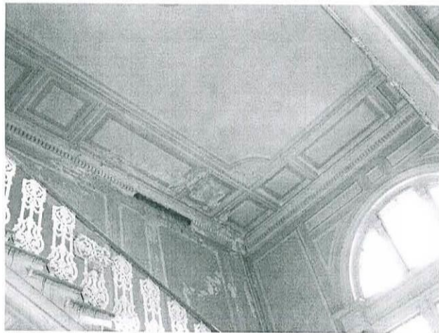
6. Потолок парадной лестницы.
