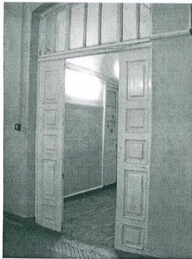
14. Перегородка с дверным заполнением между коридорами.
