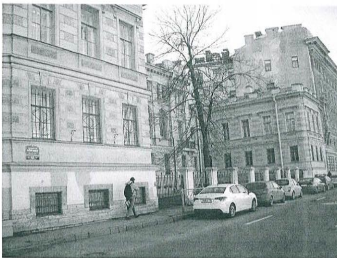
1. Лицевой фасад, вдоль реки Фонтанки.
