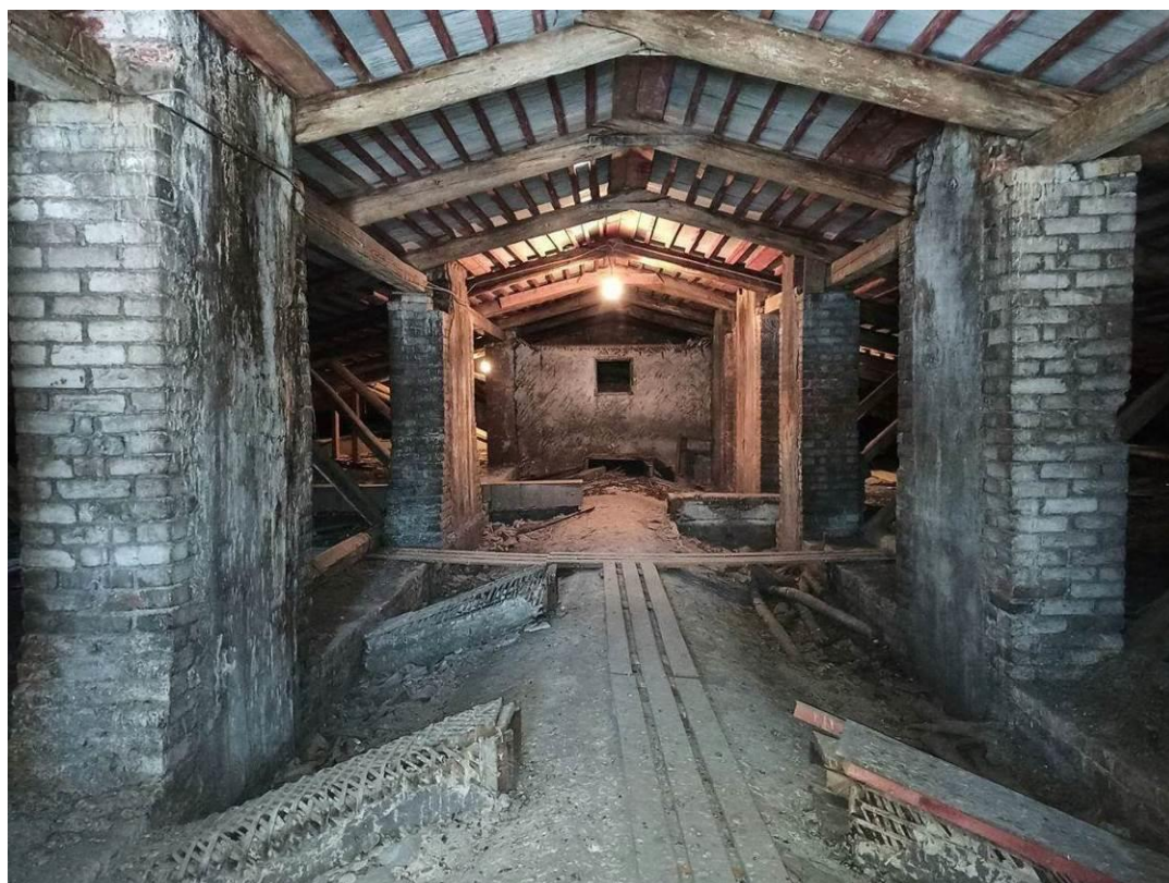
48. Здание Петровского коммерческого училища Санкт-Петербургского купеческого общества (с флигелями, сквером, металлической оградой). Чердак. Штиглиц М.С. 30.11.2020.
