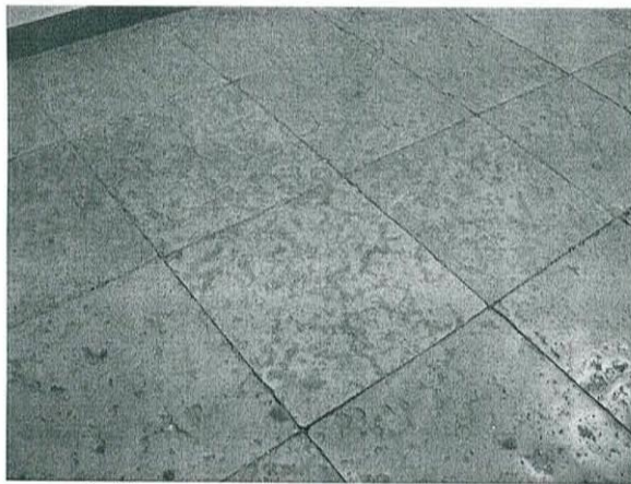
8. Полы галереи, лещадная плита.
