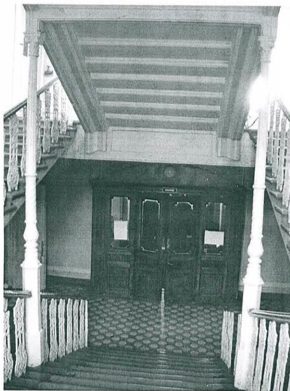
4. Парадная лестница. Площадка 1-го этажа.
