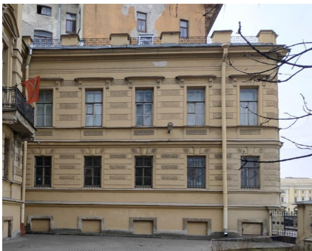
4. Здание Петровского коммерческого училища Санкт-Петербургского купеческого общества (с флигелями, сквером, металлической оградой). Северо-восточный фасад. Штиглиц М.С. 30.11.2020.
