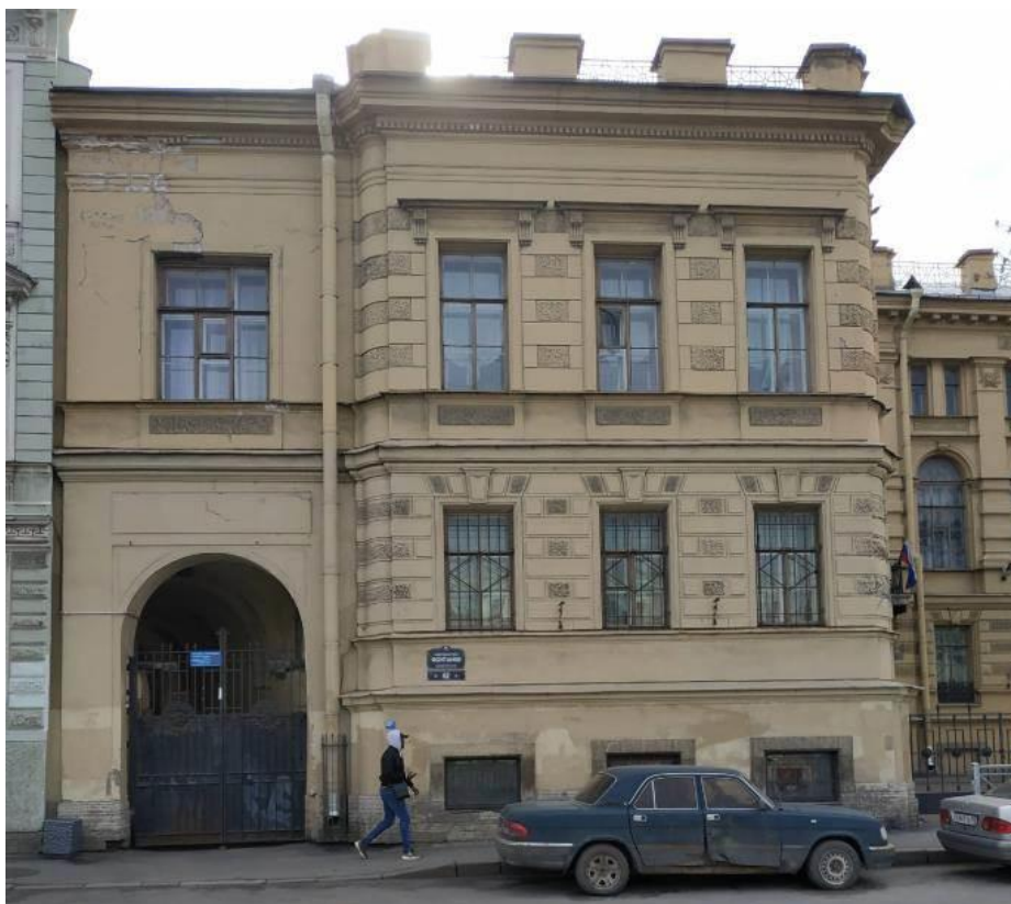
1. Здание Петровского коммерческого училища Санкт-Петербургского купеческого общества (с флигелями, сквером, металлической оградой). Северо-западный фасад. Штиглиц М.С. 30.11.2020.
