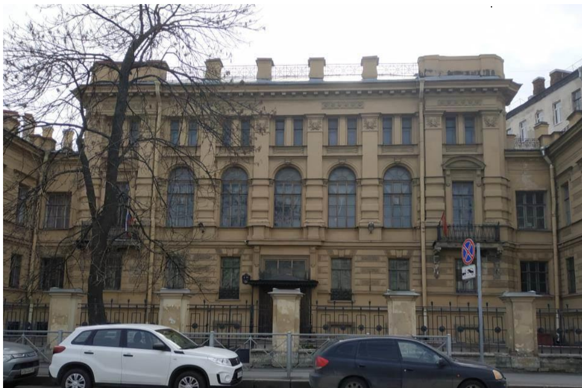
3. Здание Петровского коммерческого училища Санкт-Петербургского купеческого общества (с флигелями, сквером, металлической оградой). Северо-западный фасад. Штиглиц М.С. 30.11.2020.
