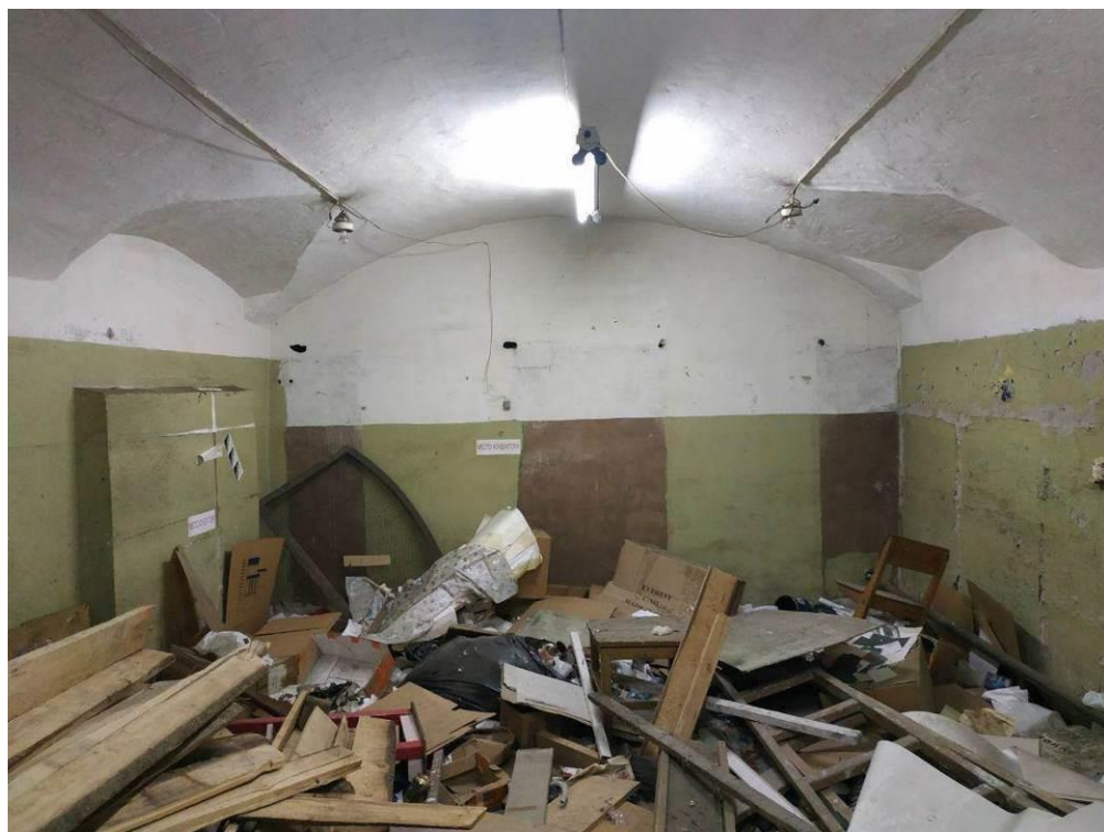
13. Здание Петровского коммерческого училища Санкт-Петербургского купеческого общества (с флигелями, сквером, металлической оградой). Подвал. Штиглиц М.С. 30.11.2020.
