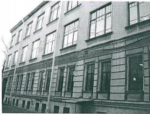
24. Фасад дворового корпуса.
