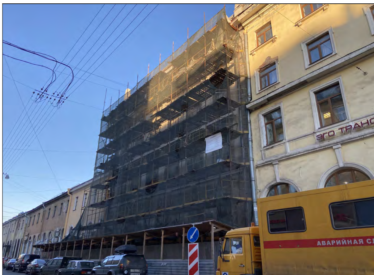
2. Объект культурного наследия «Большой железный ряд или Кожевенная линия». Средний корпус. Лицевой фасад по Мучному переулку. Вид на север от дома № 5 по Мучному переулку. 11.11.2020 г.
