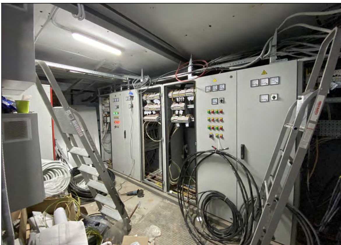
13. Объект культурного наследия «Большой железный ряд или Кожевенная линия». Средний корпус. Подвал, помещение № 22. 11.11.2020 г.
