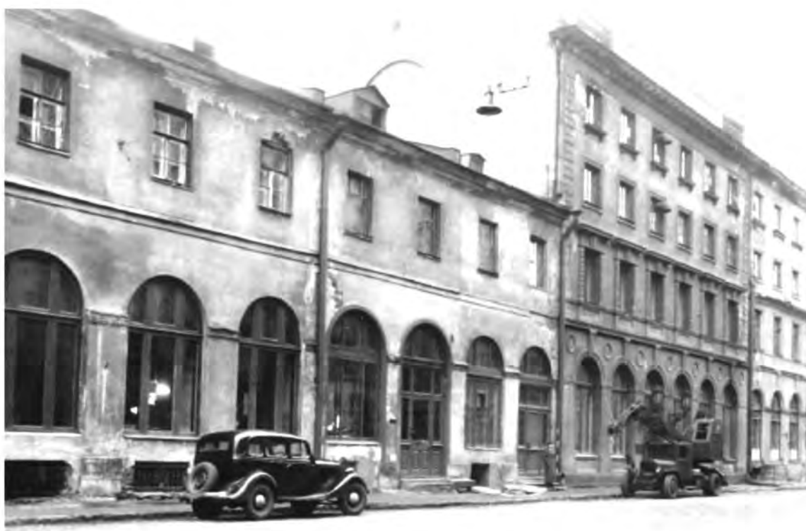
Илл. 20. Мучной переулок. Фасад дома № 2. 1949 г. ЦГА КФФД СПб. Гр 72062.
