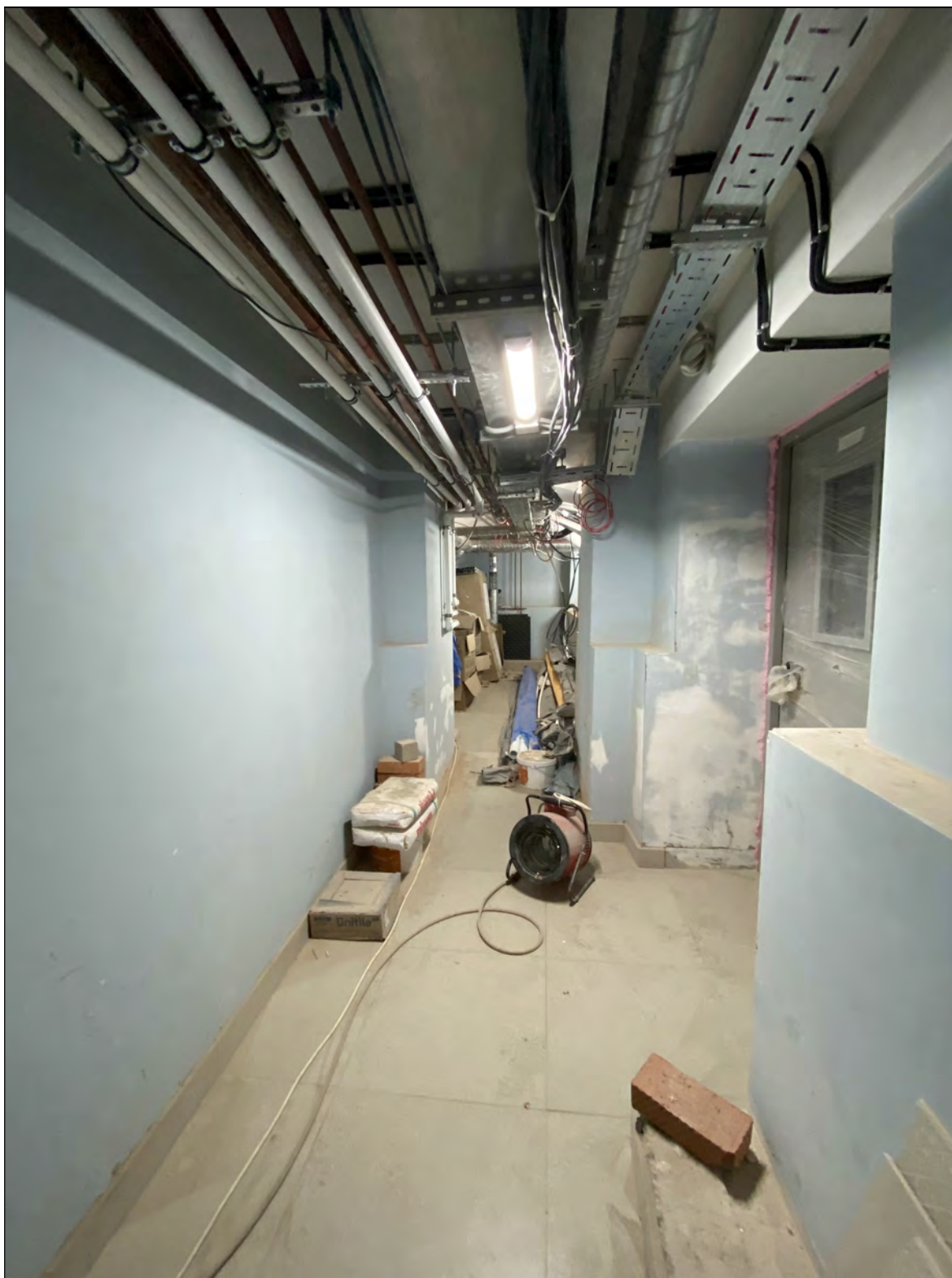
10. Объект культурного наследия «Большой железный ряд или Кожевенная линия». Средний корпус. Подвал, помещение № 25. 11.11.2020 г.
