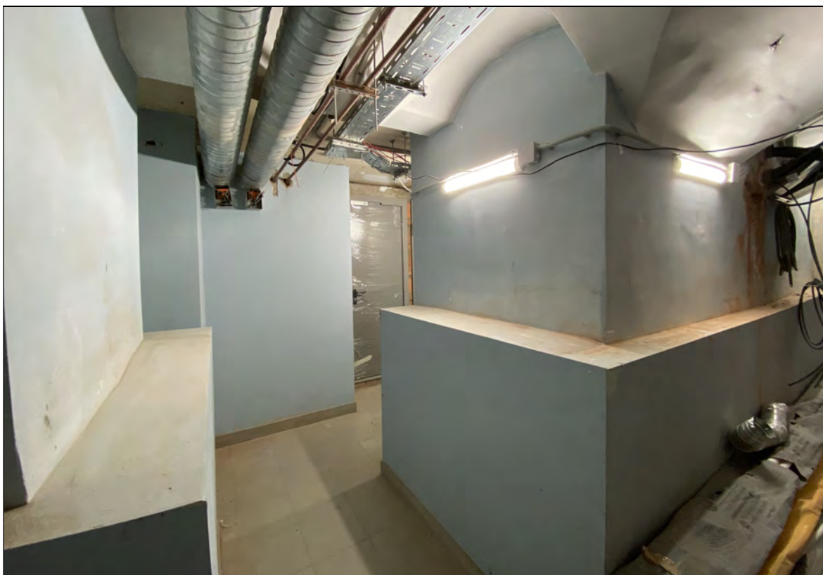
12. Объект культурного наследия «Большой железный ряд или Кожевенная линия». Средний корпус. Подвал, помещение № 30. Вид в сторону помещения № 22. 11.11.2020 г.
