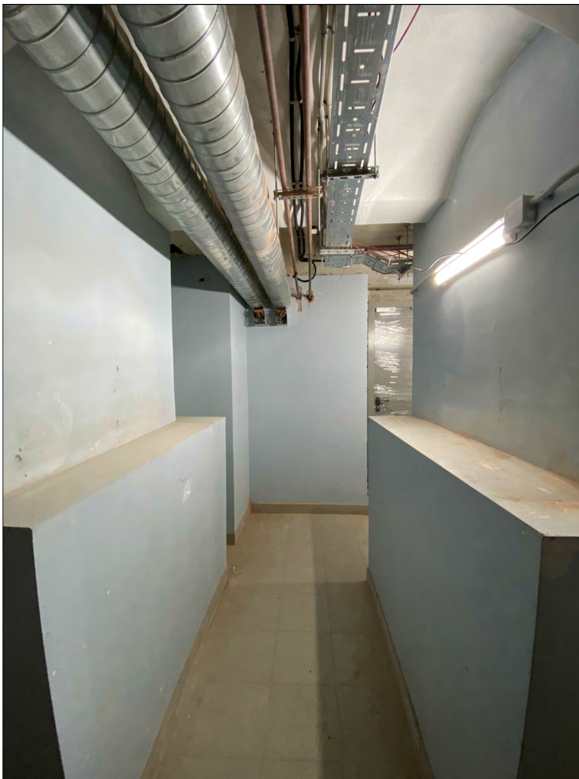
11. Объект культурного наследия «Большой железный ряд или Кожевенная линия». Средний корпус. Подвал, помещение № 30. Коридор к помещениям №№ 13, 22. 11.11.2020 г.
