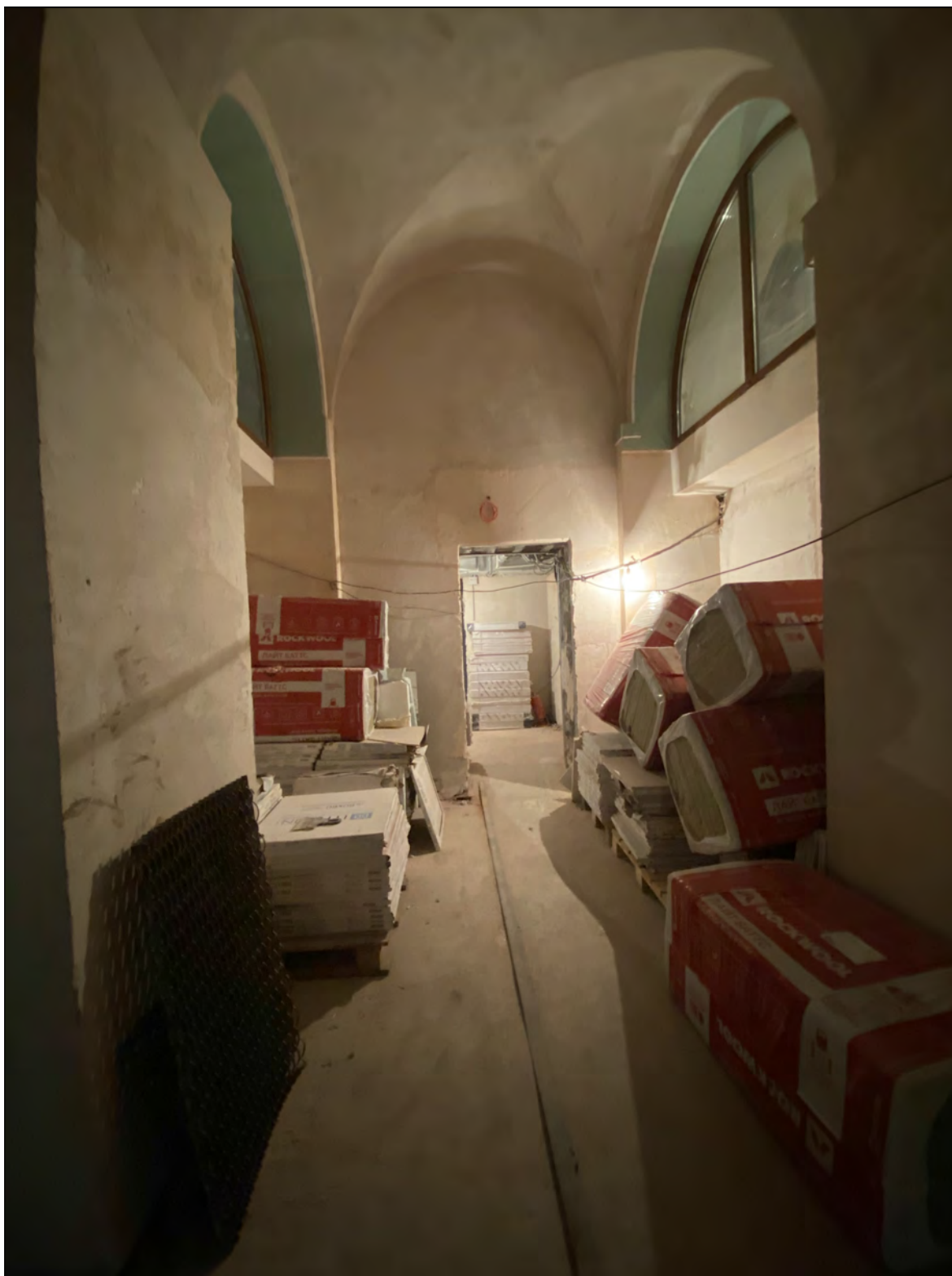
16. Объект культурного наследия «Большой железный ряд или Кожевенная линия». Средний корпус. 1-й этаж, западная часть помещения № 115. 11.11.2020 г.
