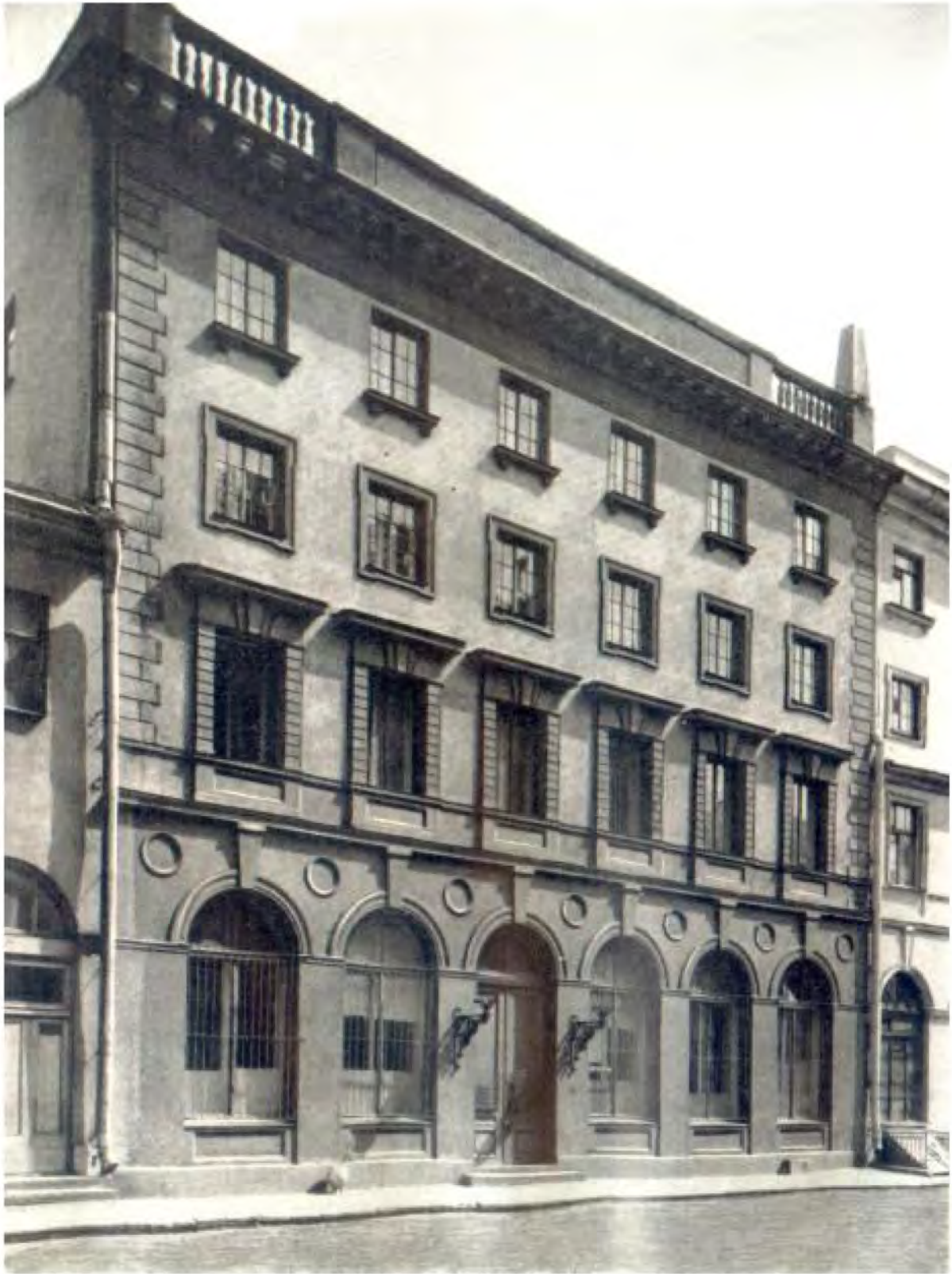
Илл. 25. Торговый дом В.П. Липина. Фасад по Мучному переулку. 1970-е гг. Опубликовано в книге: Быкова Г.Д. Андрей Оль. - Ленинград : Стройиздат. Ленингр. отд-ние, 1976.
