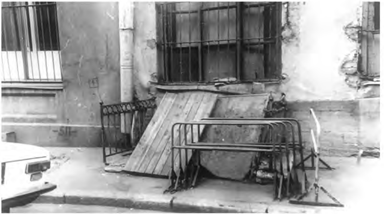
Илл. 33. Малый гостиный двор. Большой железный ряд. Фрагмент фасада со стороны Москательного переулка. Архив института «Ленжилпроект». 1984 год.
