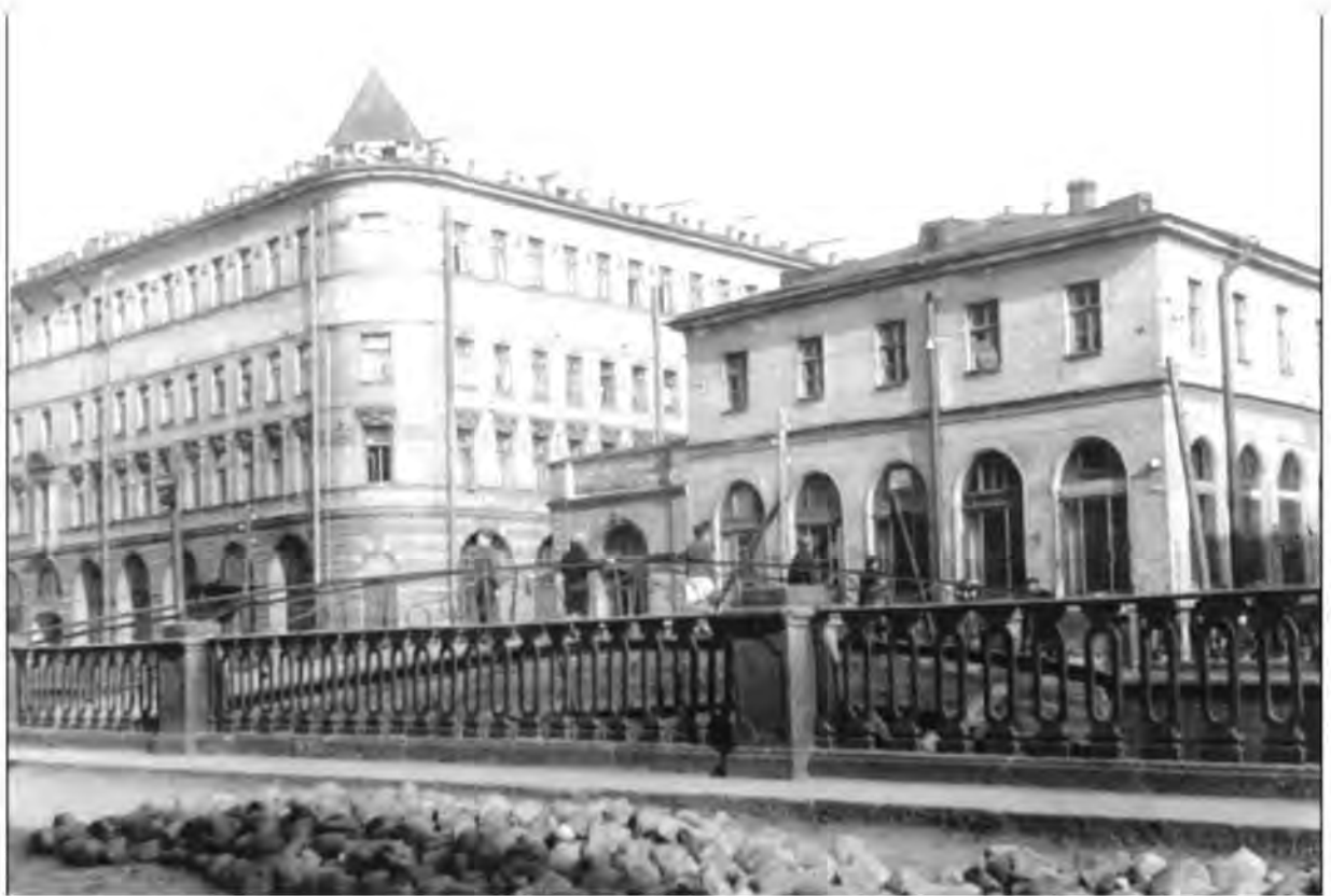
Илл. 22. Вид части набережной в районе Мучного и Москательного переулков. Автор снимка А.Н. Казьмин. 1950-е гг. ЦГА КФФД СПб. Ар 207863.
