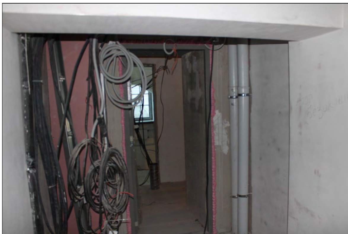
20. Объект культурного наследия «Большой железный ряд или Кожевенная линия». Средний корпус. 2-й этаж, северная часть помещения № 207. Кабели гр.1 и гр. 2. 11.11.2020 г.
