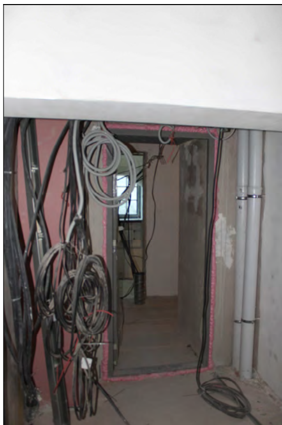
19. Объект культурного наследия «Большой железный ряд или Кожевенная линия». Средний корпус. 2-й этаж, северная часть помещения № 207. Кабели гр.1 и гр. 2. 11.11.2020 г.
