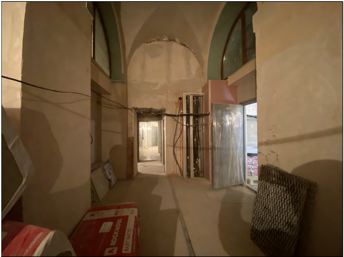
14. Объект культурного наследия «Большой железный ряд или Кожевенная линия». Средний корпус. 1-й этаж, восточная часть помещения № 115. 11.11.2020 г.
