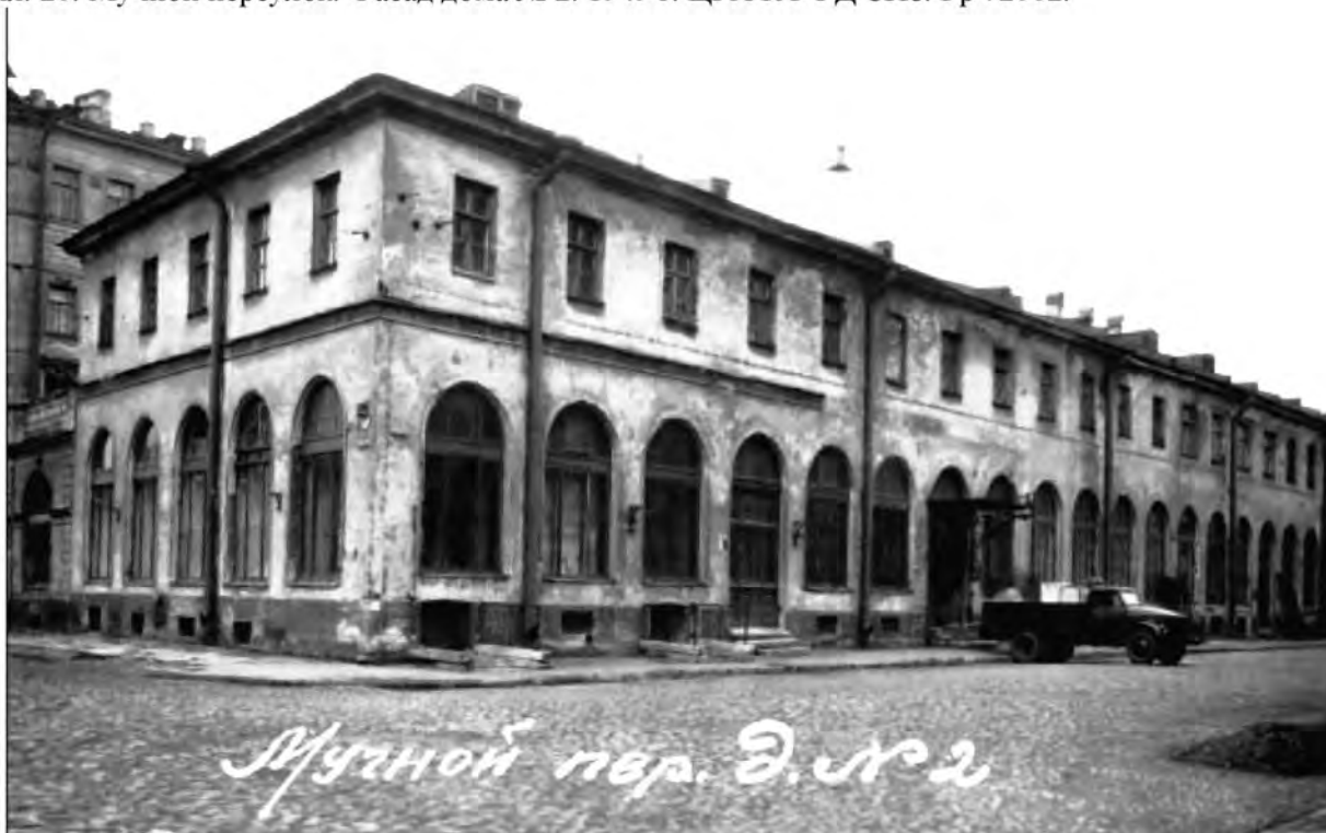
Илл. 21. Мучной переулок. Фасад дома № 2. 1949 г. ЦГА КФФД СПб. Гр 72063.
