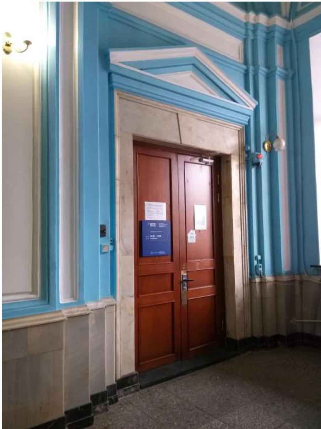
ФФ. 6 Холл. Вид на дверной проем и деревянное заполнение. Облицовка стен и проема мрамором. Треугольный сандрик. 02.05.2020
