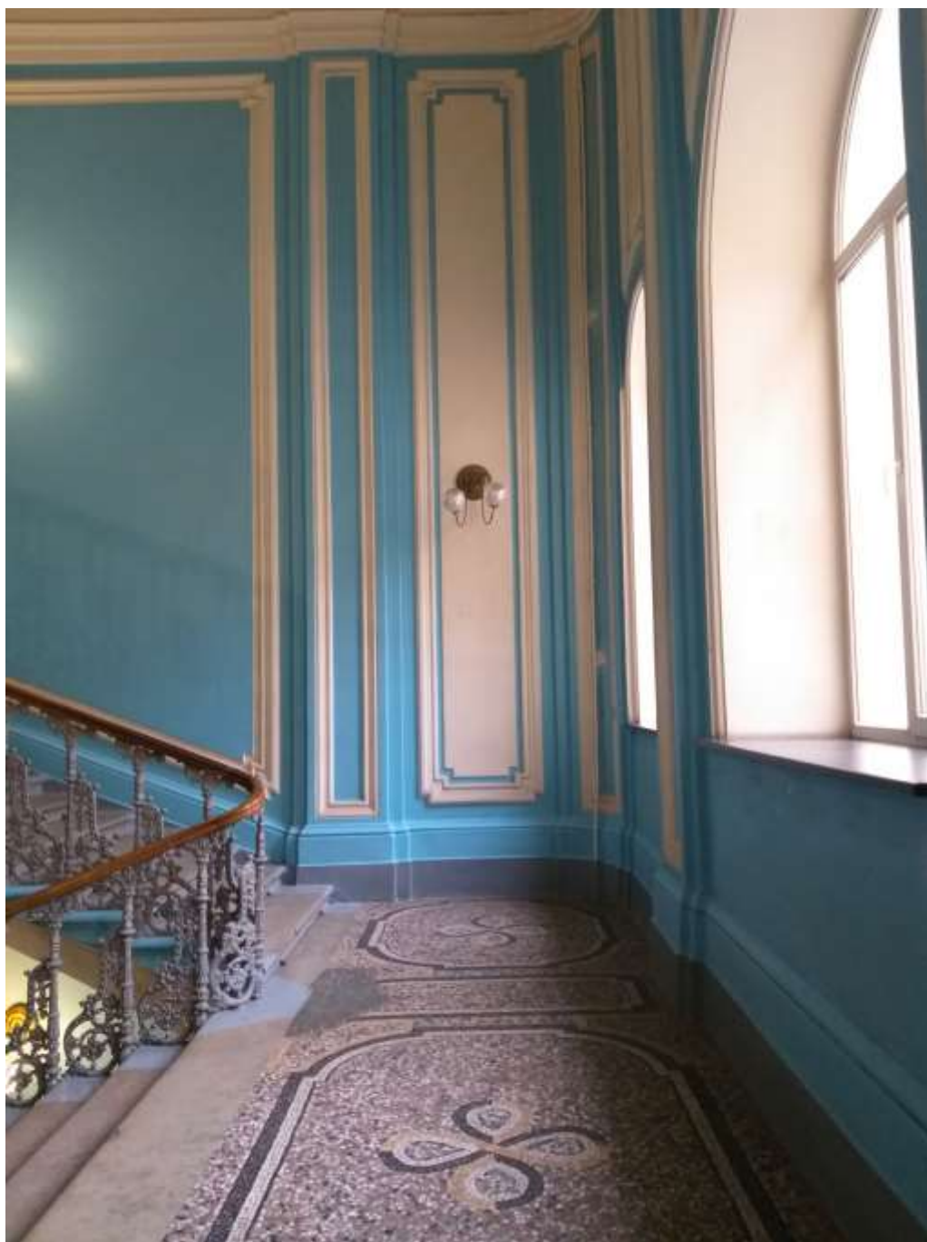
ФФ. 41 Вид на стену в уровне межэтажной площадки. Слева по направлению подъема 02.05.2020.
