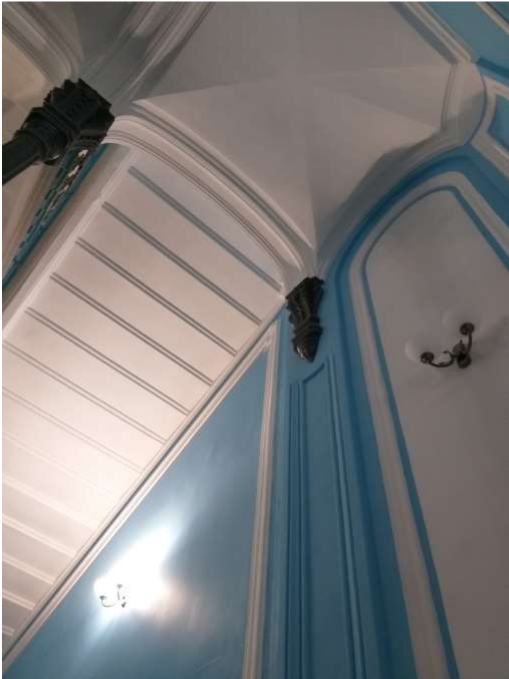
ФФ. 20 Опираие сводика лестничной площадки на колонну и поперечную стену 02.05.2020.
