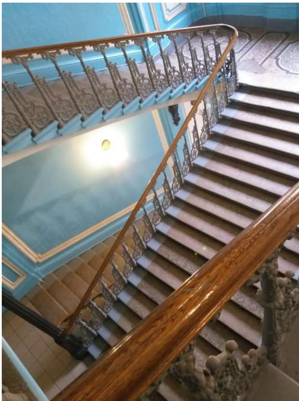
ФФ. 52 Вид на лестничный марш с площадки третьего этажа Взгляд по направлению спуска 02.05.2020.
