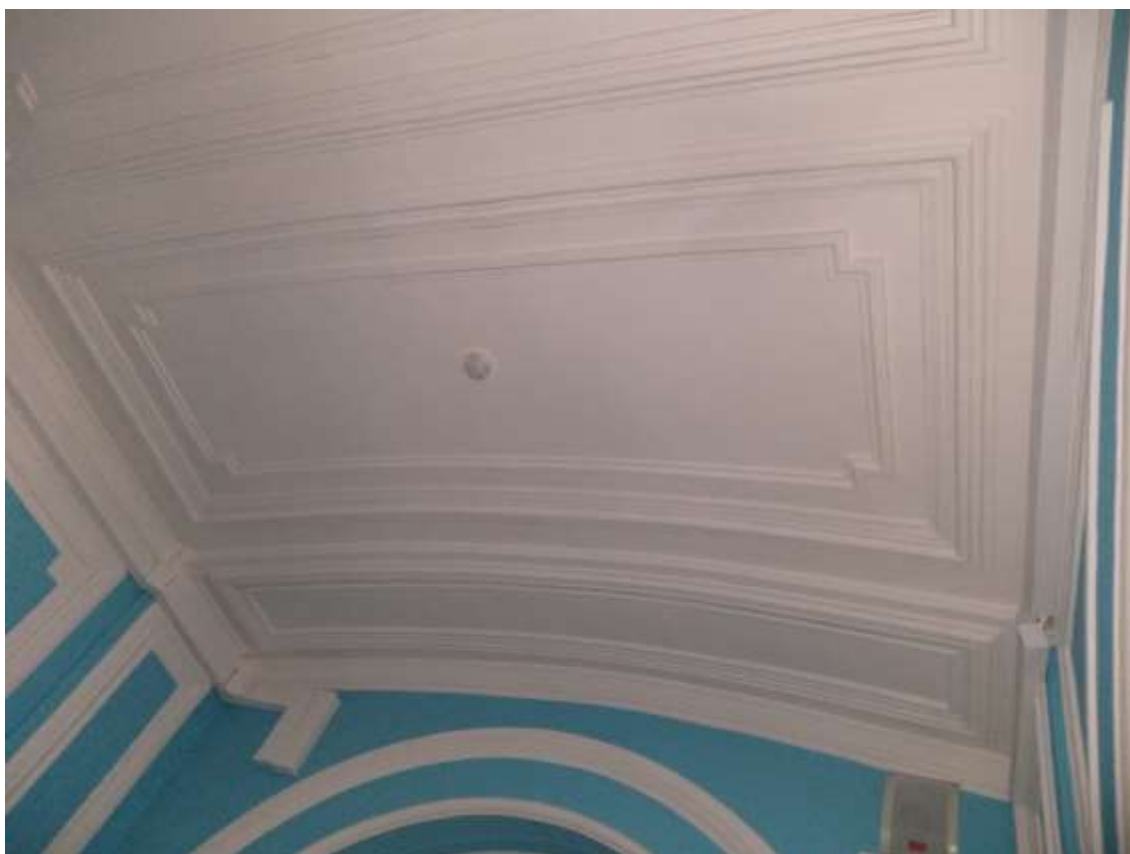
ФФ. 35 Оформление потолка в уровне второго этажа. 02.05.2020.
