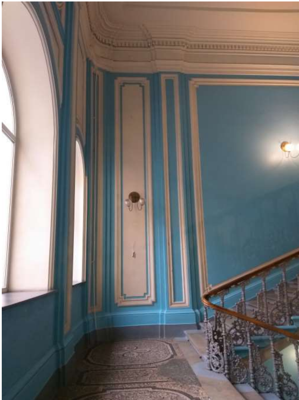
ФФ. 42 Вид на стену в уровне межэтажной площадки. Справа по направлению подъема 02.05.2020.
