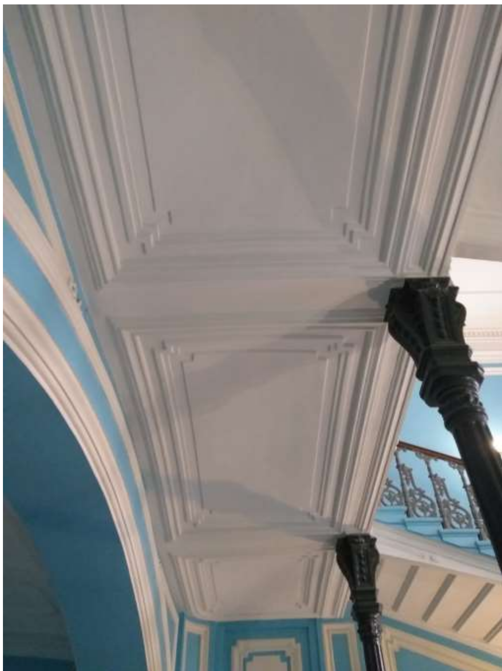
ФФ. 32 Оформление потолка лестничной площадки в уровне второго этажа . 02.05.2020.
