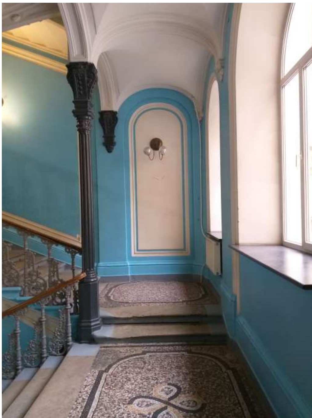
ФФ. 25 Вид на стену в уровне межэтажной площадки. Слева по направлению подъема 02.05.2020.
