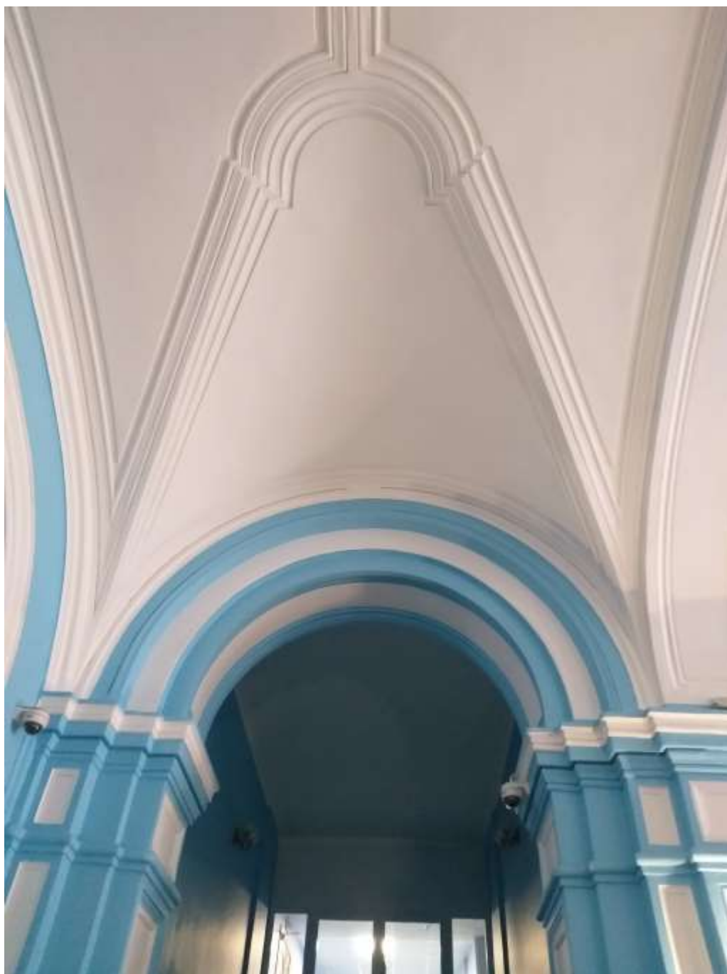
ФФ. 11 Арочный проем и сводчатое перекрытие. 02.05.2020
