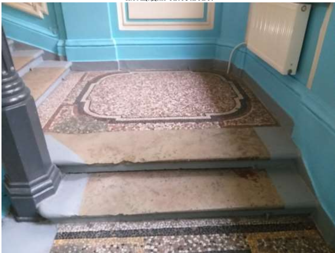
ФФ. 24 Состояние напольного мозаичного покрытия в уровне второй межэтажной площадки. Слева по направлению подъема 02.05.2020.
