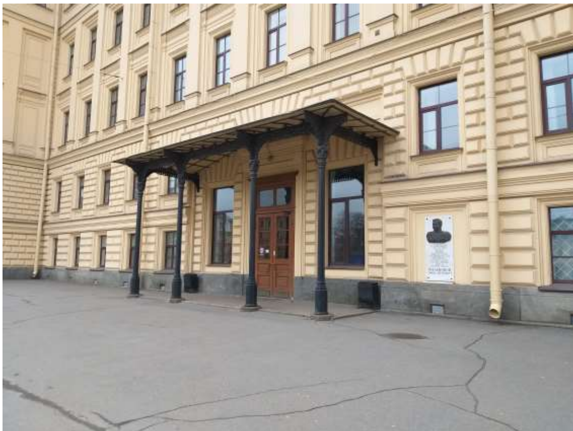
ФФ. 1 Центральный вход. Чугунный козырек на стойках. 02.05.2020
