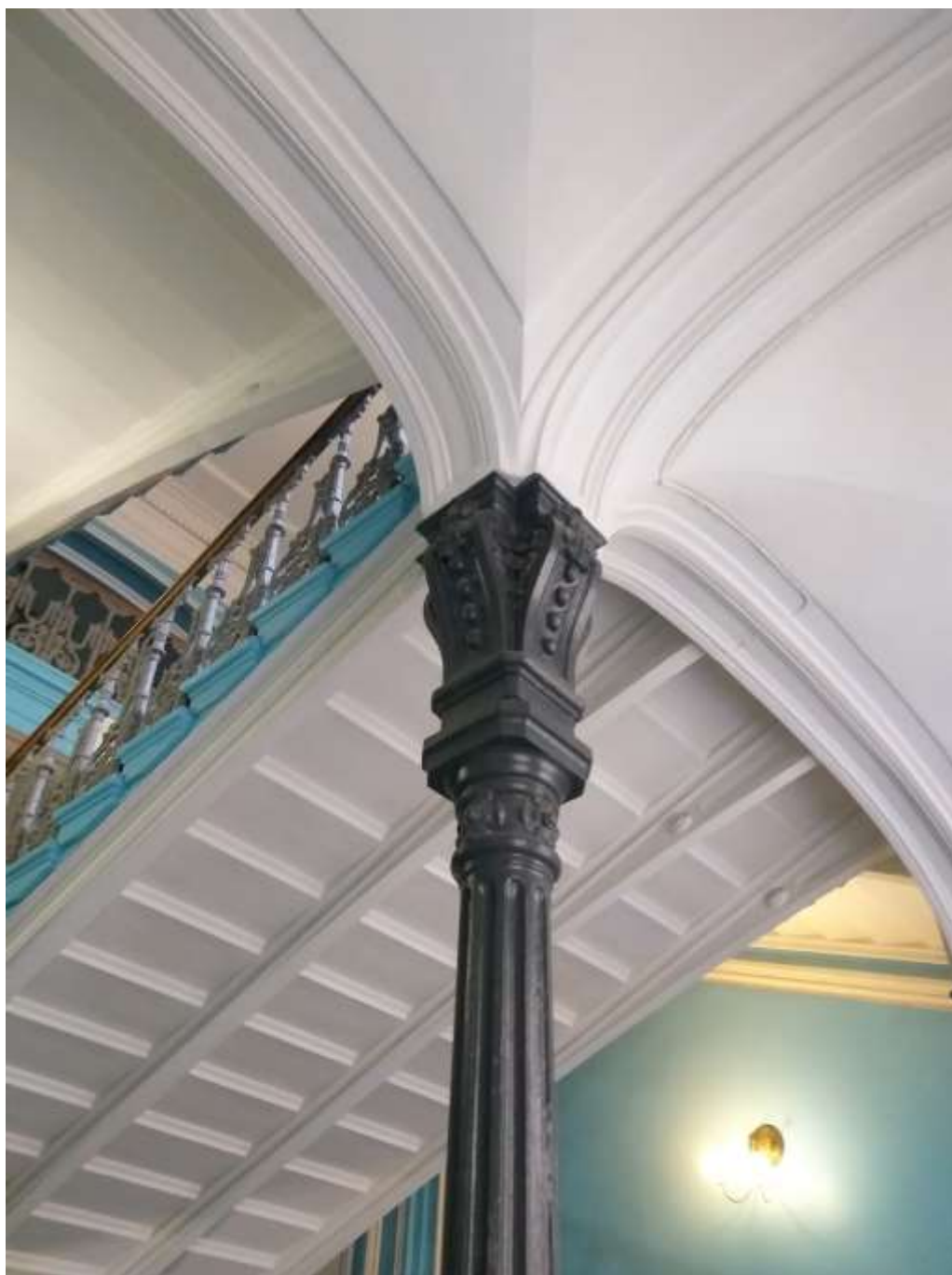
ФФ. 26 Опираие сводика на металлический столб. Слева по направлению подъема 02.05.2020.
