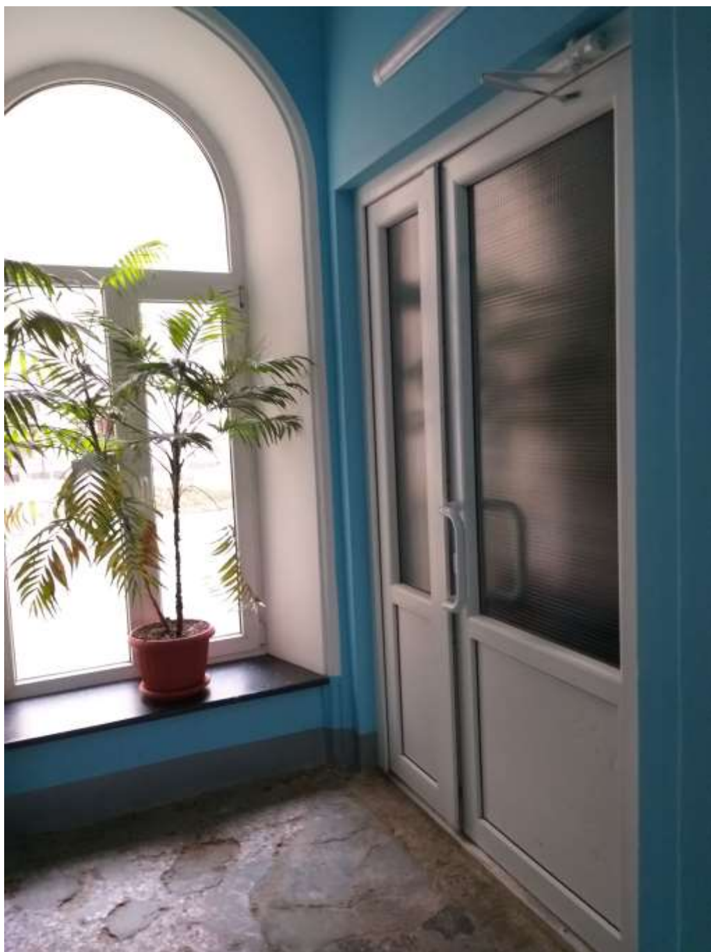
ФФ. 15 Коридор в уровне первого этажа слева от лестницы. Вход в подлестничное пространство 02.05.2020
