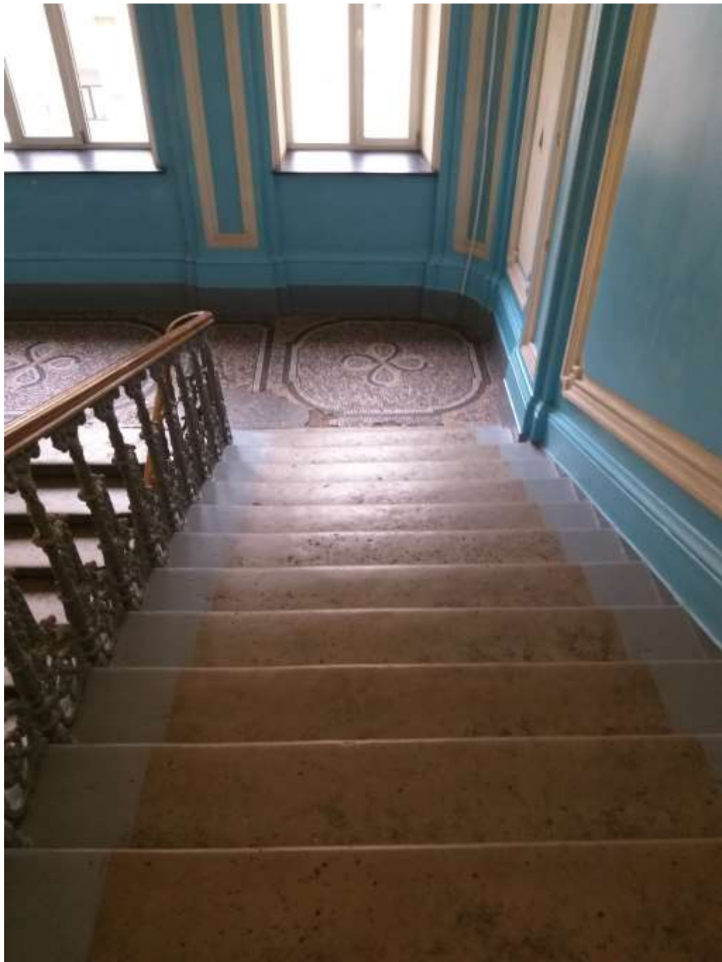
ФФ. 51 Вид на лестничный марш между вторым и третьим этажами. Справа по направлению спуска 02.05.2020.
