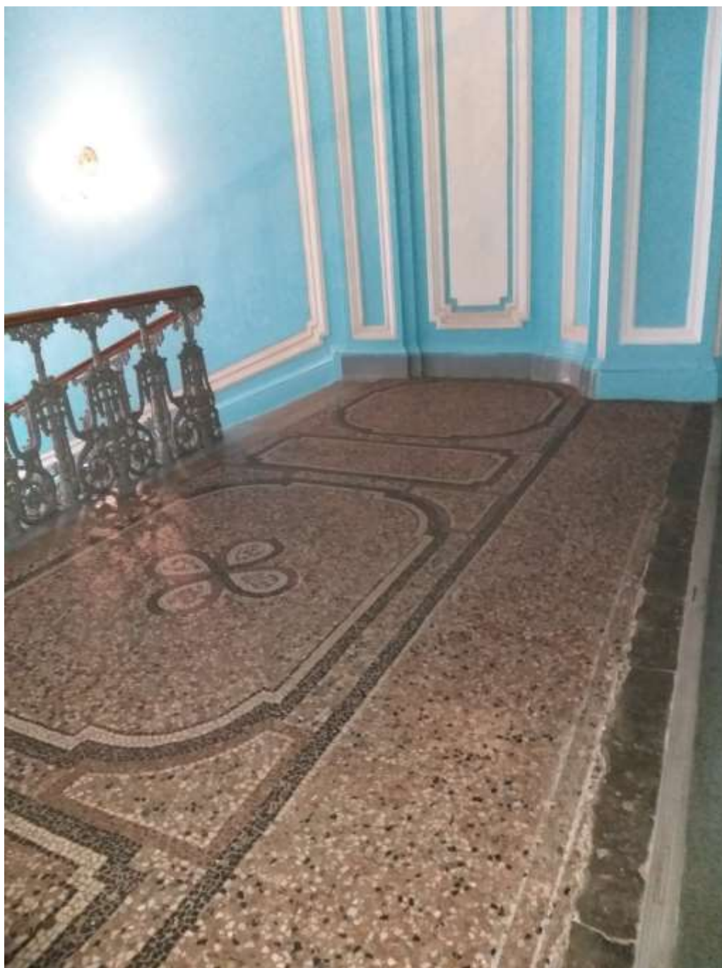
ФФ. 48 Мозаичное напольное покрытие в уровне третьего этажа 02.05.2020.
