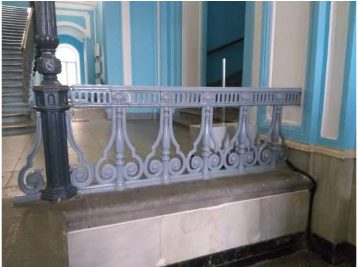
ФФ. 58 Ограждение площадки. 02.05.2020.
