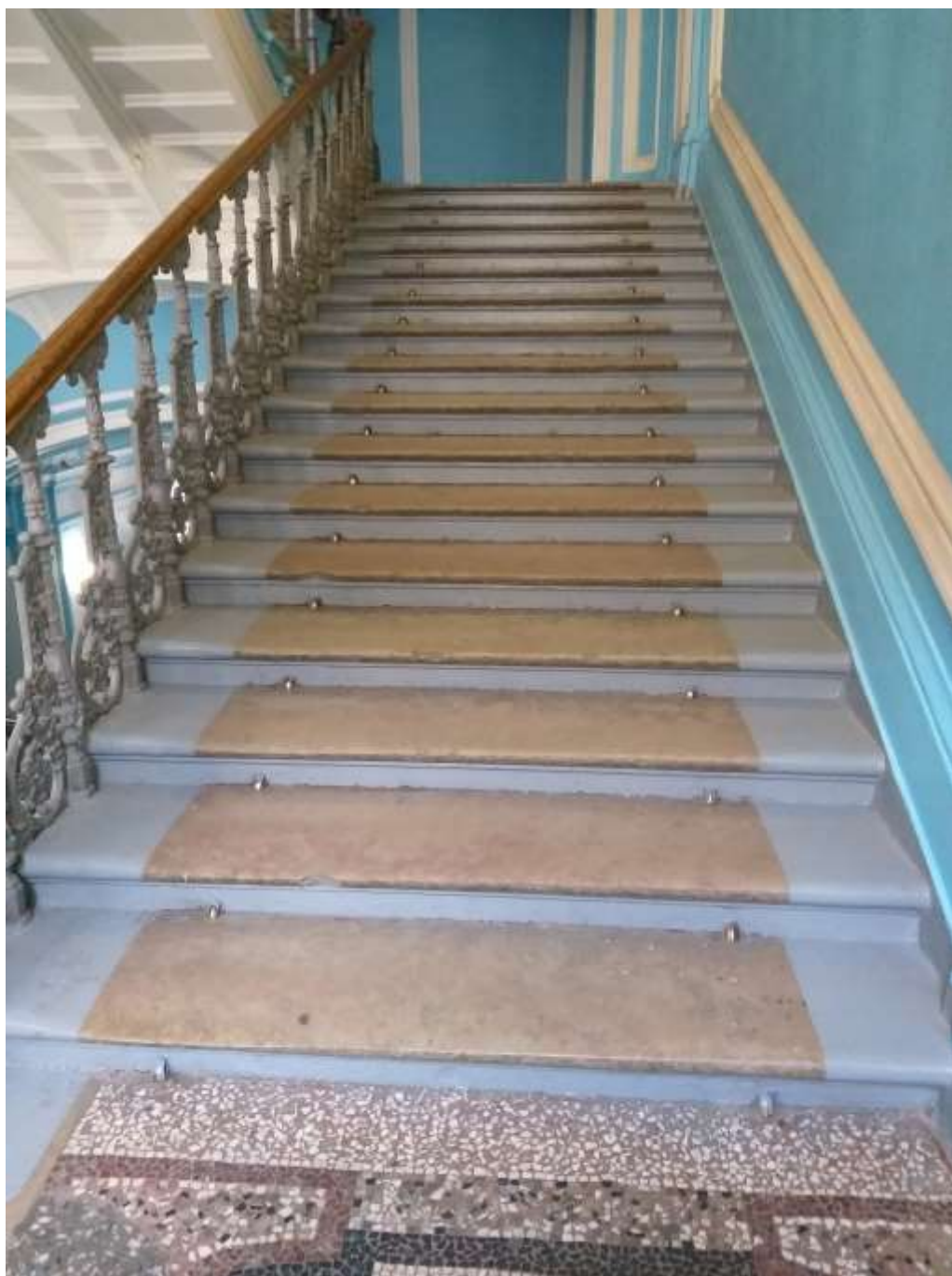
ФФ. 29 Вид на лестничный марш. Слева по направлению подъема 02.05.2020.
