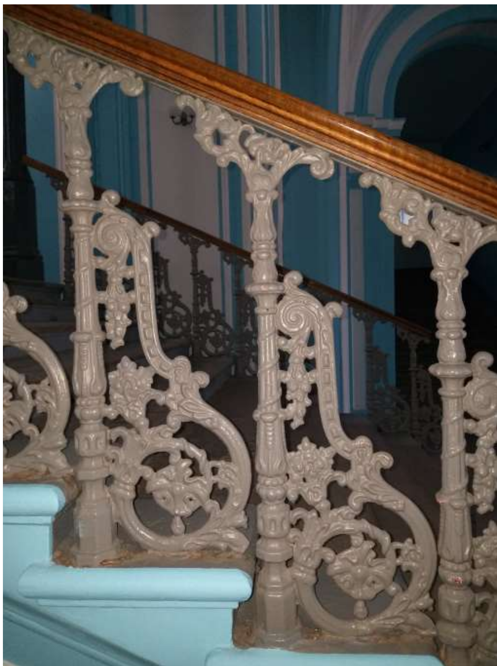
ФФ. 56 Ограждение лестницы 02.05.2020.
