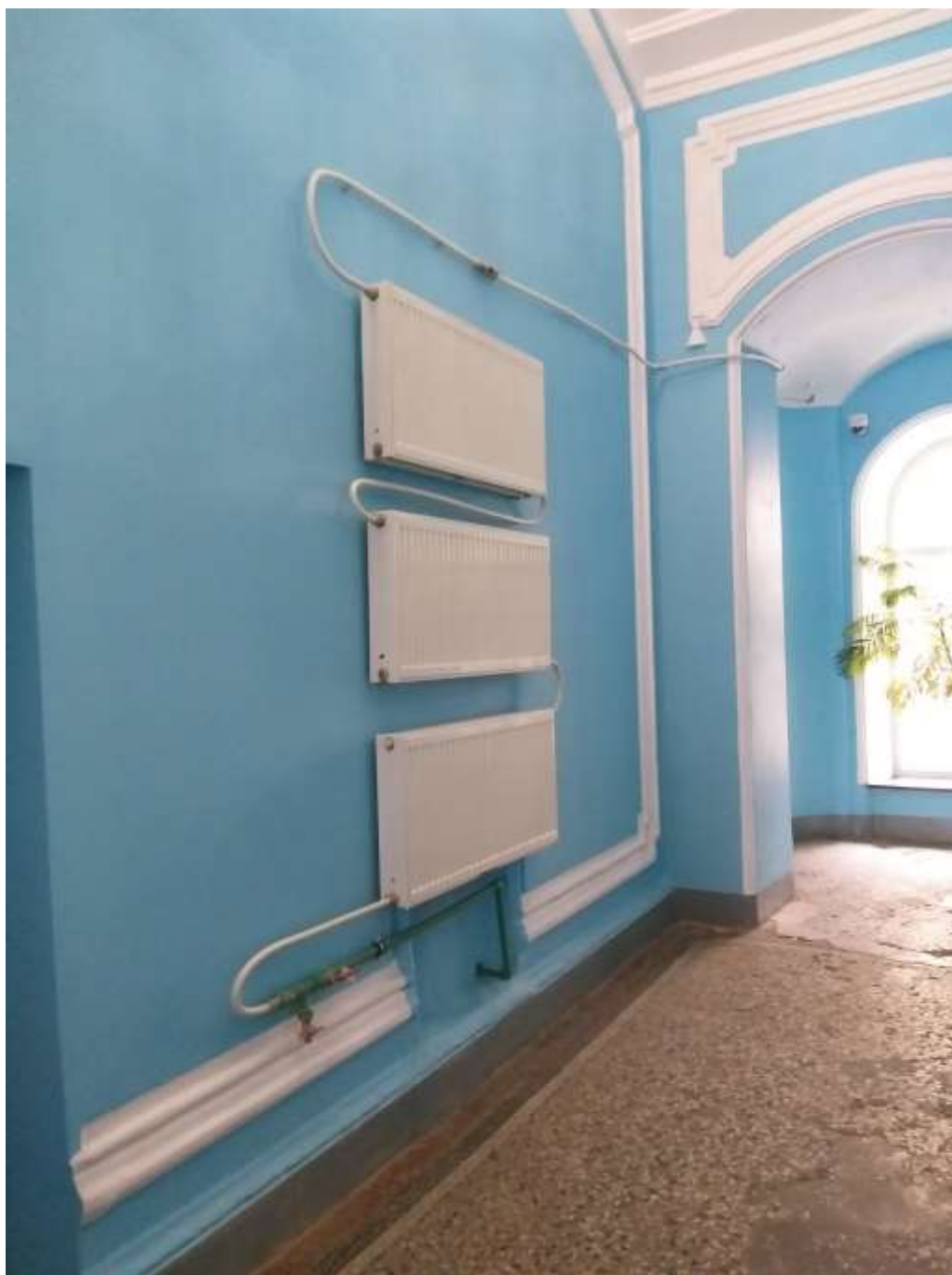
ФФ. 14 Стены коридора в уровне первого этажа слева от лестницы. Система отопления помещения 02.05.2020
