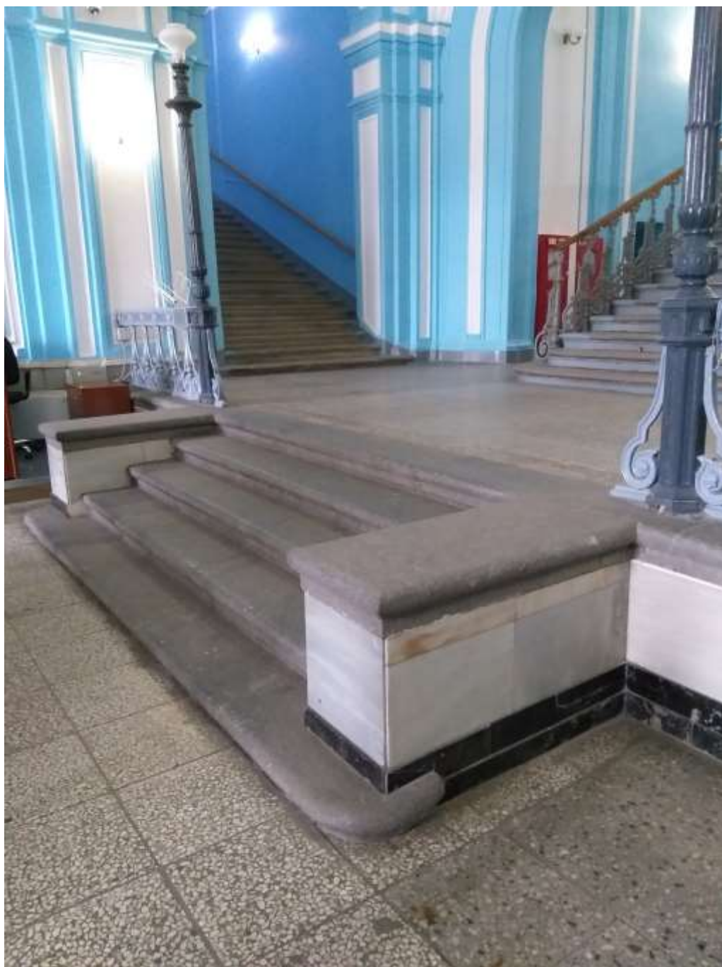
ФФ. 7 Мраморная лестница. Металлические фонари. Вид из холла. 02.05.2020
