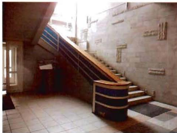
13,14. Ограждение в виде глухого парапета с деревянным поручнем
