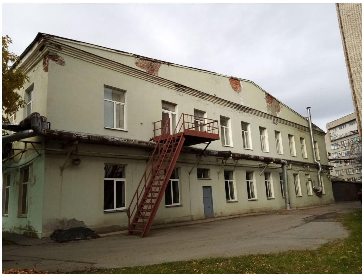
7. Юго-восточный фасад объекта культурного наследия регионального значения «Фабрика – кухня Путиловской верфи», расположенного по адресу: г. Санкт-Петербург, Корабельная ул., д. 6, литера ЕЮ. 13.08.2020.
