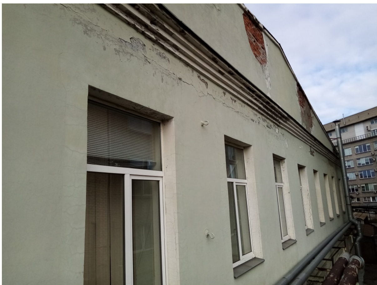
8. Венчающий карниз юго-восточного фасада объекта культурного наследия регионального значения «Фабрика – кухня Путиловской верфи», расположенного по адресу: г. Санкт-Петербург, Корабельная ул., д. 6, литера ЕЮ. 13.08.2020.
