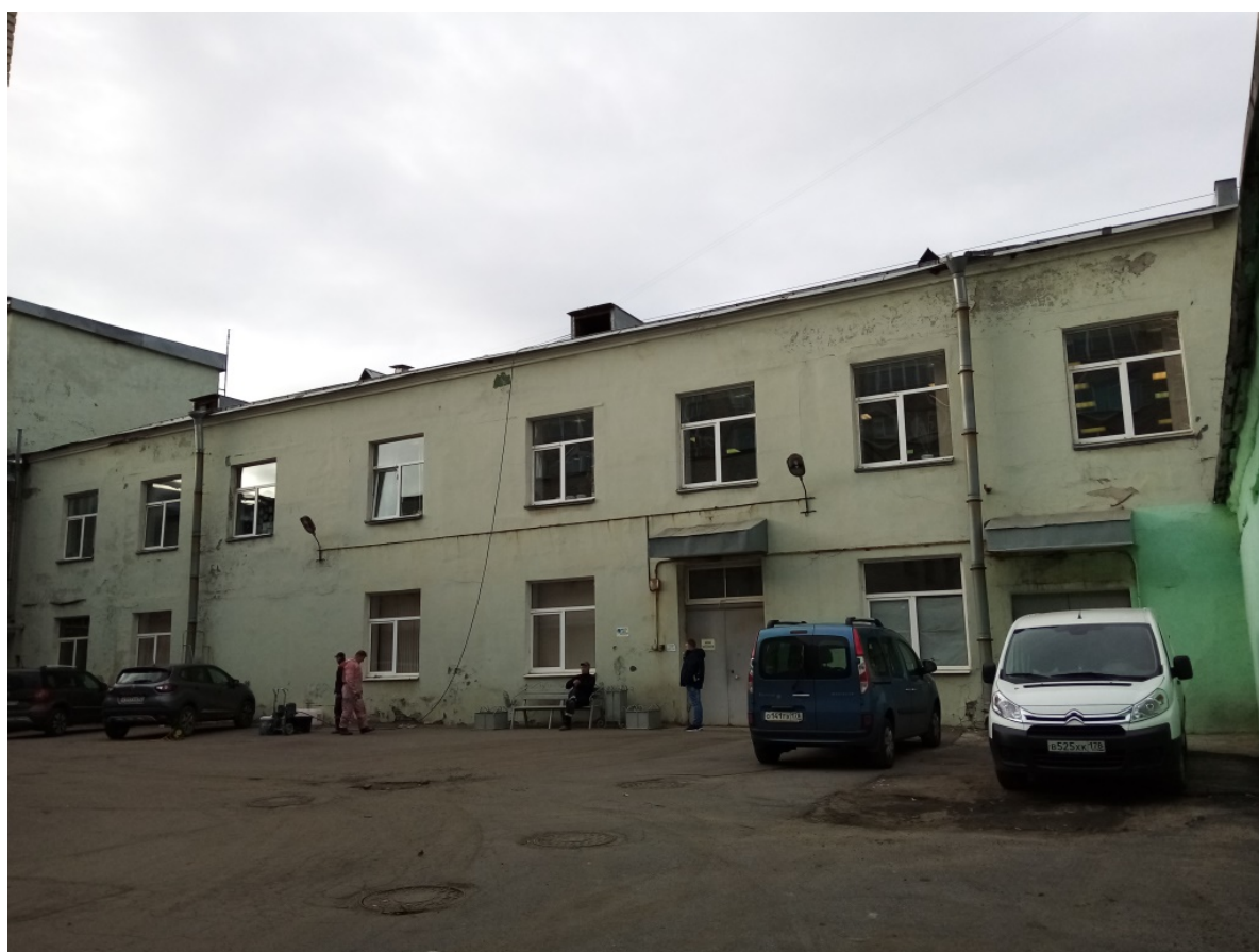
9. Юго-западный фасад объекта культурного наследия регионального значения «Фабрика – кухня Путиловской верфи», расположенного по адресу: г. Санкт-Петербург, Корабельная ул., д. 6, литера ЕЮ. 13.08.2020.
