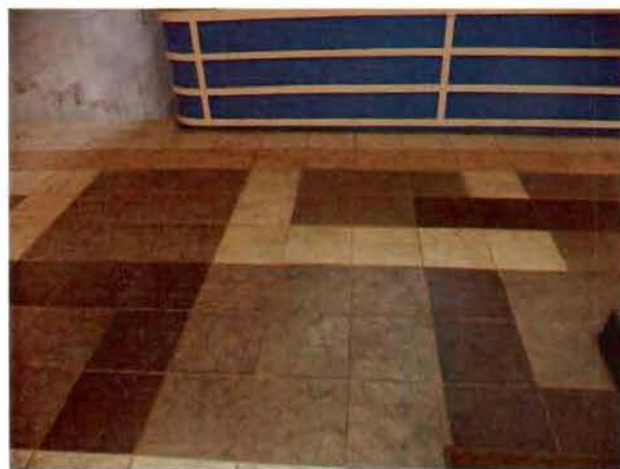
16. Покрытие керамической плиткой
