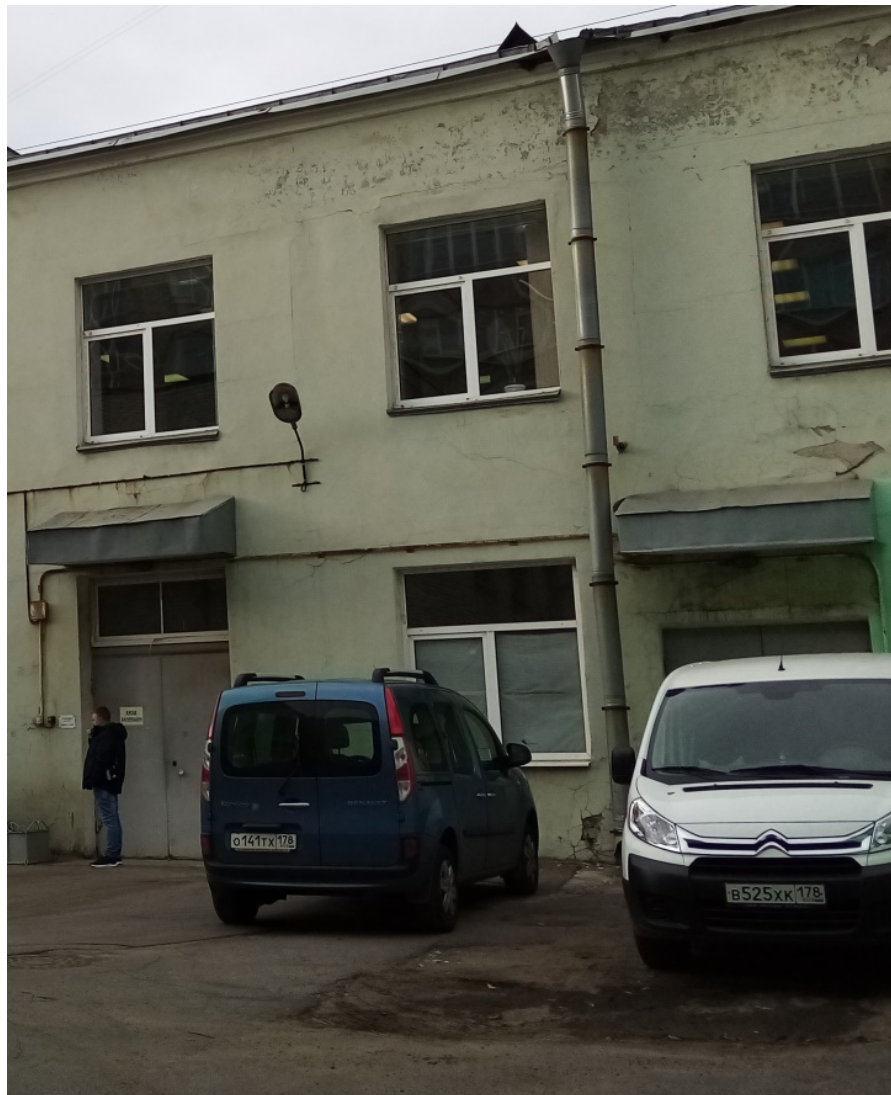
10. Козырьки над входами юго-западного фасада объекта культурного наследия регионального значения «Фабрика – кухня Путиловской верфи», расположенного по адресу: г. Санкт-Петербург, Корабельная ул., д. 6, литера ЕЮ. 13.08.2020.
