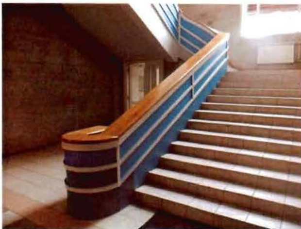
13,14. Ограждение в виде глухого парапета с деревянным поручнем
