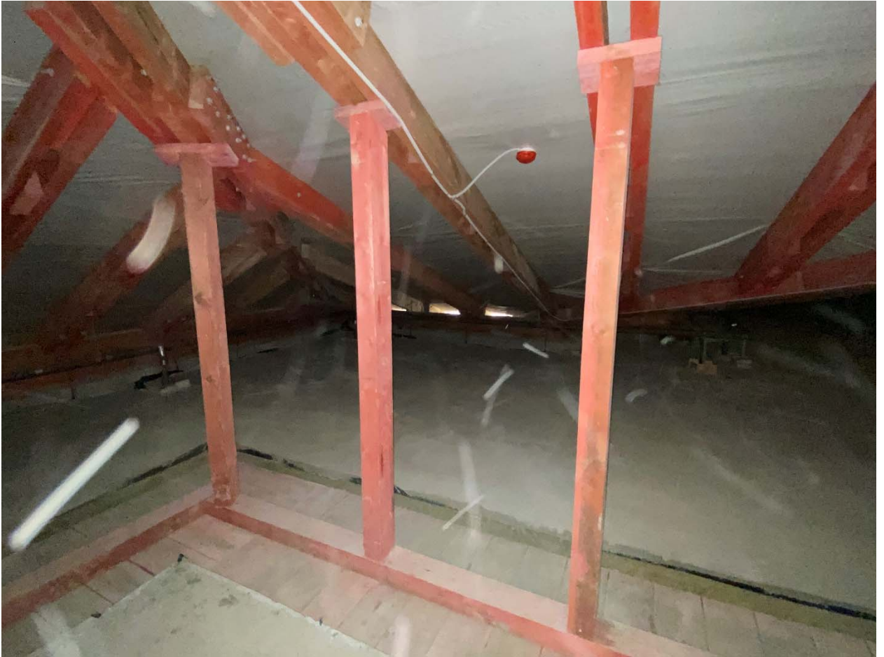
Фото №107. Элементы стропильной системы.
