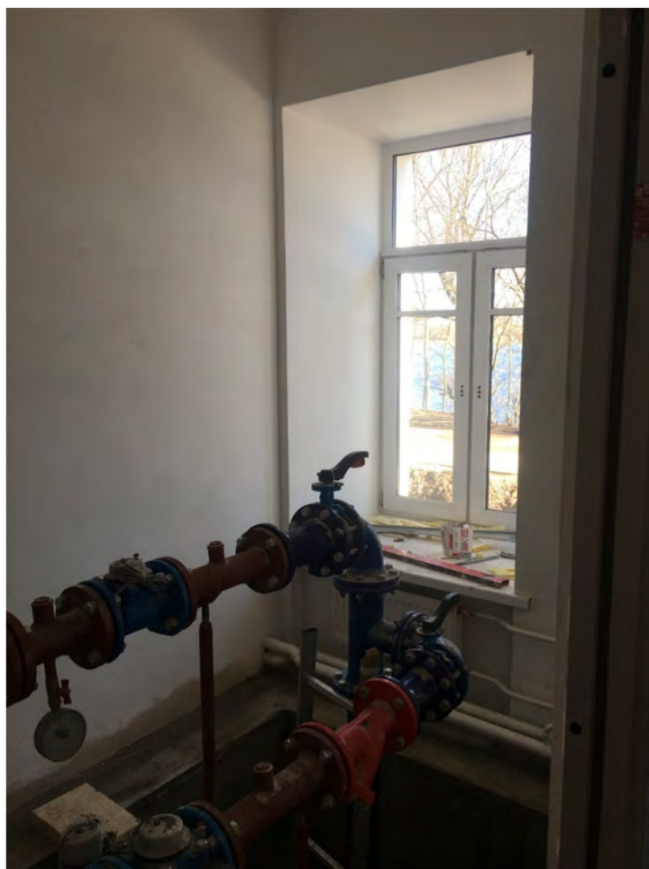
Фото №15. Помещение первого этажа.
