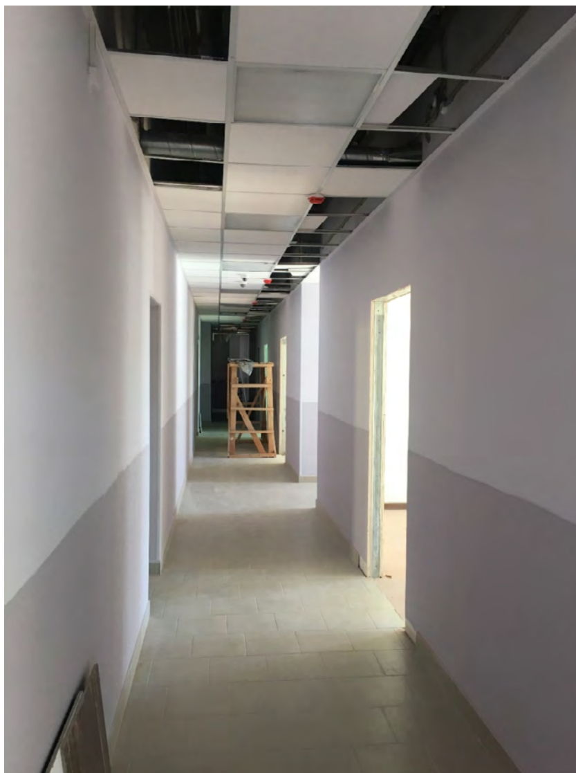
Фото №59. Помещение второго этажа, коридор.
