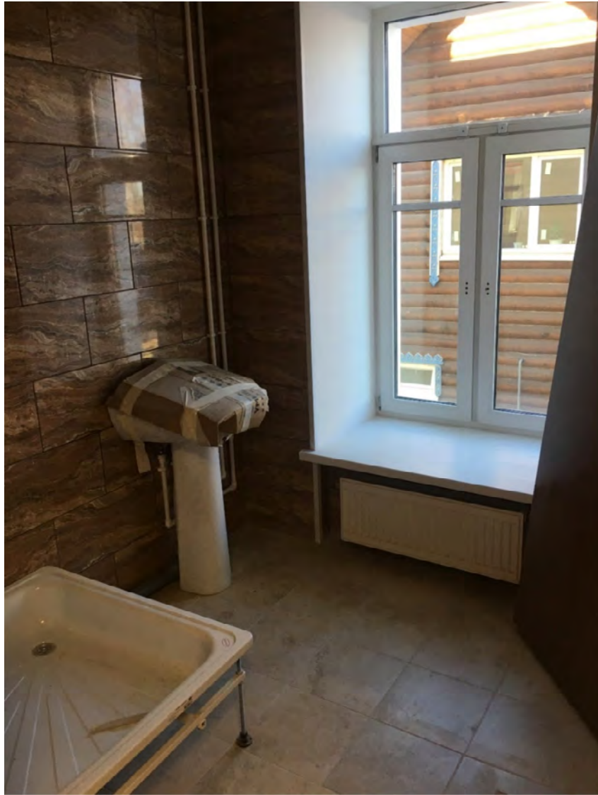
Фото №90. Помещение второго этажа, санузел.
