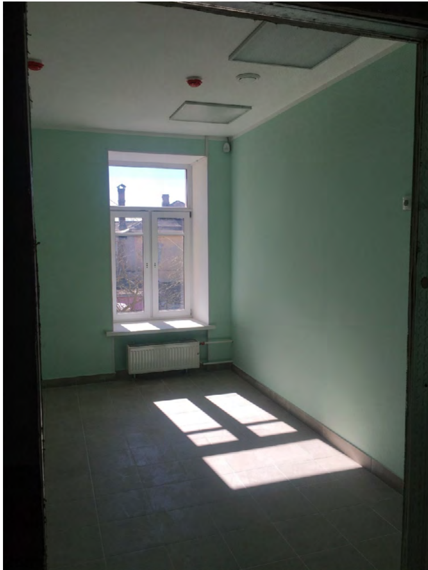
Фото №51. Помещение второго этажа.
