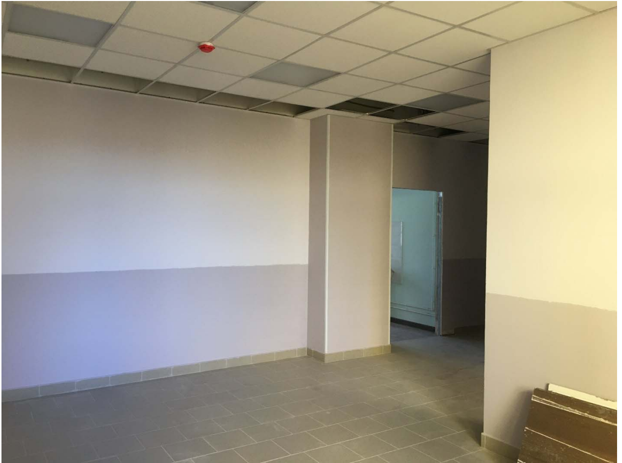
Фото №73. Помещение второго этажа.
