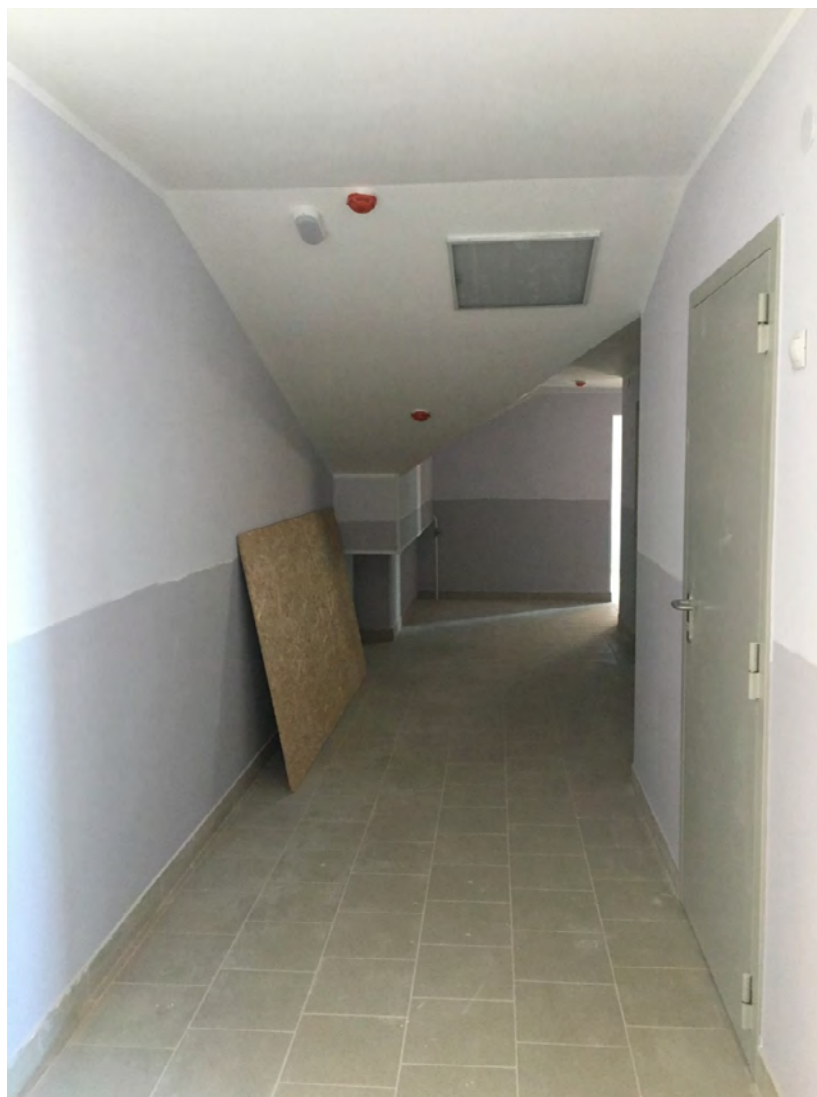
Фото №97. Помещение мансардного этажа, коридор.
