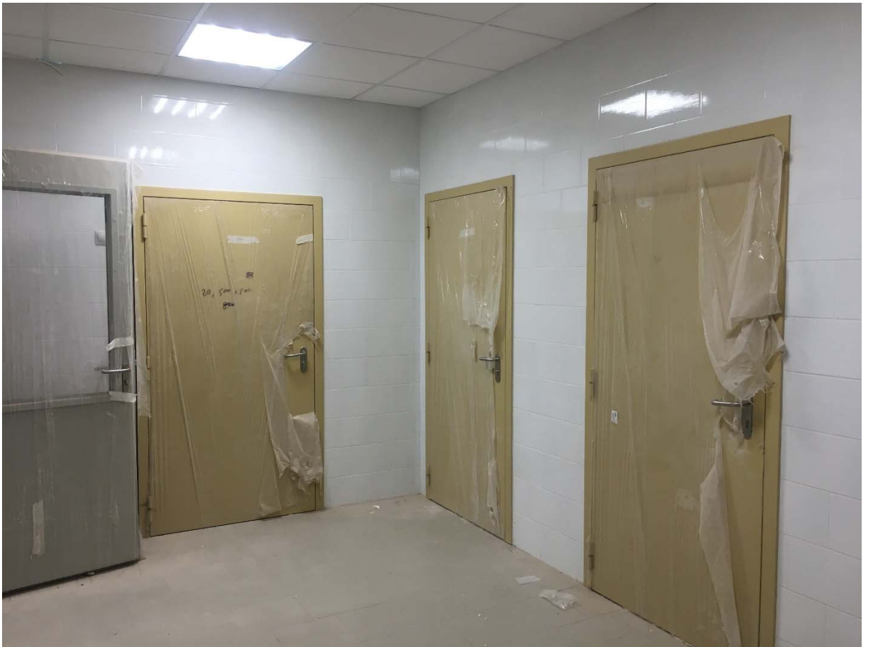
Фото № 35. Помещение первого этажа.
