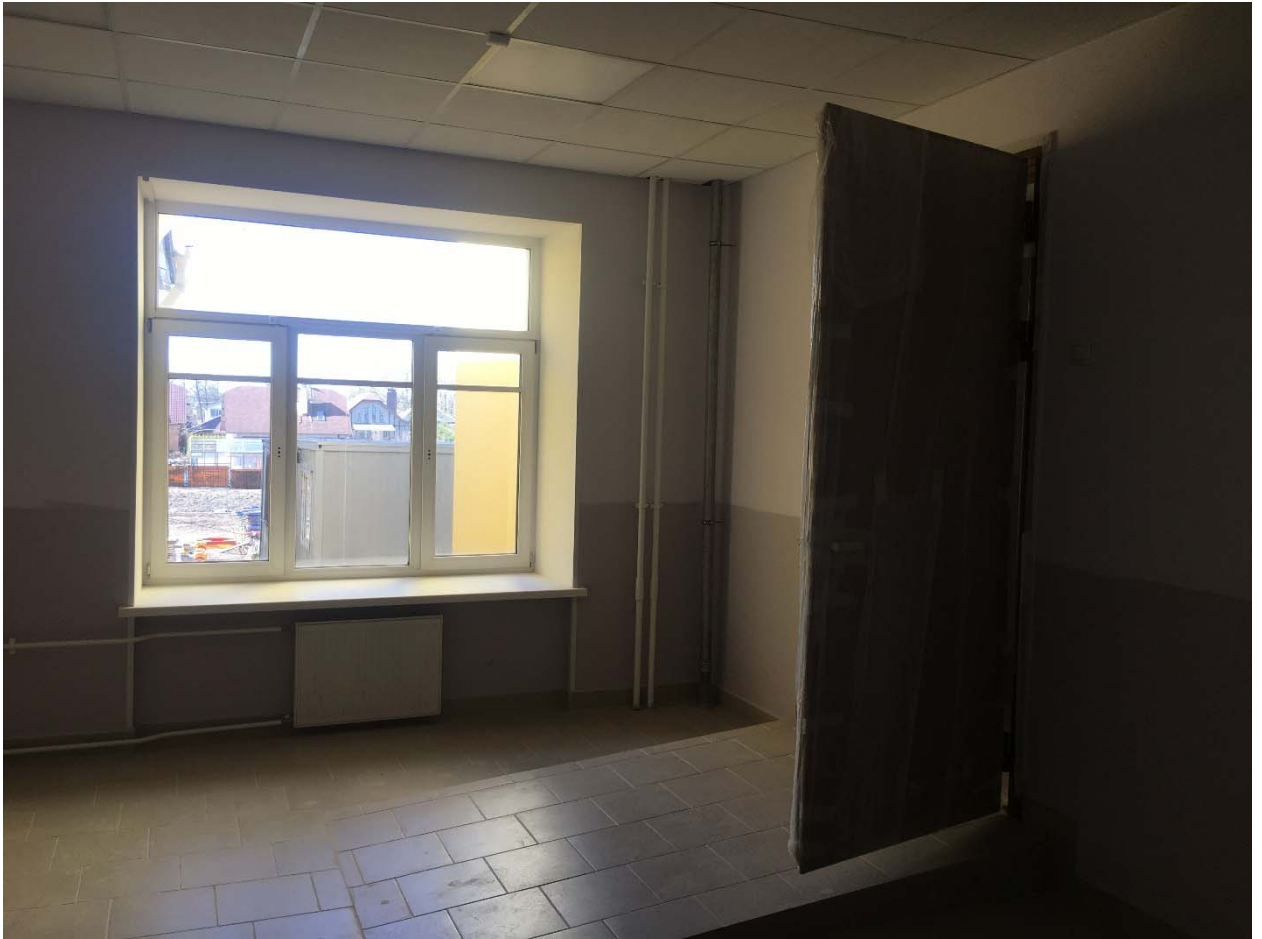
Фото №74. Помещение второго этажа.
