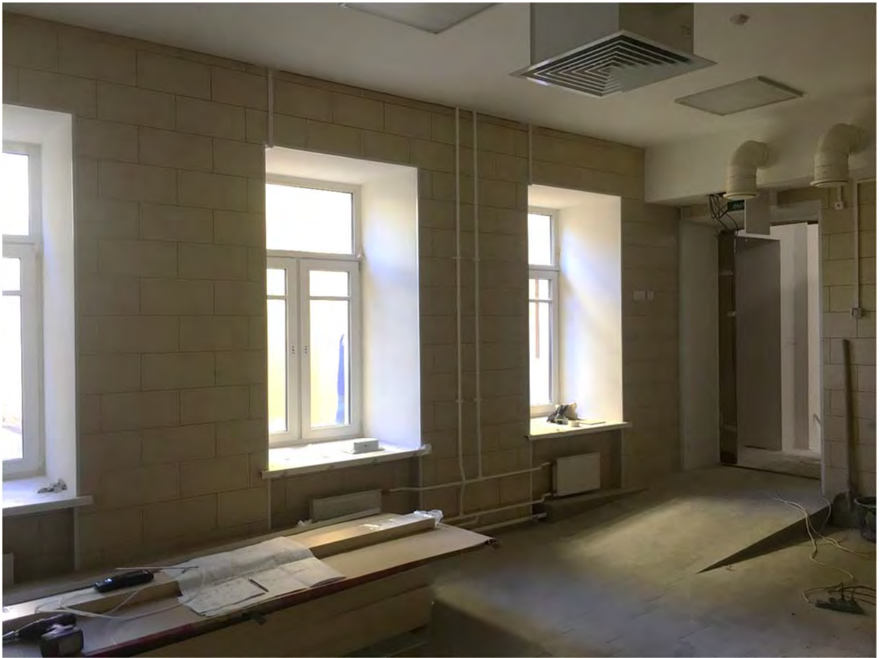
Фото № 42. Помещение первого этажа.
