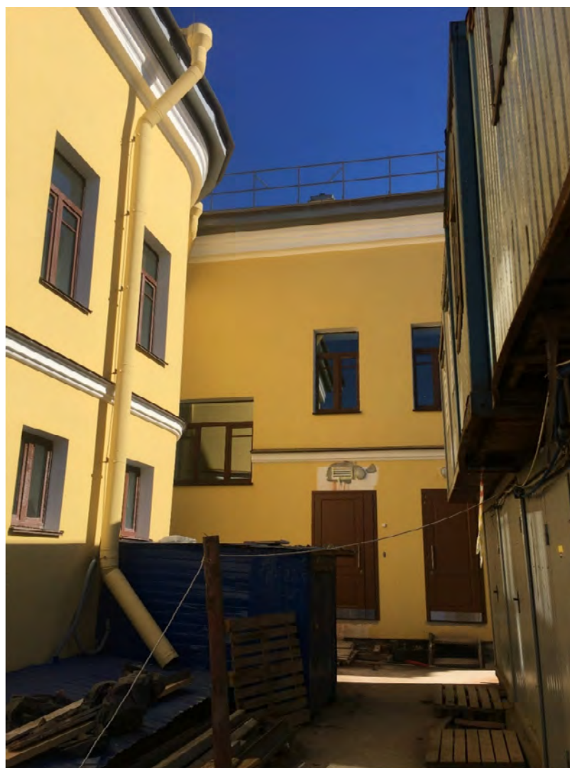
Фото №8. Юго-западный фасад лицевого корпуса и фрагмент северо-западного фасада южного флигеля.
