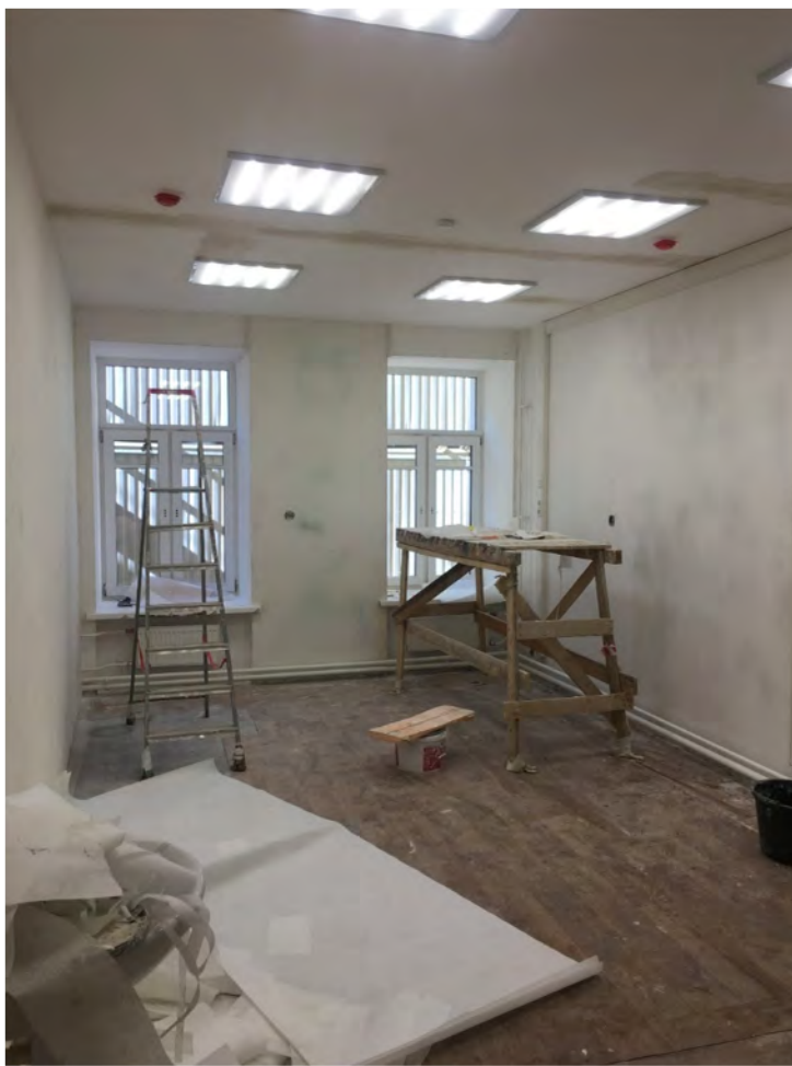
Фото №23. Помещение первого этажа.
