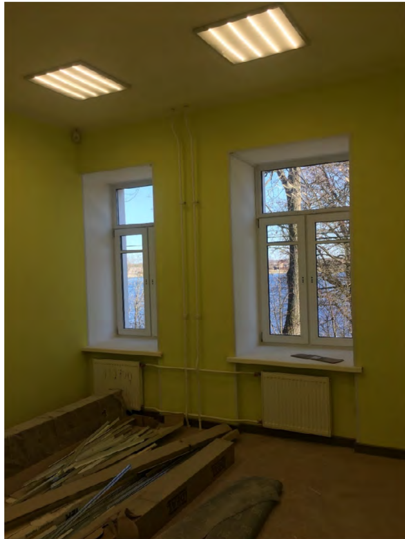
Фото №67. Помещение второго этажа.
