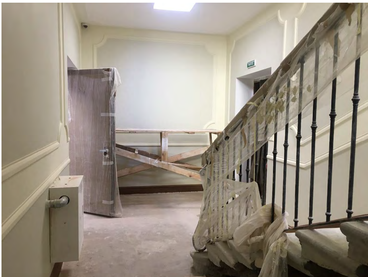
Фото № 30. Первый этаж, лестничная клетка.
