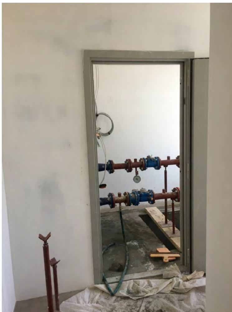
Фото №13. Первый этаж, вспомогательное помещение.
