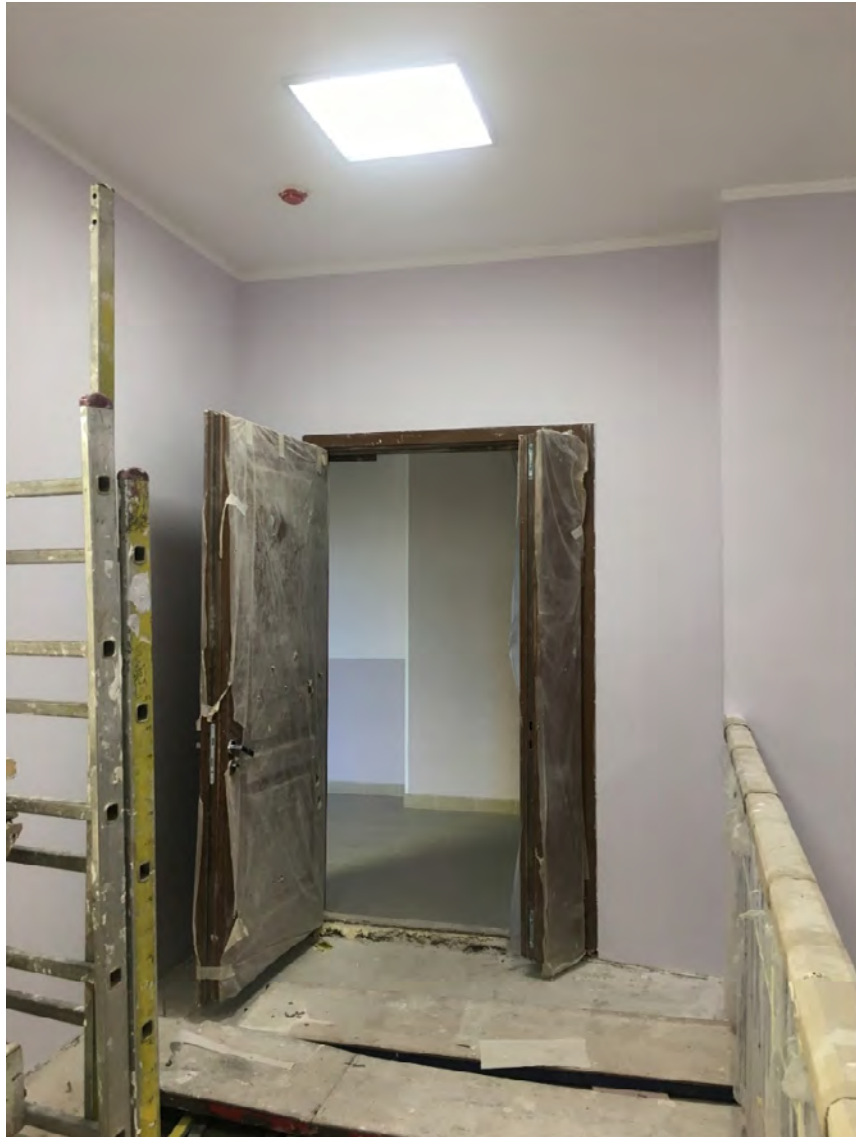
Фото №55 Лестничная площадка второго этажа.
