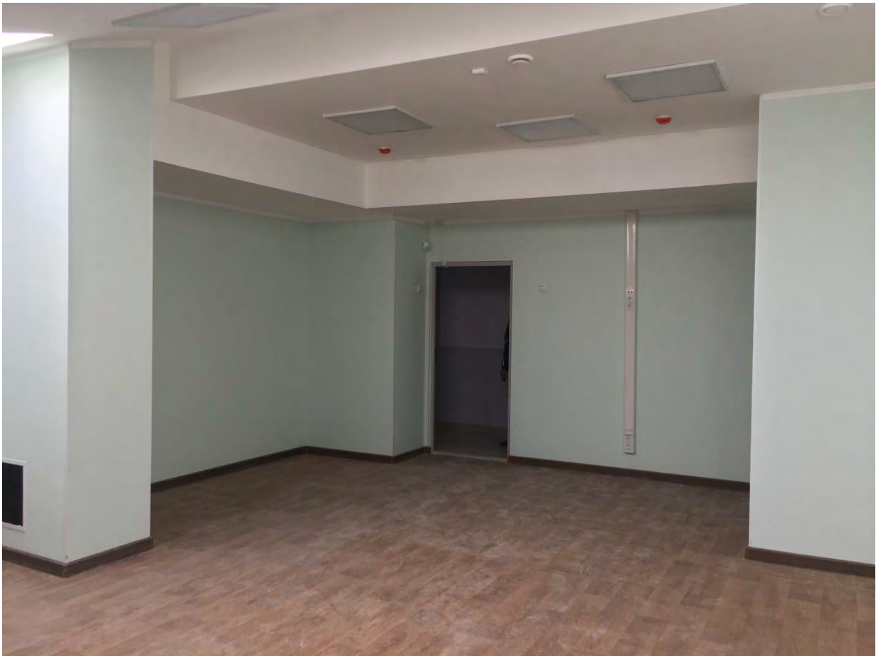
Фото №101. Помещение мансардного этажа.
