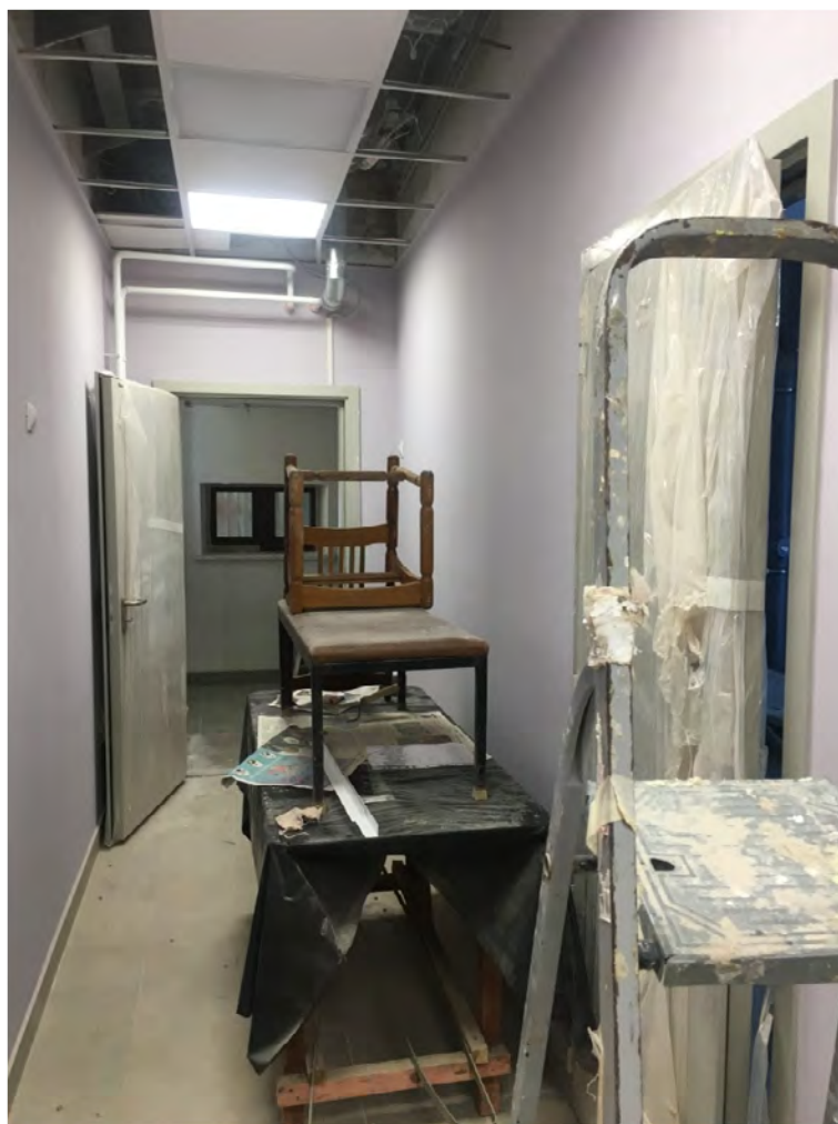
Фото № 32. Помещение первого этажа.
