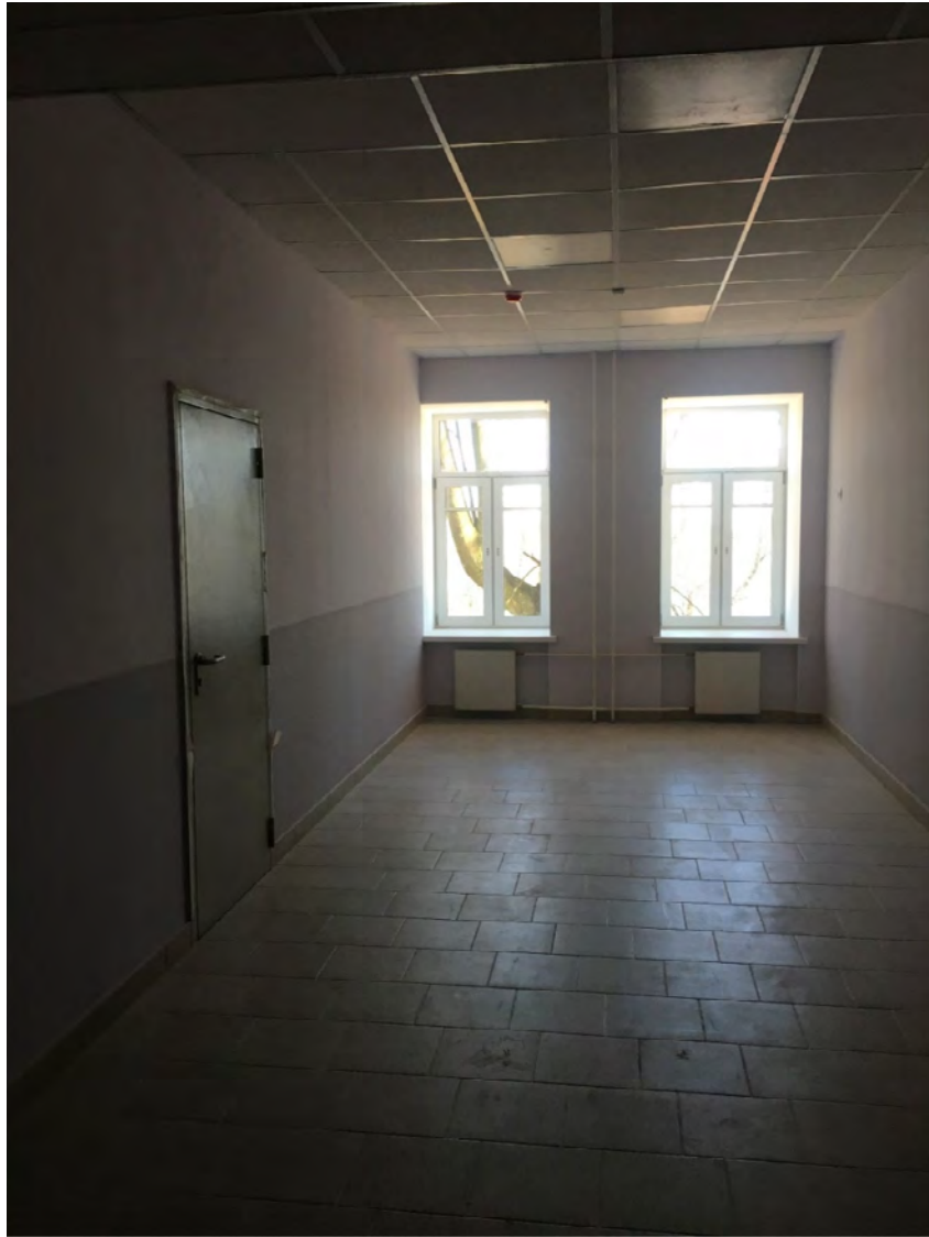
Фото №70. Помещение второго этажа.
