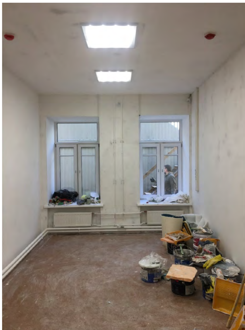
Фото №19. Помещение первого этажа.
