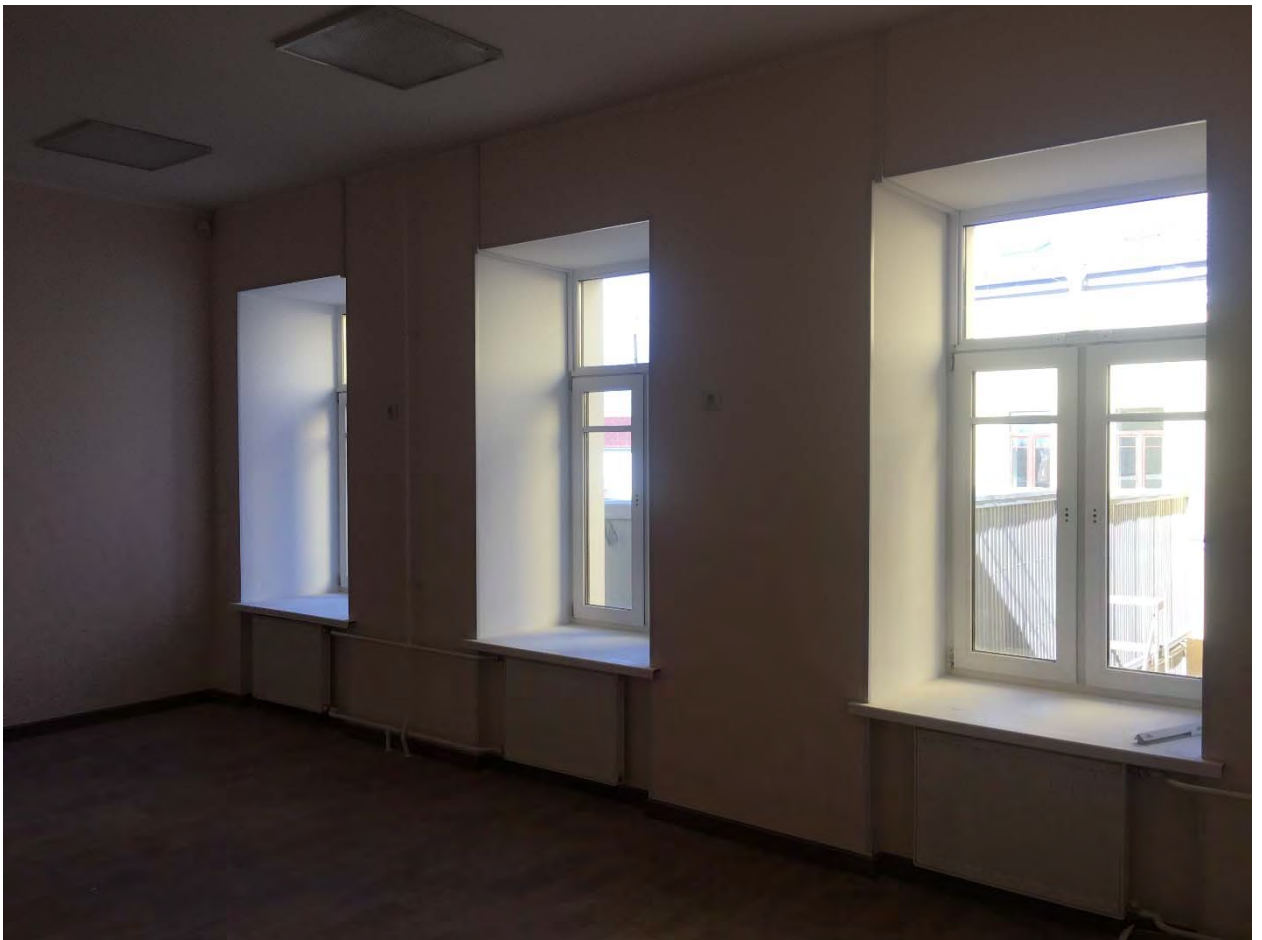
Фото №53. Помещение второго этажа.
