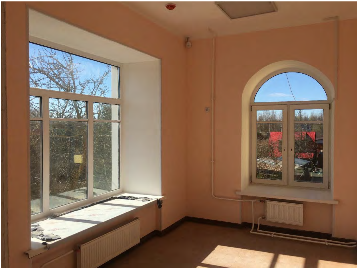
Фото №80. Помещение второго этажа.
