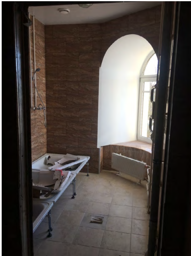
Фото №57. Помещение второго этажа, санузел.
