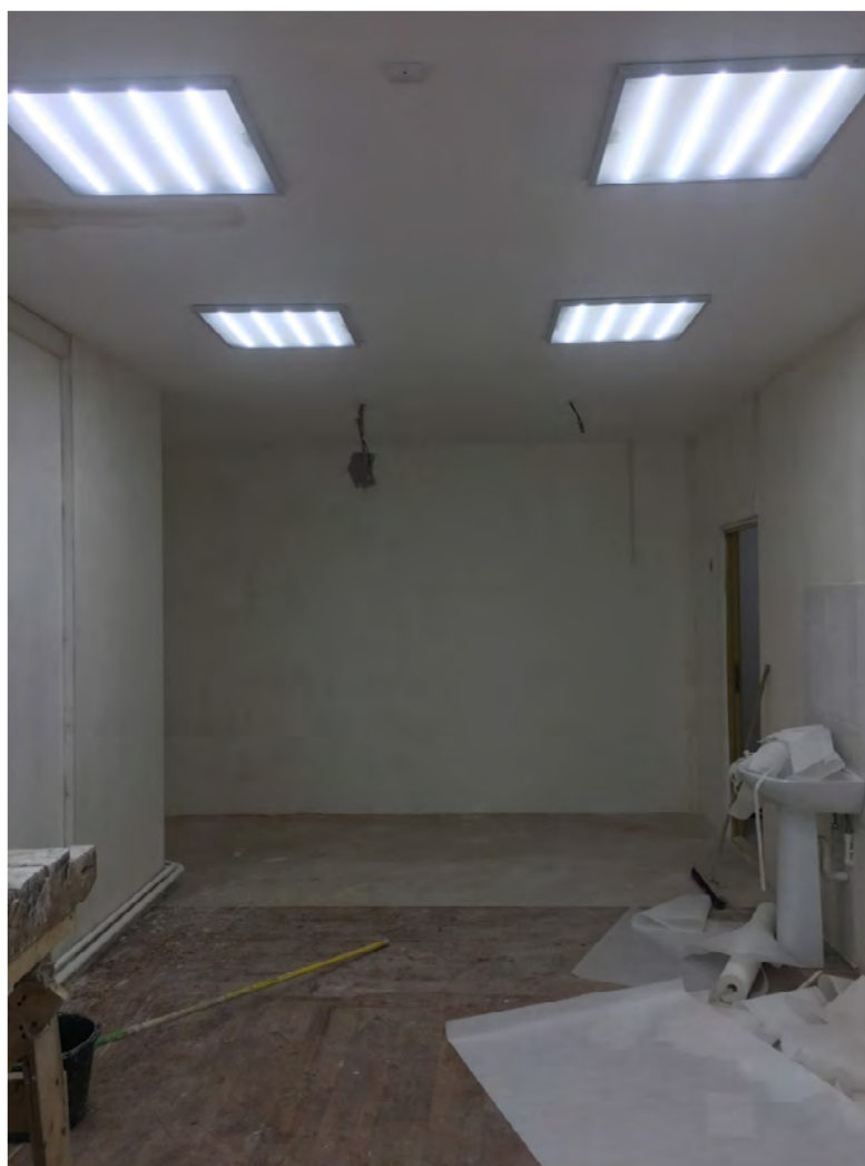
Фото №24. Помещение первого этажа.
