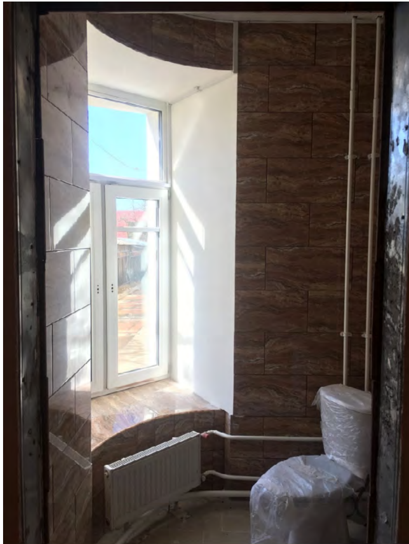
Фото №49. Помещение второго этажа, санузел.
