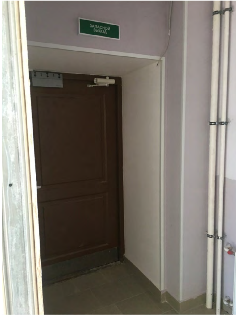
Фото №61. Помещение второго этажа, выход на пожарную лестницу.
