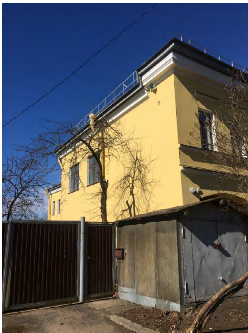
Фото №10. Фрагмент юго-восточного фасада (южный флигель).
