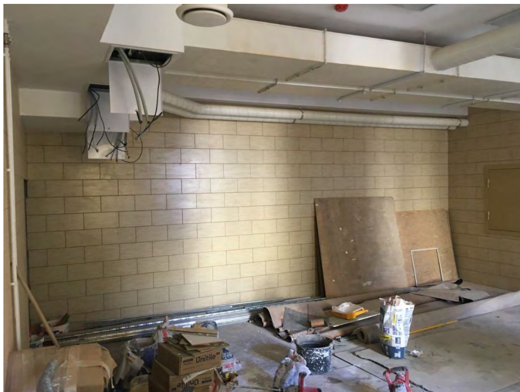
Фото № 43. Помещение первого этажа.
