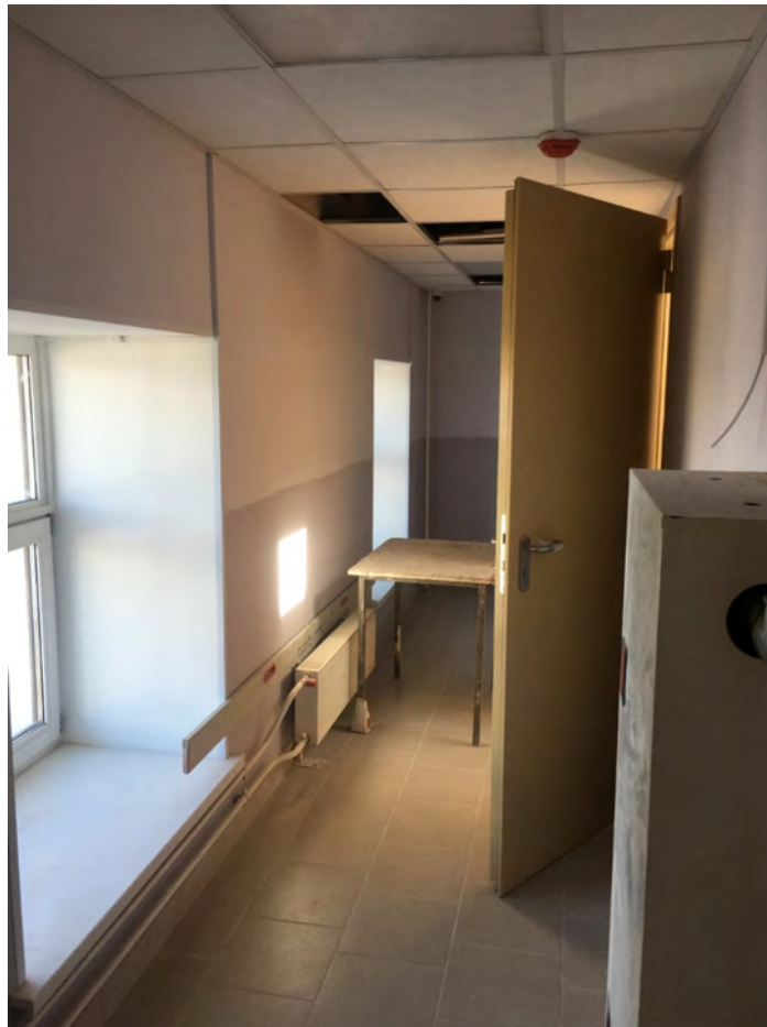
Фото №95. Помещение мансардного этажа, коридор.
