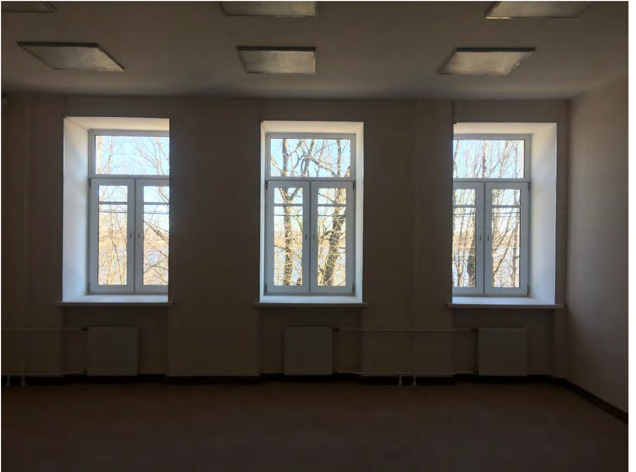
Фото №76. Помещение второго этажа.
