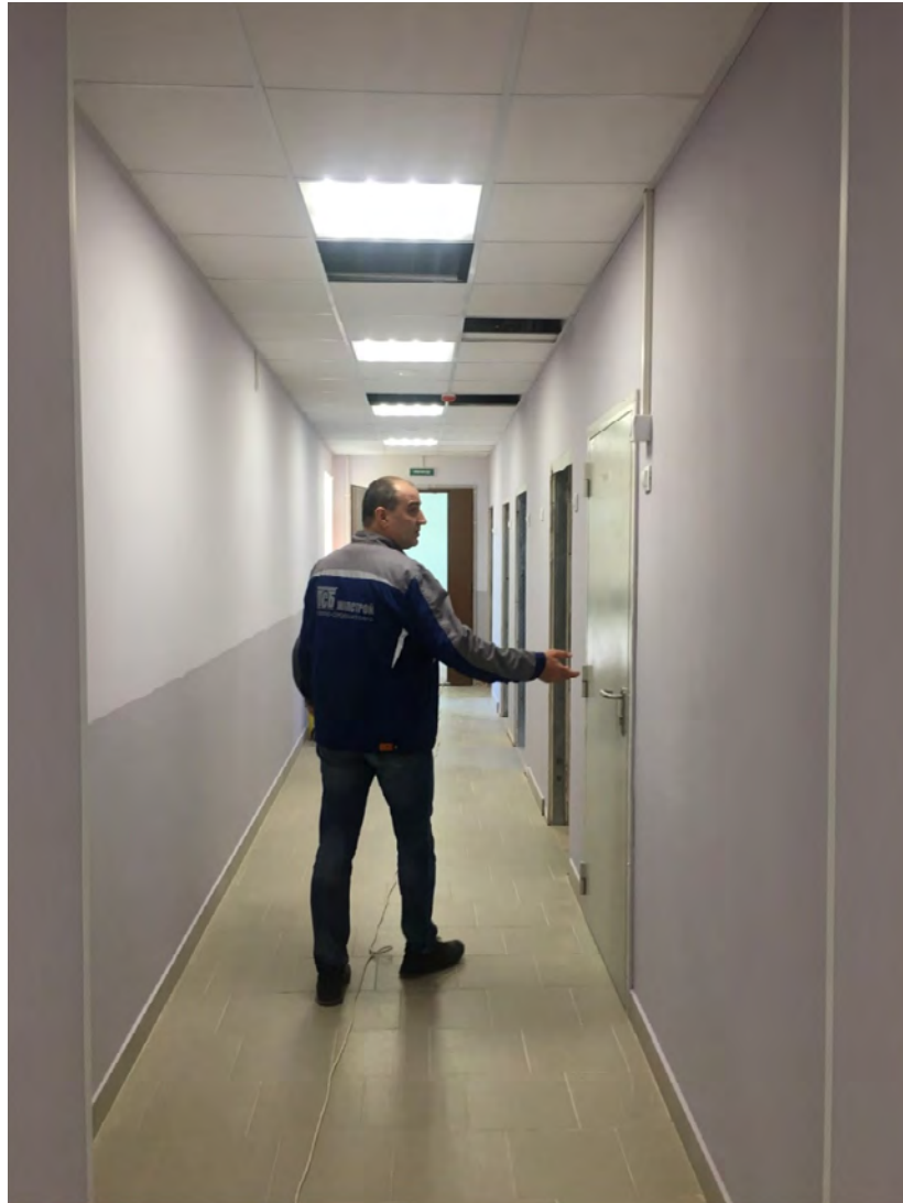
Фото №84. Помещение второго этажа.
