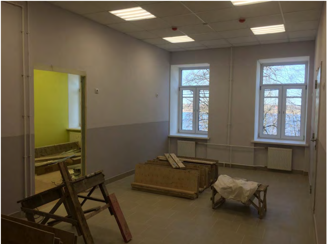
Фото №68. Помещение второго этажа.
