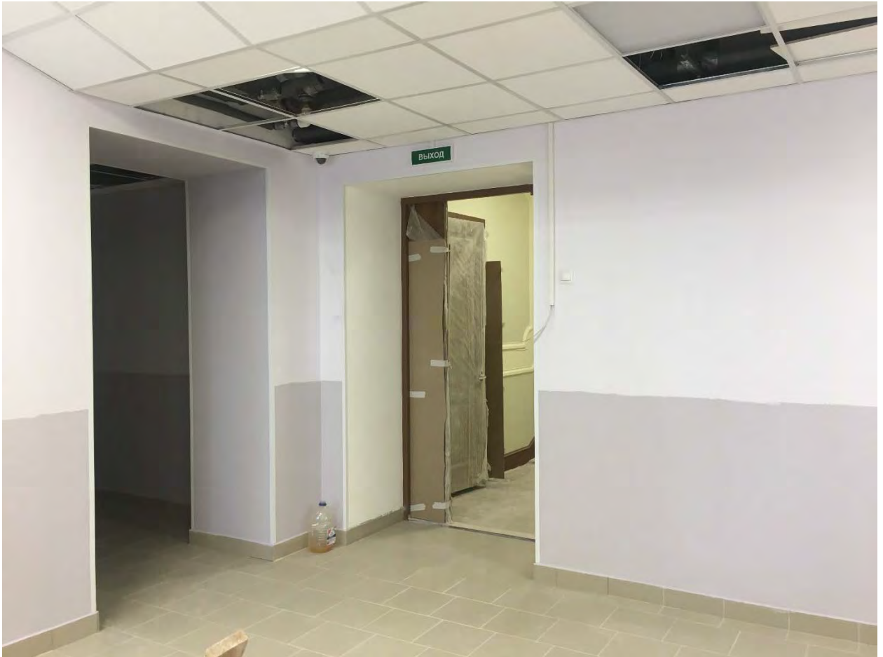
Фото №87. Помещение второго этажа.
