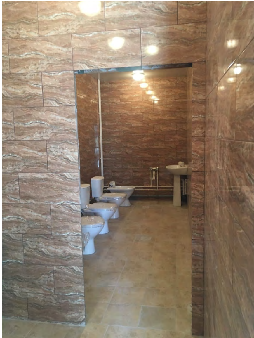
Фото №79. Помещение второго этажа, санузел.
