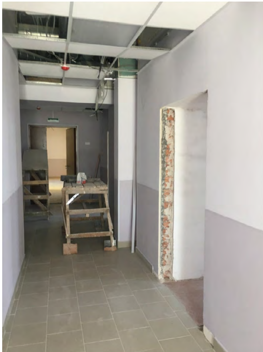
Фото №78. Помещение второго этажа.
