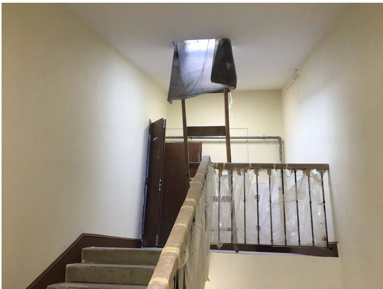
Фото №94. Лестничная клетка, площадка мансардного этажа.
