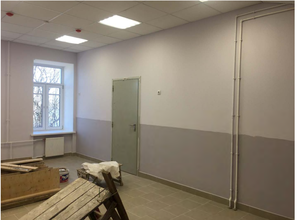
Фото №85. Помещение второго этажа.
