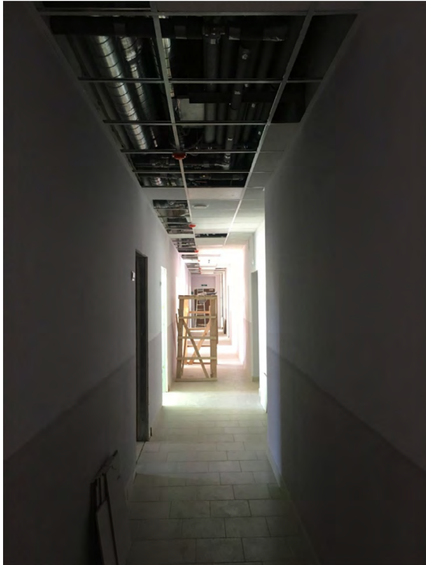
Фото №56. Помещение второго этажа, коридор.
