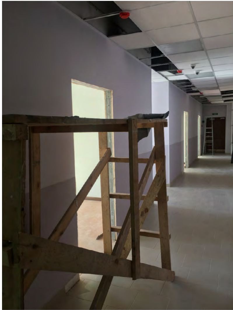
Фото №50. Помещение второго этажа, коридор.
