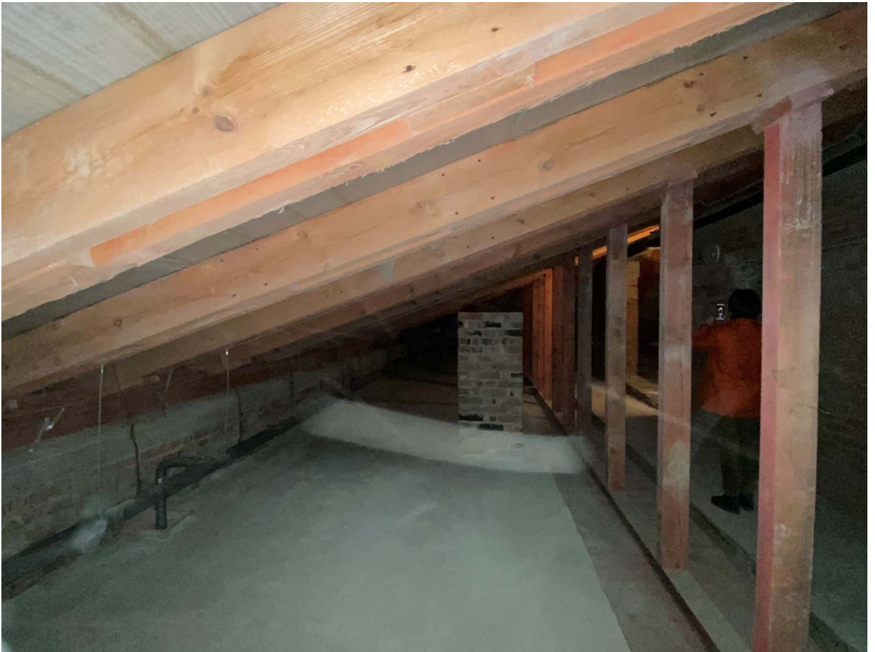
Фото №106. Элементы стропильной системы.
