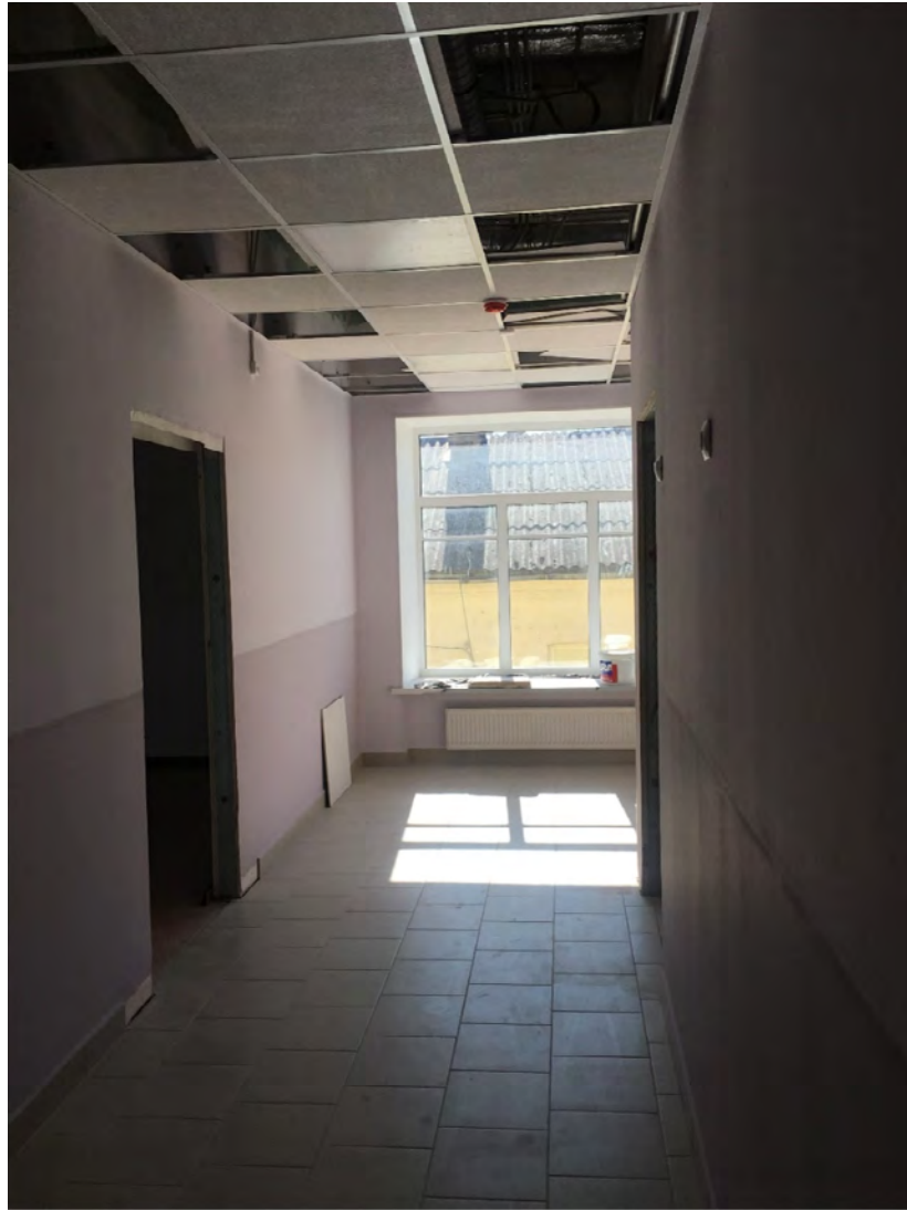
Фото №83. Помещение второго этажа.
