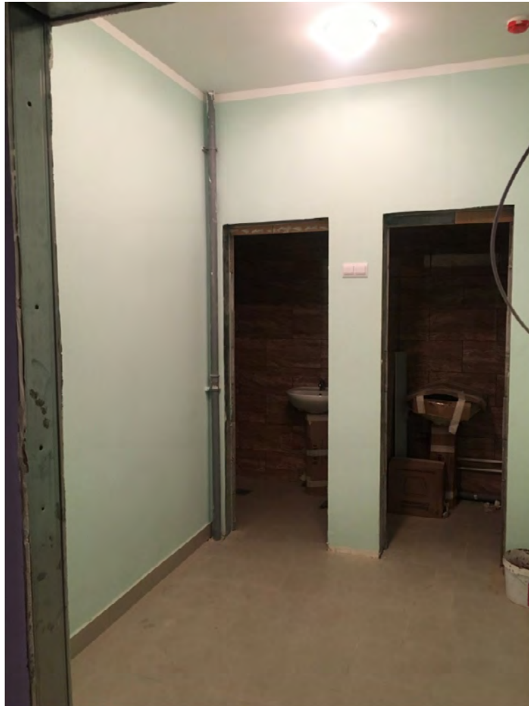
Фото № 38. Помещение первого этажа.
