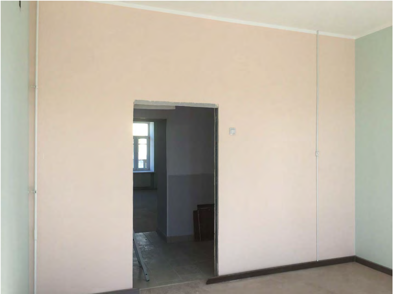
Фото №62. Помещение второго этажа.
