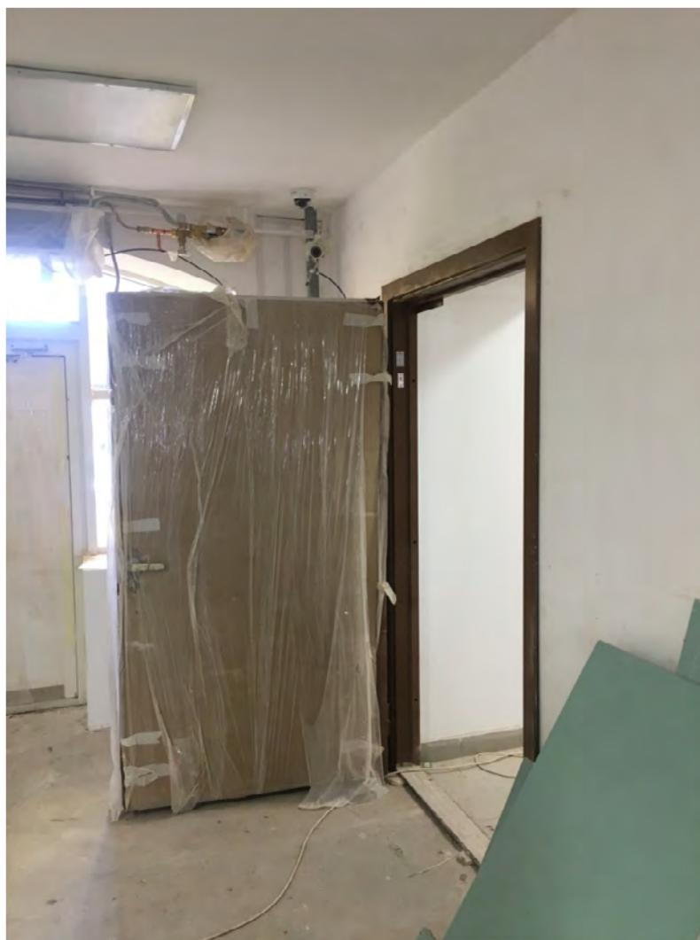
Фото №18. Первый этаж, холл главного входа.
