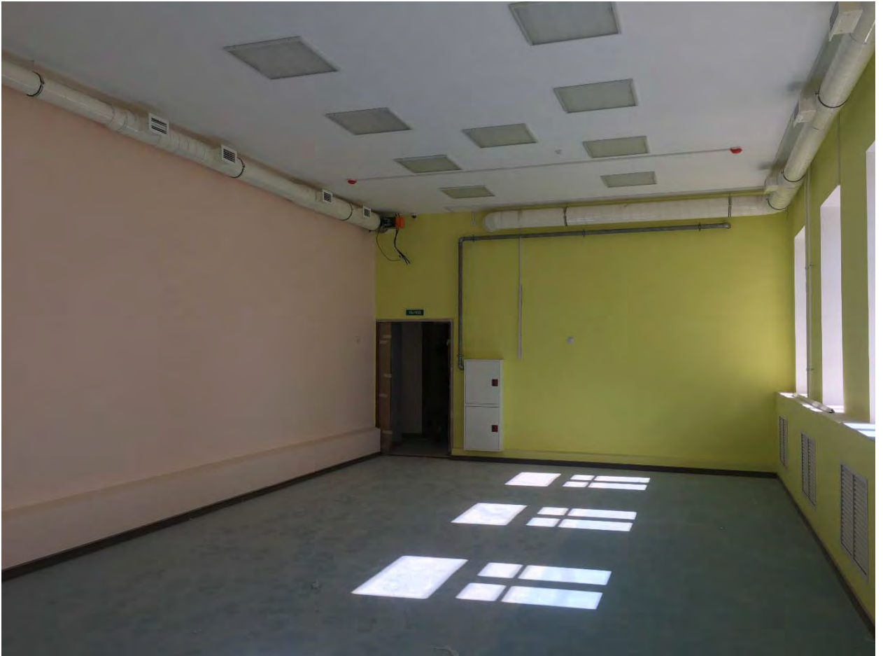
Фото № 48. Помещение первого этажа, объем бывшего воротного проезда.
