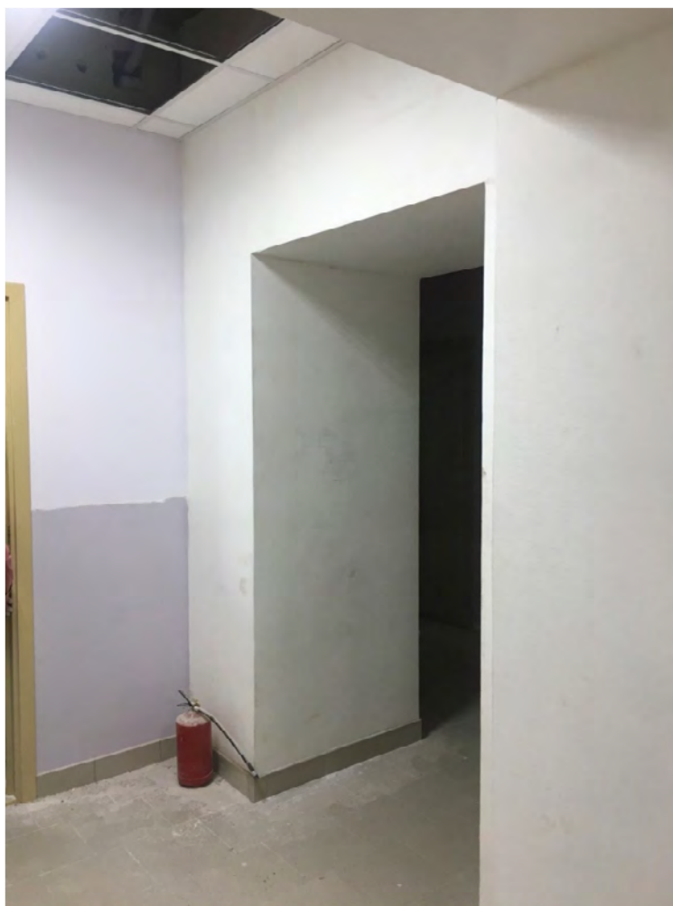
Фото №20. Помещение первого этажа.
