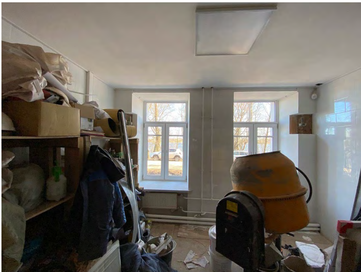
Фото № 47. Помещение первого этажа, объем бывшего воротного проезда.
