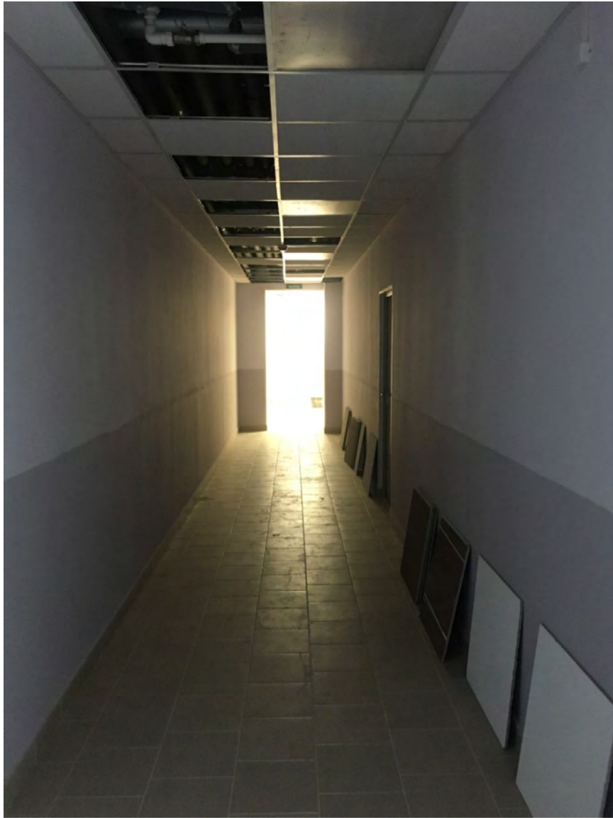
Фото №69. Помещение второго этажа, коридор.
