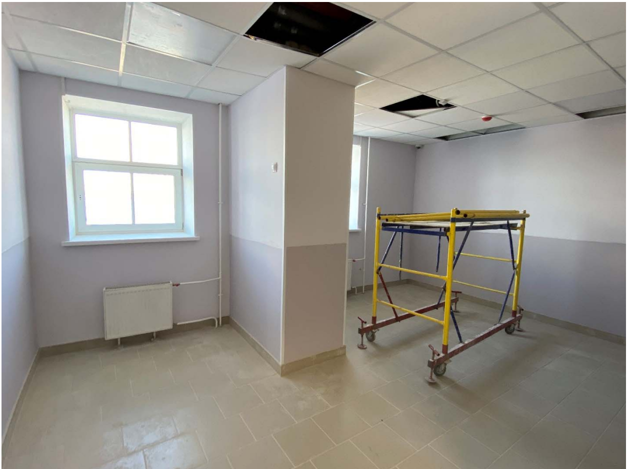
Фото №100. Помещение мансардного этажа.
