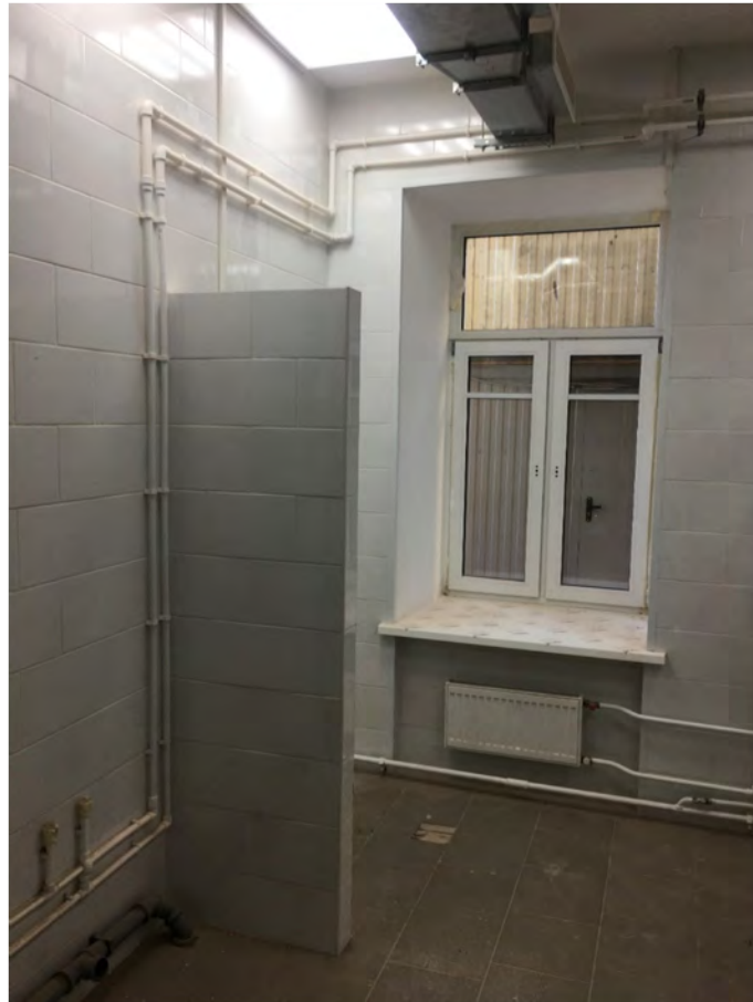
Фото № 41. Помещение первого этажа, санузел.
