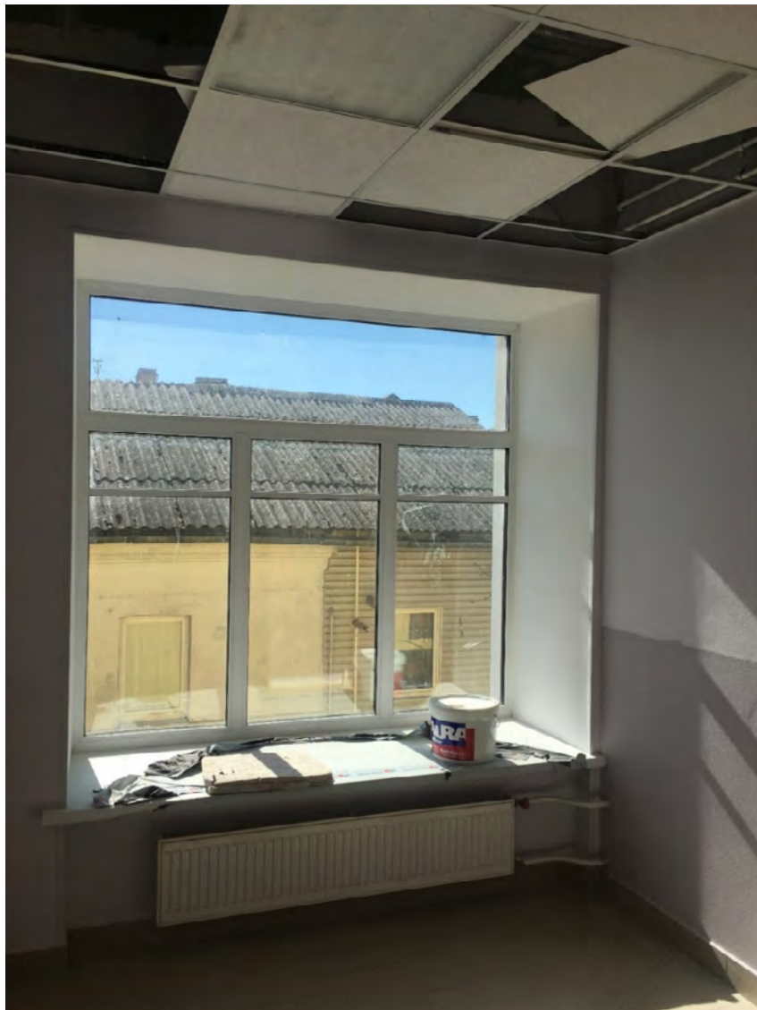
Фото №81. Помещение второго этажа.
