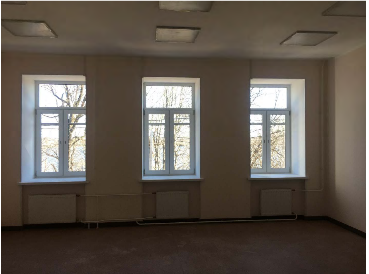
Фото №82. Помещение второго этажа.
