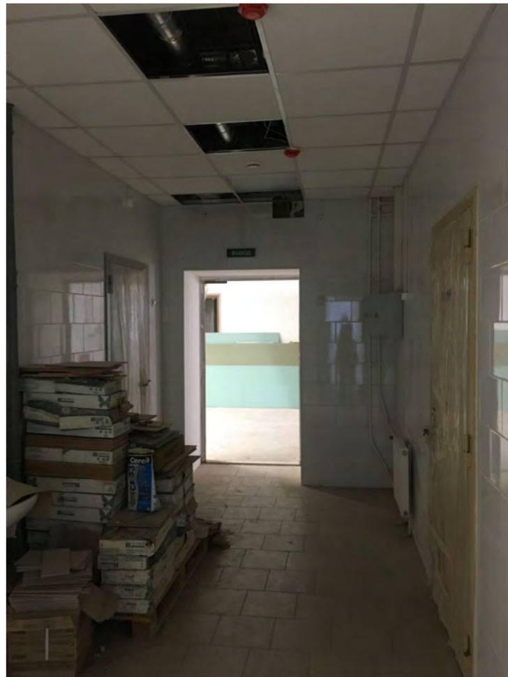
Фото № 36. Помещение первого этажа.
