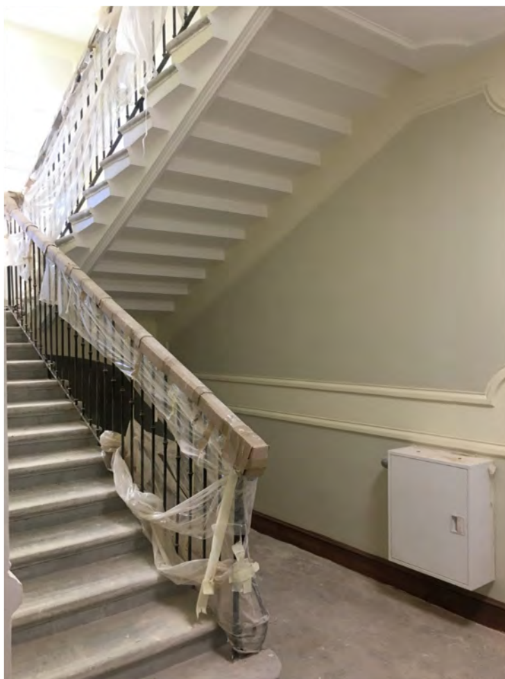
Фото №28. Первый этаж, лестничная клетка.
