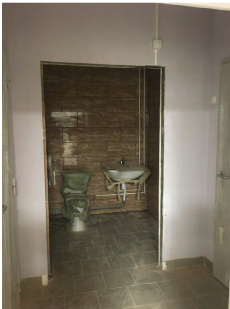
Фото №16. Помещение первого этажа.
