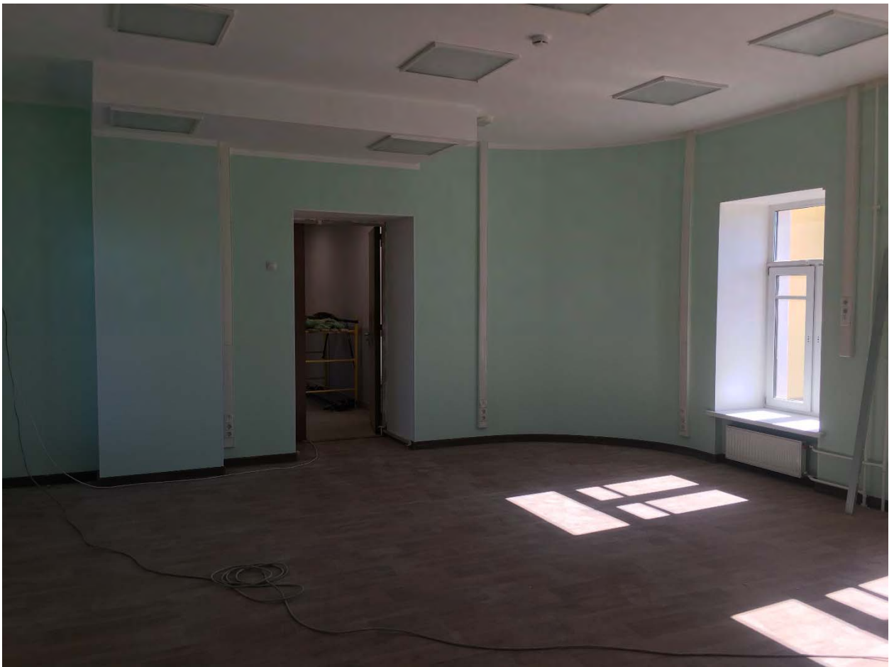
Фото №88. Помещение второго этажа.
