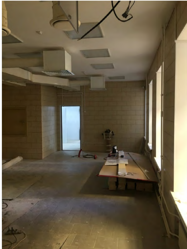
Фото № 44. Помещение первого этажа.
