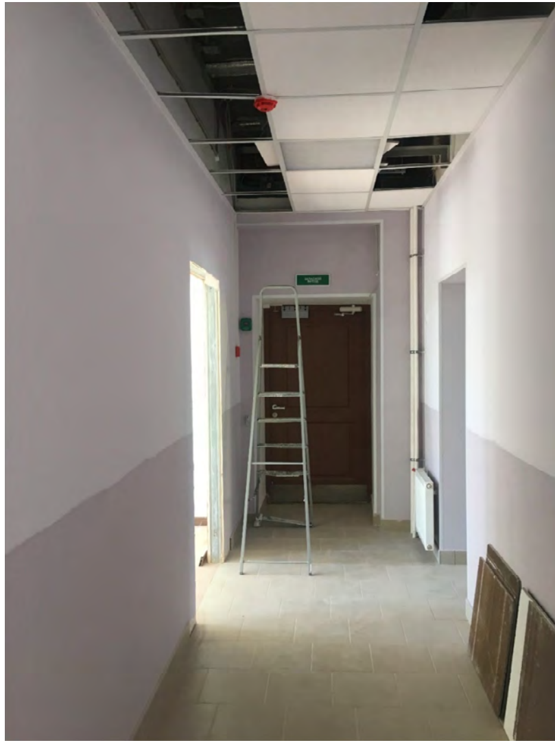
Фото №64. Помещение второго этажа, коридор.
