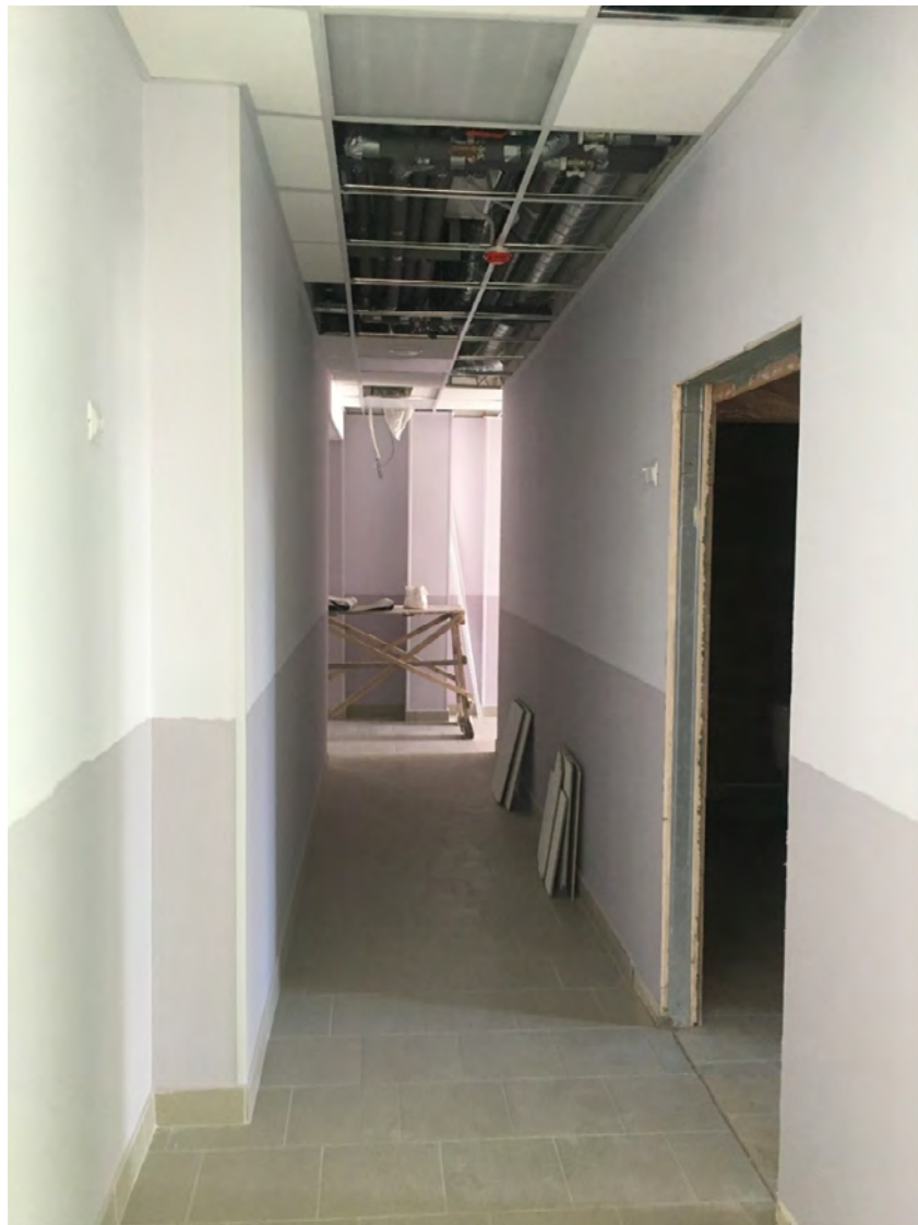
Фото №52. Помещение второго этажа, коридор.
