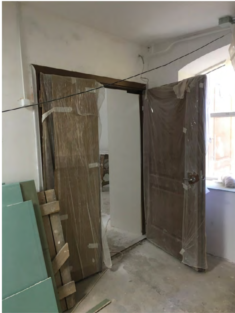
Фото № 46. Помещение первого этажа.
