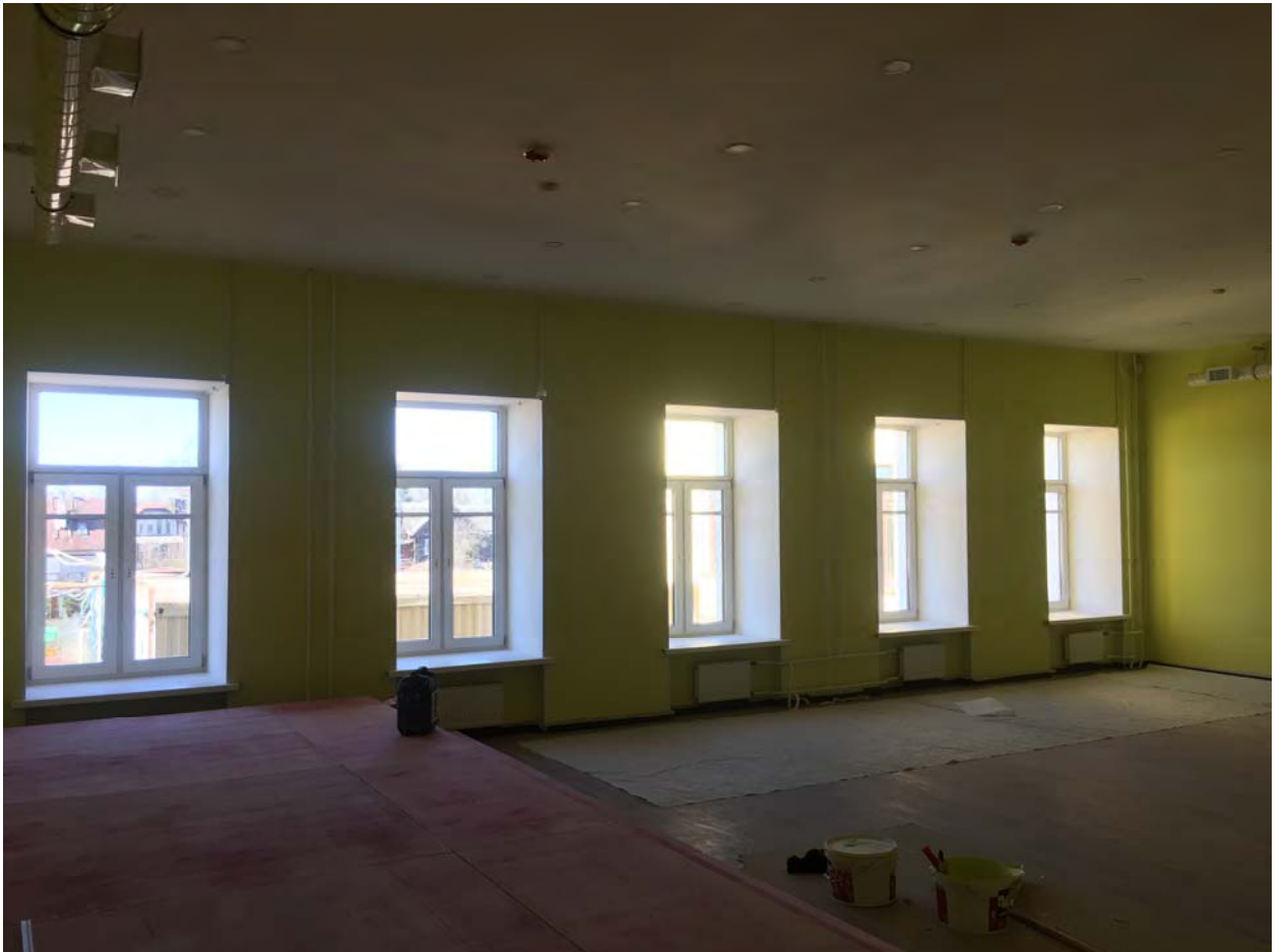
Фото №72. Помещение второго этажа.
