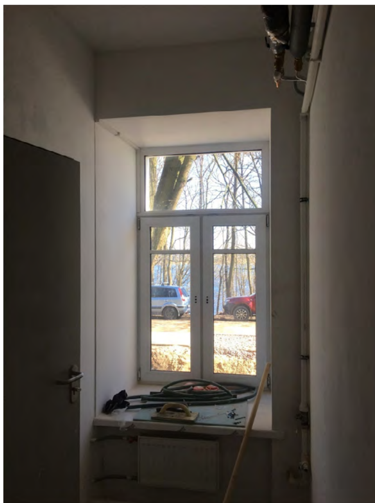
Фото №14. Помещение первого этажа, оконный проем.
