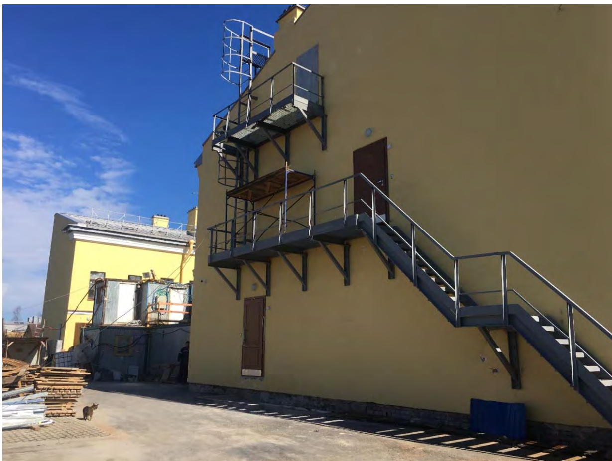
Фото №6. Юго-западный фасад здания, пожарная лестница (южный флигель).
