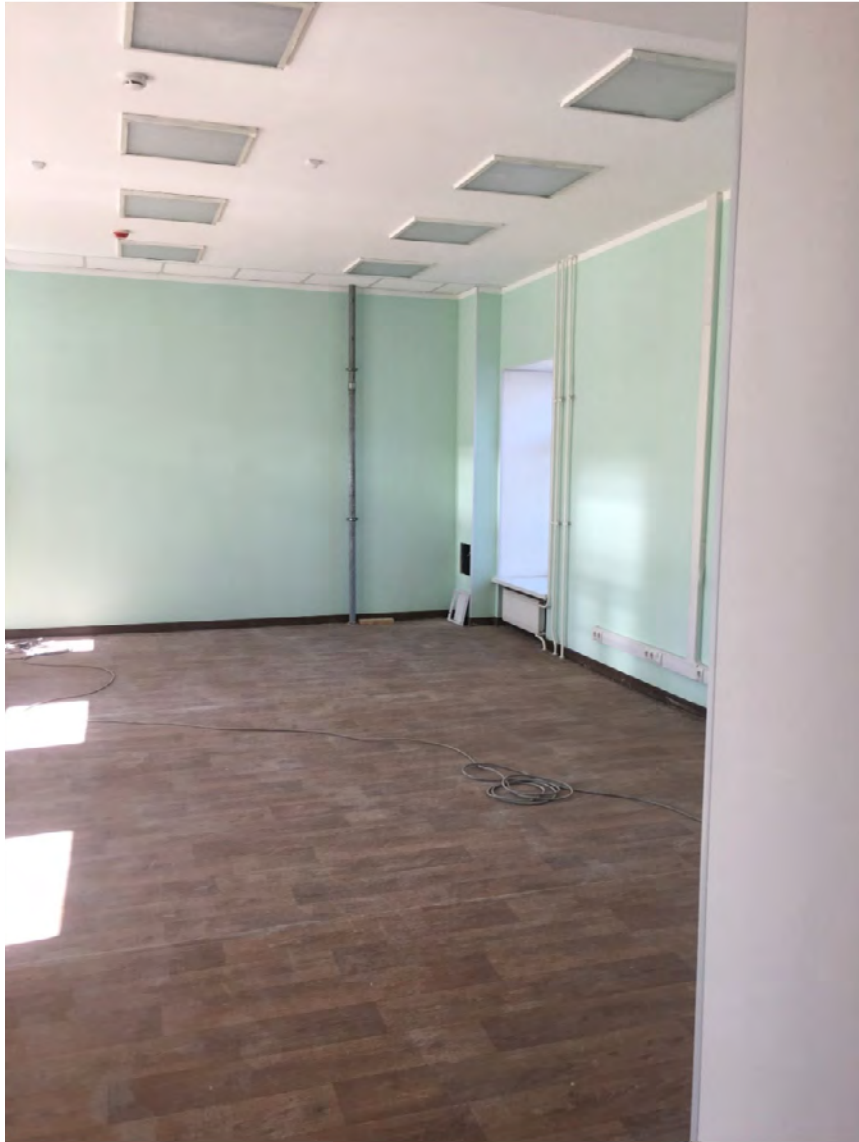
Фото №89. Помещение второго этажа.
