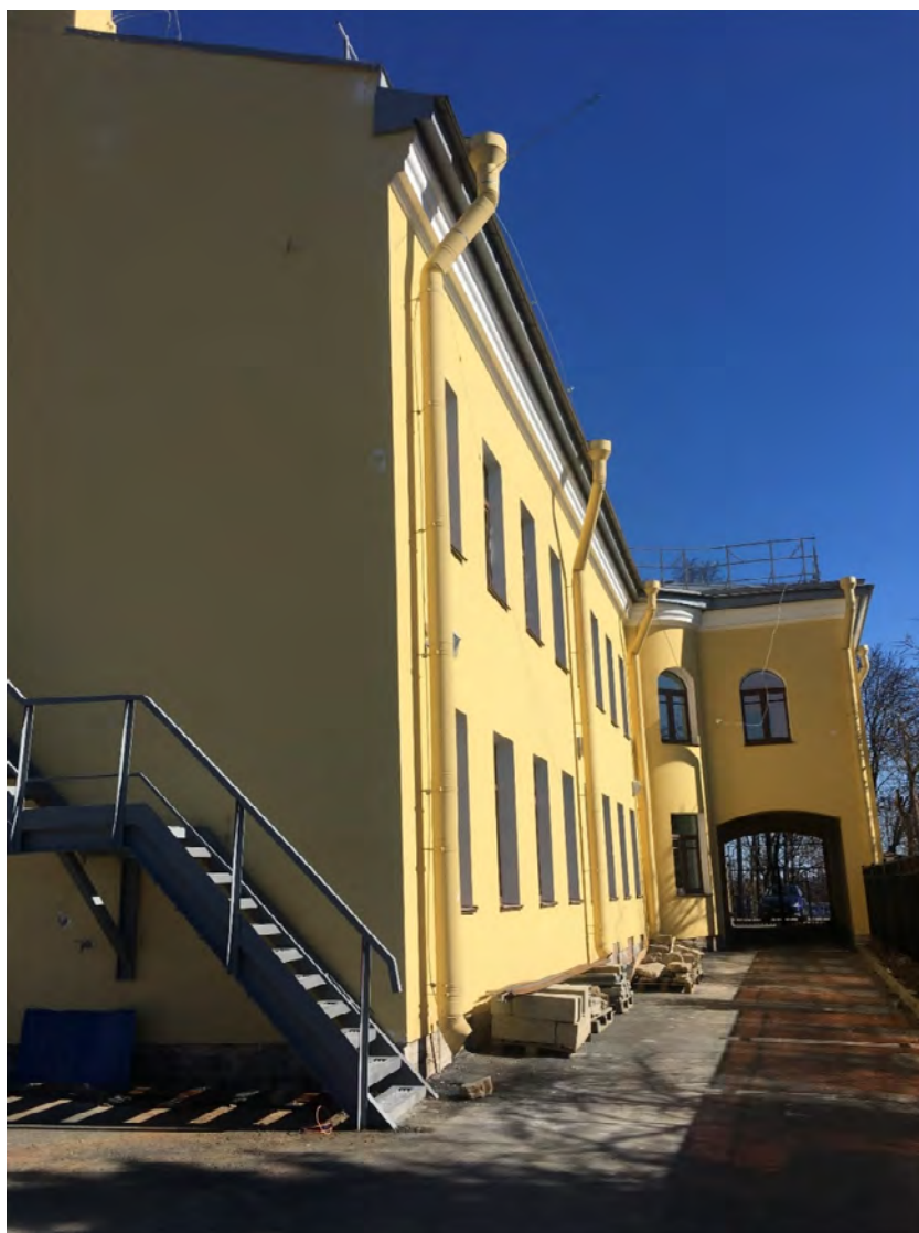
Фото №5. Юго-восточный фасад (южный флигель).
