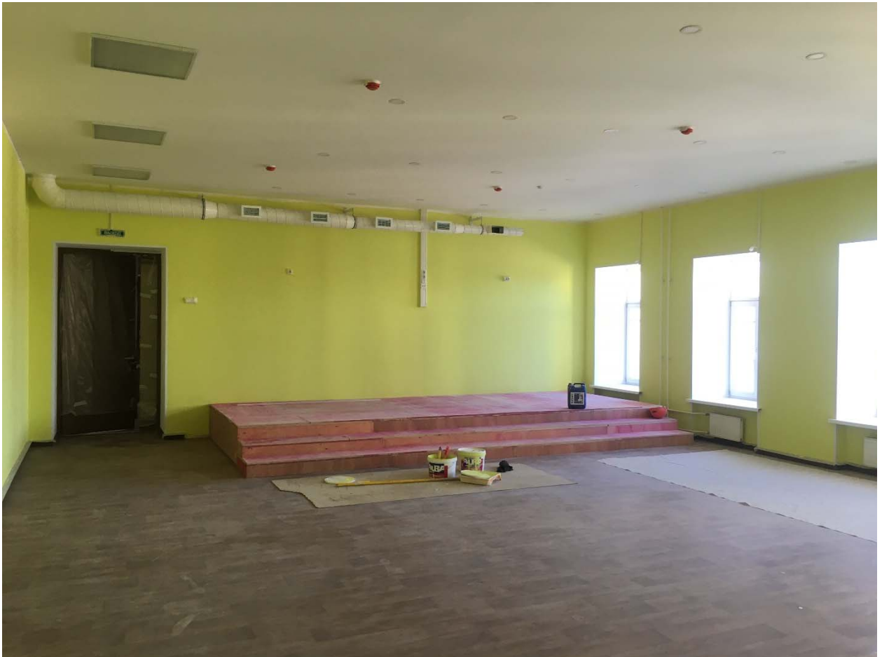
Фото №71. Помещение второго этажа.
