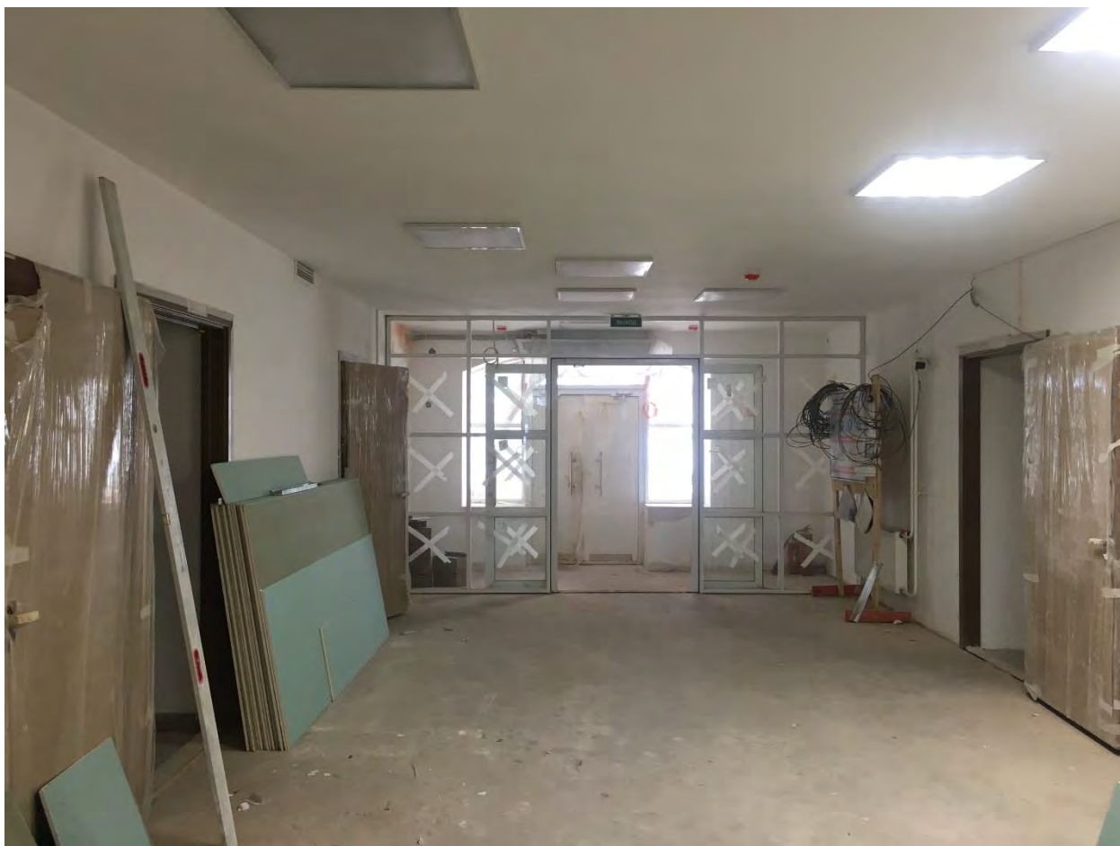
Фото №12. Первый этаж, холл главного входа.
