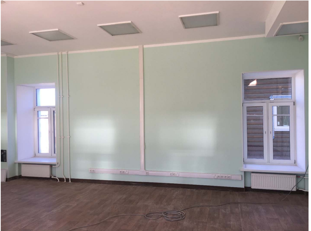
Фото №91. Помещение второго этажа.
