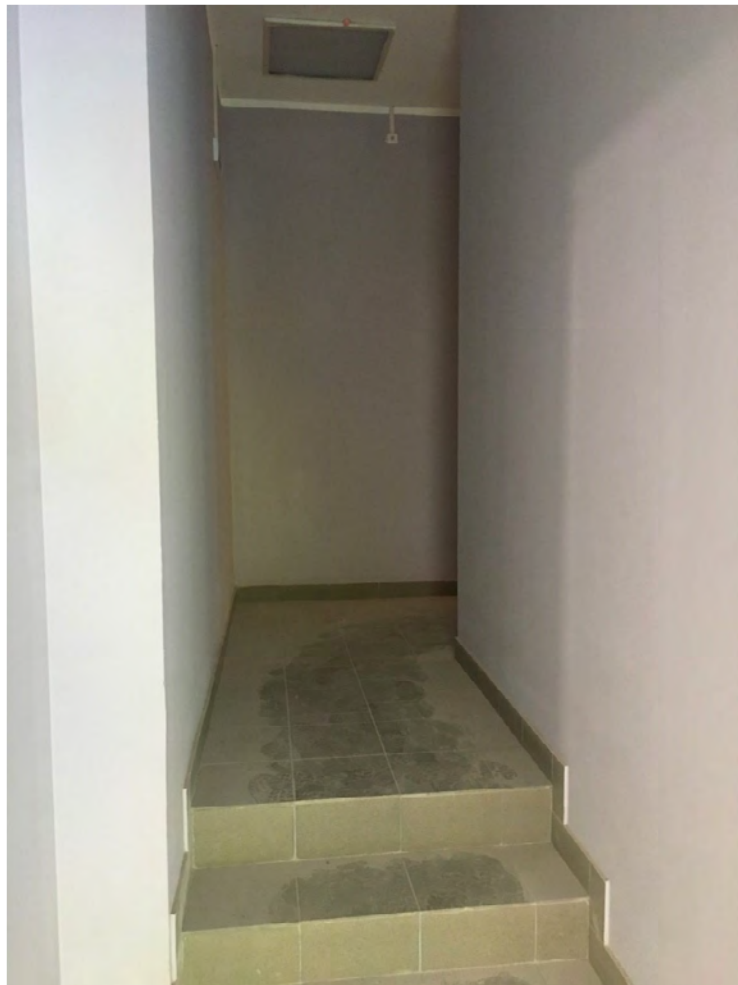
Фото № 39. Помещение первого этажа.
