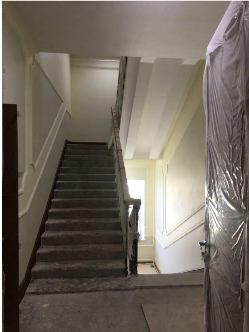
Фото №86. Лестничная клетка.
