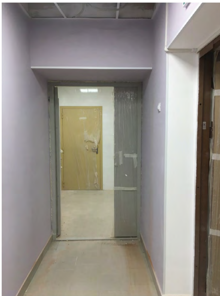
Фото № 31. Помещение первого этажа.
