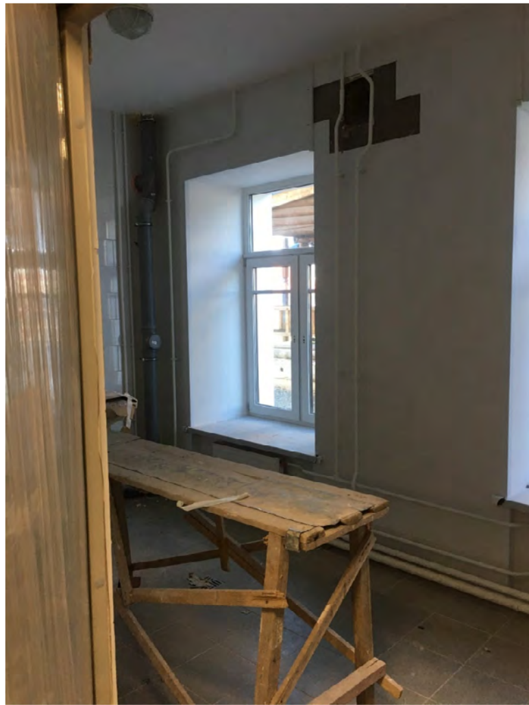
Фото № 34. Помещение первого этажа.
