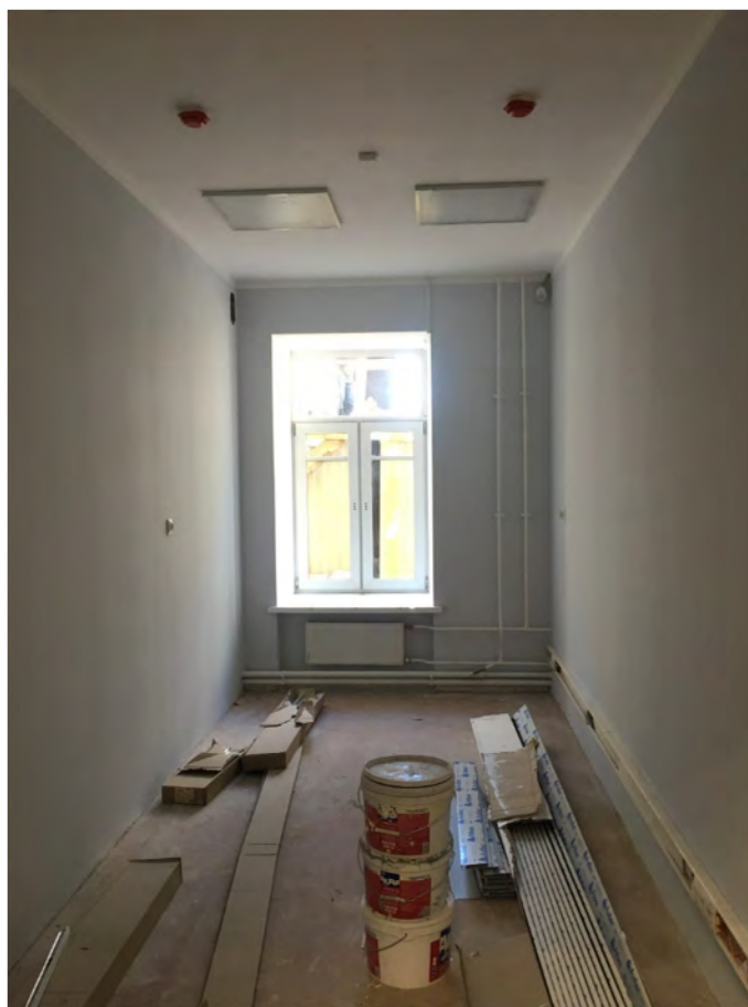
Фото №22. Помещение первого этажа.
