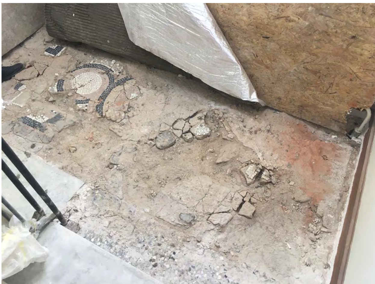
Фото №93. Лестничная клетка, междуэтажная площадка, фрагменты исторической мозаики.
