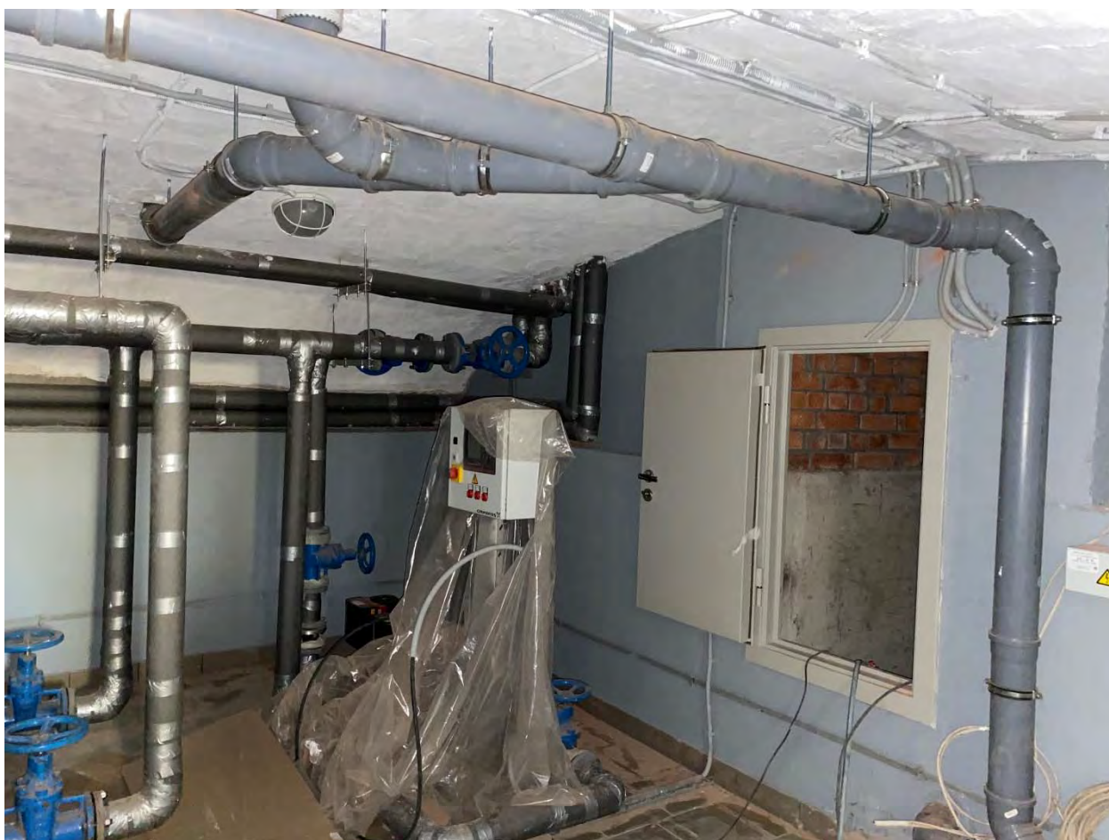
Фото №108. Подвал. Под северным дворовым флигелем, вход в подполье. Вход в подвал расположен со стороны юго-западного фасада северного флигеля.
