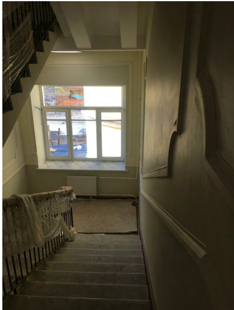
Фото №92. Лестничная клетка, междуэтажная площадка.
