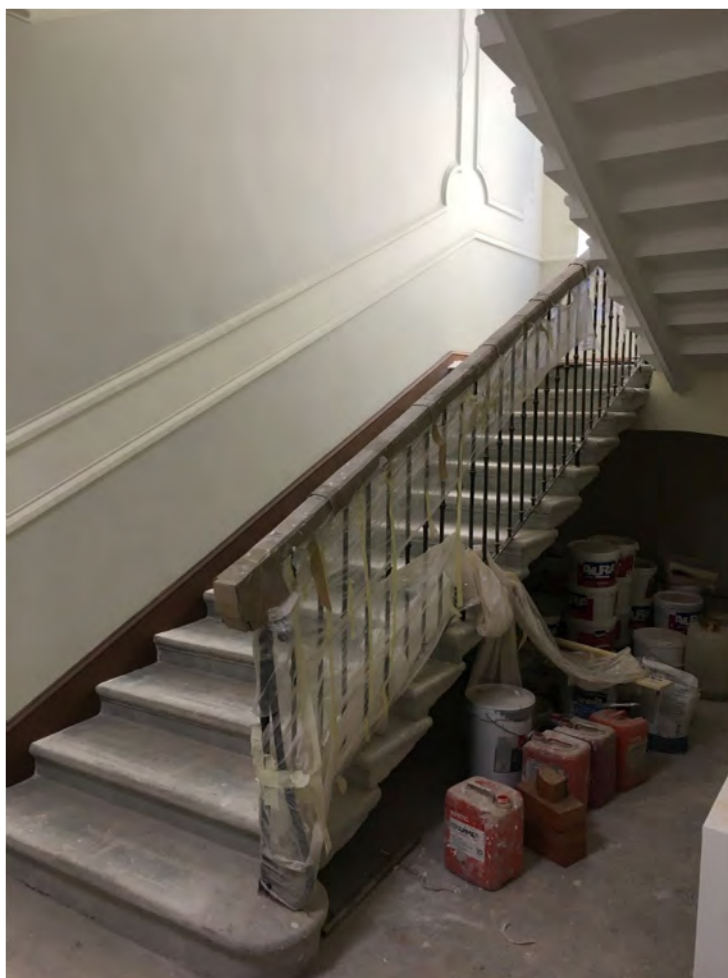
Фото № 29. Первый этаж, лестничная клетка.
