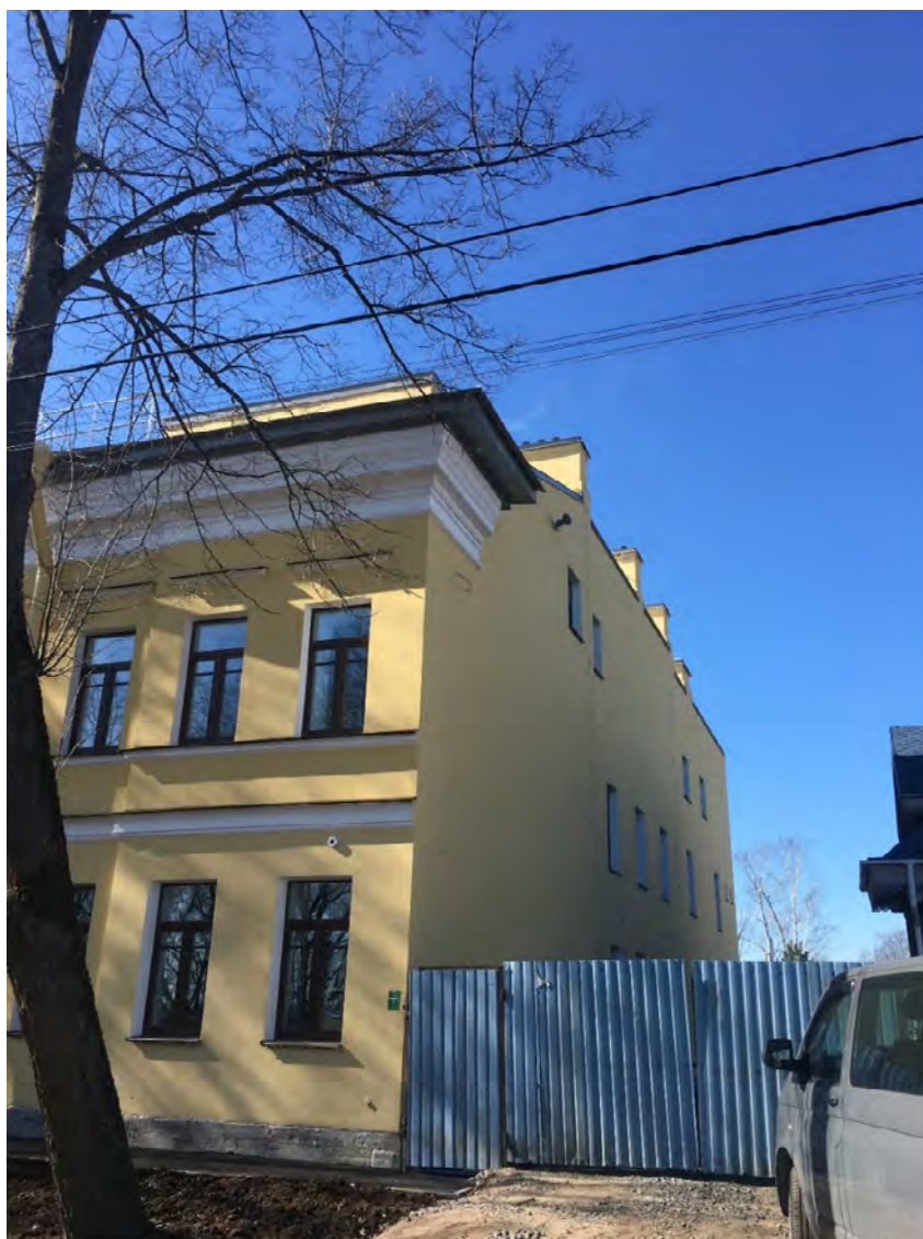
Фото №11. Фрагмент северо-западного фасада (северный флигель).
