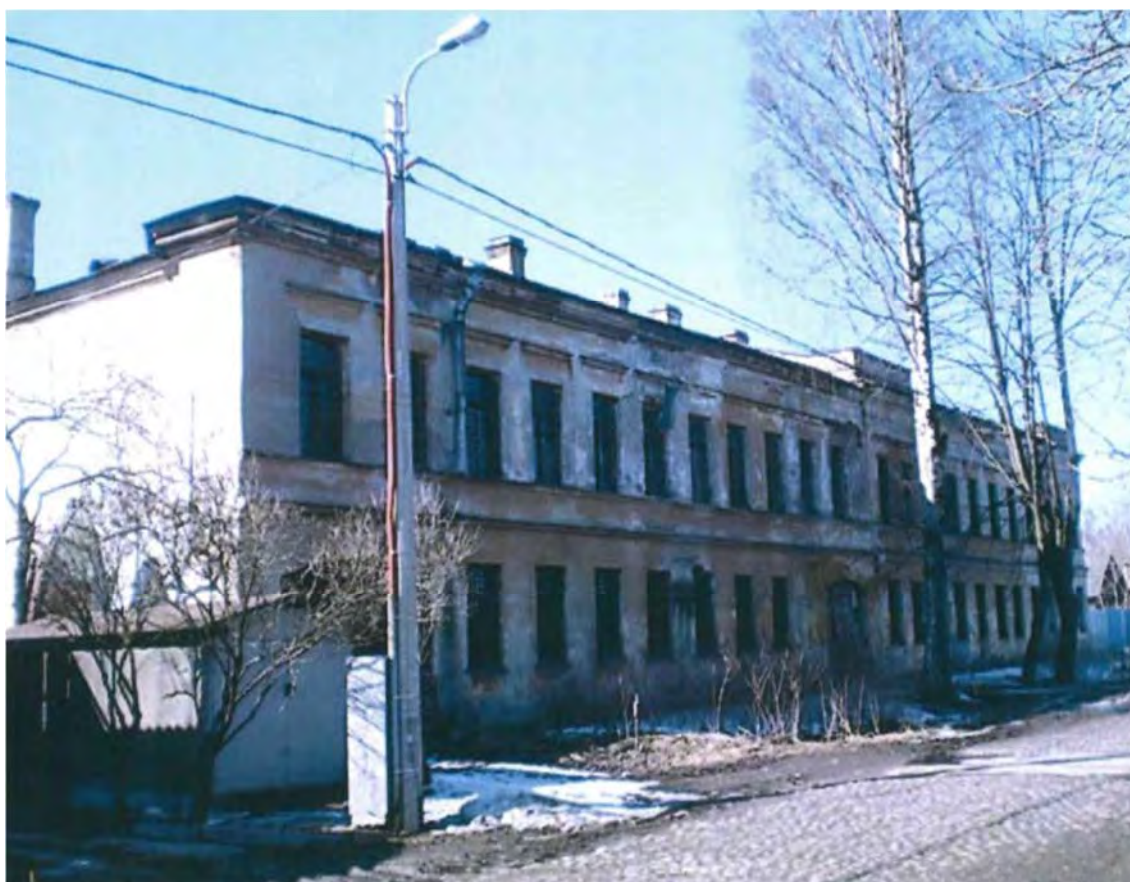
Илл. 14. Санкт-Петербург, Колпинский район, пос. Усть-Ижора, Шлиссельбургский проспект, д. 187. 2012 г. Архив КГИОП.
