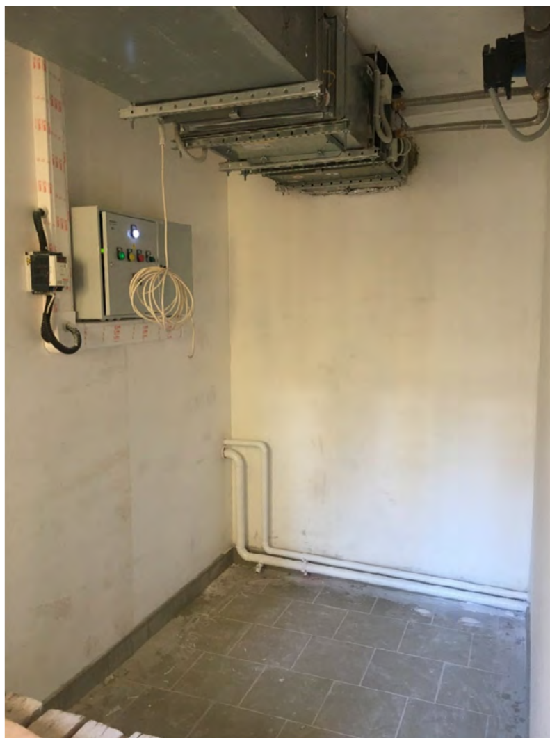
Фото № 33. Помещение первого этажа.
