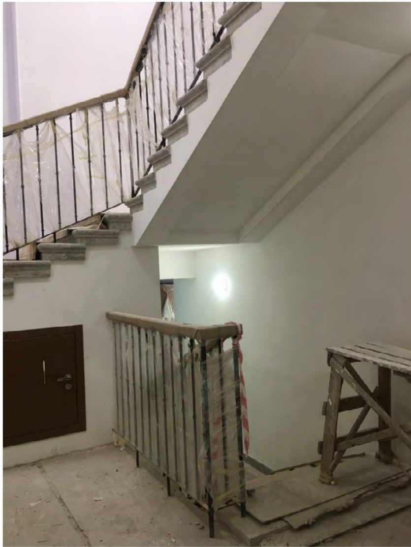
Фото № 45. Помещение первого этажа.
