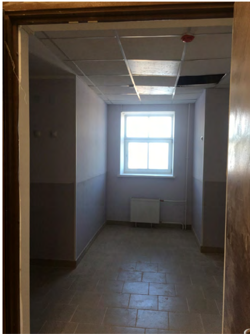
Фото №99. Помещение мансардного этажа.
