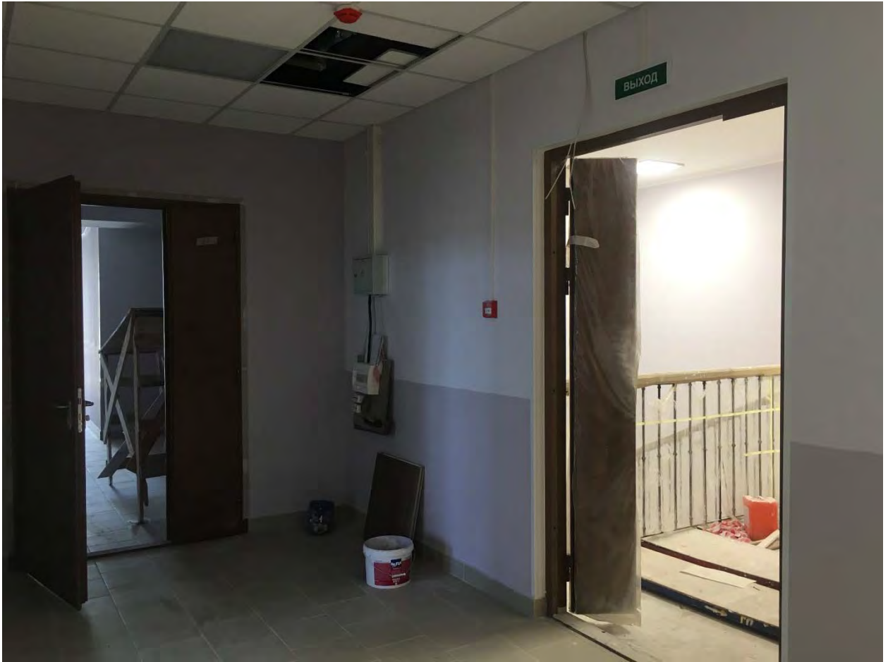
Фото №75. Помещение второго этажа.
