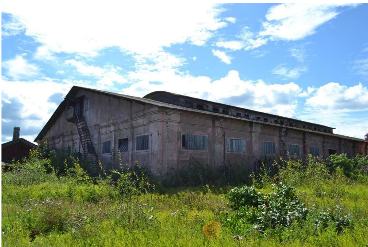
Фото 4. Северо-восточный и северо-западный фасады эллинга. Вид с северо-востока
