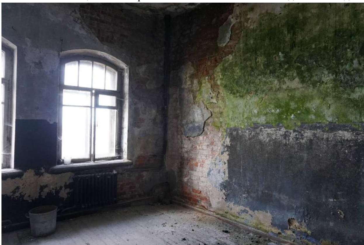
Фото 51. Помещения в северной части основного объема. Вид с юго-востока
