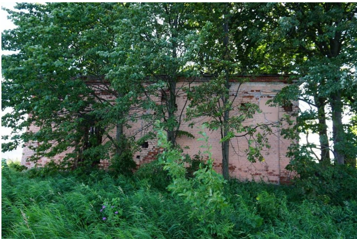
Фото 1. Вид на северо-западный фасад с северо-запада
