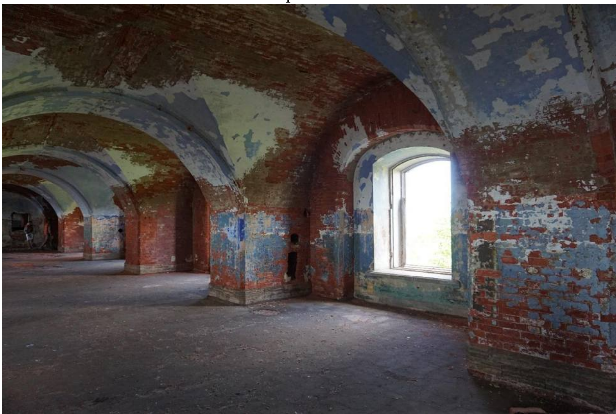
Фото 31. Помещения в южной части основного объема. Вид с юго-запада
