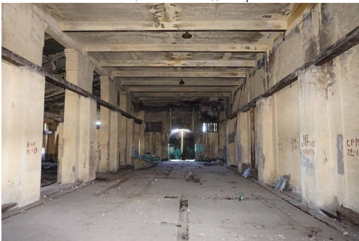
Фото 8. Помещения эллинга. Вид с юго-запада
