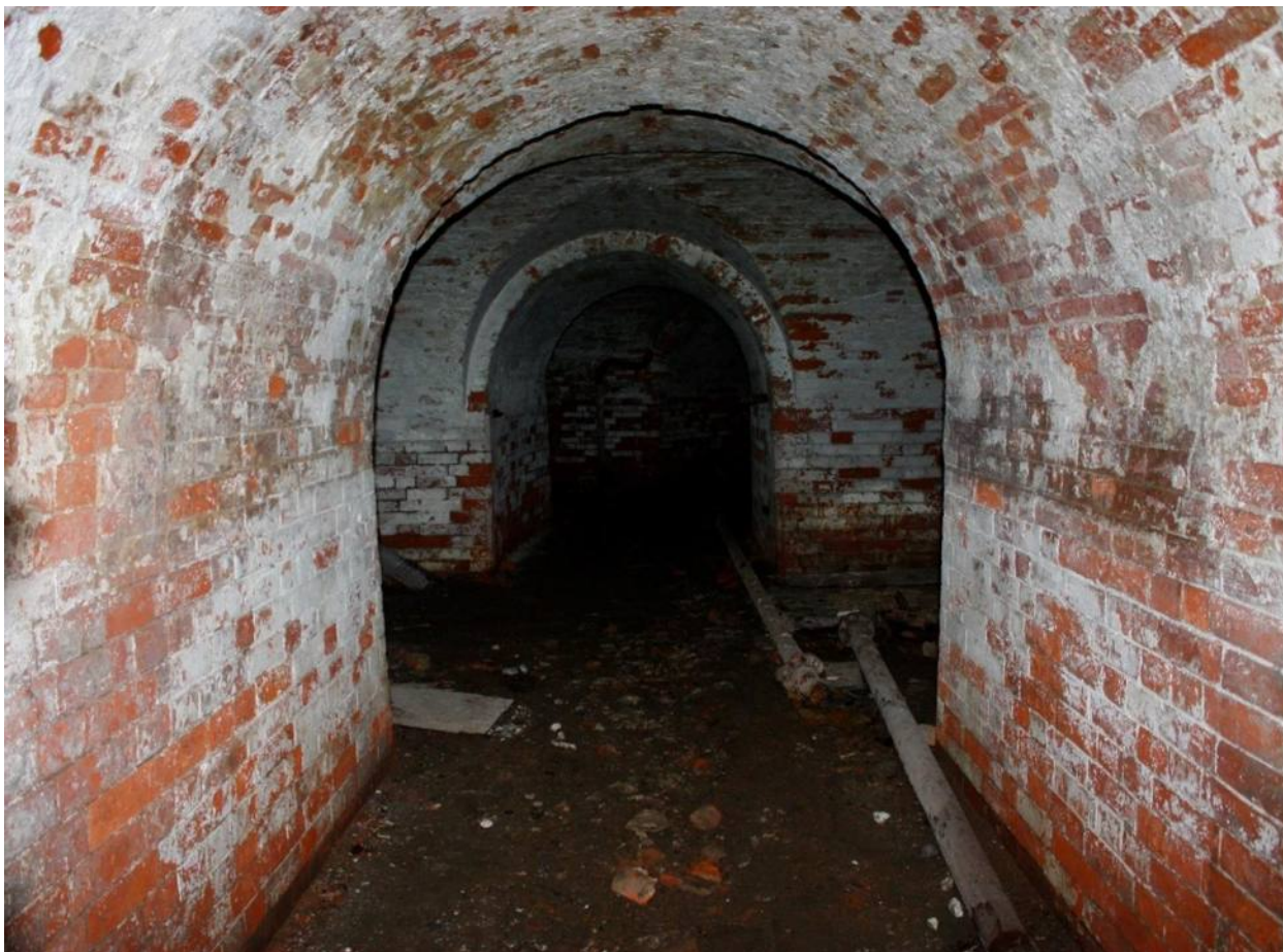
Фото 18. Подвал южного ризалита. Вид с юго-востока
