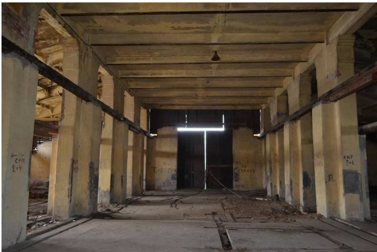
Фото 7. Помещения эллинга. Вид с северо-востока
