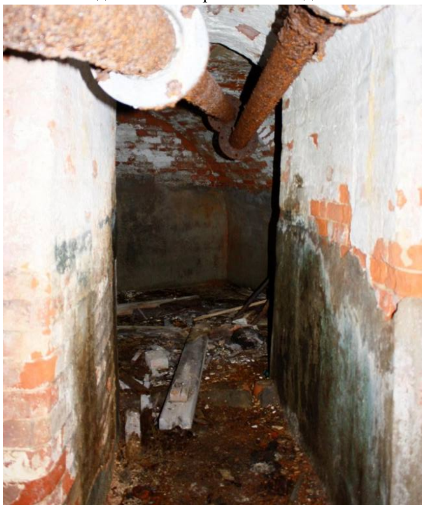
Фото 21. Подвал южного ризалита. Вид с юго-запада
