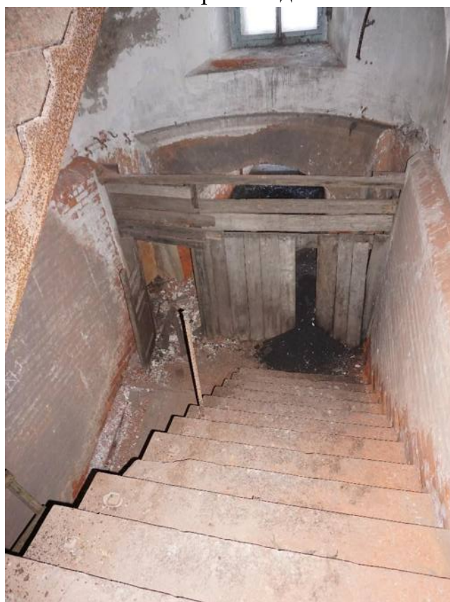
Фото 37. Лестница в помещения подвала в объеме центрального ризалита. Вид с северо-запада
