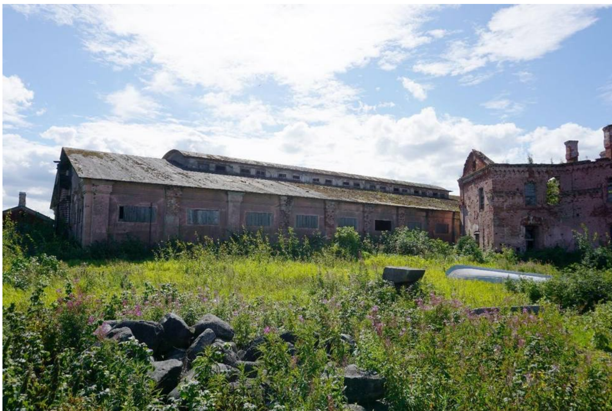
Фото 5. Общий вид на эллинг и восьмигранную башню с севера
