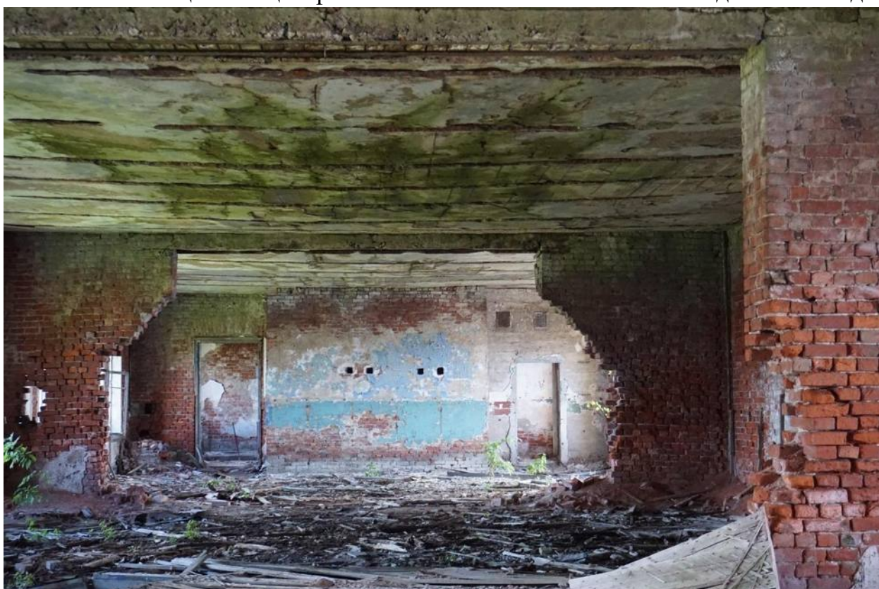
Фото 47. Помещения в южной части основного объема. Вид с северо-востока
