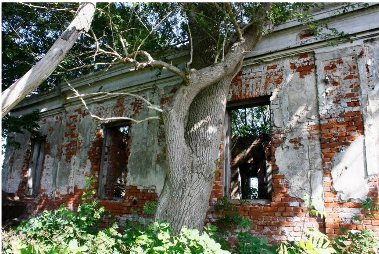
Фото 5. Юго-западный фасад. Вид с юго-запада
