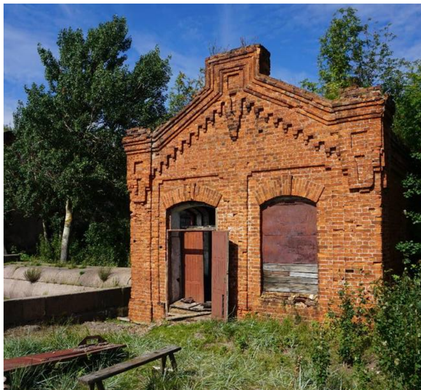
Фото 3. Юго-западный фасад западного ризалита цейхгауза. Вид с юго-востока
