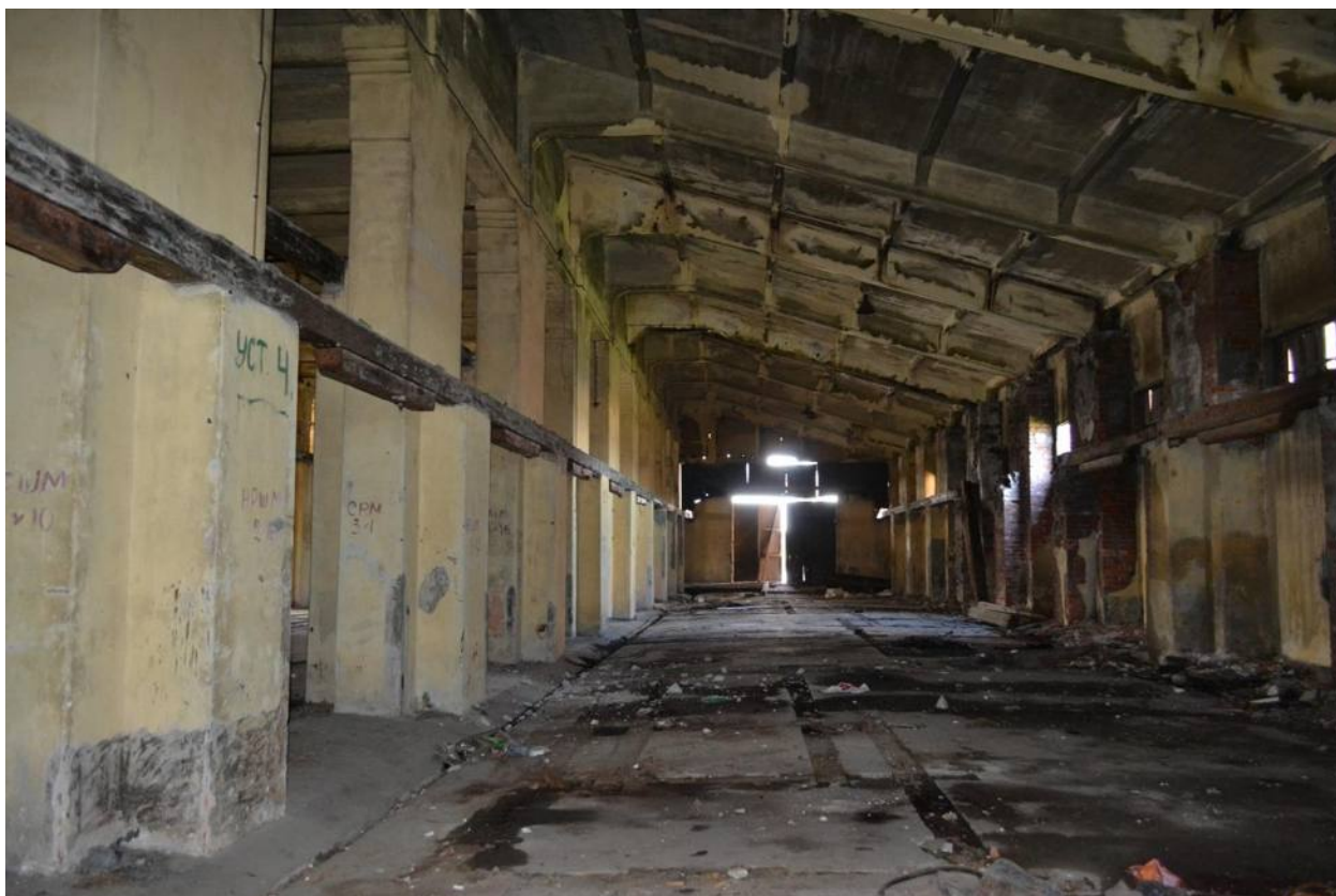
Фото 9. Помещения эллинга. Вид с северо-востока
