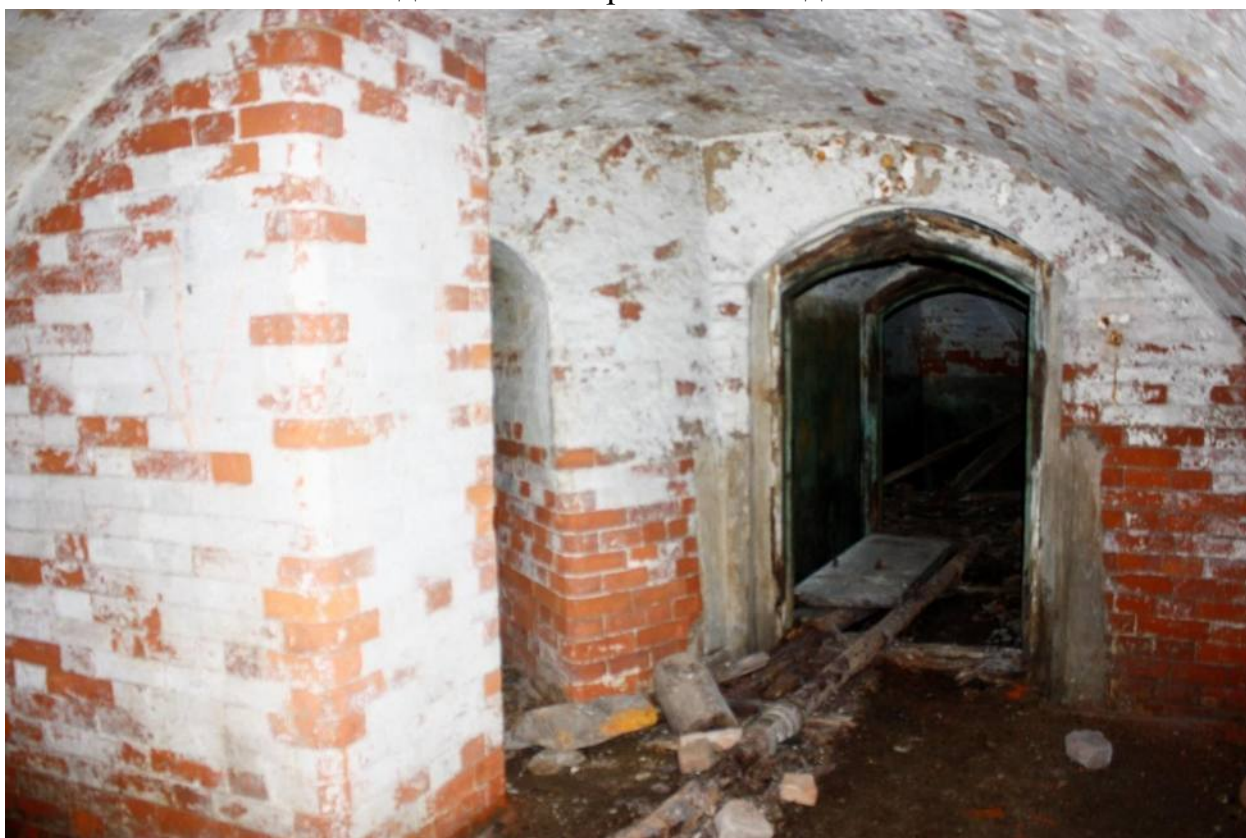
Фото 19. Подвал южного ризалита. Вид с юго-востока
