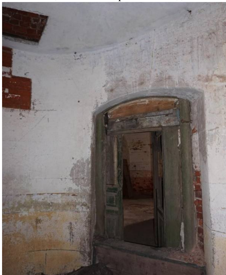
Фото 25. Помещения южного ризалита. Вид с юго-запада
