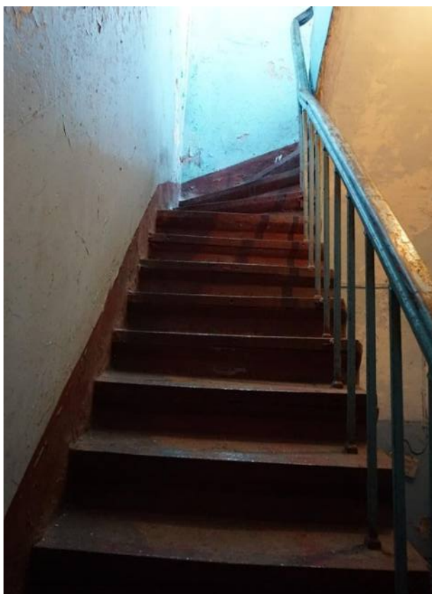
Фото 40. Лестница на второй этаж в северной части основного объема. Вид с северо-востока
