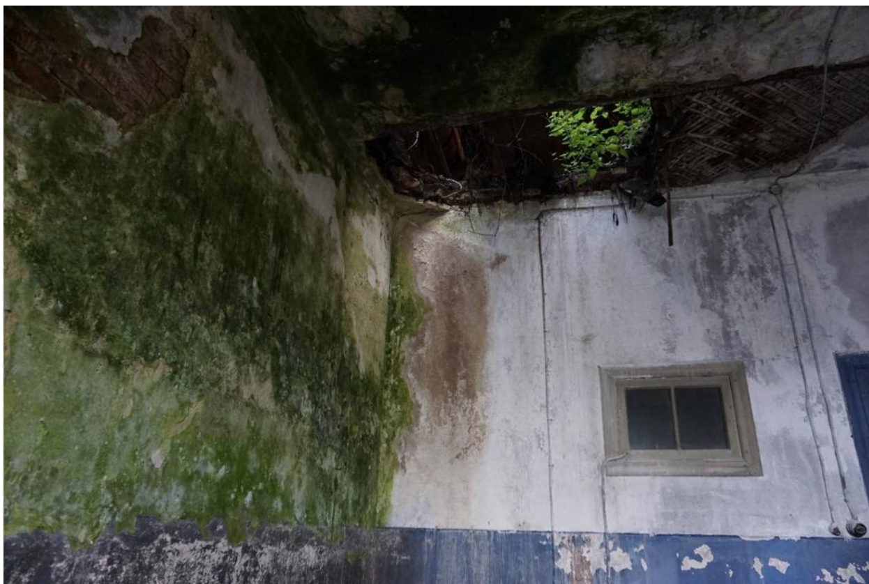
Фото 52. Помещения в северной части основного объема. Вид с юго-запада
