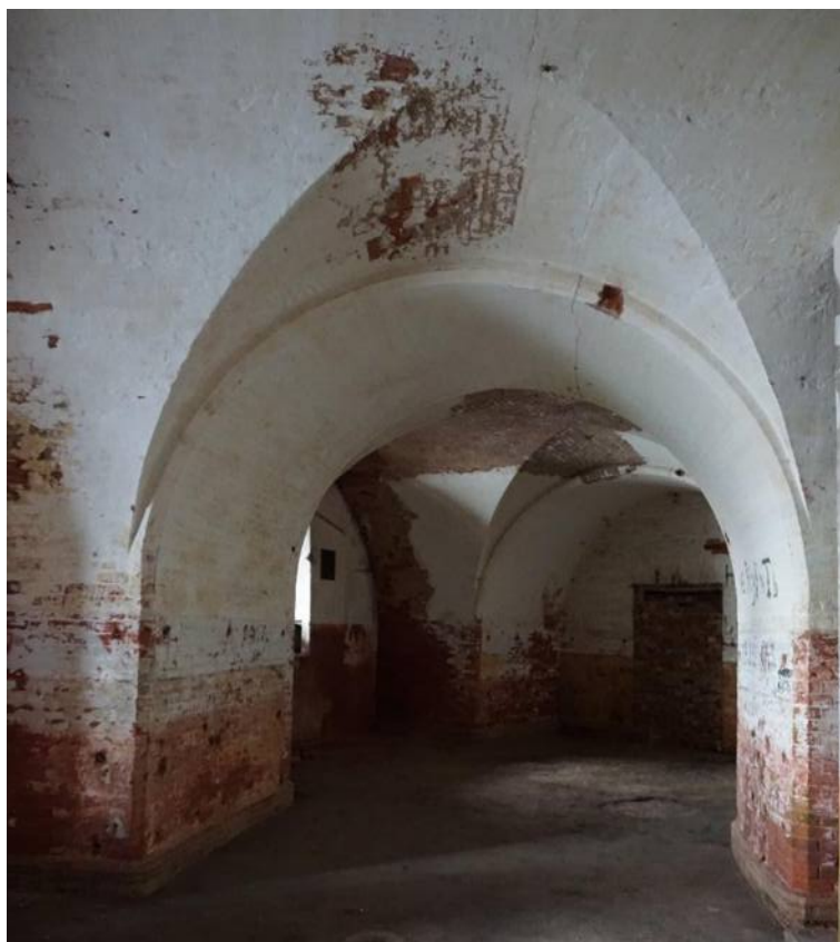
Фото 24. Помещения южного ризалита. Вид с юго-востока
