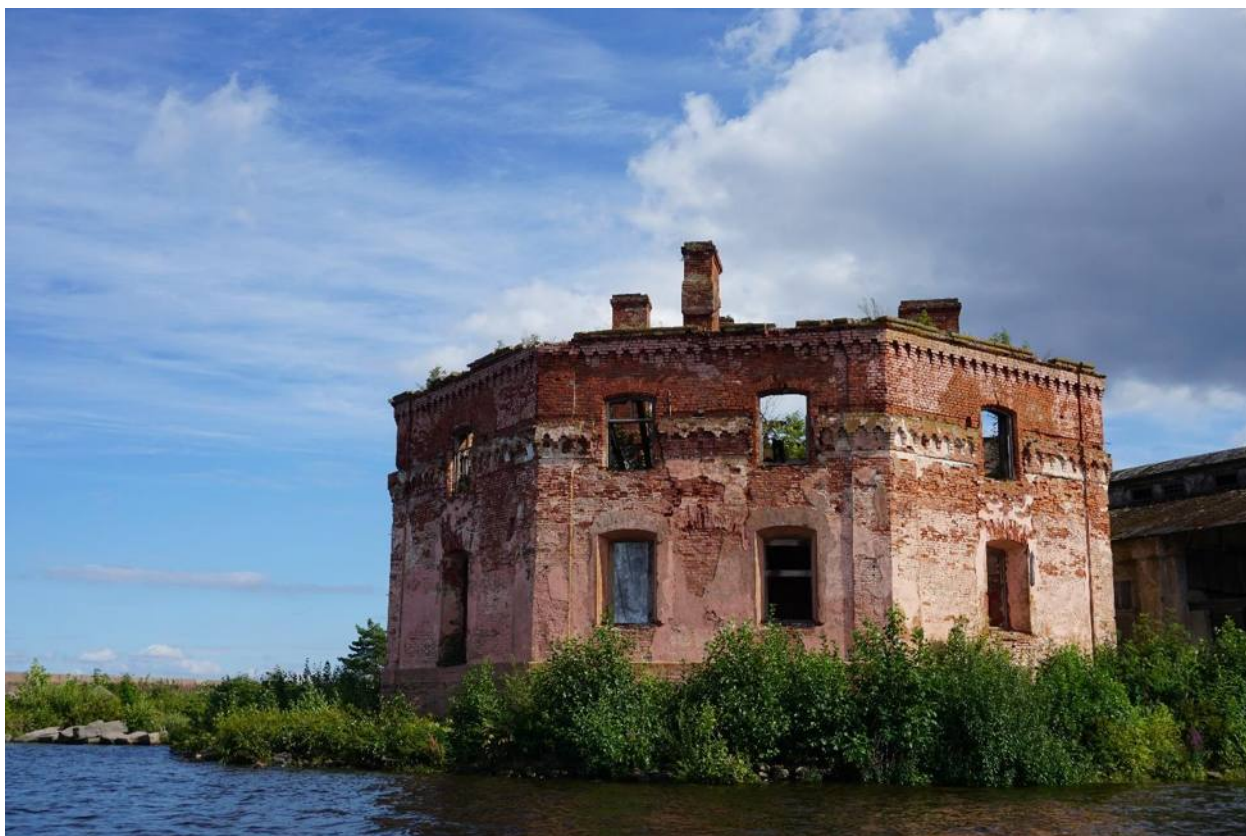
Фото 13. Вид на восьмигранную башню с северо-запада
