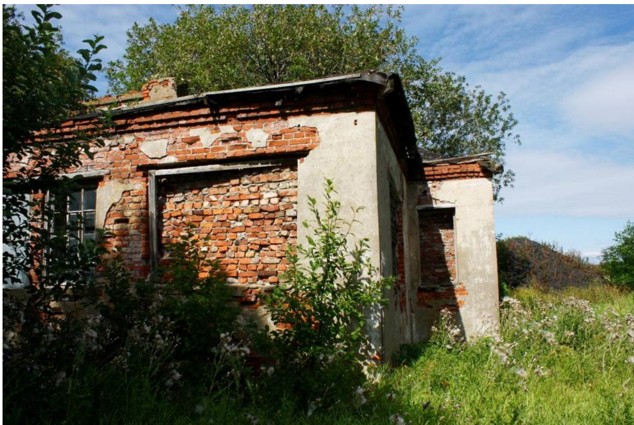
Фото 14. Правая часть юго-западного фасада служебной постройки. Вид с юга
