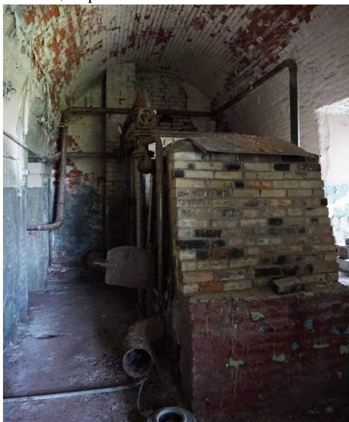
Фото 39. Помещения в северной части основного объема. Вид с юго-запада
