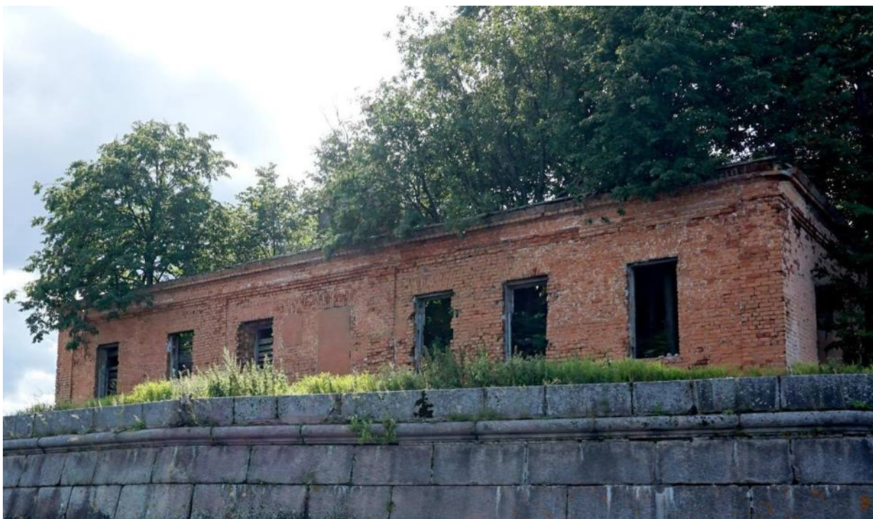
Фото 3. Северо-восточный фасад. Вид с северо-востока
