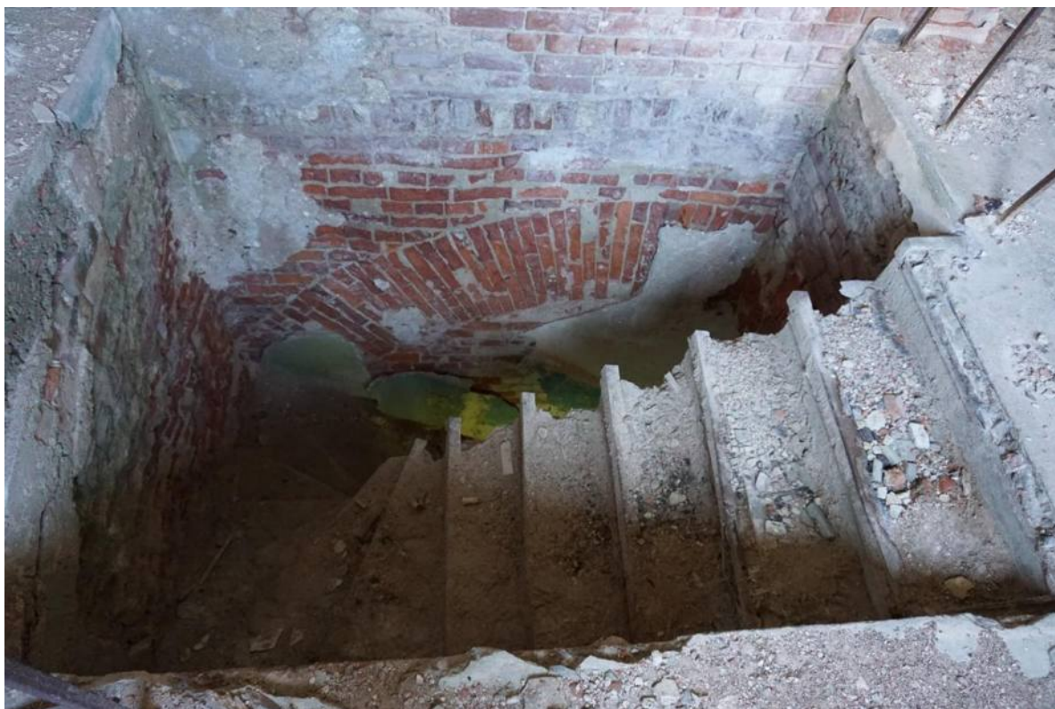
Фото 48. Лестница в южной части основного объема. Вид с северо-запада
