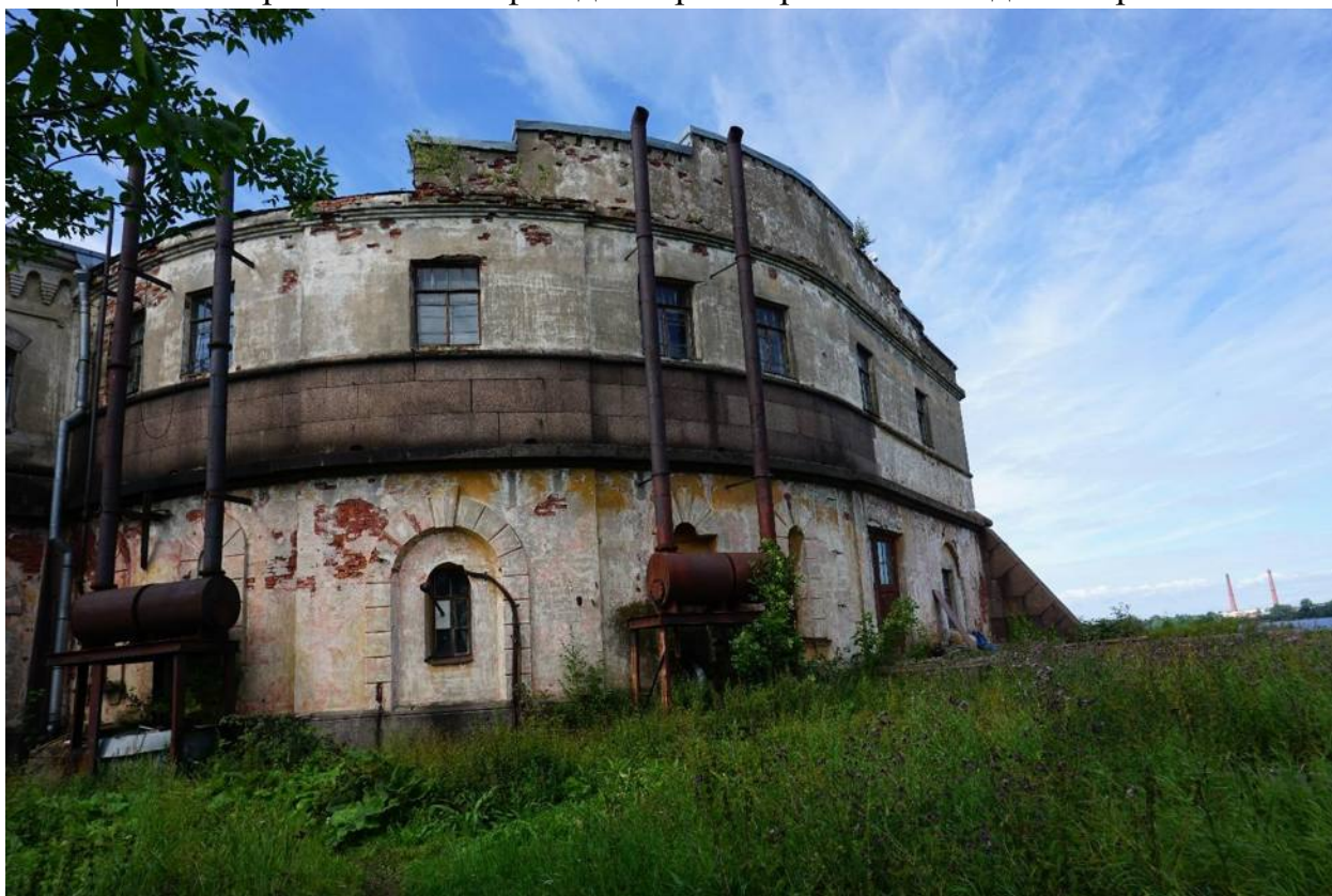
Фото 5. Юго-восточный фасад северного ризалита. Вид с юго-востока
