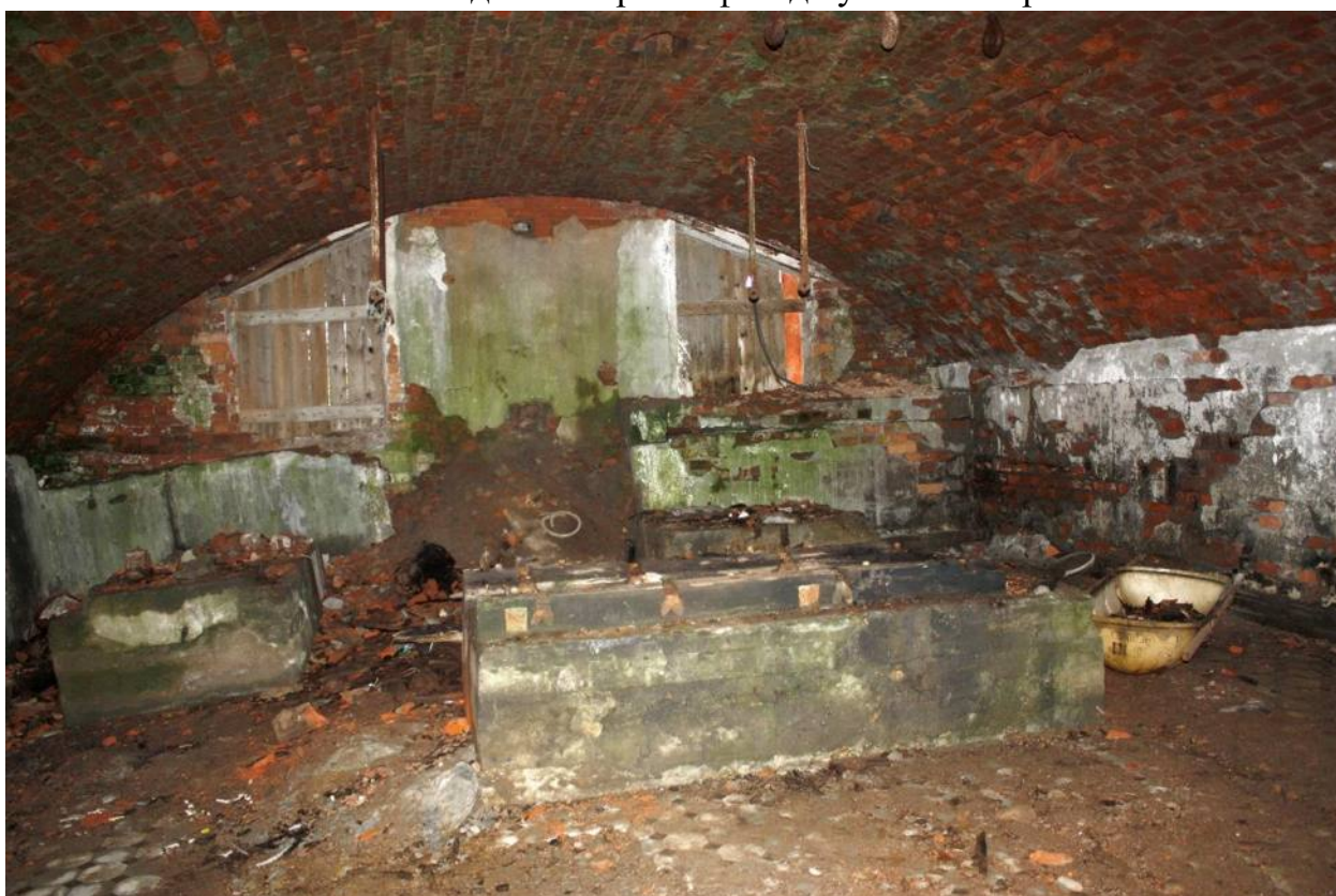
Фото 6. Помещение кухни. Вид с северо-запада
