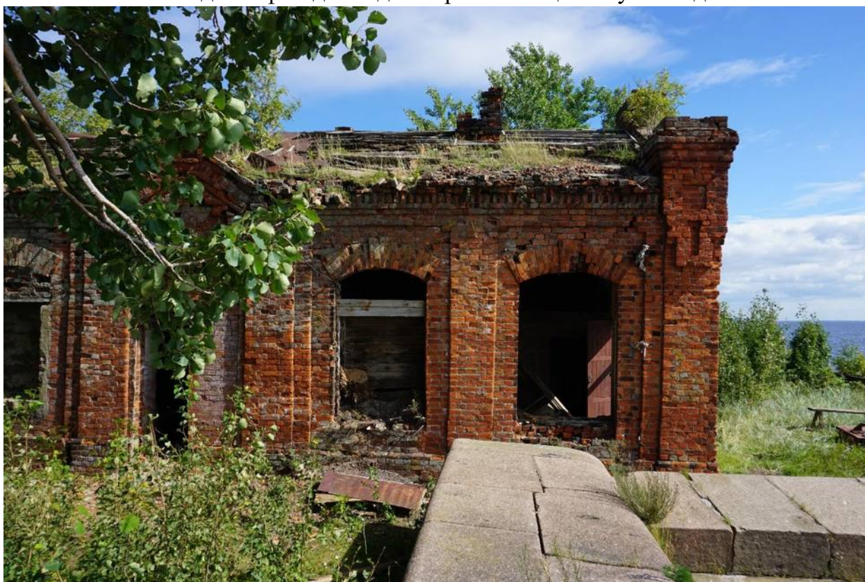
Фото 4. Правая часть северо-западного фасада цейхгауза. Вид с северо-запада
