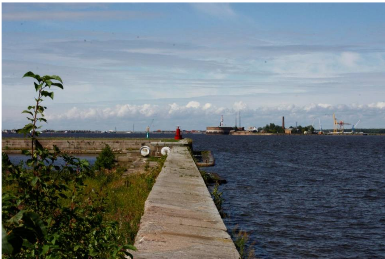
Фото 21. Восточный мол гавани. Вид с юго-востока
