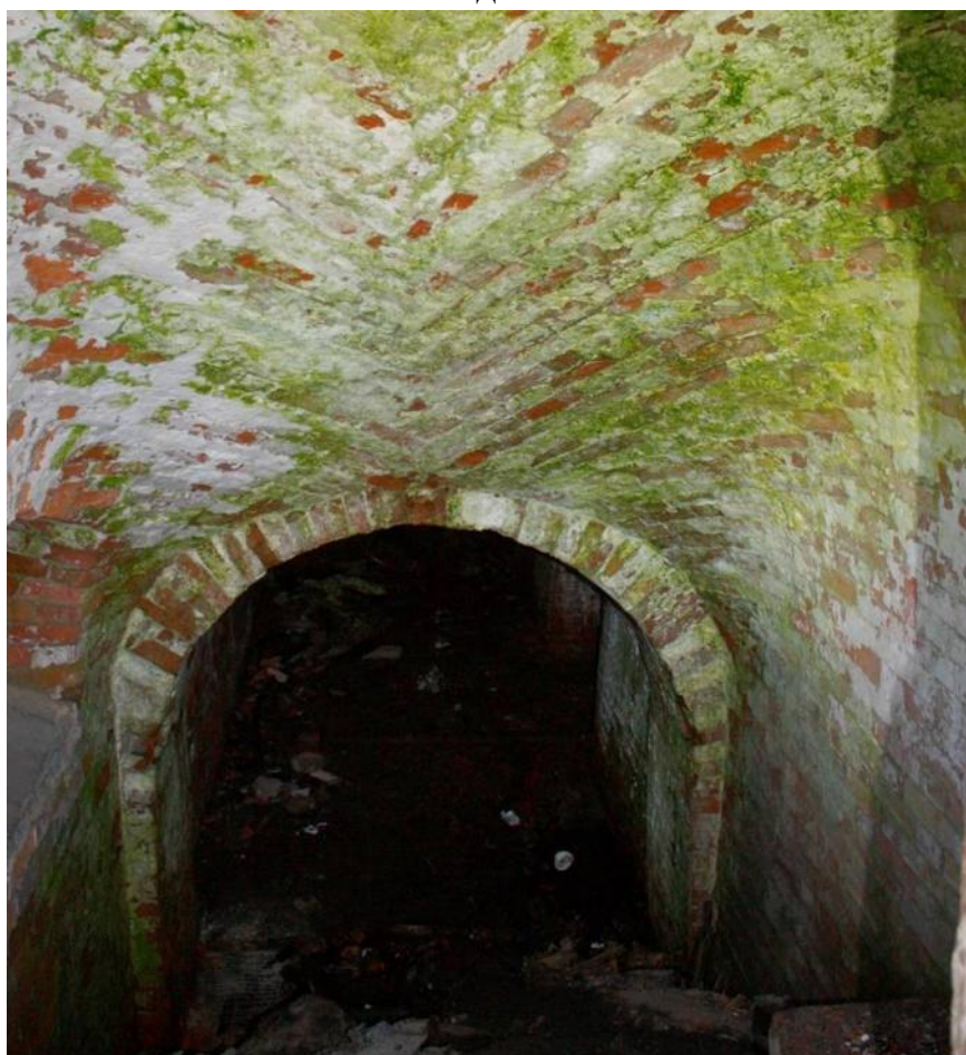
Фото 17. Спуск в помещения подвала южного ризалита. Вид с северо-востока
