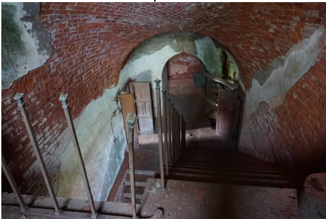
Фото 41. Лестница в объеме центрального ризалита. Вид с юго-востока
