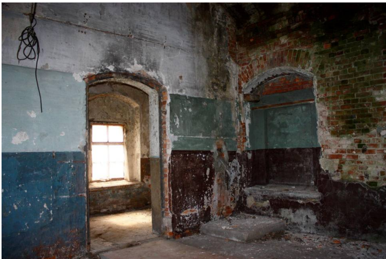
Фото 7. Помещения восточного ризалита цейхгауза. Вид с северо-востока
