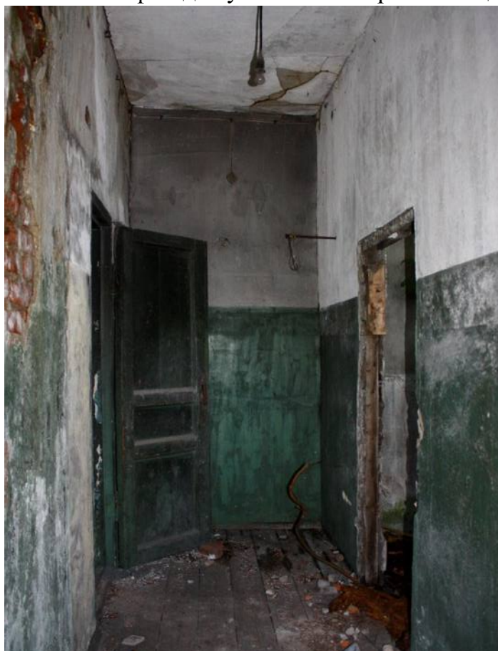
Фото 16. Помещения служебной постройки. Вид с юго-востока
