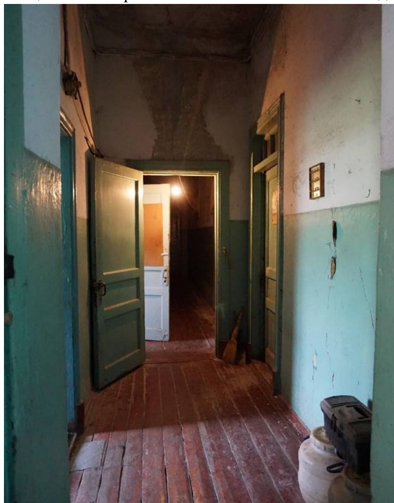
Фото 53. Помещения в северной части основного объема. Вид с северо-востока
