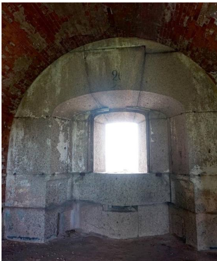
Фото 32. Помещения в южной части основного объема. Вид с юго-востока
