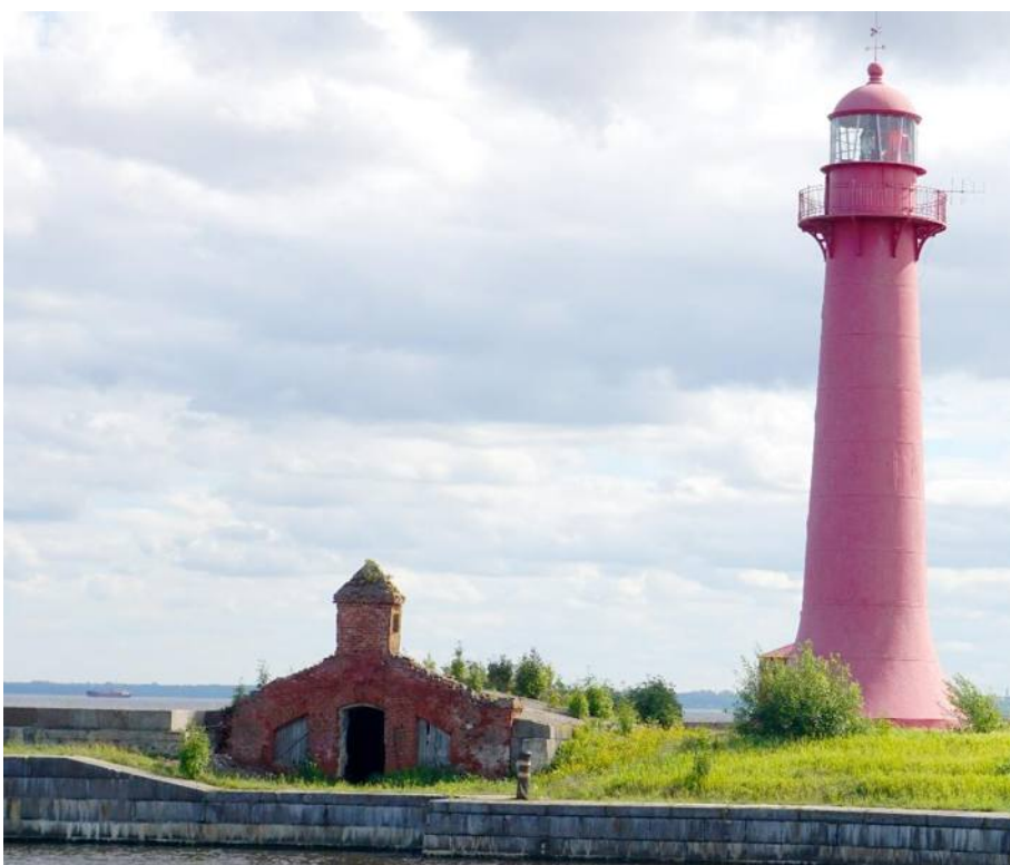
Фото 2. Общий вид на маяк Николаевский створный верхний и кухню с севера
