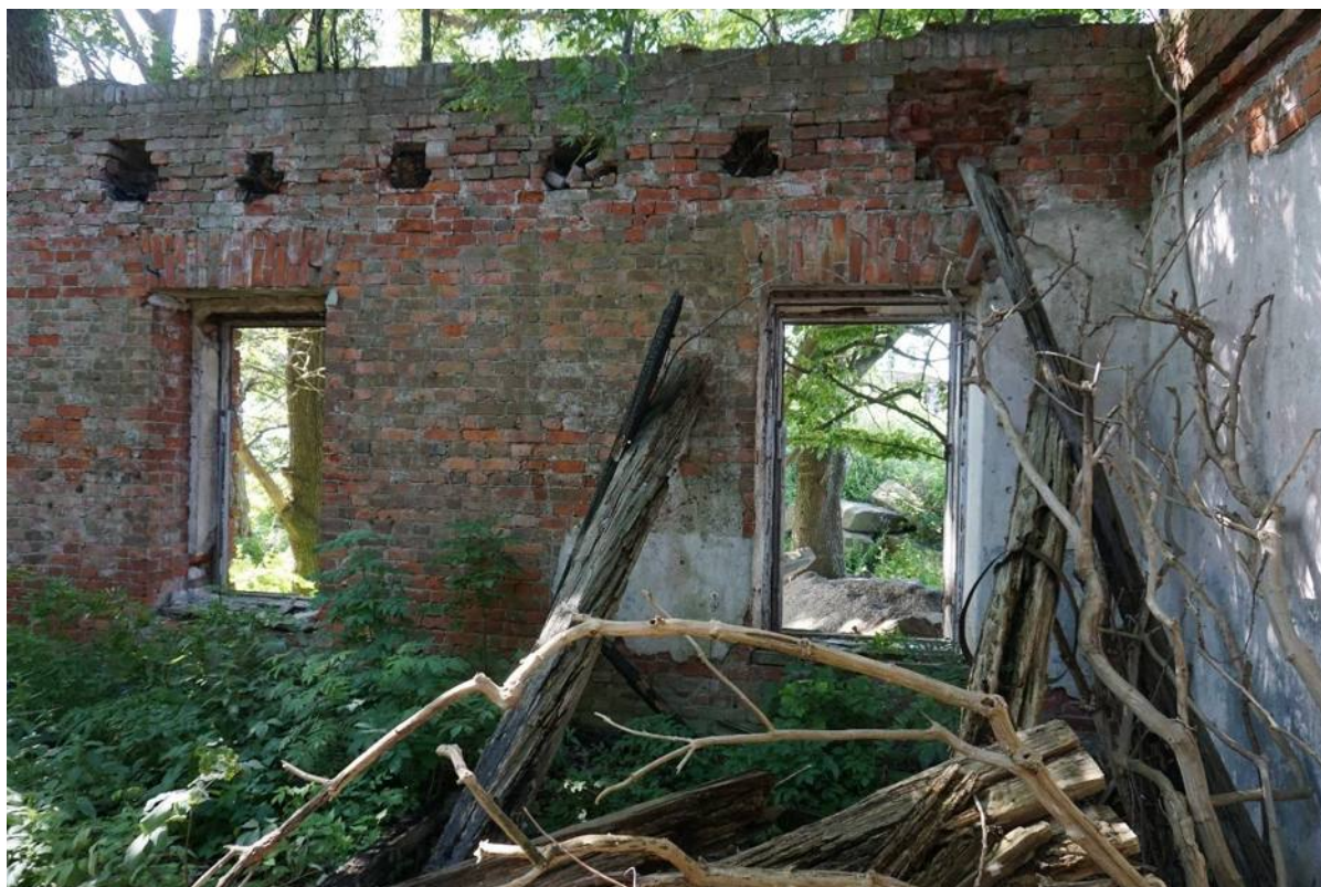
Фото 7. Помещения. Вид с северо-востока
