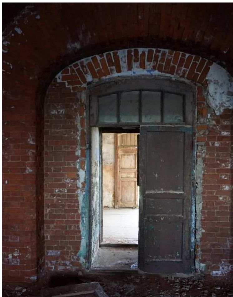
Фото 33. Помещения в центральной части основного объема. Вид с запада
