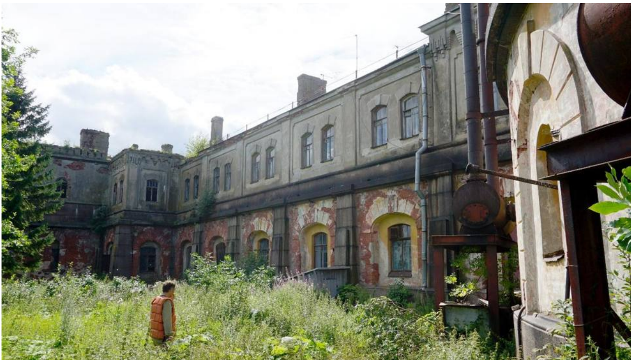
Фото 6. Юго-восточный фасад северной части основного объема. Вид с северо-востока
