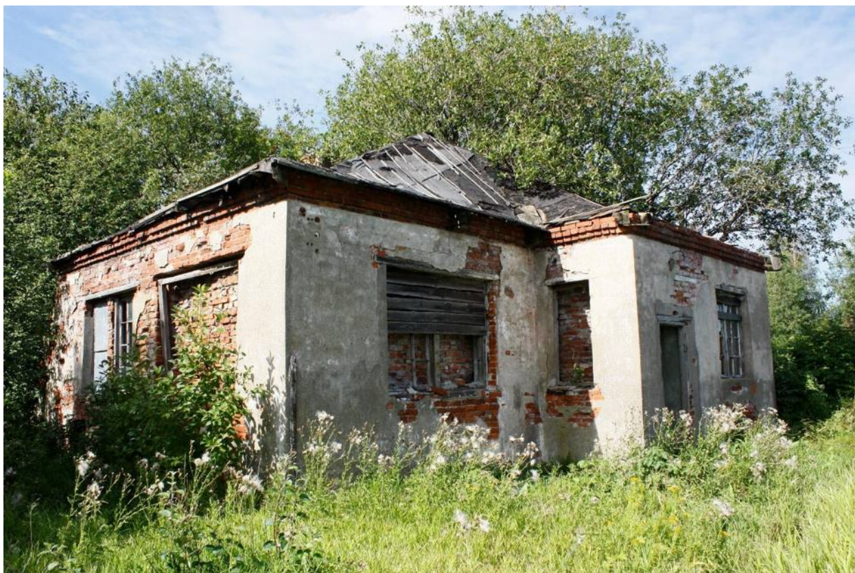
Фото 13. Юго-восточный и юго-западный фасады служебной постройки. Вид с юго-востока
