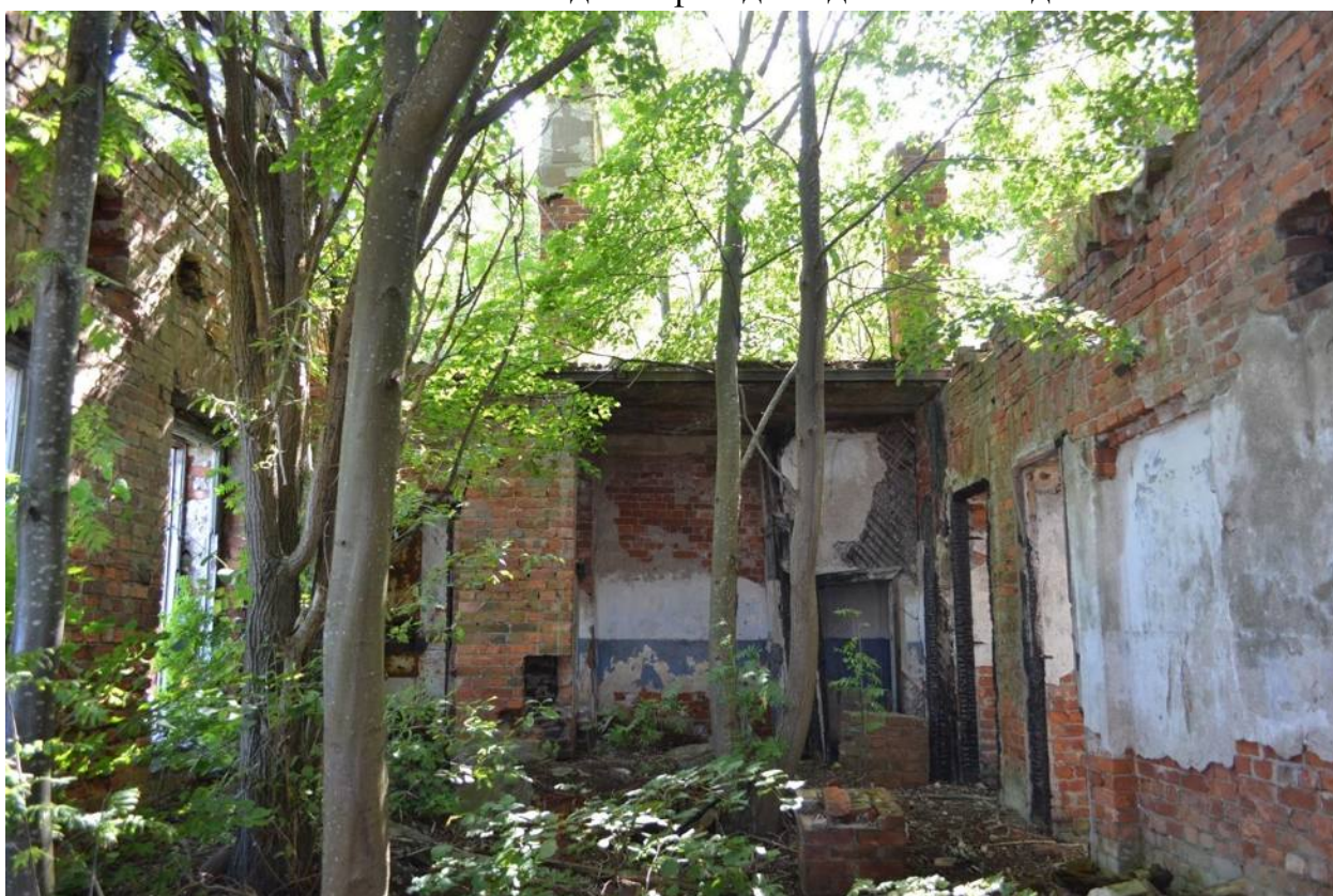
Фото 6. Помещения. Вид с северо-запада
