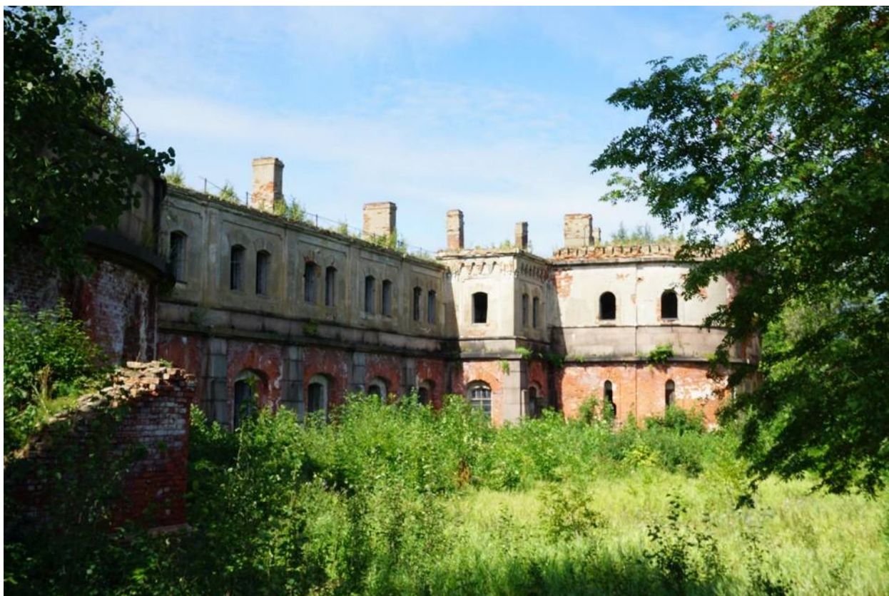
Фото 8. Юго-восточный фасад северной части основного объема. Вид с юго-востока
