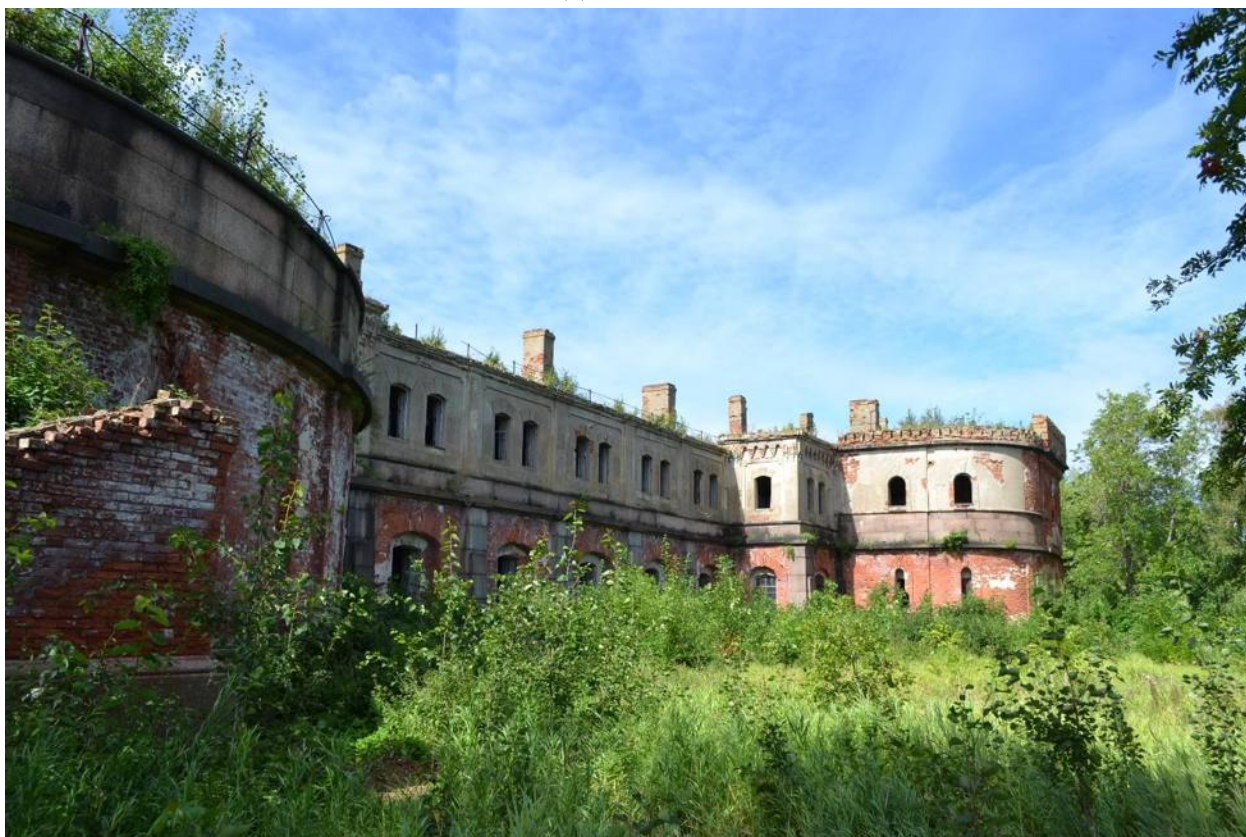
Фото 15. Юго-восточный фасад южной части основного объема. Вид с юго-востока
