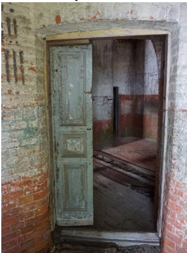
Фото 22. Помещения южного ризалита. Вид с юго-запада
