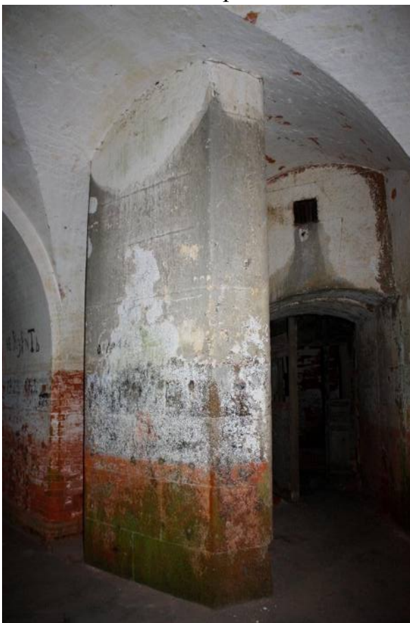
Фото 23. Помещения южного ризалита. Вид с юго-востока
