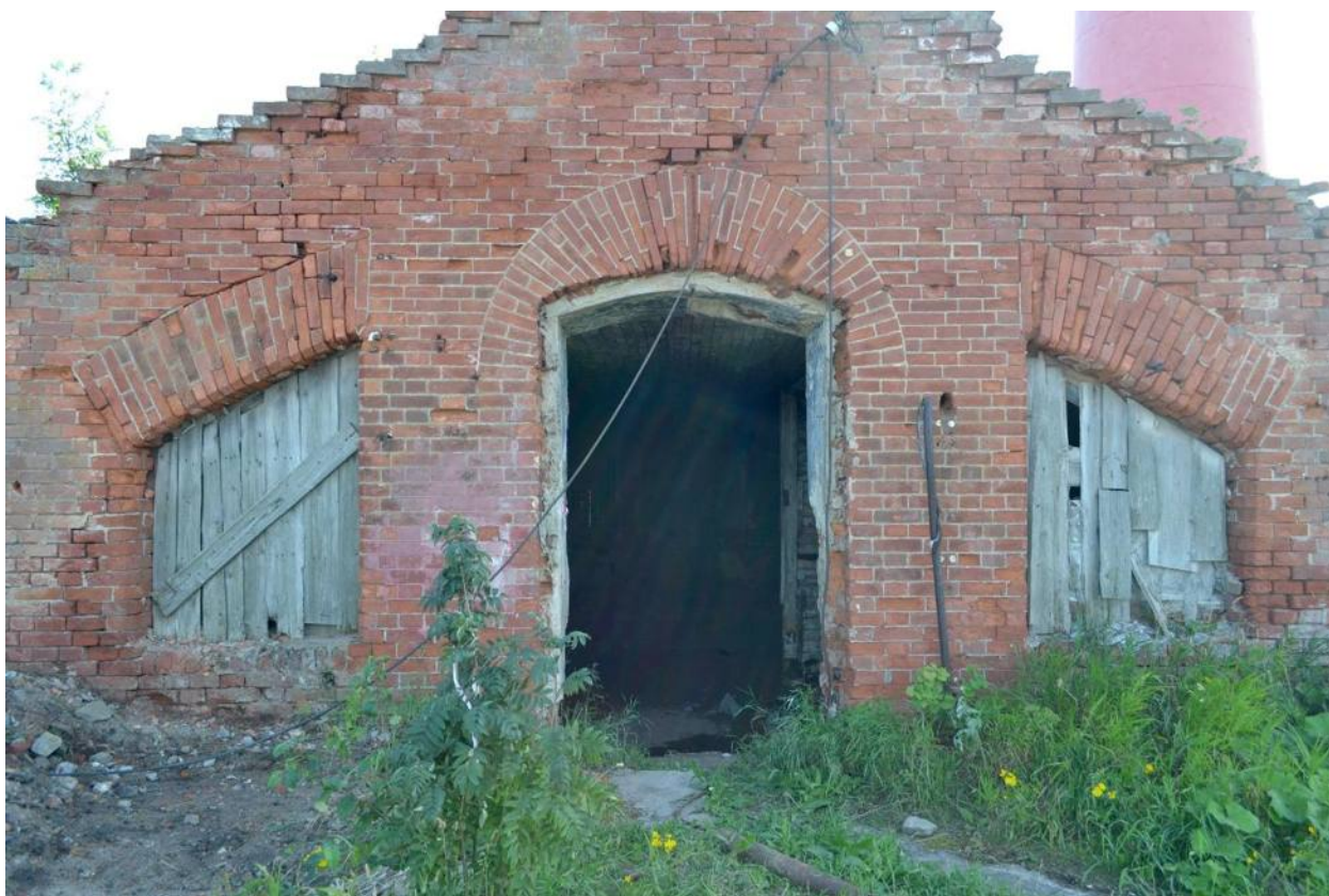
Фото 5. Вид на северный фасад кухни с севера
