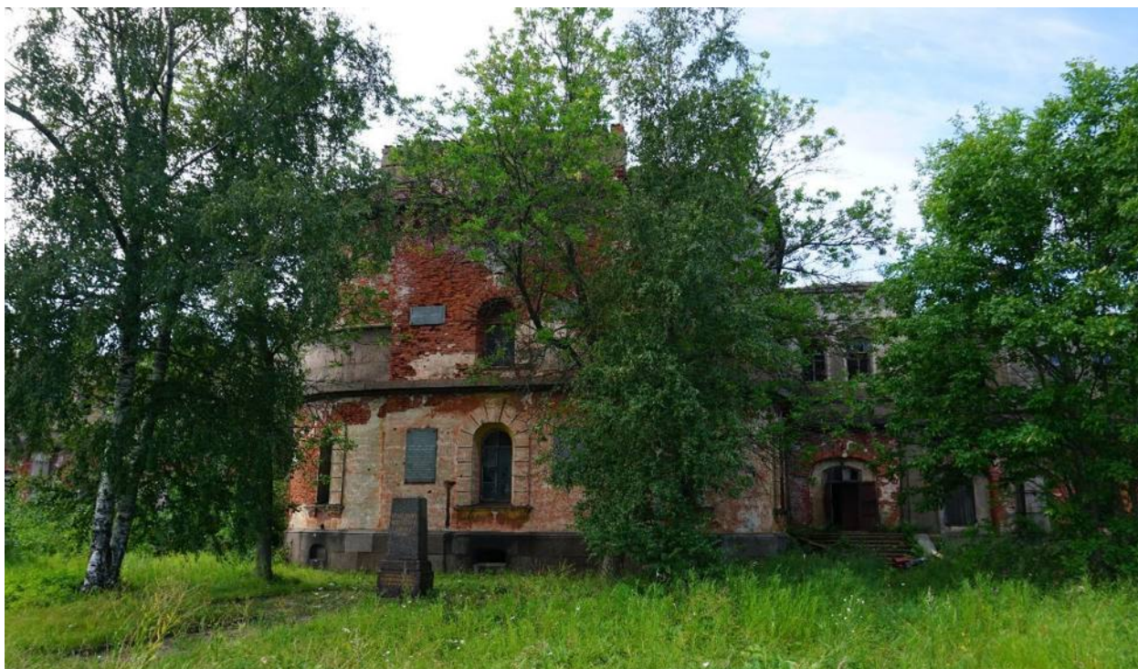
Фото 9. Юго-восточный фасад основного объема. Центральный ризалит. Вид с востока
