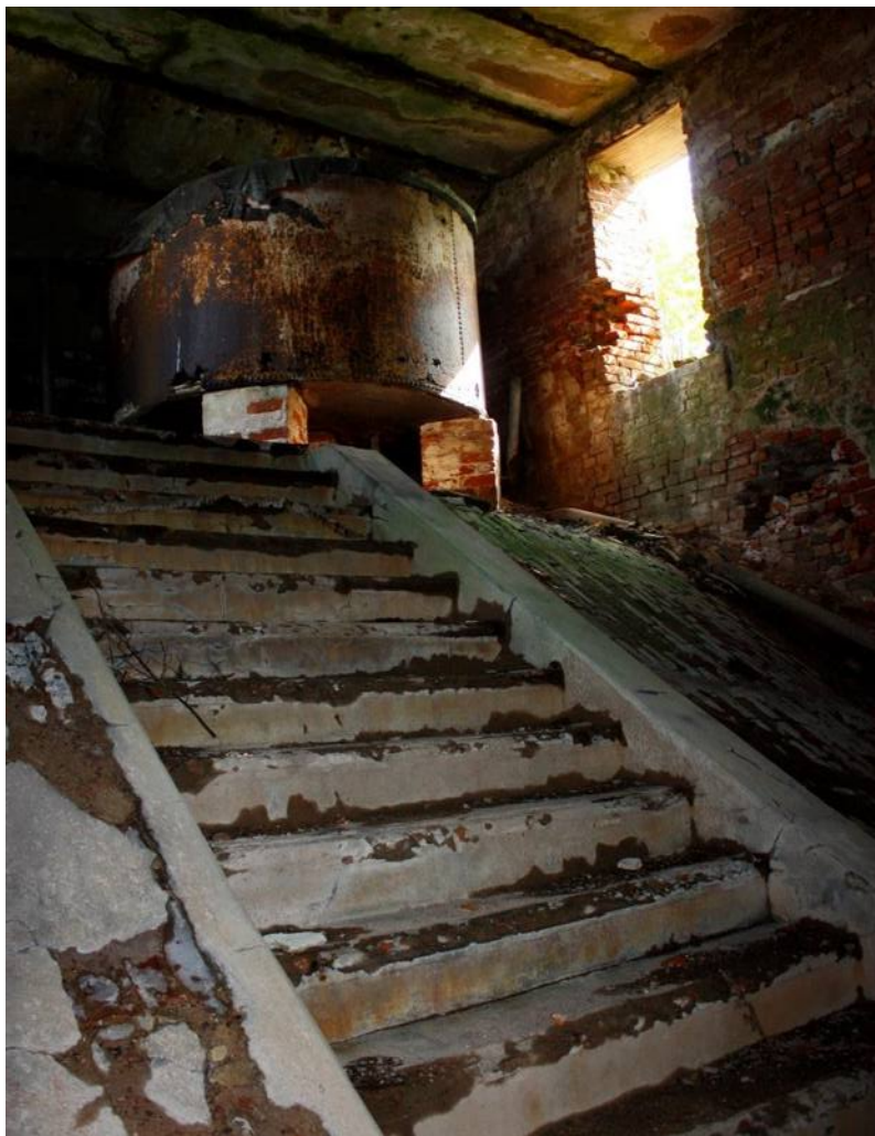
Фото 49. Лестница на чердак в центральном ризалите. Вид с северо-запада
