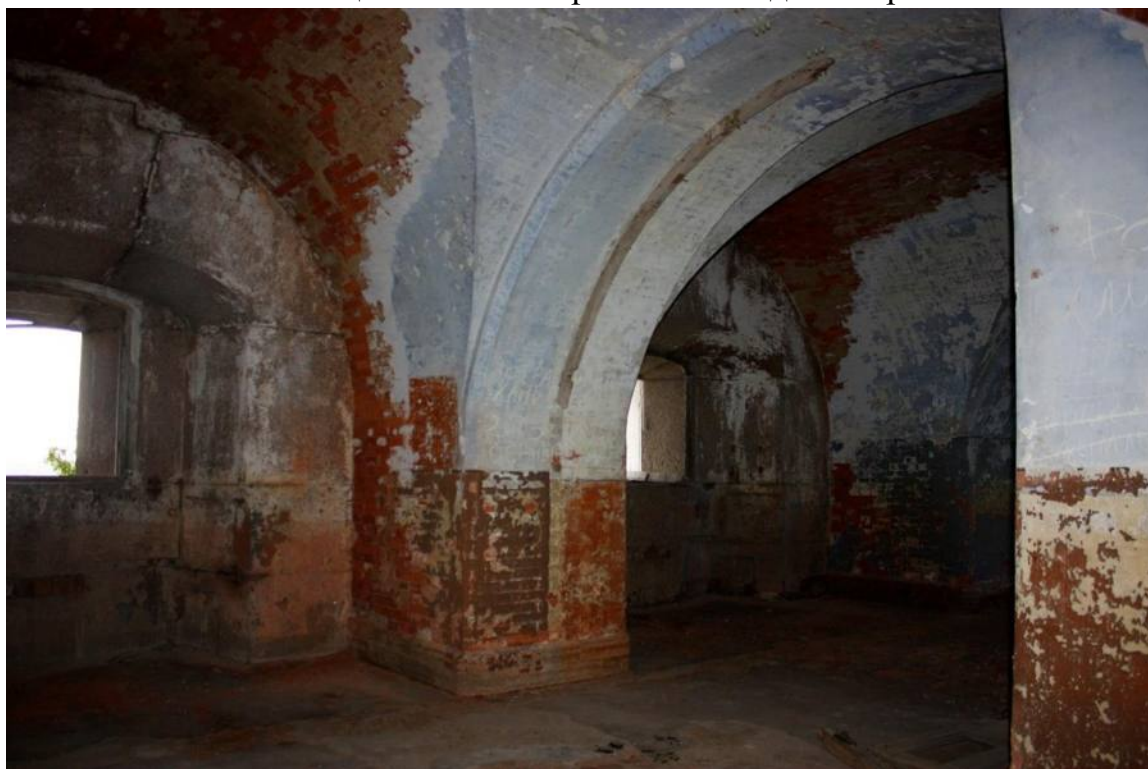
Фото 27. Помещения южного ризалита. Вид с юго-востока
