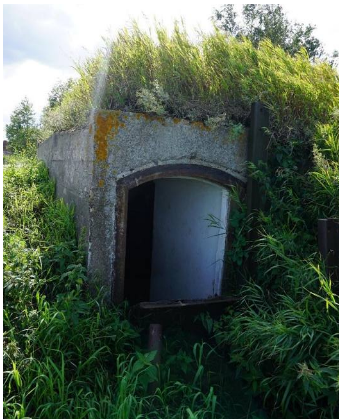
Фото 27. Вид на погреба в северо-западной части форта с севера
