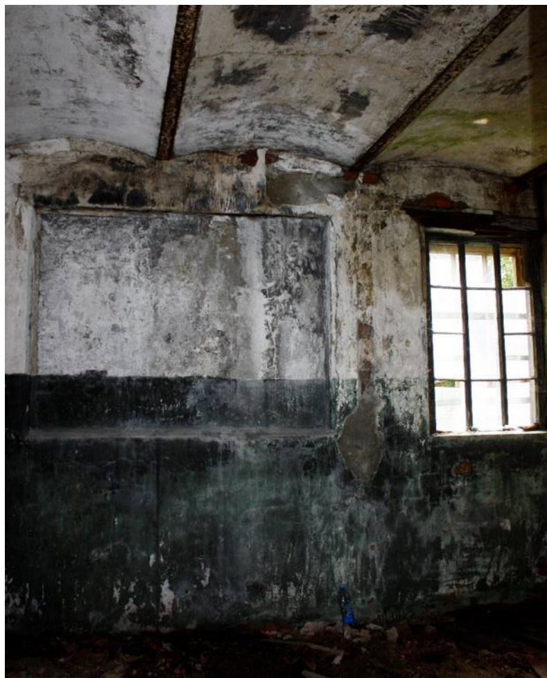
Фото 17. Помещения служебной постройки. Вид с северо-востока
