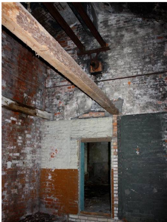
Фото 11. Помещения западного ризалита цейхгауза. Вид с северо-запада
