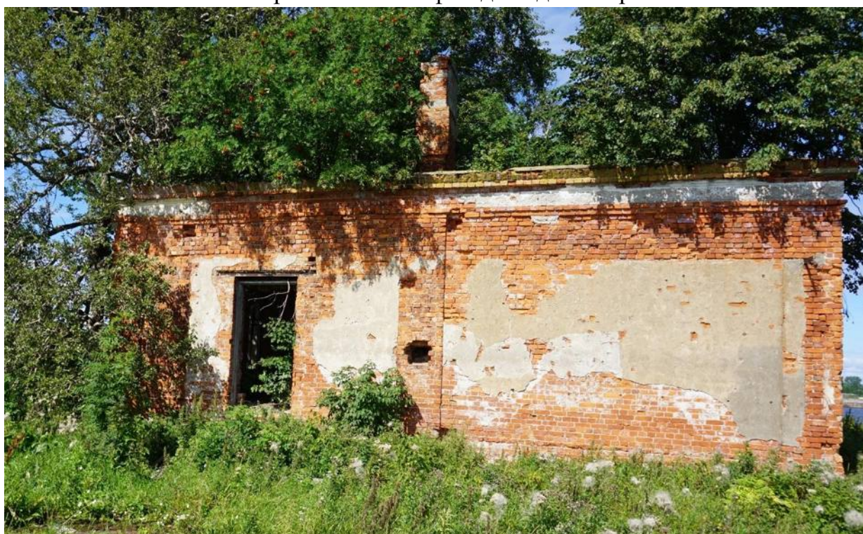
Фото 4. Юго-восточный фасад. Вид с юго-востока
