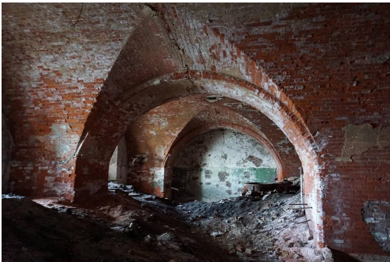
Фото 34. Помещения в центральной части основного объема. Вид с юго-запада
