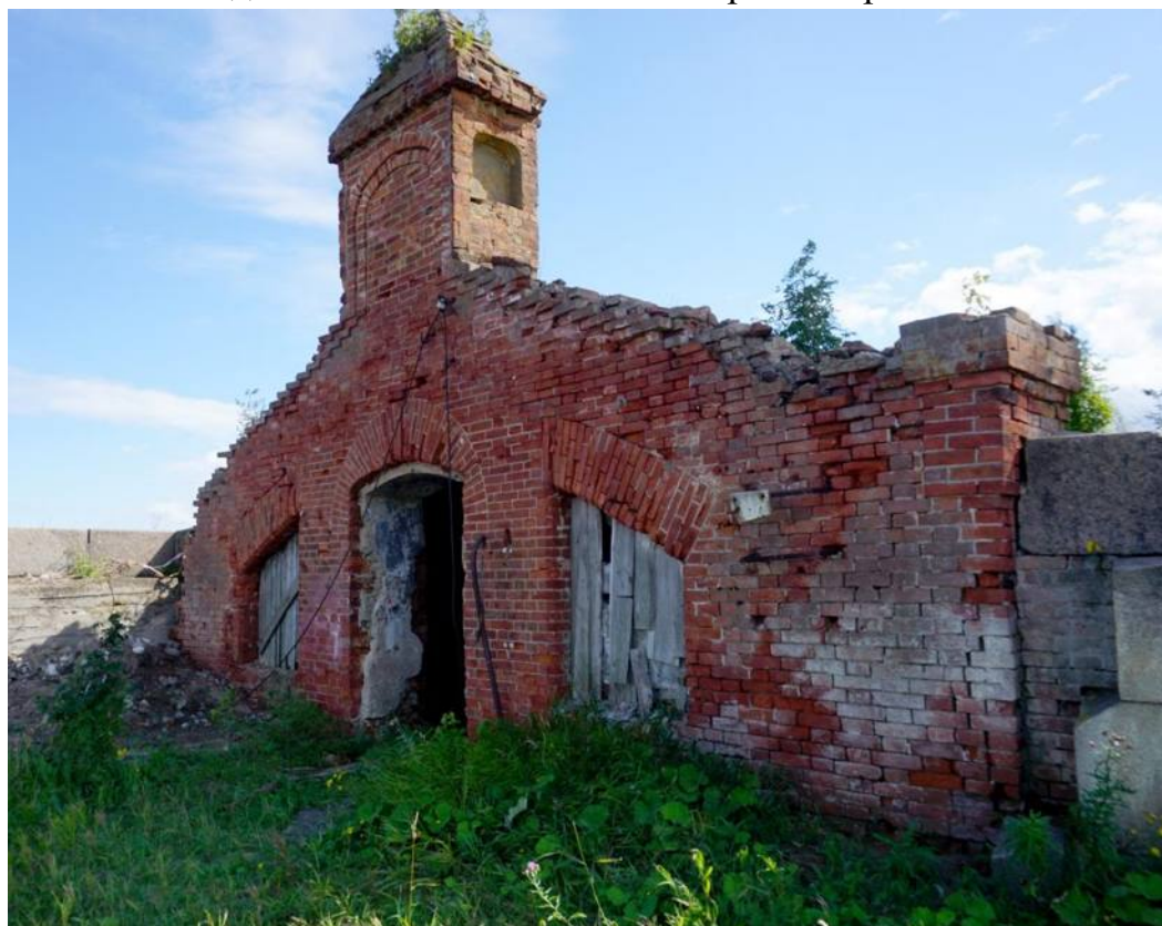
Фото 4. Вид на северный фасад кухни с севера
