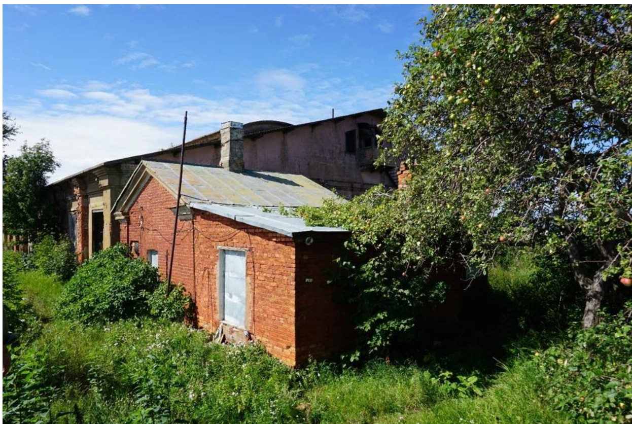
Фото 3. Служебное здание со стороны северо-восточного фасада эллинга. Вид с востока
