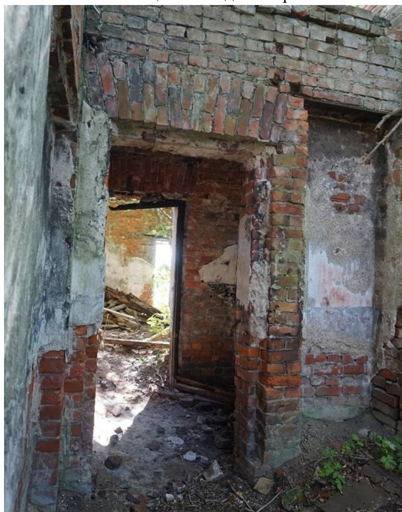
Фото 8. Помещения. Вид с северо-запада
