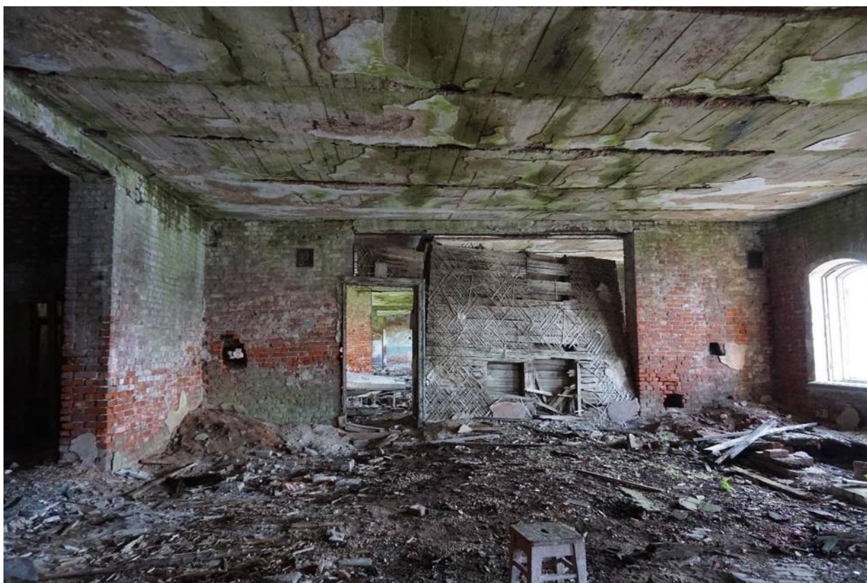
Фото 45. Помещения в центральной части основного объема. Вид с северо-востока
