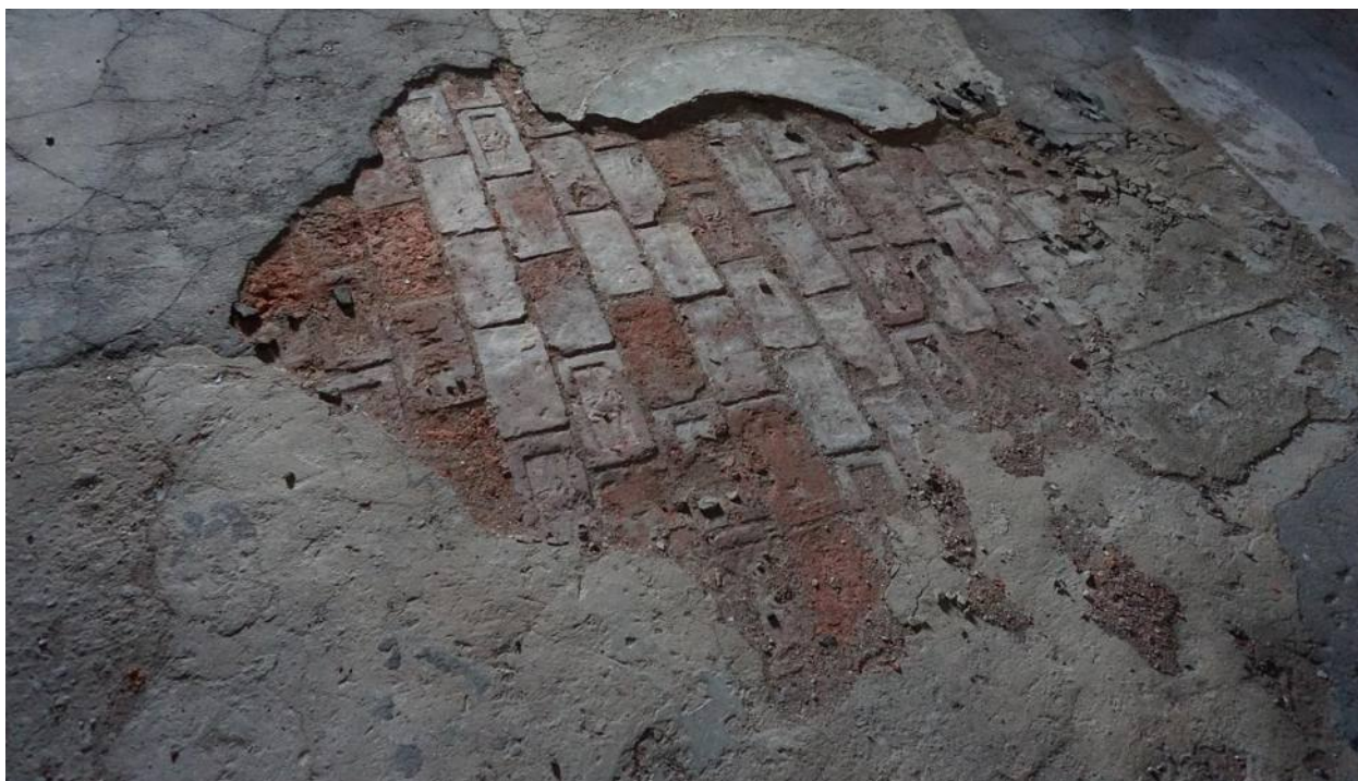
Фото 28. Помещения в южной части основного объема. Вид с юго-востока
