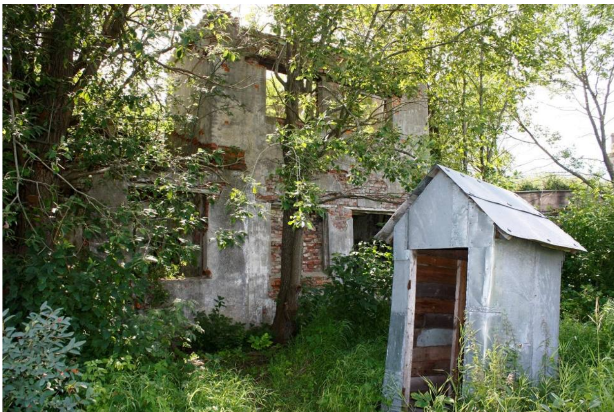
Фото 15. Северо-восточный фасад служебной постройки. Вид с северо-востока
