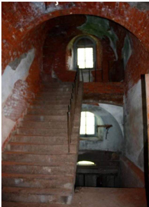
Фото 36. Лестница на второй этаж в объеме центрального ризалита. Вид с северо-запада
