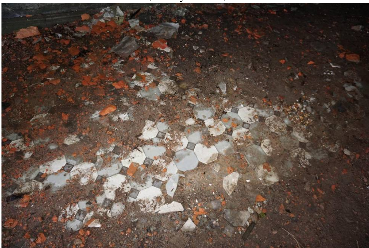
Фото 8. Помещение кухни. Вид с северо-запада
