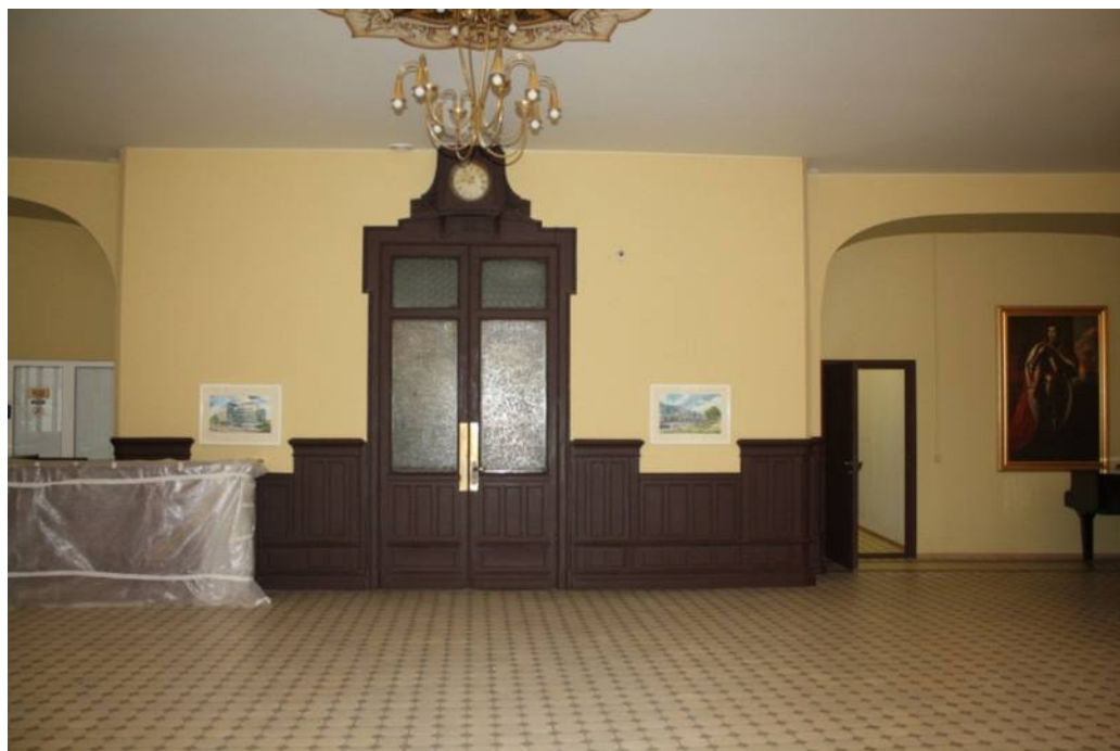
69. Помещение 1-Н (бывший «Операционный зал»). Панели стеновые тонированного дуба. Дверь с порталом. Объект культурного наследия федерального значения «Дом, где в первой половине XIX в. размещалась Российско-Американская компания. Здесь в 1820-х гг. жили декабристы Бестужев-Марлинский А.А. и Рылеев К.Ф.», расположенный по адресу: Санкт-Петербург, Адмиралтейский район, набережная реки Мойки, дом 72, литера А. Дата дополнительной съемки: 08.07.2019.
