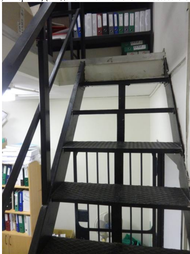
44. Лестничный марш, ведущий на 3-й этаж. Подсобное помещение. Объект культурного наследия федерального значения «Дом, где в первой половине XIX в. размещалась Российско-Американская компания. Здесь в 1820-х гг. жили декабристы Бестужев-Марлинский А.А. и Рылеев К.Ф.», расположенный по адресу: Санкт-Петербург, Адмиралтейский район, набережная реки Мойки, дом 72, литера А. Дата дополнительной съемки: 08.07.2019.
