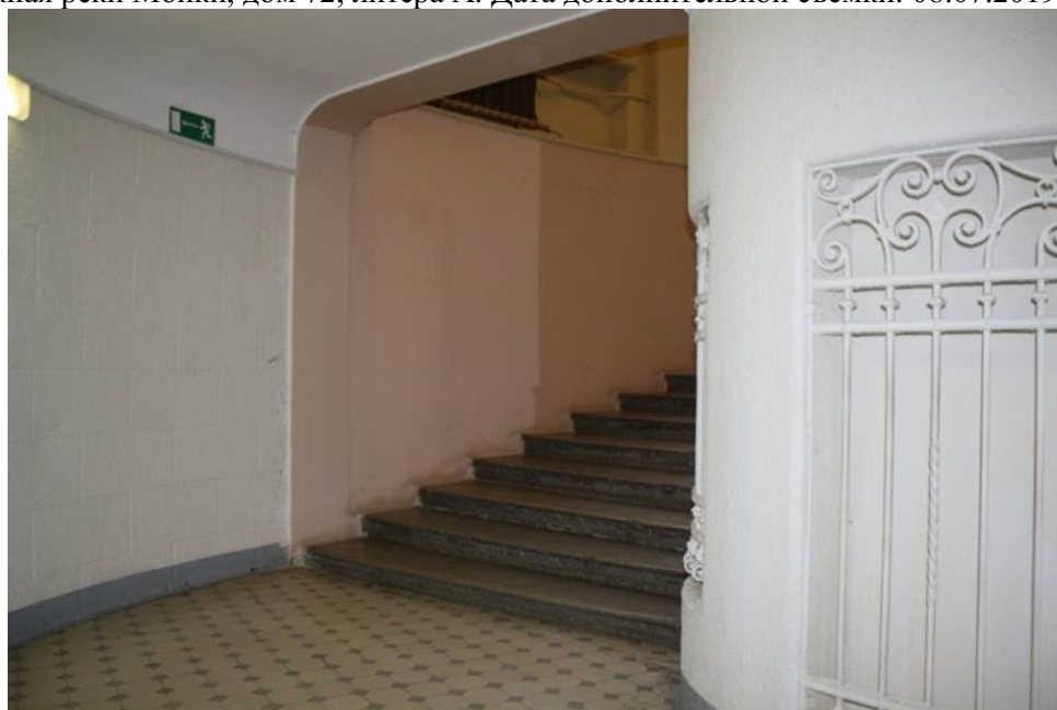
72. Полукруглая в плане лестница дворового фасада лицевого корпуса: ступени (известняк), материал облицовки площадок (метлахская плитка), решетка в нише служебного помещения под лестницей (ковка). Объект культурного наследия федерального значения «Дом, где в первой половине XIX в. размещалась Российско-Американская компания. Здесь в 1820-х гг. жили декабристы Бестужев-Марлинский А.А. и Рылеев К.Ф.», расположенный по адресу: Санкт-Петербург, Адмиралтейский район, набережная реки Мойки, дом 72, литера А. Дата дополнительной съемки: 08.07.2019.
