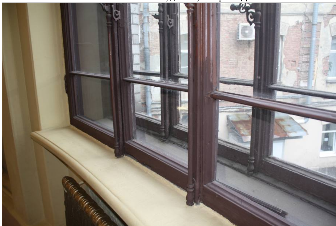
16. Оконные заполнения второго этажа. Объект культурного наследия федерального значения «Дом, где в первой половине XIX в. размещалась Российско-Американская компания. Здесь в 1820-х гг. жили декабристы Бестужев-Марлинский А.А. и Рылеев К.Ф.», расположенный по адресу: Санкт-Петербург, Адмиралтейский район, набережная реки Мойки, дом 72, литера А. Дата съемки: 21.06.2019.
