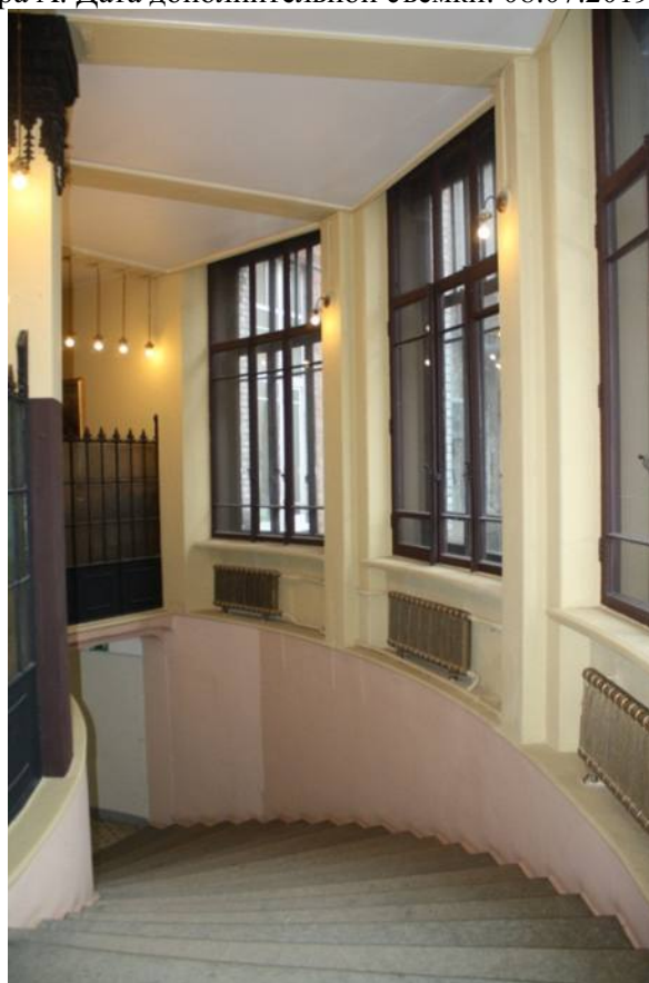
68. Полукруглая в плане лестница дворового фасада лицевого корпуса. Объект культурного наследия федерального значения «Дом, где в первой половине XIX в. размещалась Российско-Американская компания. Здесь в 1820-х гг. жили декабристы Бестужев-Марлинский А.А. и Рылеев К.Ф.», расположенный по адресу: Санкт-Петербург, Адмиралтейский район, набережная реки Мойки, дом 72, литера А. Дата дополнительной съемки: 08.07.2019.
