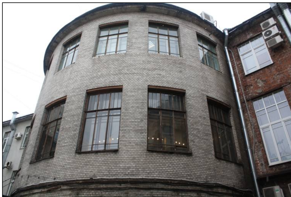
14. Оконные заполнения второго и третьего этажей. Объект культурного наследия федерального значения «Дом, где в первой половине XIX в. размещалась Российско-Американская компания. Здесь в 1820-х гг. жили декабристы Бестужев-Марлинский А.А. и Рылеев К.Ф.», расположенный по адресу: Санкт-Петербург, Адмиралтейский район, набережная реки Мойки, дом 72, литера А. Дата съемки: 21.06.2019.
