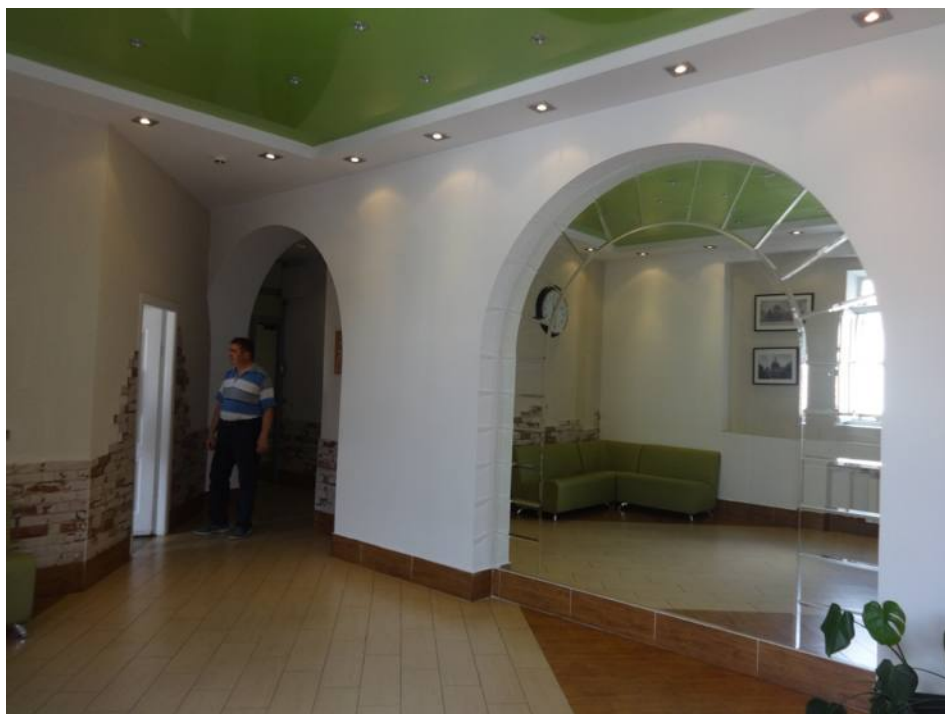
87. Коридор. Вид на северо-запад. Объект культурного наследия федерального значения «Дом, где в первой половине XIX в. размещалась Российско-Американская компания. Здесь в 1820-х гг. жили декабристы Бестужев-Марлинский А.А. и Рылеев К.Ф.», расположенный по адресу: Санкт-Петербург, Адмиралтейский район, набережная реки Мойки, дом 72, литера А. Дата дополнительной съемки: 08.07.2019.
