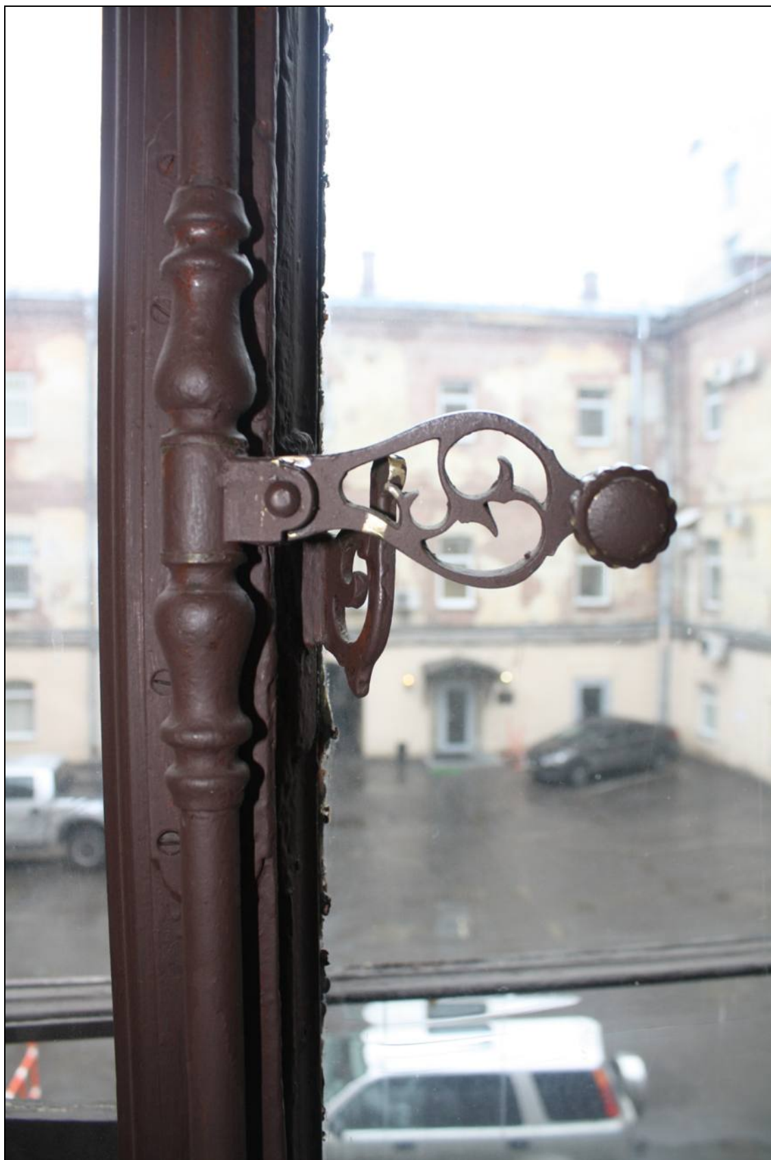
20. Оконные приборы. Объект культурного наследия федерального значения «Дом, где в первой половине XIX в. размещалась Российско-Американская компания. Здесь в 1820-х гг. жили декабристы Бестужев-Марлинский А.А. и Рылеев К.Ф.», расположенный по адресу: Санкт-Петербург, Адмиралтейский район, набережная реки Мойки, дом 72, литера А. Дата съемки: 21.06.2019.
