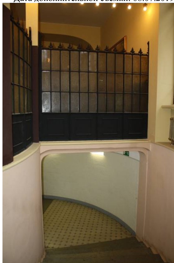
70. Перегородки помещения 1-Н (бывший «Операционный зал»). Часть полукруглой в плане лестницы дворового фасада лицевого корпуса. Объект культурного наследия федерального значения «Дом, где в первой половине XIX в. размещалась Российско-Американская компания. Здесь в 1820-х гг. жили декабристы Бестужев-Марлинский А.А. и Рылеев К.Ф.», расположенный по адресу: Санкт-Петербург, Адмиралтейский район, набережная реки Мойки, дом 72, литера А. Дата дополнительной съемки: 08.07.2019.
