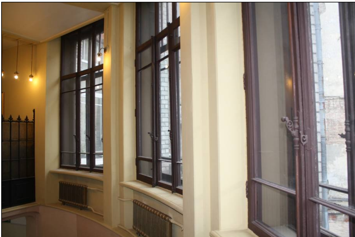
15. Оконные заполнения второго этажа. Объект культурного наследия федерального значения «Дом, где в первой половине XIX в. размещалась Российско-Американская компания. Здесь в 1820-х гг. жили декабристы Бестужев-Марлинский А.А. и Рылеев К.Ф.», расположенный по адресу: Санкт-Петербург, Адмиралтейский район, набережная реки Мойки, дом 72, литера А. Дата съемки: 21.06.2019.
