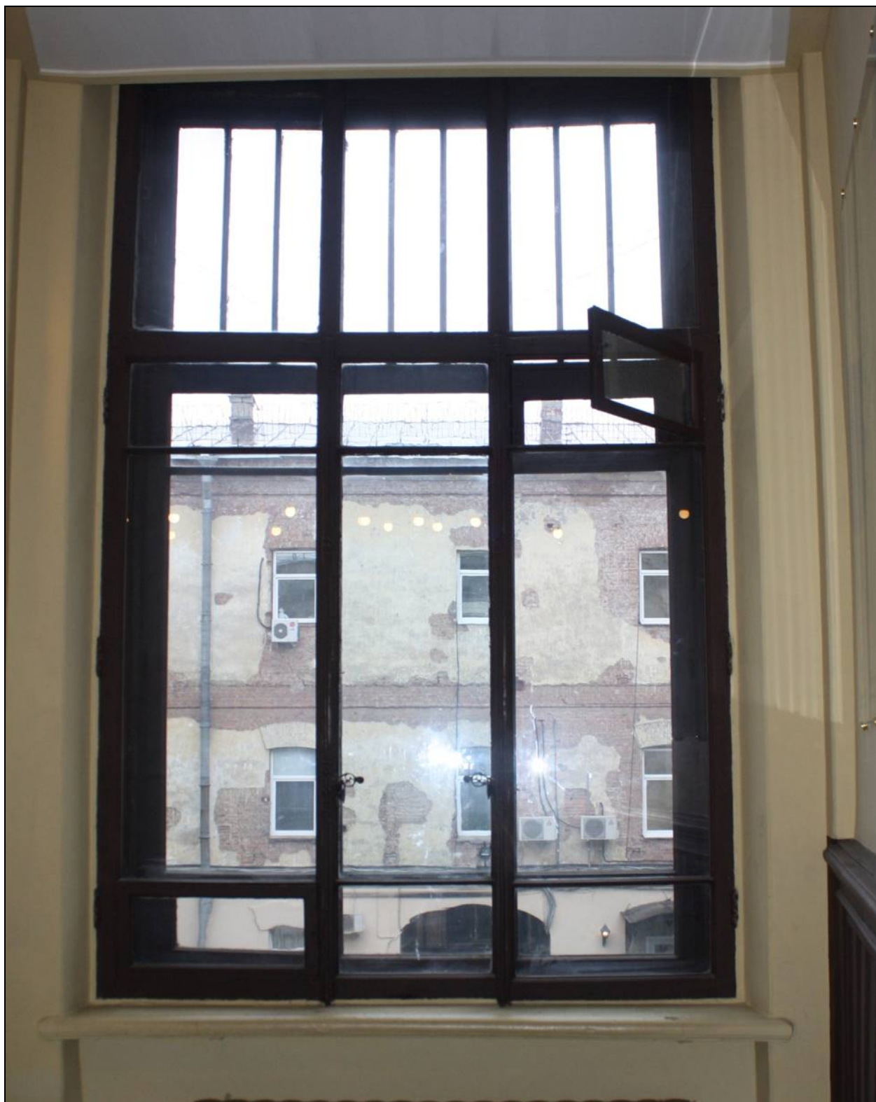
17. Оконные заполнения второго этажа. Объект культурного наследия федерального значения «Дом, где в первой половине XIX в. размещалась Российско-Американская компания. Здесь в 1820-х гг. жили декабристы Бестужев-Марлинский А.А. и Рылеев К.Ф.», расположенный по адресу: Санкт-Петербург, Адмиралтейский район, набережная реки Мойки, дом 72, литера А. Дата съемки: 21.06.2019.
