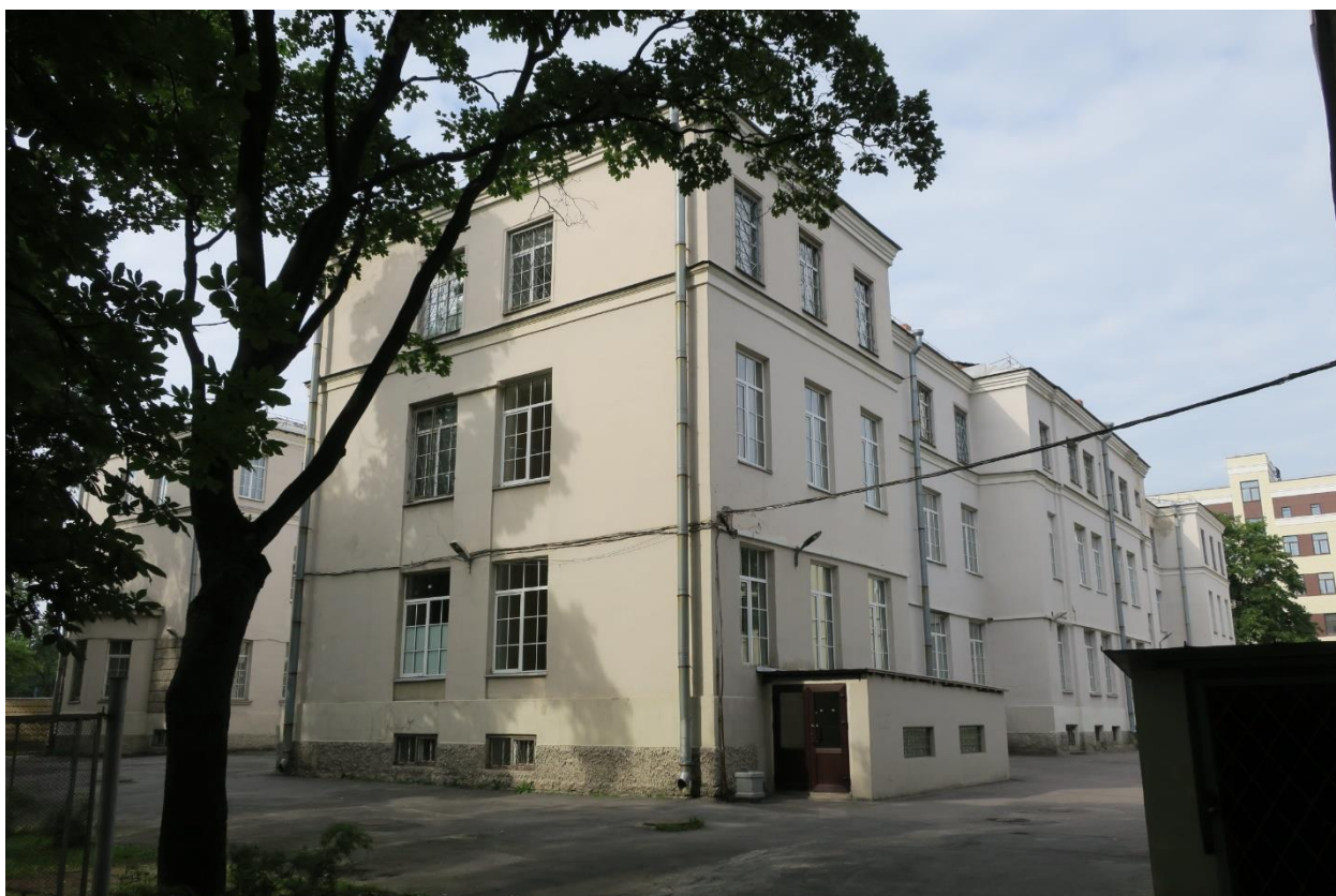
17. Юго-западный торцевой фасад объекта культурного наследия регионального значения «Противоалкогольный институт» (Главное здание), расположенного по адресу: г. Санкт-Петербург, ул. Бехтерева д. 3, Лит. А. 26.07.2018
