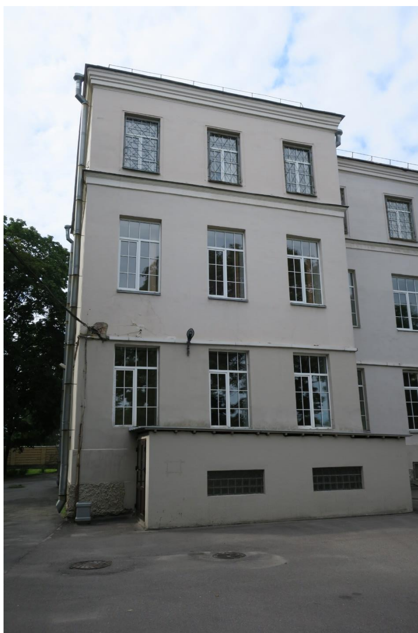
16. Юго-восточный дворовый фасад объекта культурного наследия регионального значения «Противоалкогольный институт» (Главное здание)», расположенного по адресу: г. Санкт-Петербург, ул. Бехтерева д. 3, Лит. А. Фрагмент. 26.07.2018
