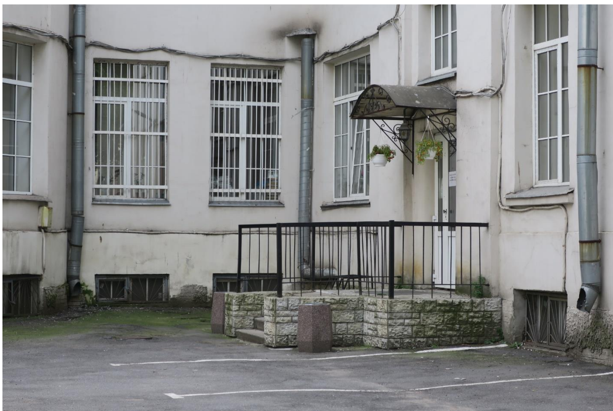
12. Крыльцо юго-восточного фасада объекта культурного наследия регионального значения «Противоалкогольный институт» (Главное здание), расположенного по адресу: г. Санкт-Петербург, ул. Бехтерева д. 3, Лит. А. 26.07.2018
