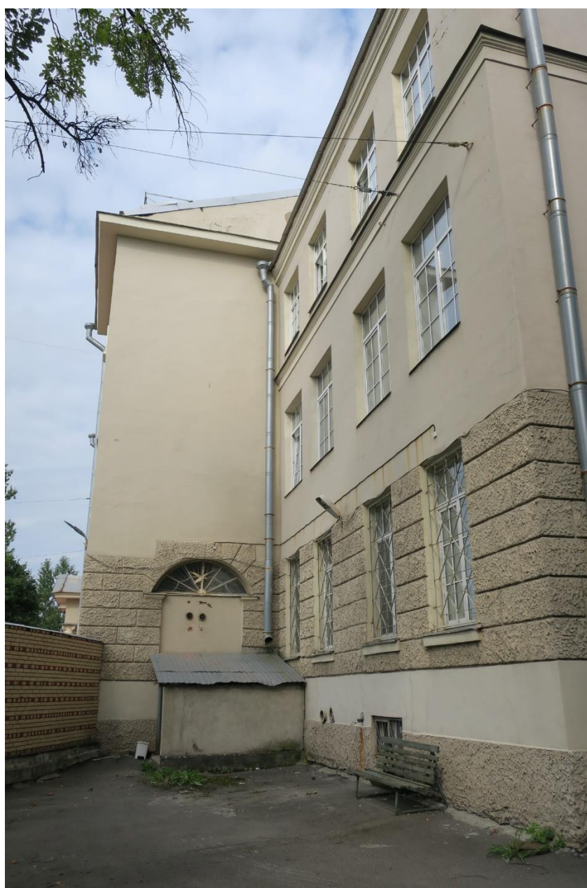
23. Северо-западный лицевой фасад объекта культурного наследия регионального значения «Противоалкогольный институт» (Главное здание)», расположенного по адресу: г. Санкт-Петербург, ул. Бехтерева д. 3, Лит. А. Фрагмент. 26.07.2018
