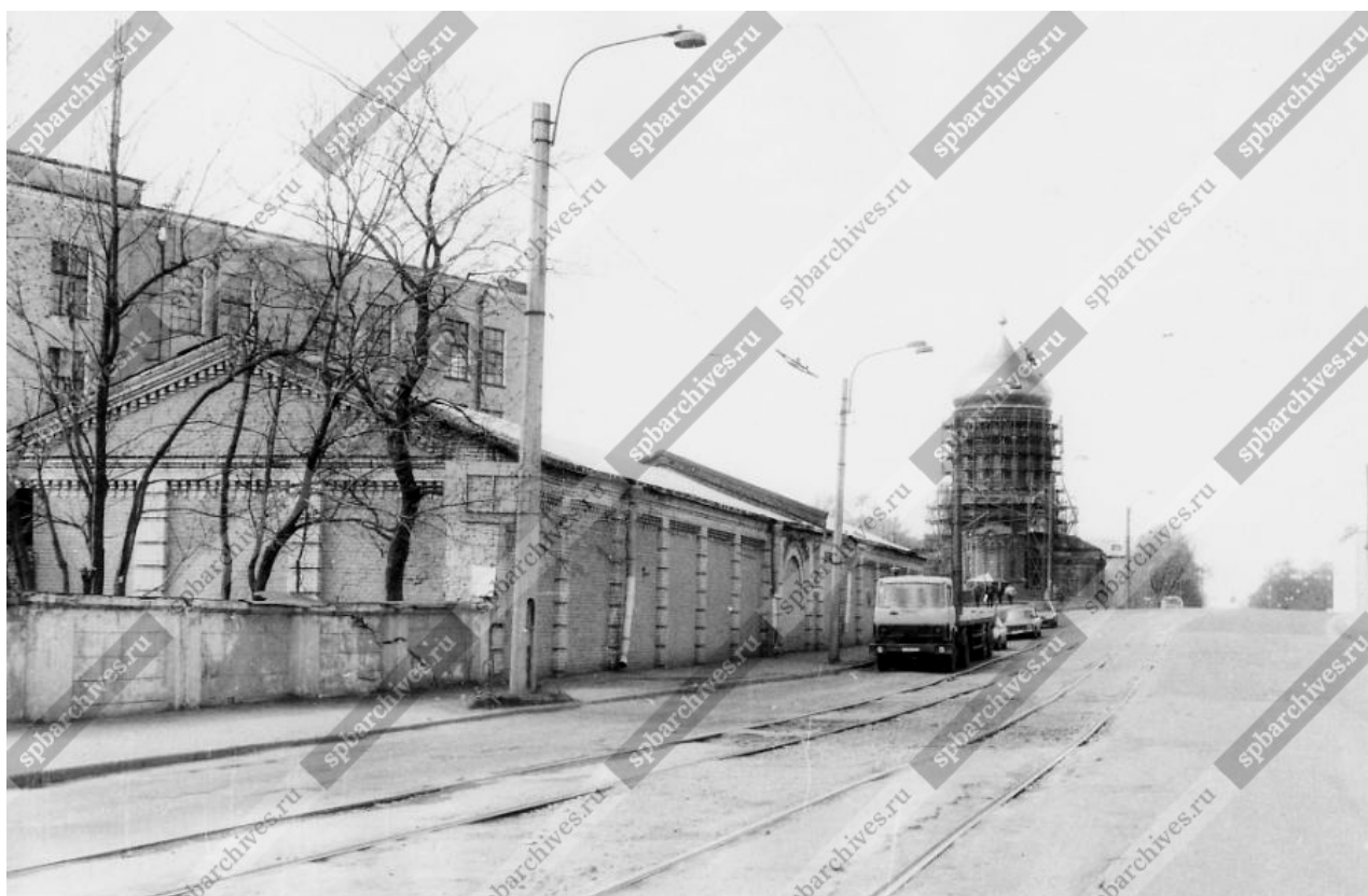
Илл. 31. Вид с левого берега Обводного канала на купол храма Богоявления Господня во время реставрации. 1999 г.— «spbarchives» – Архивы Санкт-Петербурга [Электронный ресурс] URL: https://spbarchives.ru/infres/-/archive/cgakffd/photo/93194
