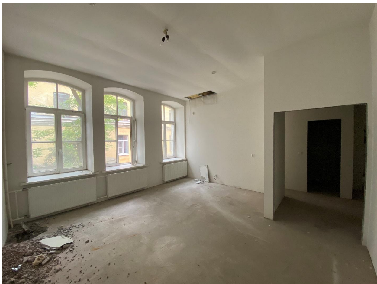
Фото 31. Помещение № 28. 2-й этаж. Вид с юго-запада.
