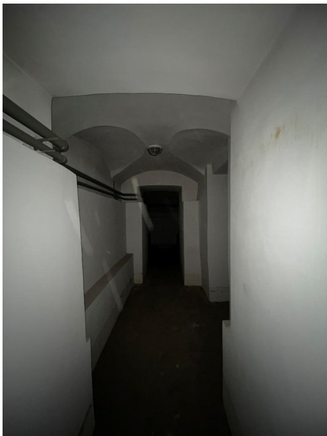
Фото 15. Подвальное помещение № 5. Вид с юго-запада.
