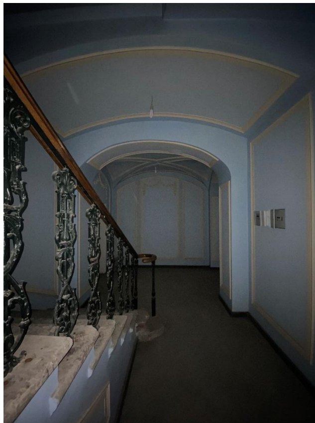
Фото 8. Парадная лестница южного лицевого корпуса. Оформление стен и потолка. 1-й этаж. Вид с юго-востока.
