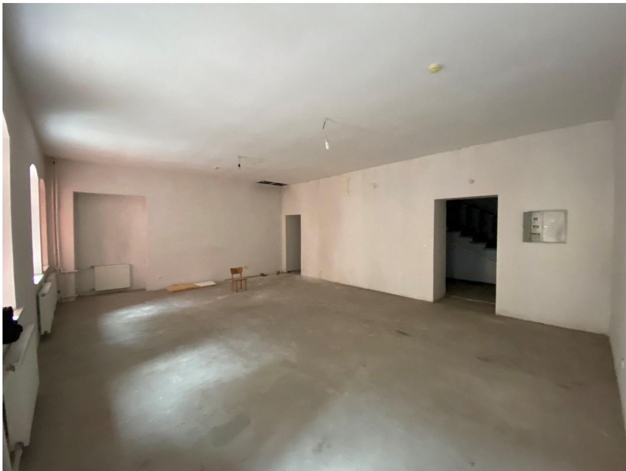
Фото 22. Помещение № 12. Вид с юго-востока.
