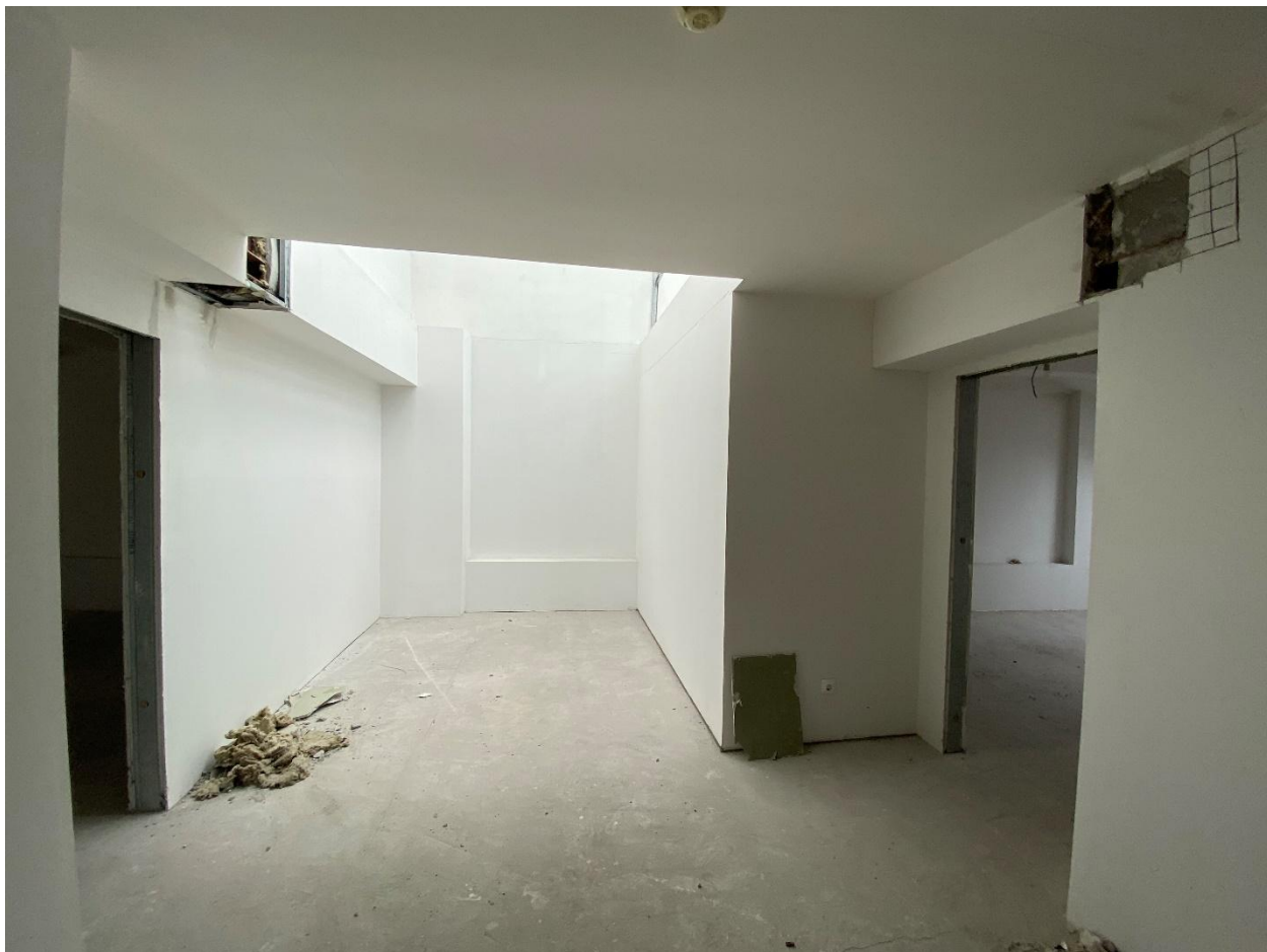
Фото 66. Помещение № 36. 3-й этаж. Вид с юго-запада.
