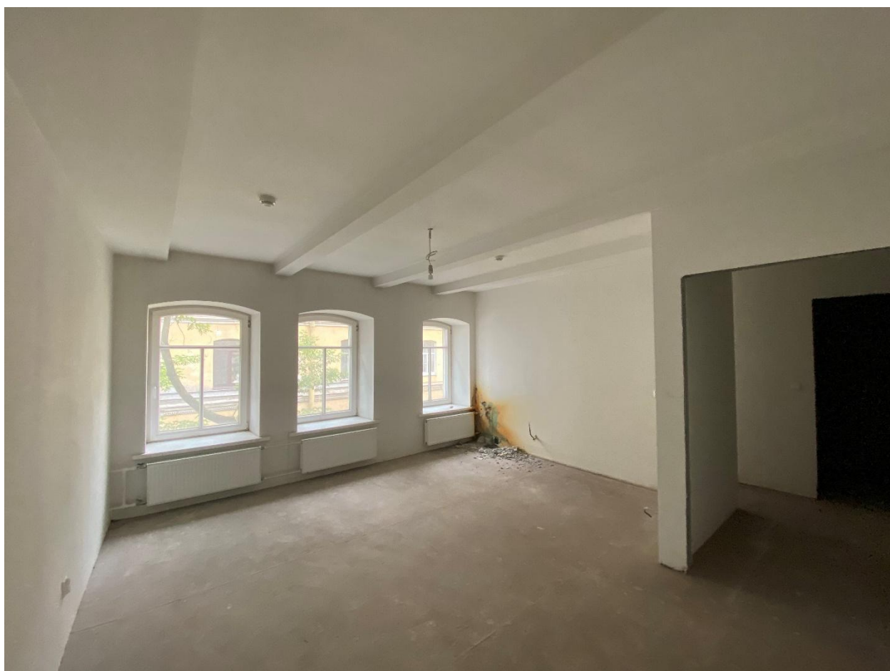
Фото 56. Помещение № 43. 3-й этаж. Вид с юга.
