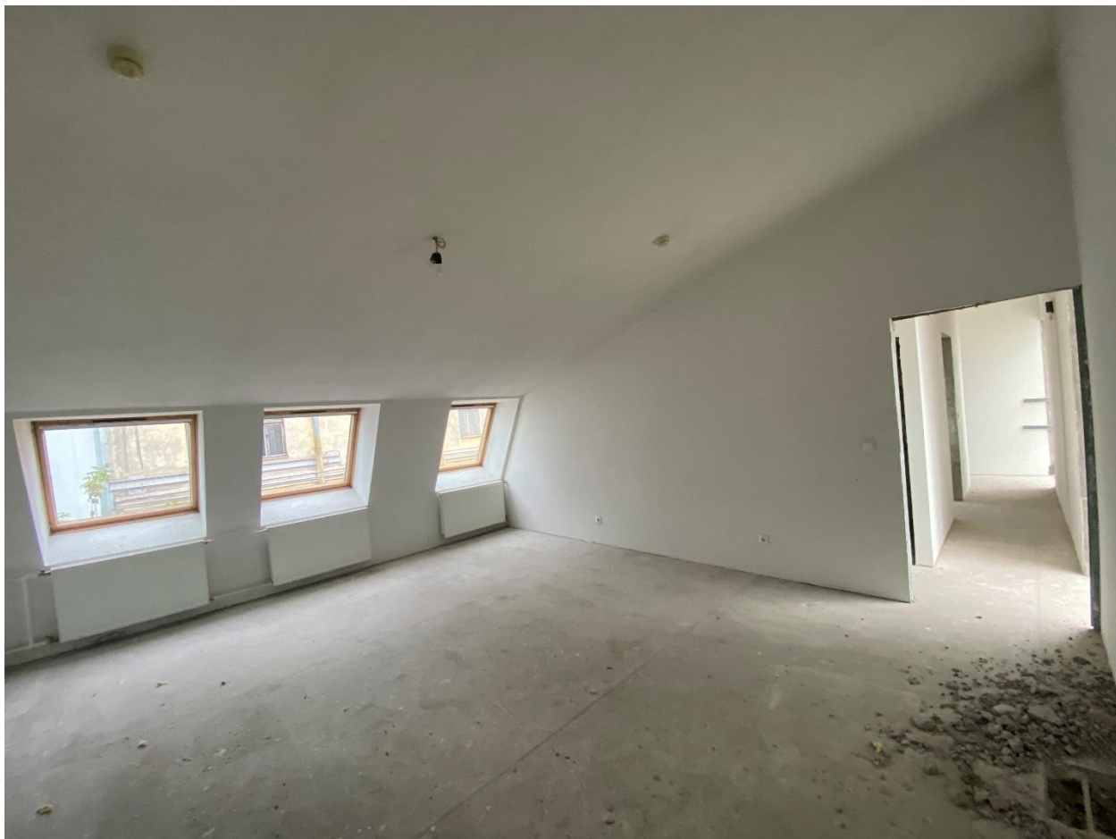
Фото 82. Помещение № 52. 4-й этаж. Вид с юго-запада.
