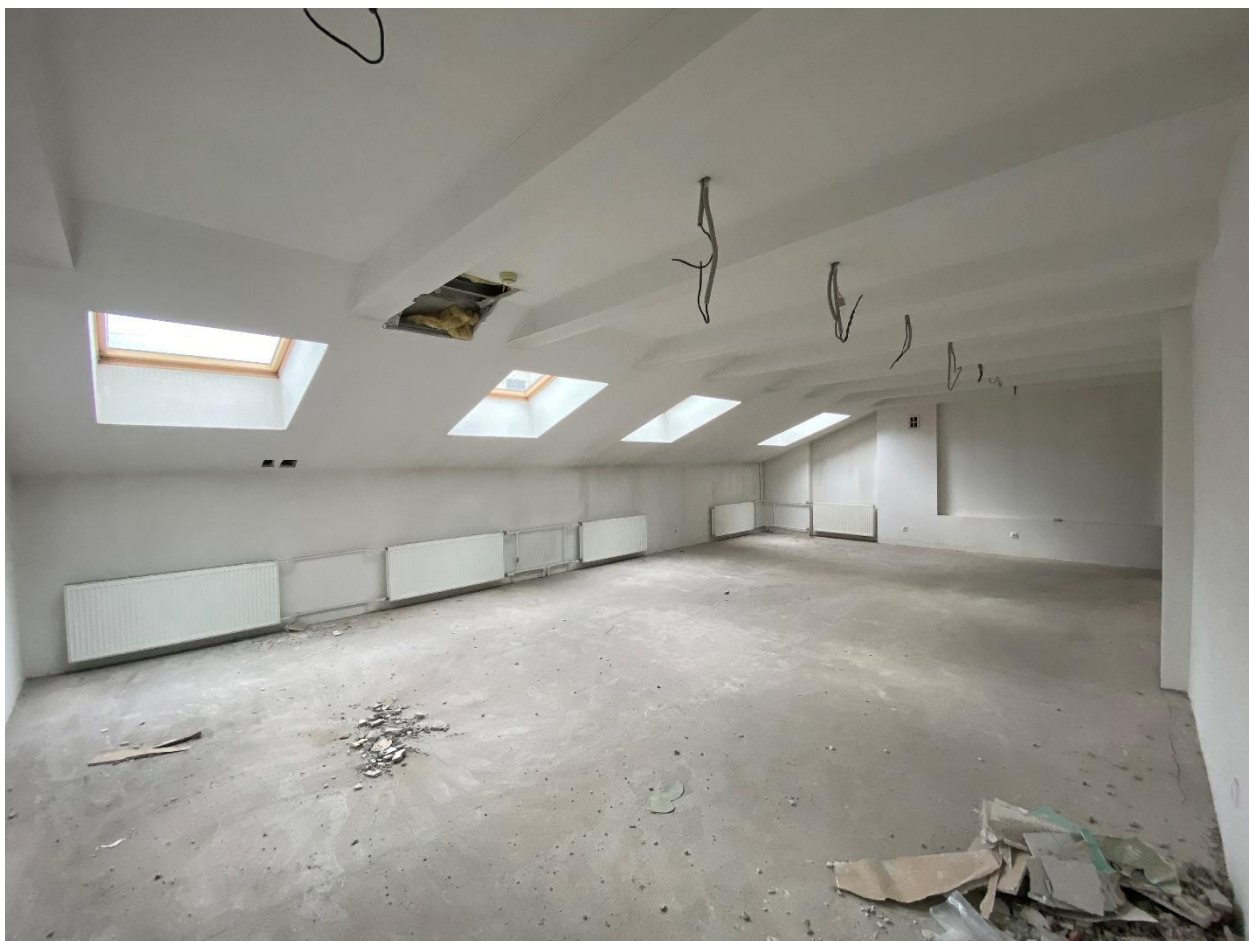
Фото 61. Помещение № 40. 3-й этаж. Вид с северо-востока.
