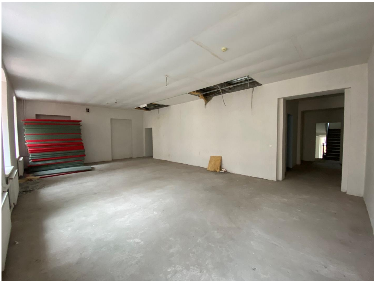
Фото 37. Помещение № 30. 2-й этаж. Вид с востока.
