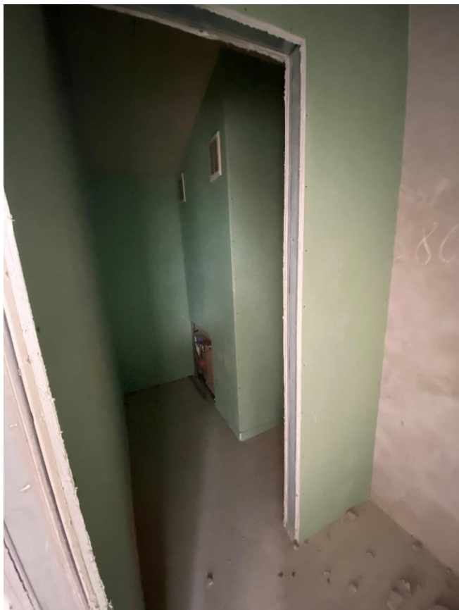
Фото 79. Помещение № 50. 4-й этаж. Вид с юга.
