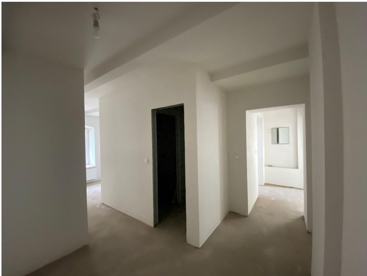
Фото 51. Помещение № 42. 3-й этаж. Вид с юга.
