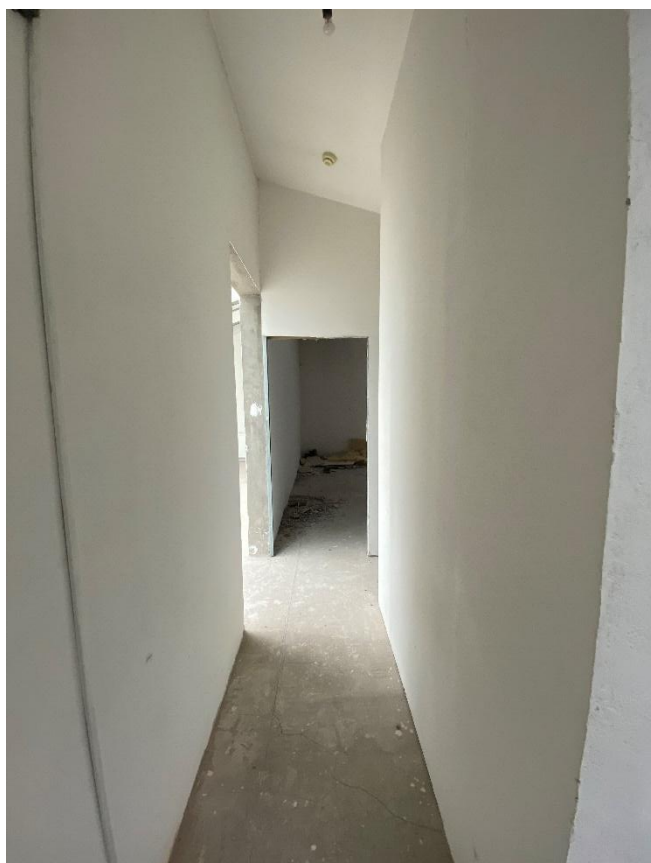
Фото 77. Помещение № 48. 4-й этаж. Вид с северо-востока.
