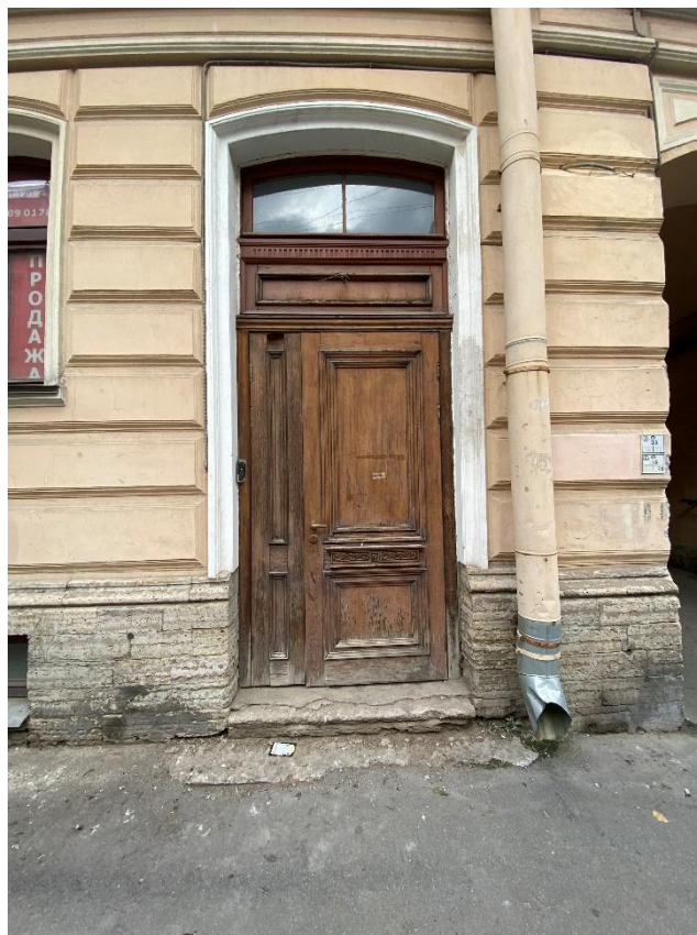
Фото 4. Входное дверное заполнение. Вид с юго-востока.
