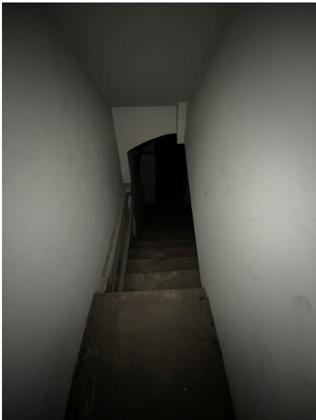
Фото 10. Лестница, ведущая в подвал. Вид с северо-запада.
