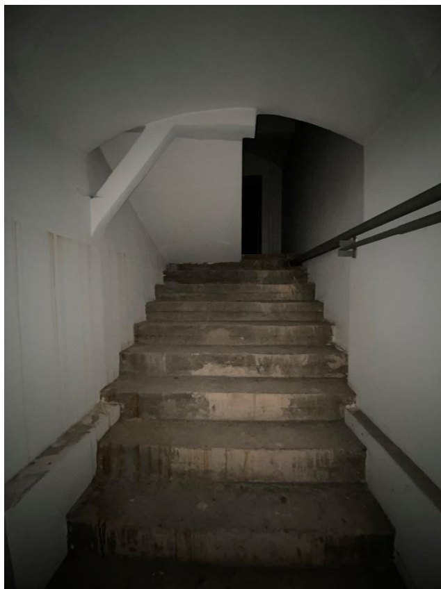
Фото 11. Лестница, ведущая в подвал. Вид с юго-востока.
