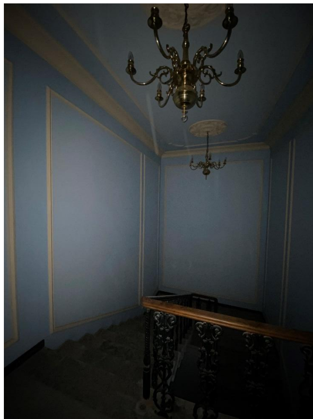
Фото 45. Парадная лестничная клетка. 2-й этаж. Оформление стен. Вид с севера.
