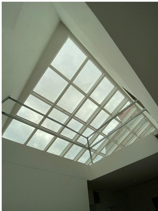
Фото 70. Помещение № 36. 3-й этаж. Вид с севера.
