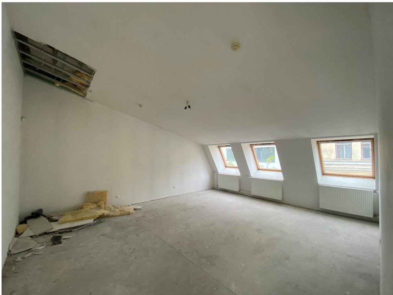
Фото 81. Помещение № 52. 4-й этаж. Вид с северо-востока.
