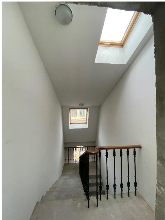
Фото 76. Лестничная клетка 1-Н. 4-й этаж. Вид с юго-востока.
