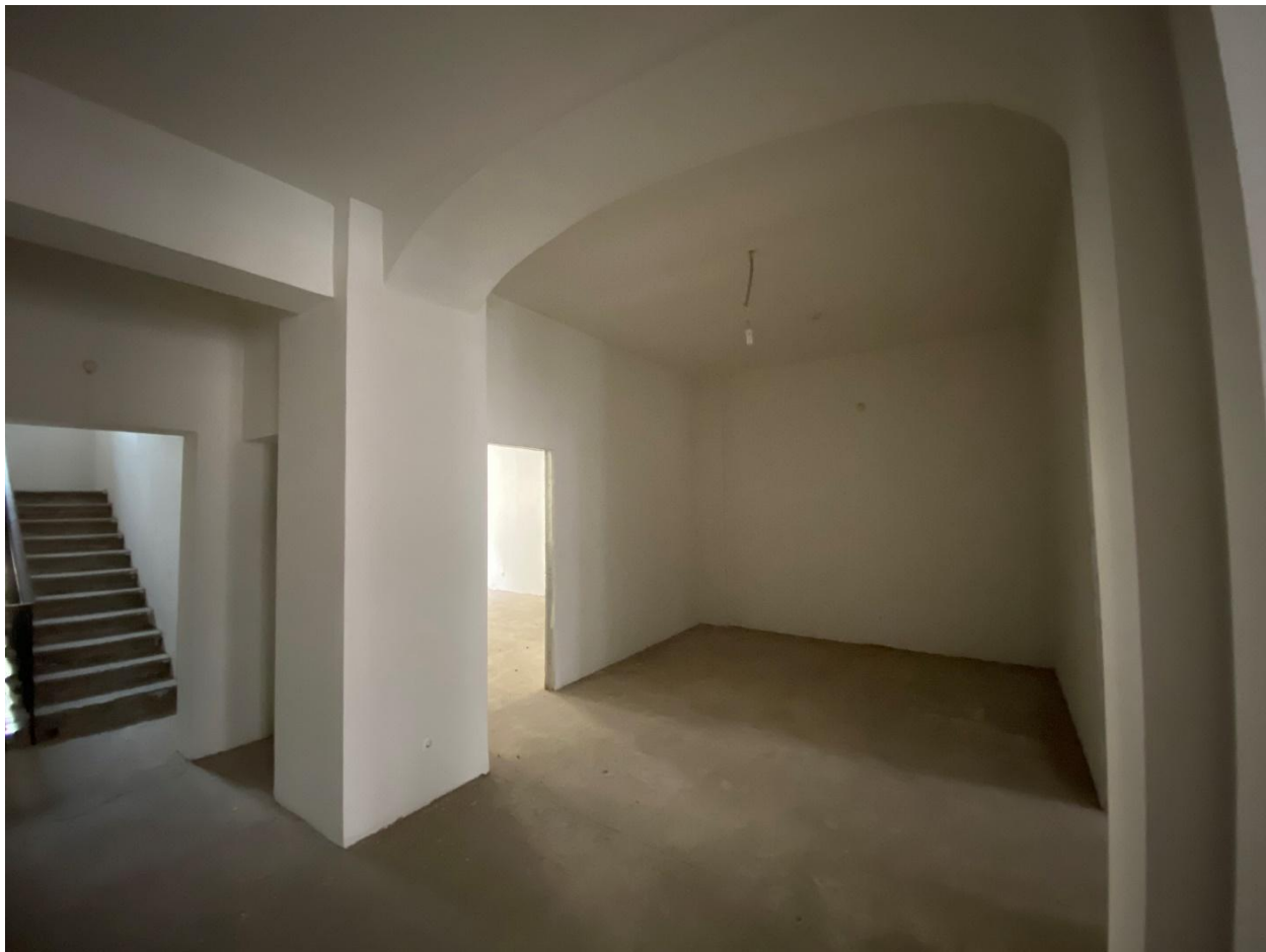
Фото 38. Помещение № 31, 32. 2-й этаж. Вид с юго-запада.
