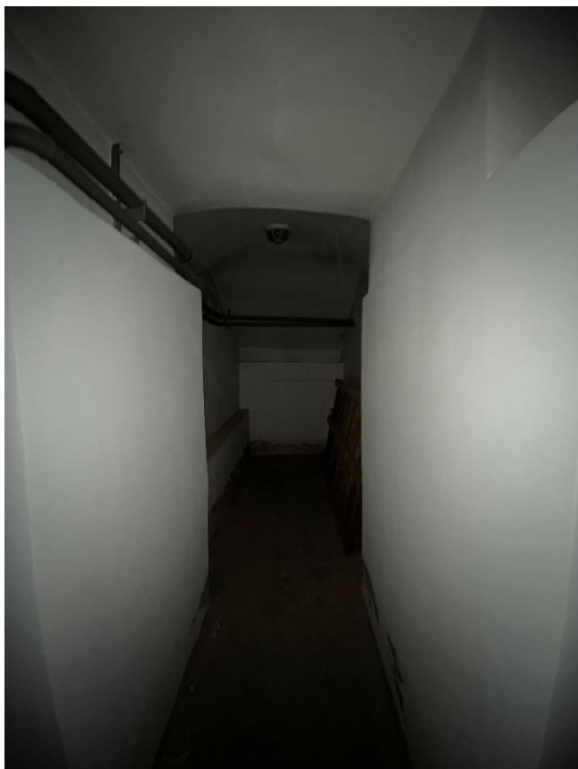
Фото 18. Подвальное помещение № 3. Вид с севера.
