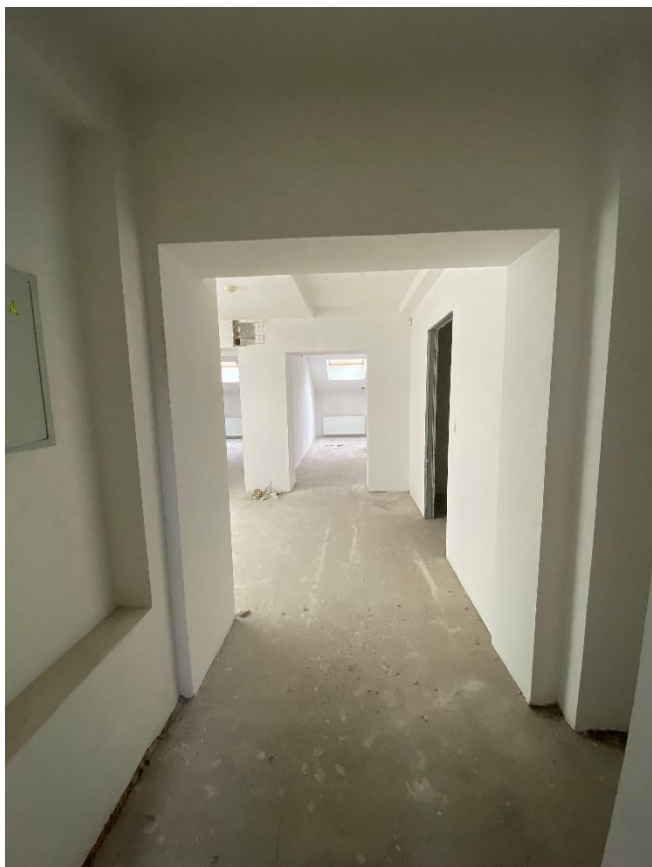
Фото 49. Помещение № 35. 3-й этаж. Вид с северо-запада.
