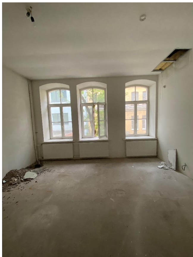
Фото 30. Помещение № 28. 2-й этаж. Вид с юго-востока.
