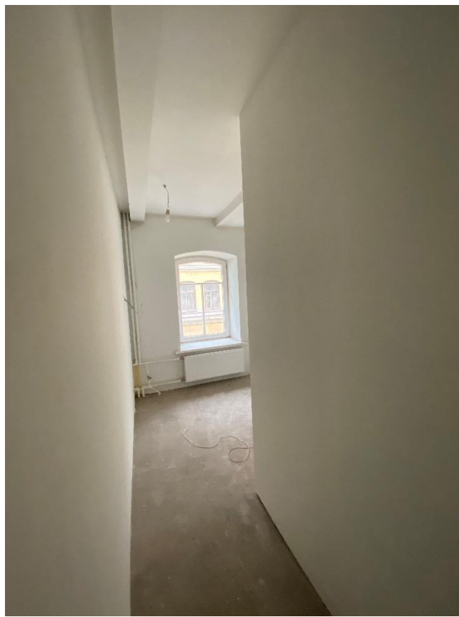
Фото 53. Помещение № 42. 3-й этаж. Вид с юго-востока.
