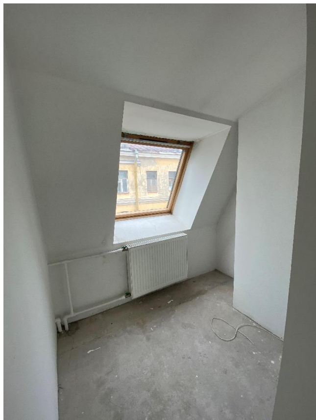
Фото 80. Помещение № 49. 4-й этаж. Вид с юга.
