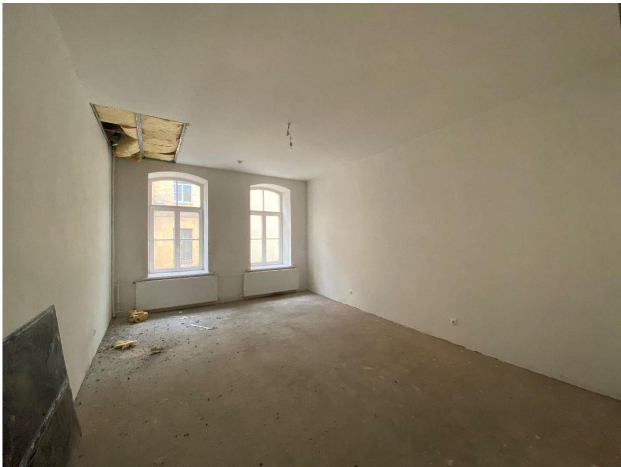
Фото 42. Помещение № 34. 2-й этаж. Вид с юго-востока.
