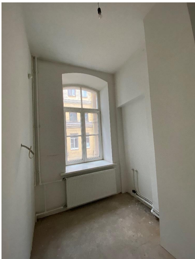
Фото 29. Помещение № 27. 2-й этаж. Вид с юга.
