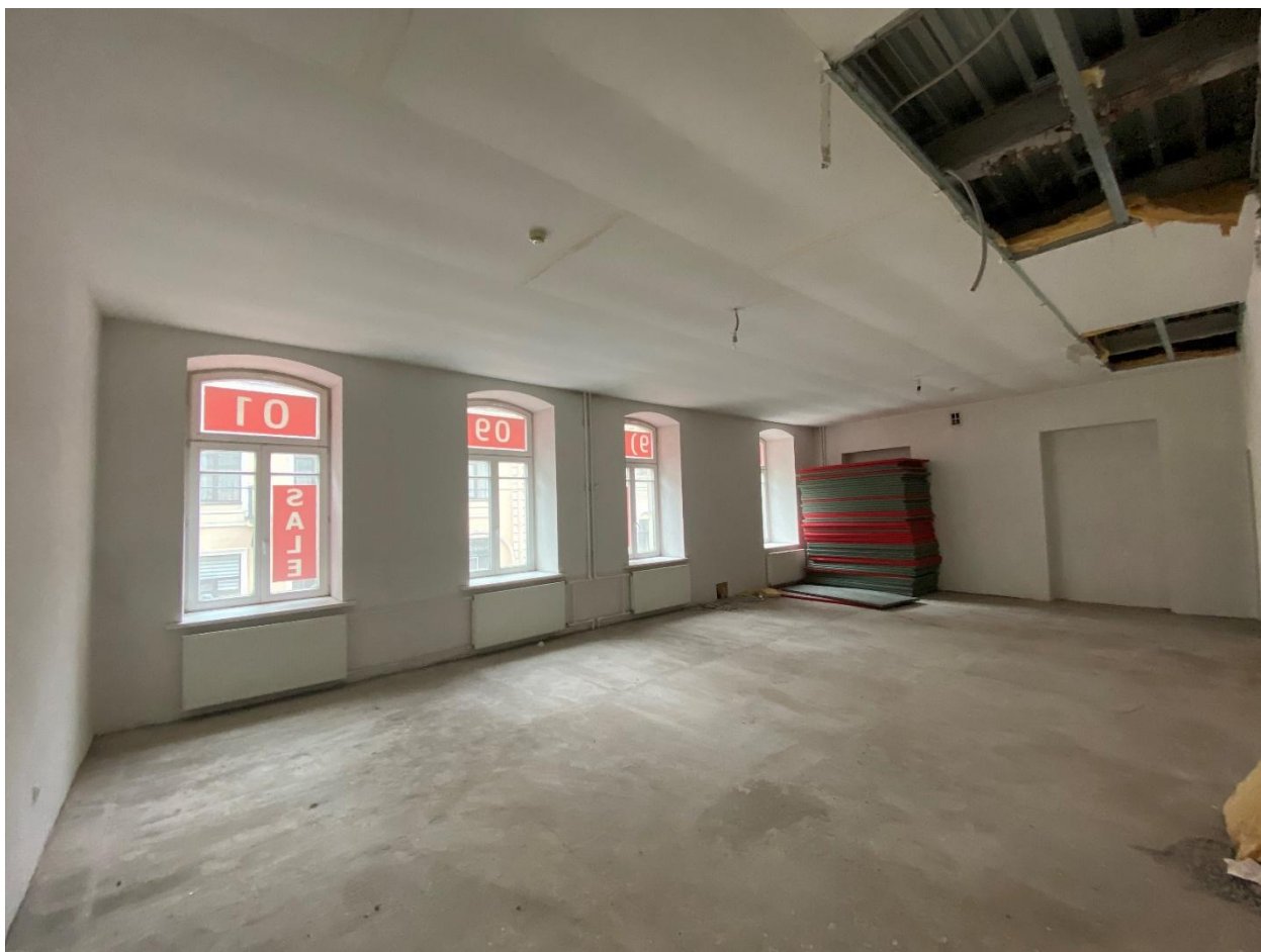
Фото 36. Помещение № 30. 2-й этаж. Вид с севера.
