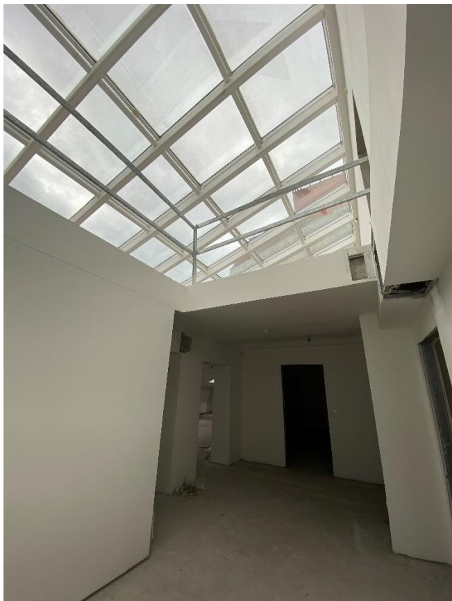
Фото 69. Помещение № 36. 3-й этаж. Вид с северо-востока.
