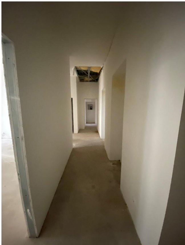
Фото 39. Помещение № 24. 2-й этаж. Вид с юго-запада.
