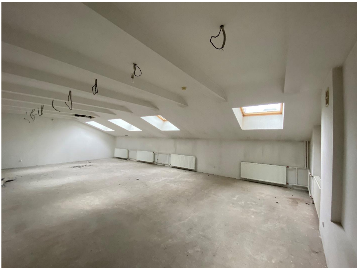
Фото 60. Помещение № 40. 3-й этаж. Вид с запада.
