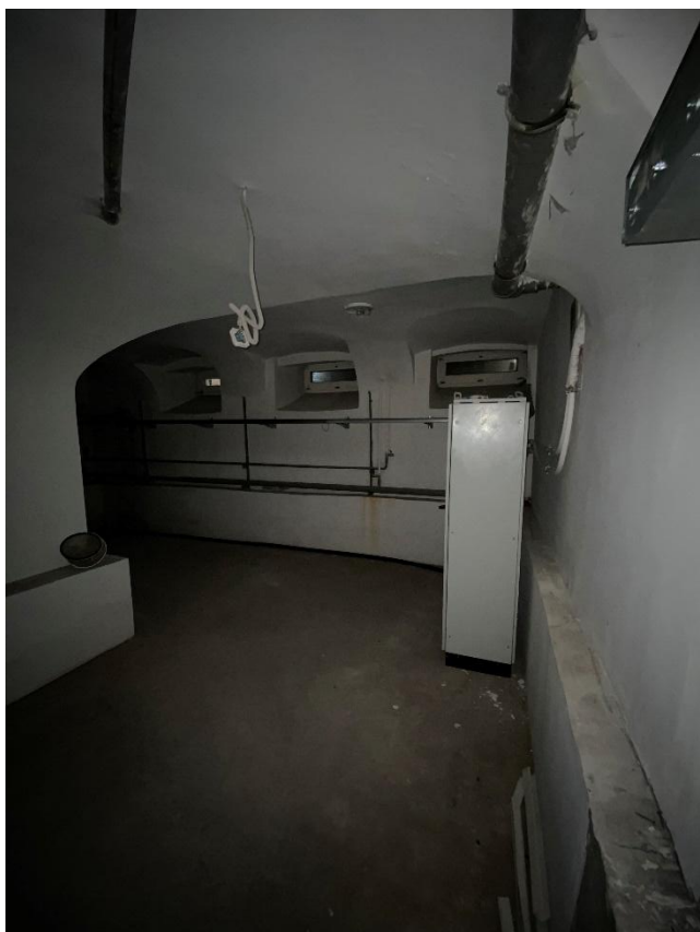
Фото 12. Подвальное помещение № 6. Вид с юга.
