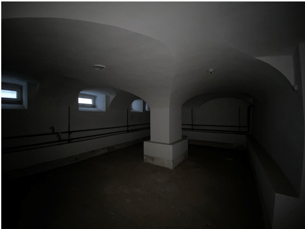
Фото 17. Подвальное помещение № 4. Вид с северо-востока.
