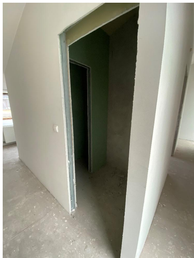
Фото 78. Помещение № 51. 4-й этаж. Вид с юга.
