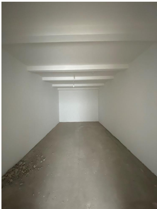
Фото 63. Помещение № 39. 3-й этаж. Вид с северо-востока.
