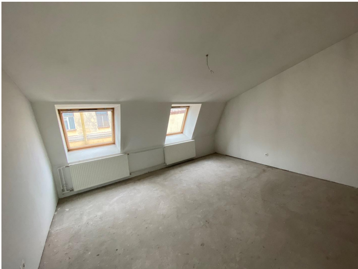
Фото 86. Помещение № 54. 4-й этаж. Вид с юга.
