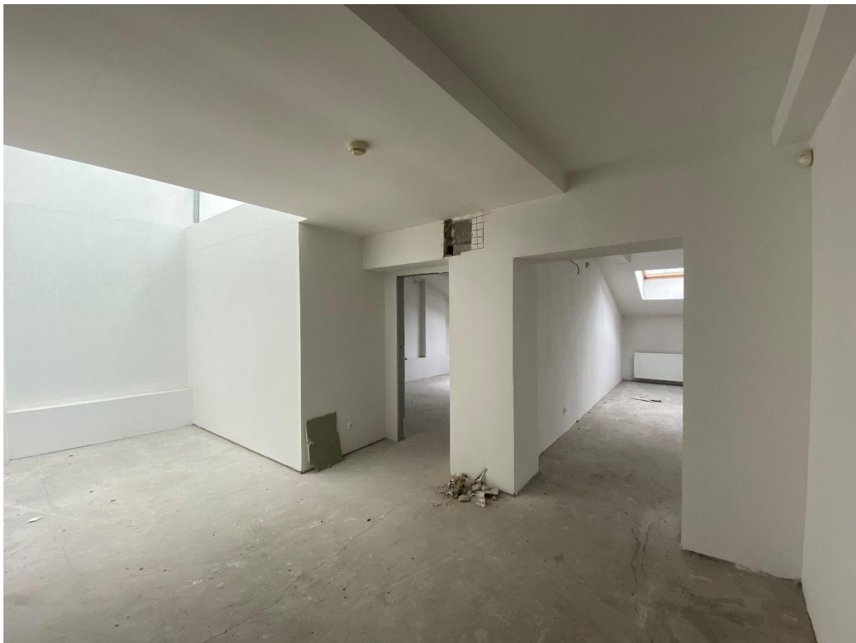
Фото 65. Помещение № 36. 3-й этаж. Вид с запада.
