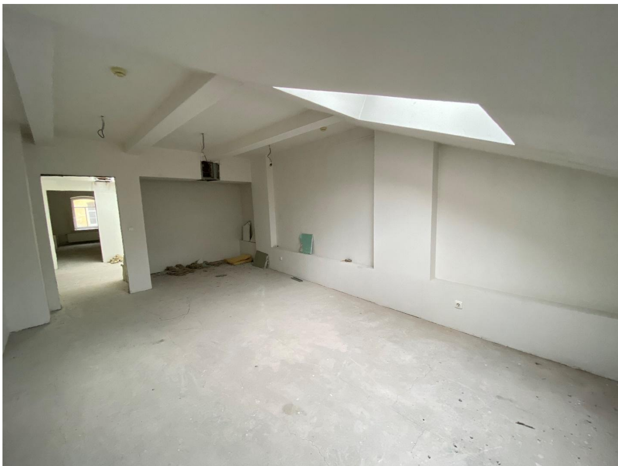
Фото 68. Помещение № 38. 3-й этаж. Вид с юго-востока.
