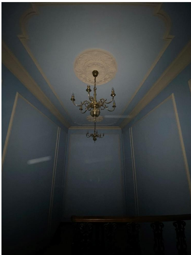
Фото 44. Парадная лестничная клетка. 2-й этаж. Оформление потолка. Вид с северо-востока.
