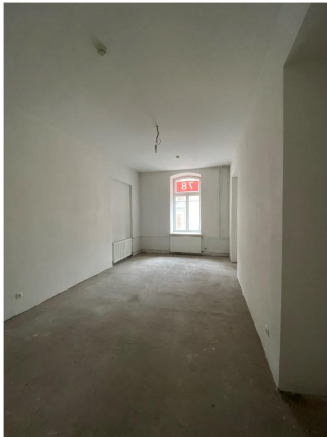
Фото 40. Помещение № 33. 2-й этаж. Вид с северо-запада.
