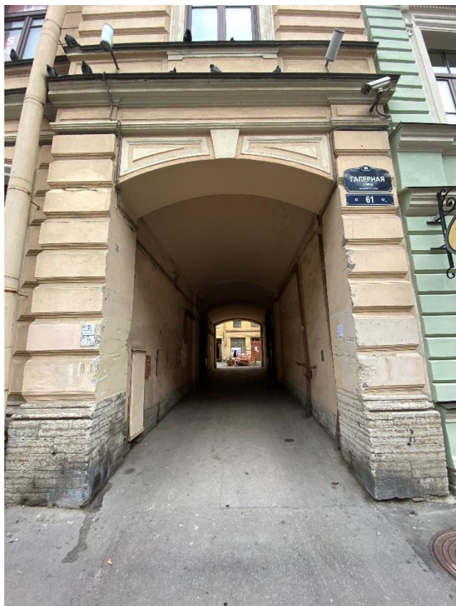
Фото 3. Арка воротного проезда. Вид с юго-востока.
