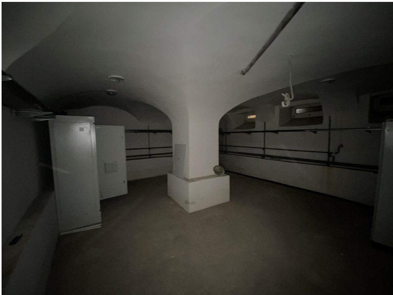
Фото 14. Подвальное помещение № 6. Вид с северо-востока.
