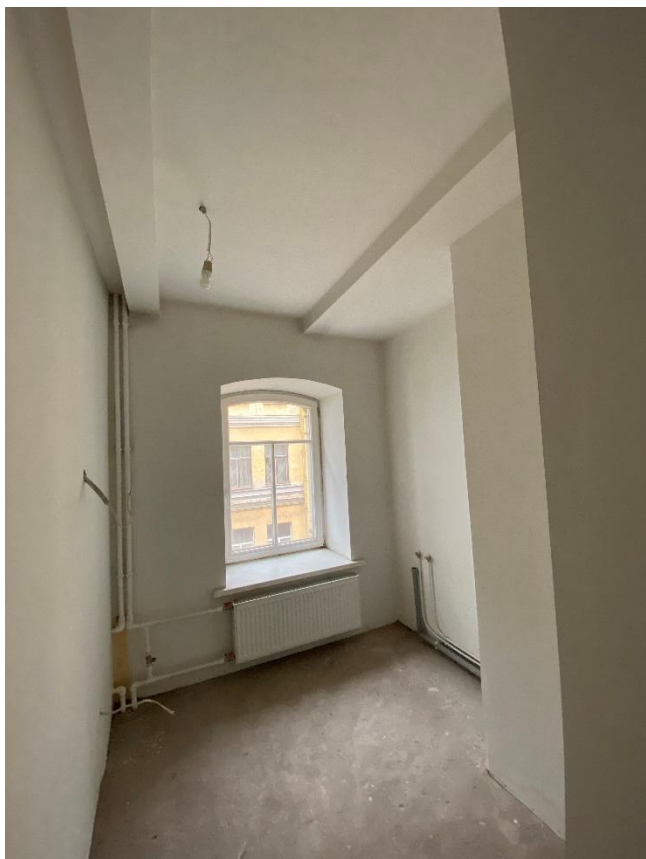
Фото 54. Помещение № 44. 3-й этаж. Вид с юго-востока.
