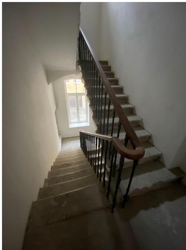
Фото 24. Лестничная клетка 1-Н. 2-й этаж. Вид с юго-востока.
