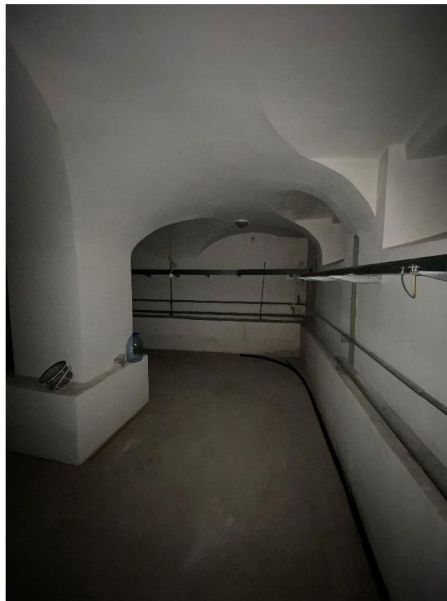
Фото 13. Подвальное помещение № 6. Вид с северо-востока.
