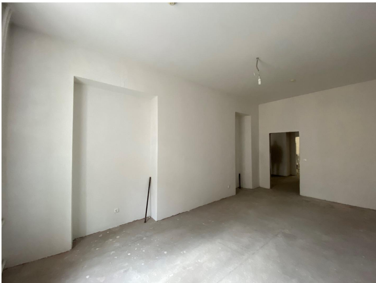
Фото 41. Помещение № 33. 2-й этаж. Вид с востока.
