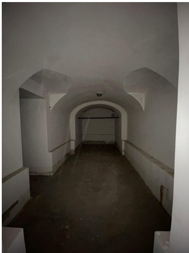
Фото 16. Подвальное помещение № 5. Вид с северо-востока.
