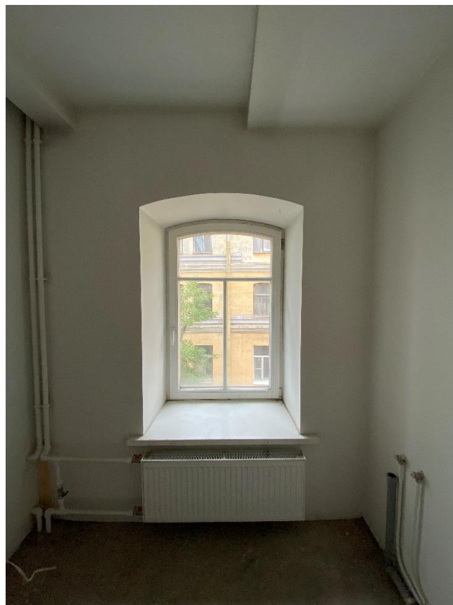
Фото 55. Помещение № 44. 3-й этаж. Вид с юго-востока.
