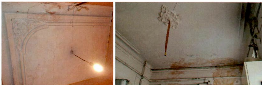
24, 25, 26. лестница Л-2 дворового корпуса
