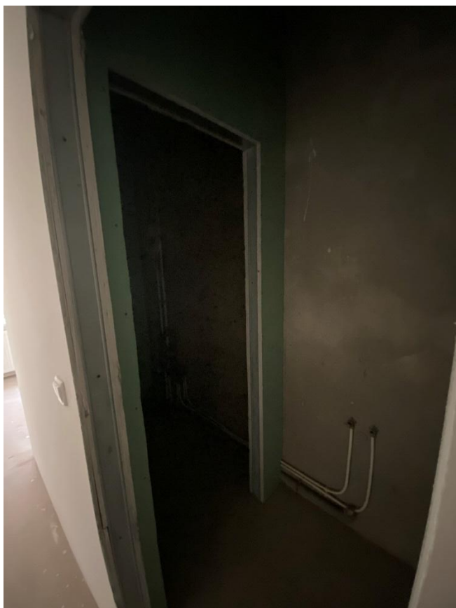
Фото 27. Помещение № 25, 26. 2-й этаж. Вид с юга.
