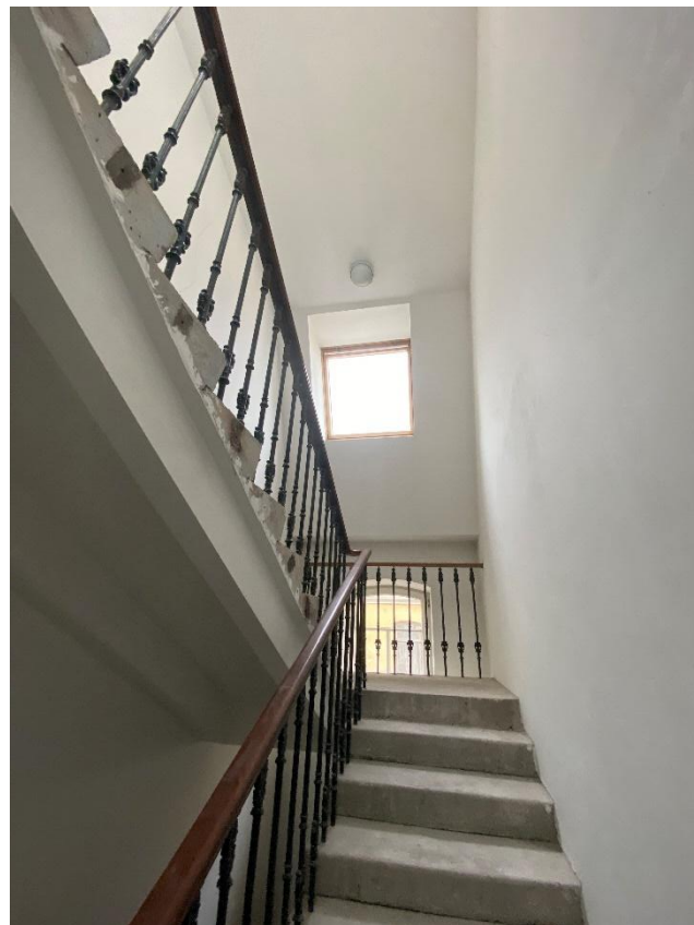
Фото 74. Лестничная клетка 1-Н. 3-й этаж. Вид с юго-востока.
