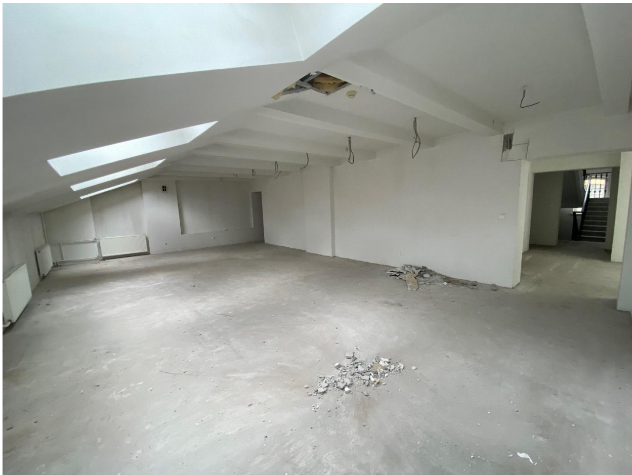
Фото 62. Помещение № 40. 3-й этаж. Вид с востока.
