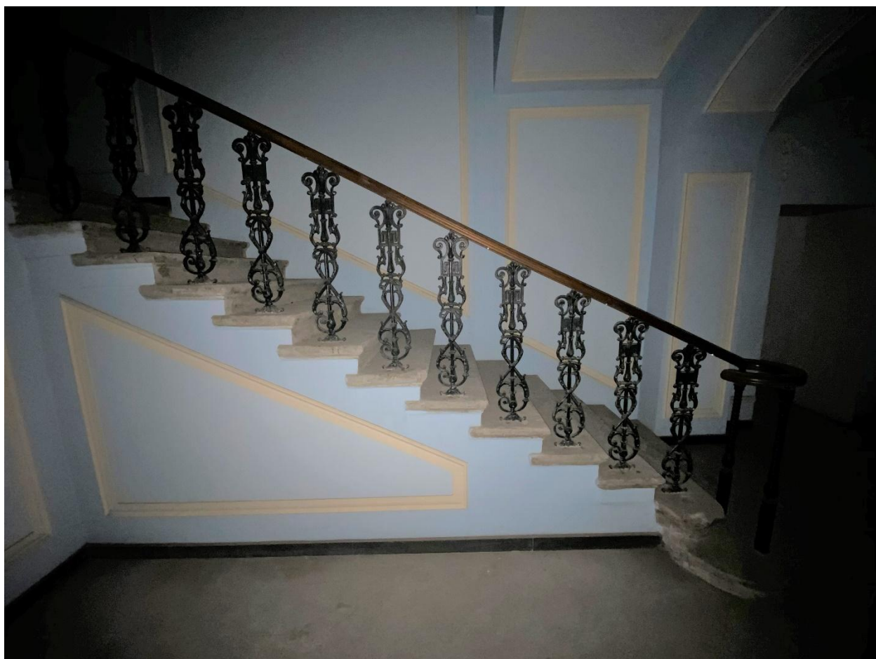
Фото 9. Кованое ограждение парадной лестницы южного лицевого корпуса. 1-й этаж. Вид с юга.
