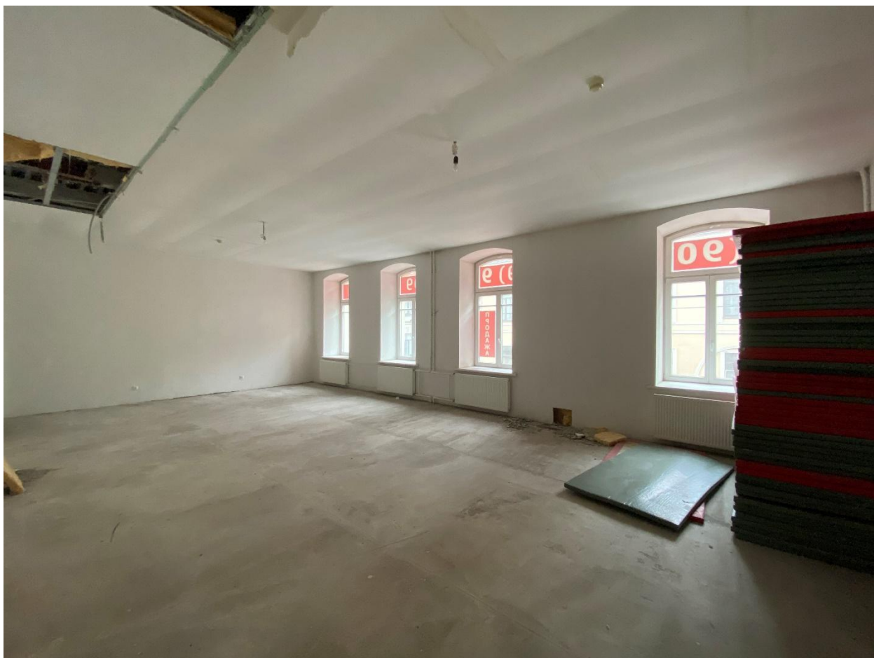
Фото 35. Помещение № 30. 2-й этаж. Вид с запада.
