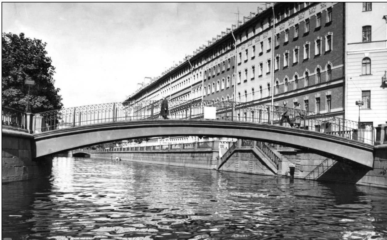
Илл. 32. Сенной мост через канал Грибоедова. Фотография. Автор съемки: неизвестен. 1973 г.
