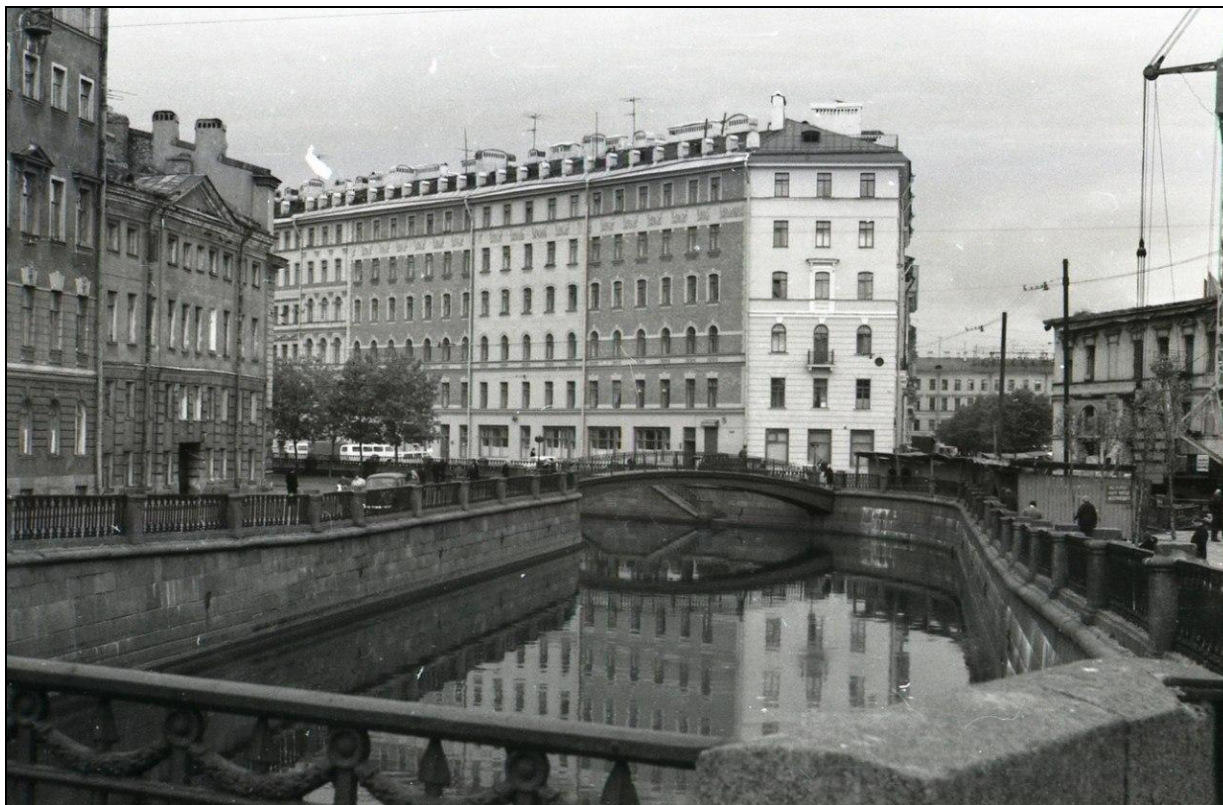
Илл. 31. Сенной мост через канал Грибоедова. Фотография. Автор съемки: неизвестен. 1975 г.
