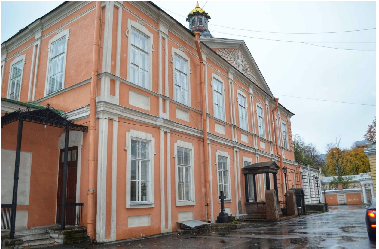
Фото 54. ОКН федерального значения «Корпус Духовской» (наб. реки Монастырки, дом 1, литера Д). Восточный фасад. Фрагмент. Съёмка 23.10.2020 г.
