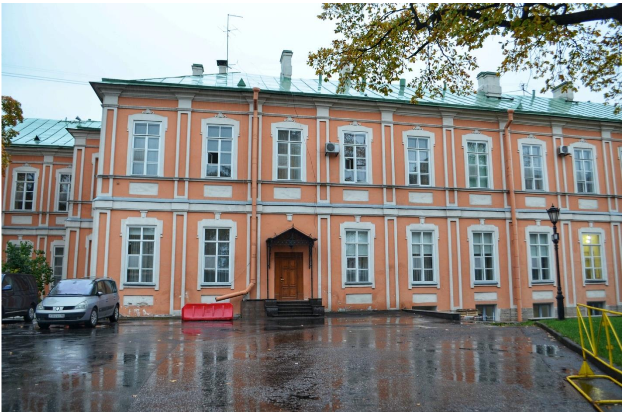
Фото 38. ОКН федерального значения «Корпус Духовской» (наб. реки Монастырки, дом 1, литера Д). Восточный фасад. Фрагмент. Съёмка 23.10.2020 г.
