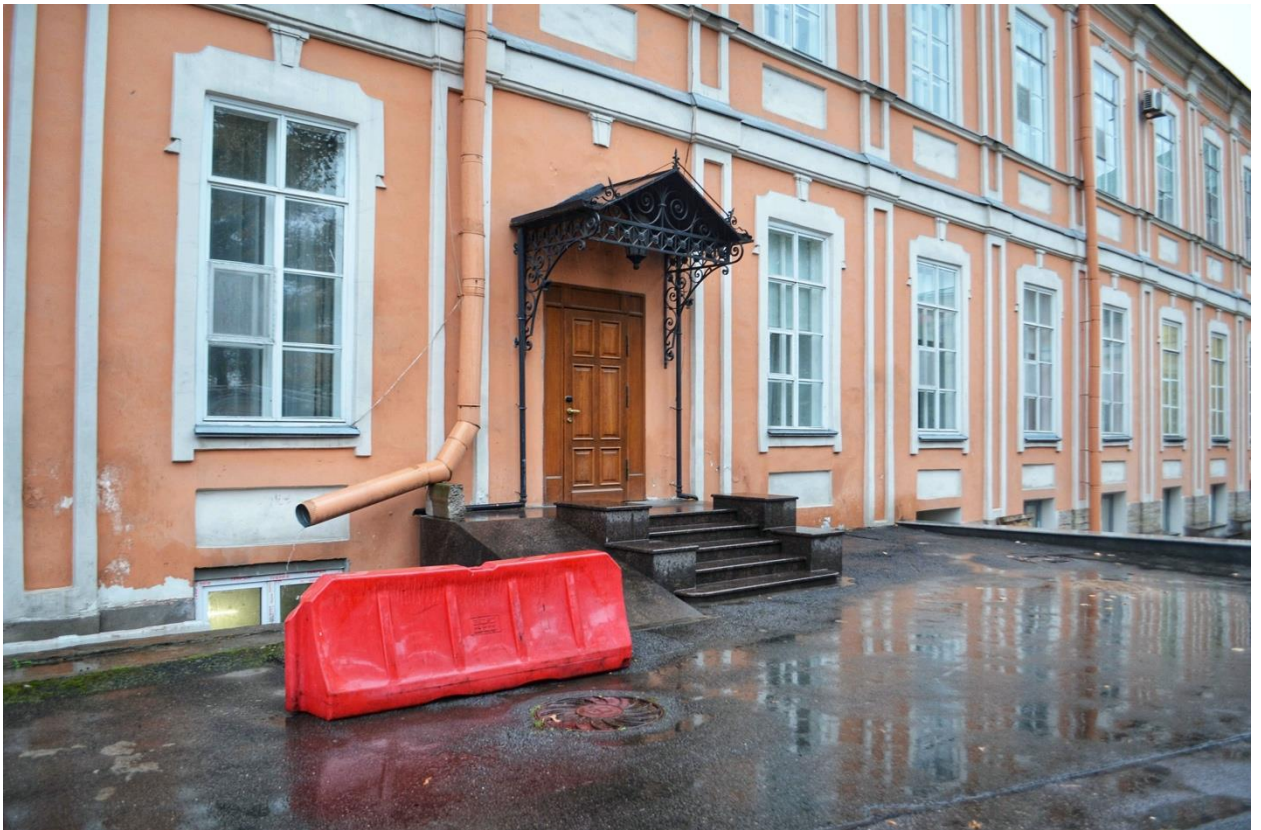
Фото 39. ОКН федерального значения «Корпус Духовской» (наб. реки Монастырки, дом 1, литера Д). Восточный фасад. Крыльцо. Фрагмент. Съёмка 23.10.2020 г.
