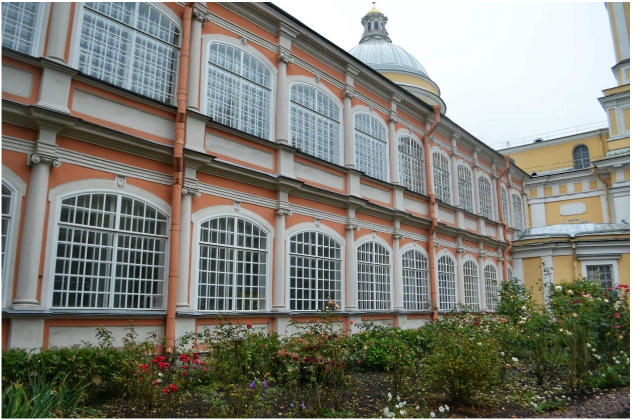
Фото 19. ОКН федерального значения «Корпус Духовской» (наб. реки Монастырки, дом 1, литера Д). Западный фасад. Фрагмент. Съёмка 23.10.2020 г.
