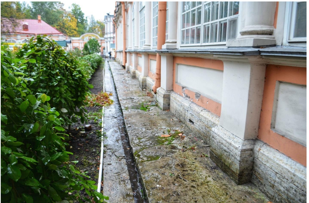
Фото 16. ОКН федерального значения «Корпус Духовской» (наб. реки Монастырки, дом 1, литера Д). Западный фасад. Фрагмент. Съёмка 23.10.2020 г.
