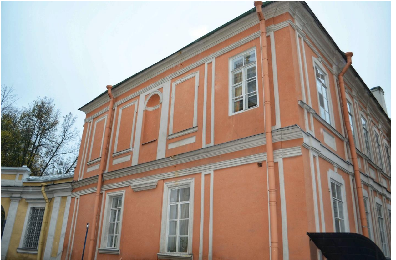
Фото 27. ОКН федерального значения «Корпус Духовской» (наб. реки Монастырки, дом 1, литера Д). Южный фасад. Фрагмент. Съемка 23.10.2020 г.
