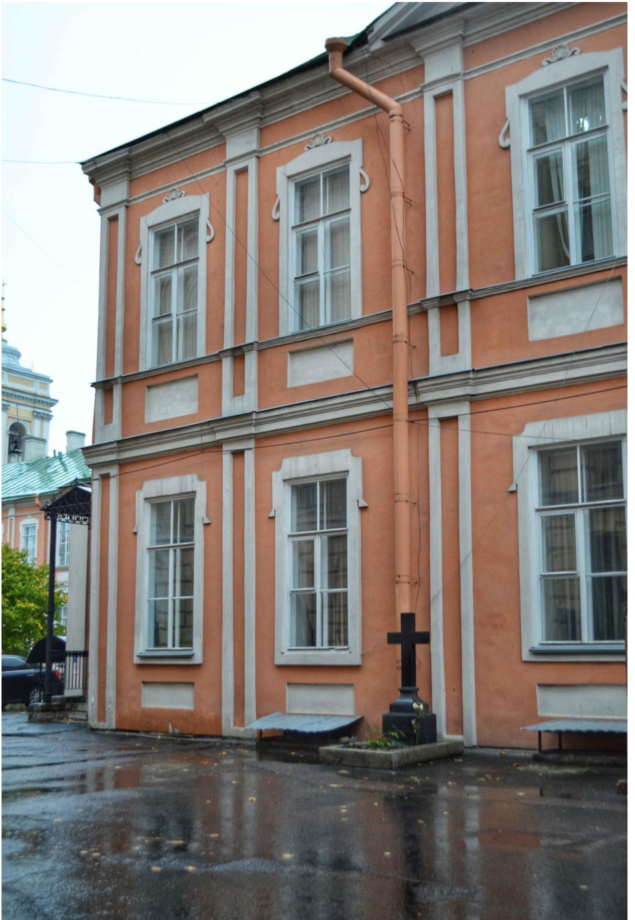
Фото 56. ОКН федерального значения «Корпус Духовской» (наб. реки Монастырки, дом 1, литера Д). Восточный фасад. Фрагмент. Съёмка 23.10.2020 г.
