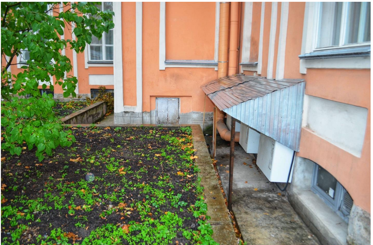
Фото 36. ОКН федерального значения «Корпус Духовской» (наб. реки Монастырки, дом 1, литера Д). Восточный фасад. Фрагмент. Съёмка 23.10.2020 г.
