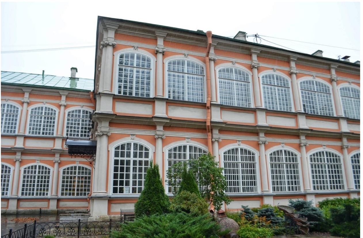
Фото 12. ОКН федерального значения «Корпус Духовской» (наб. реки Монастырки, дом 1, литера Д). Западный фасад. Фрагмент. Съёмка 23.10.2020 г.
