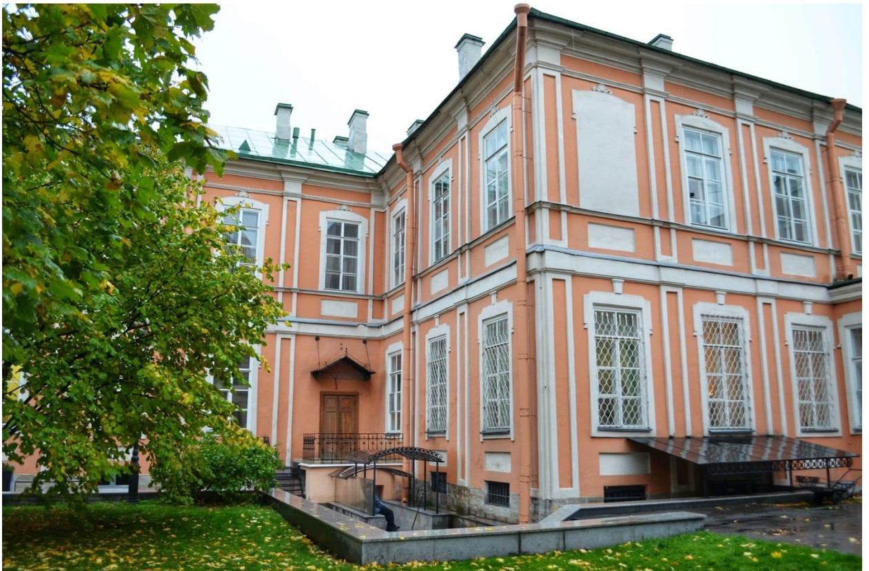
Фото 44. ОКН федерального значения «Корпус Духовской» (наб. реки Монастырки, дом 1, литера Д). Восточный фасад. Фрагмент. Съёмка 23.10.2020 г.
