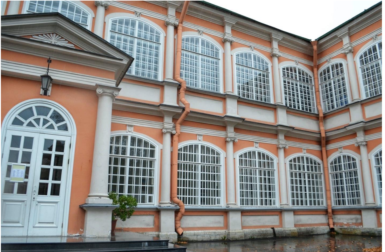
Фото 07. ОКН федерального значения «Корпус Духовской» (наб. реки Монастырки, дом 1, литера Д). Западный фасад. Фрагмент. Съёмка 23.10.2020 г.
