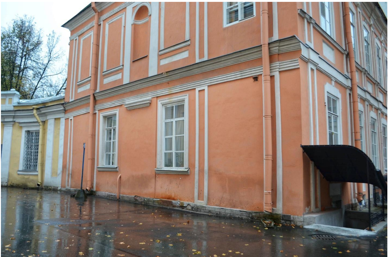
Фото 28. ОКН федерального значения «Корпус Духовской» (наб. реки Монастырки, дом 1, литера Д). Южный фасад. Фрагмент. Съемка 23.10.2020 г.
