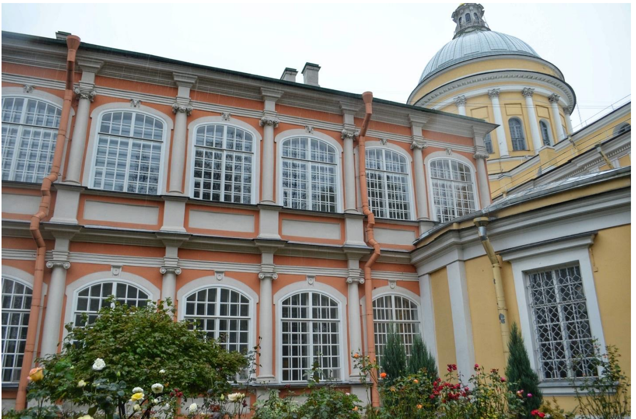
Фото 20. ОКН федерального значения «Корпус Духовской» (наб. реки Монастырки, дом 1, литера Д). Западный фасад. Фрагмент. Съёмка 23.10.2020 г.
