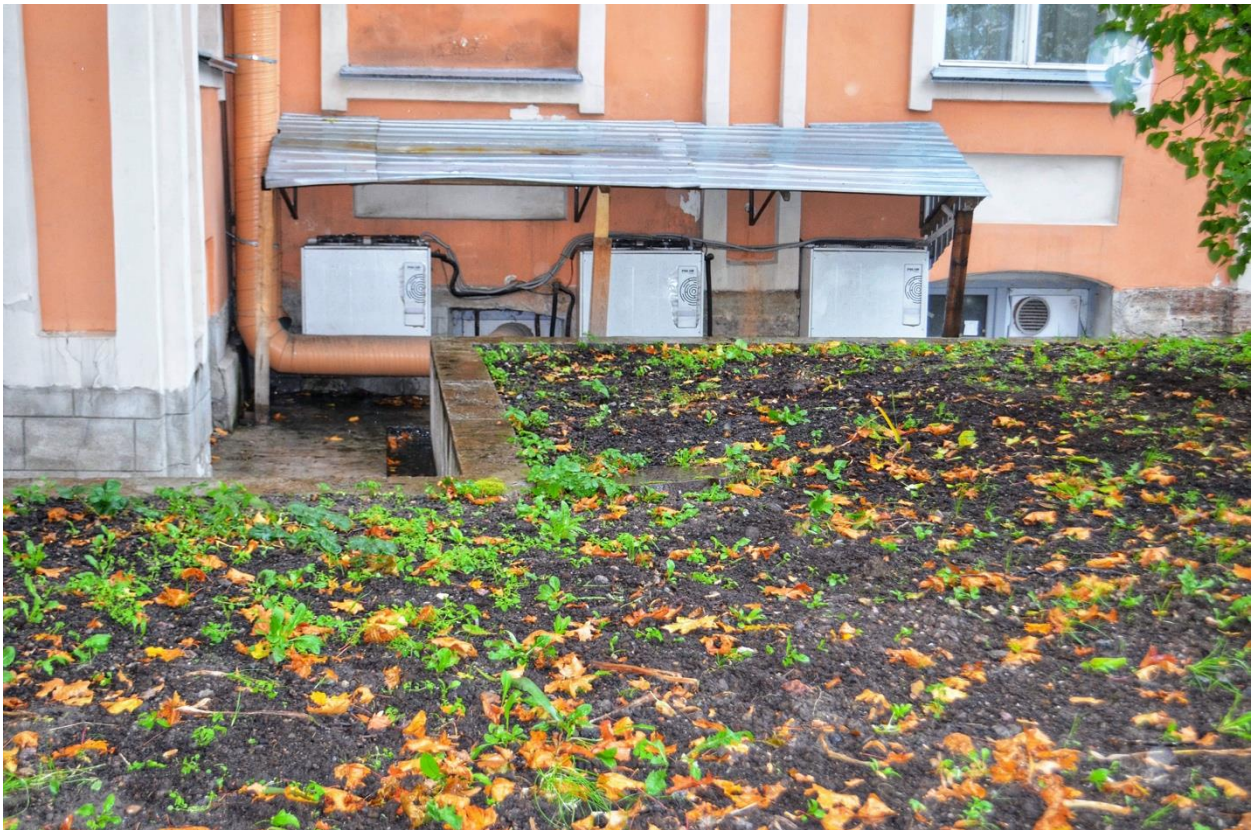
Фото 35. ОКН федерального значения «Корпус Духовской» (наб. реки Монастырки, дом 1, литера Д). Восточный фасад. Фрагмент. Съёмка 23.10.2020 г.
