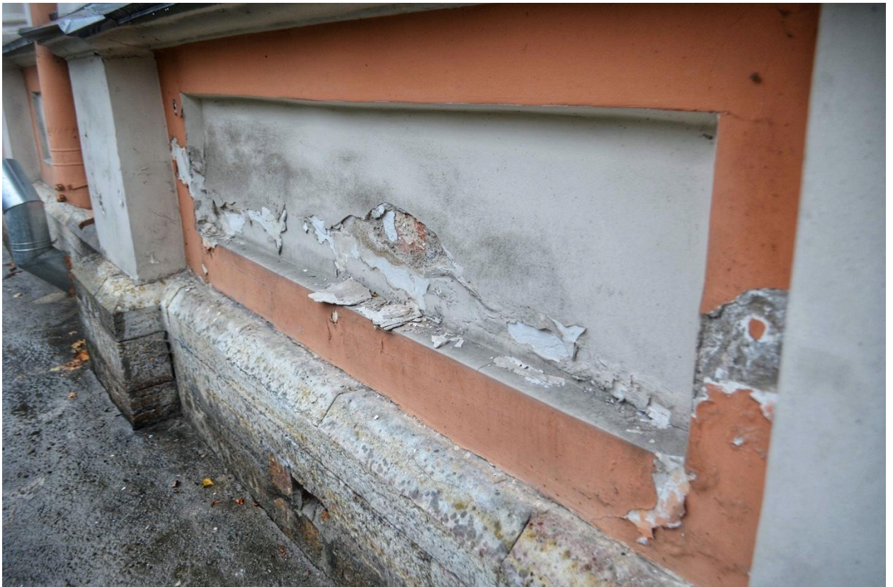
Фото 23. ОКН федерального значения «Корпус Духовской» (наб. реки Монастырки, дом 1, литера Д). Западный фасад. Фрагмент. Съёмка 23.10.2020 г.
