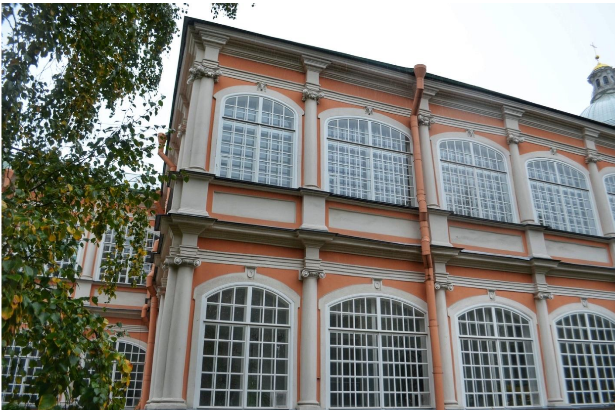
Фото 18. ОКН федерального значения «Корпус Духовской» (наб. реки Монастырки, дом 1, литера Д). Западный фасад. Фрагмент. Съёмка 23.10.2020 г.
