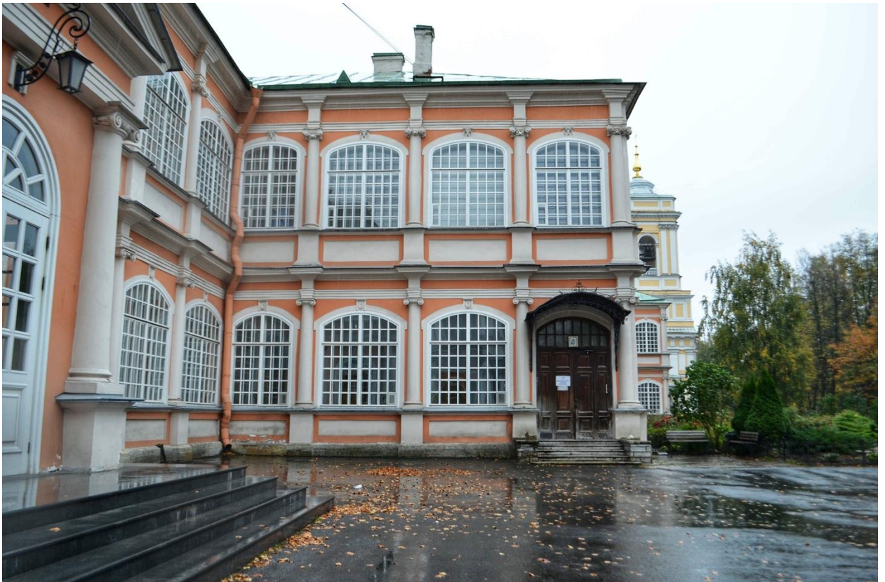
Фото 09. ОКН федерального значения «Корпус Духовской» (наб. реки Монастырки, дом 1, литера Д). Западный фасад. Фрагмент. Съёмка 23.10.2020 г.
