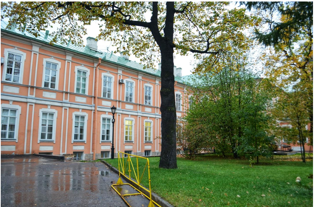
Фото 42. ОКН федерального значения «Корпус Духовской» (наб. реки Монастырки, дом 1, литера Д). Восточный фасад. Фрагмент. Съёмка 23.10.2020 г.
