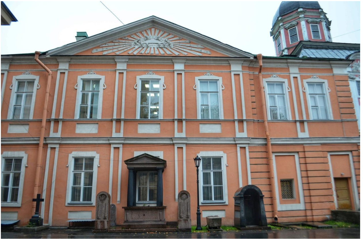
Фото 57. ОКН федерального значения «Корпус Духовской» (наб. реки Монастырки, дом 1, литера Д). Восточный фасад. Фрагмент. Съёмка 23.10.2020 г.
