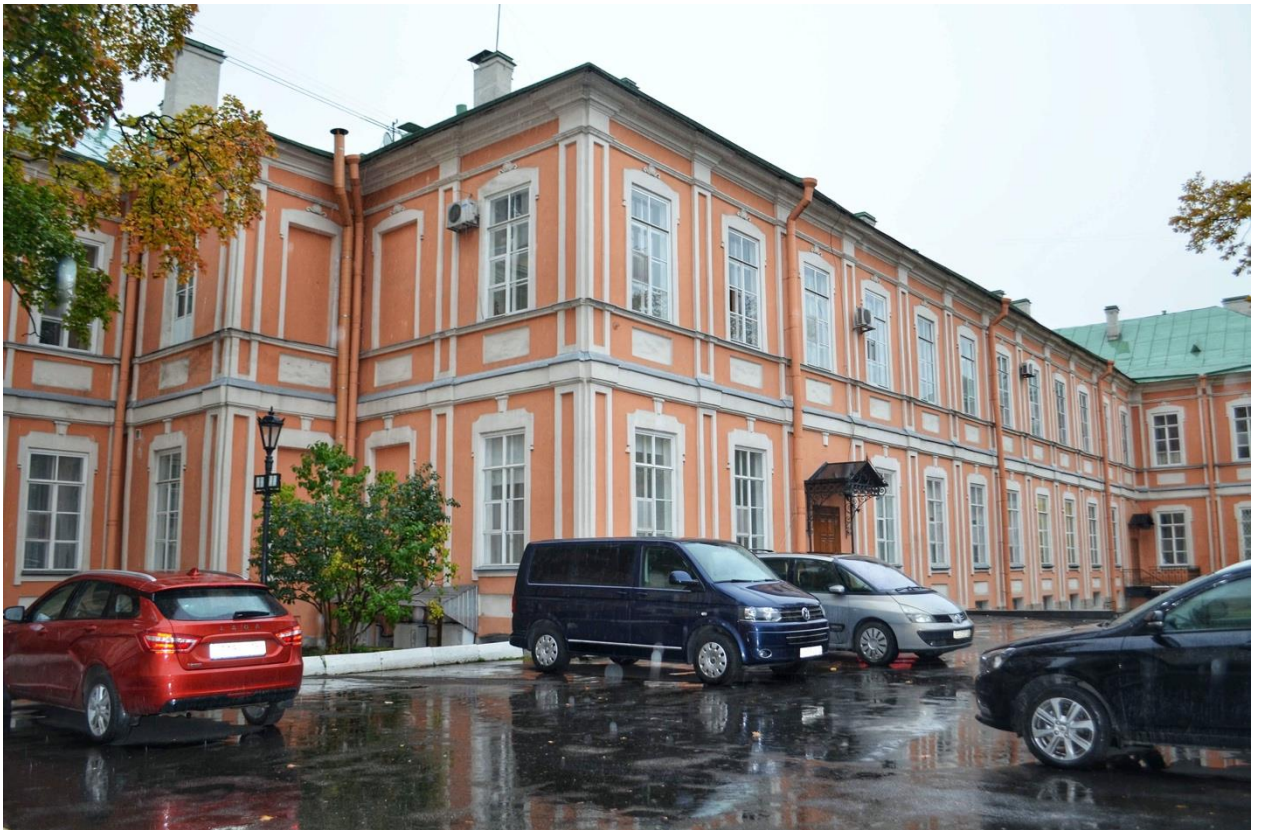
Фото 29. ОКН федерального значения «Корпус Духовской» (наб. реки Монастырки, дом 1, литера Д). Восточный фасад. Фрагмент. Съёмка 23.10.2020 г.
