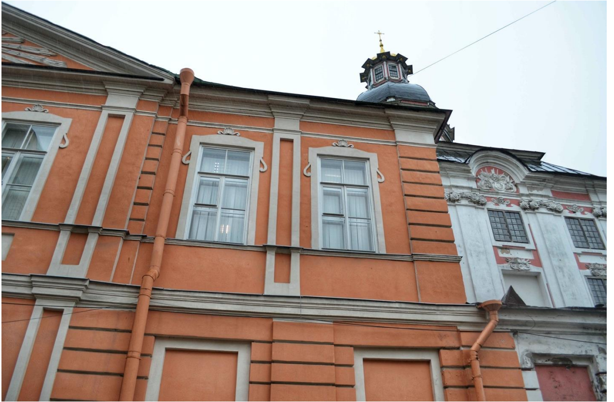
Фото 59. ОКН федерального значения «Корпус Духовской» (наб. реки Монастырки, дом 1, литера Д). Восточный фасад. Фрагмент. Съёмка 23.10.2020 г.
