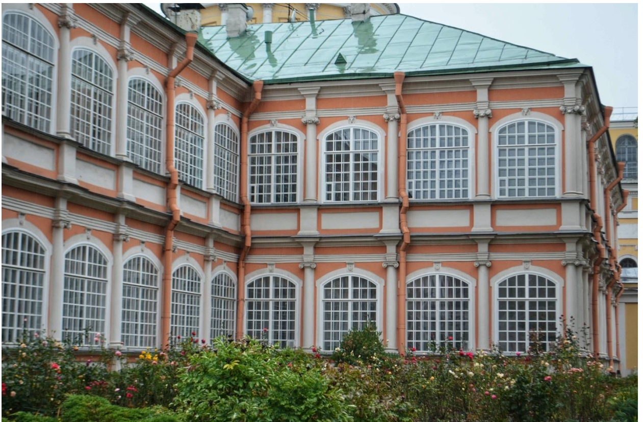
Фото 14. ОКН федерального значения «Корпус Духовской» (наб. реки Монастырки, дом 1, литера Д). Западный фасад. Фрагмент. Съемка 23.10.2020 г.
