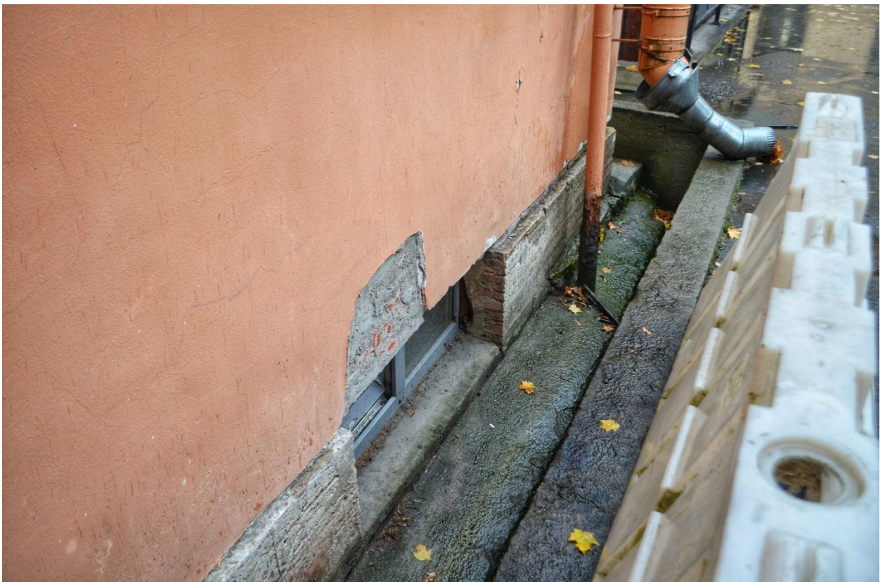
Фото 52. ОКН федерального значения «Корпус Духовской» (наб. реки Монастырки, дом 1, литера Д). Восточный фасад. Фрагмент. Съёмка 23.10.2020 г.
