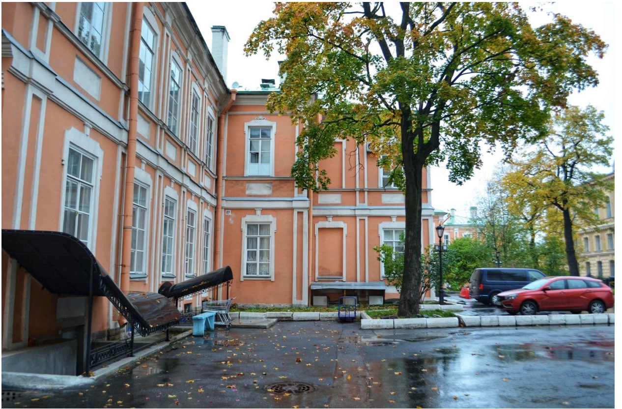
Фото 31. ОКН федерального значения «Корпус Духовской» (наб. реки Монастырки, дом 1, литера Д). Восточный фасад. Фрагмент. Съёмка 23.10.2020 г.
