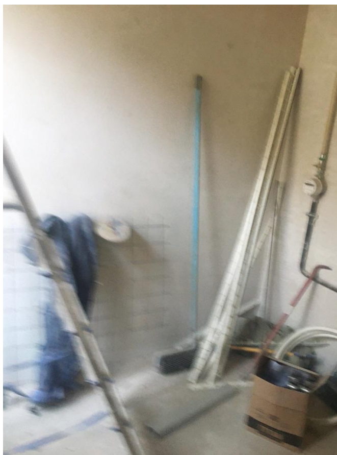
Илл. 7. Объект культурного наследия регионального значения «Дом П.Ф. Скрипицына», наб. Мойки, 30, кв. 2. Вид квартиры.
