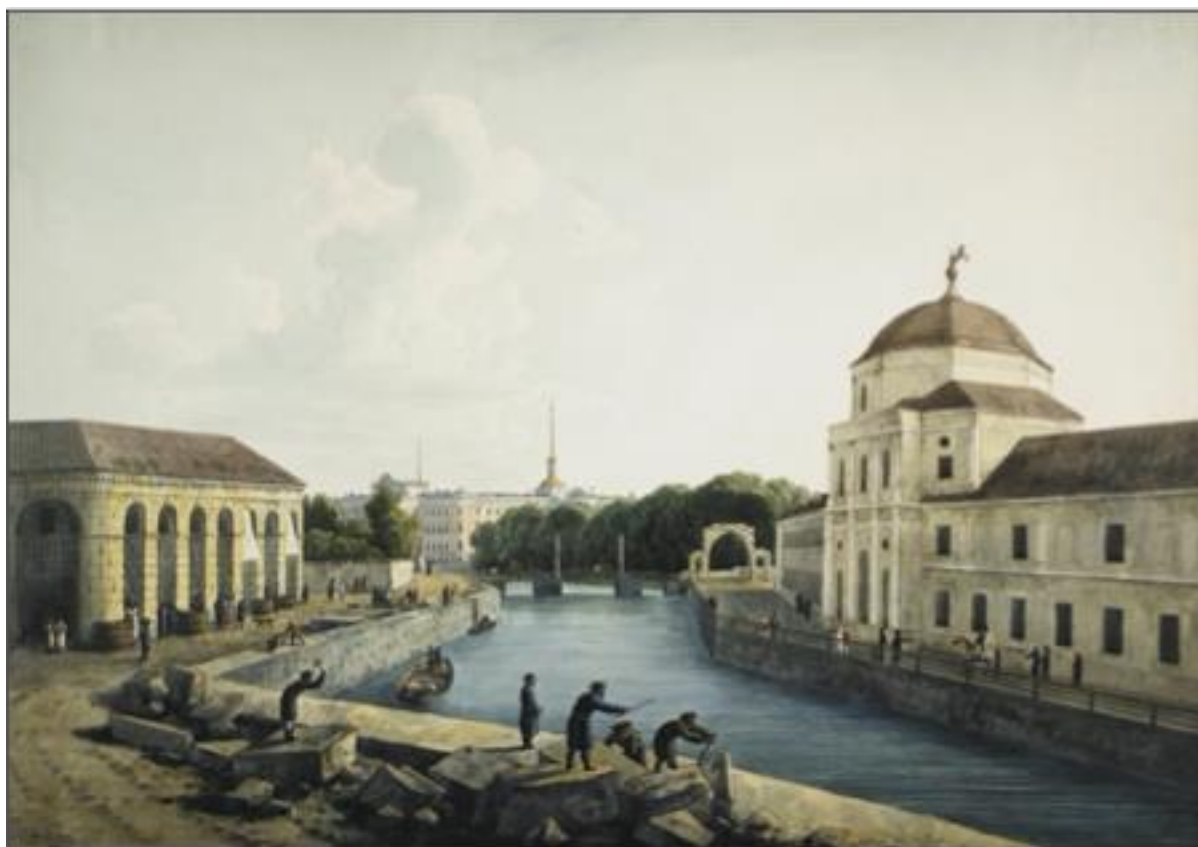
Илл. 7. Строительство набережных реки Мойки в 1800-х гг. Акварель А. Мартынова.
