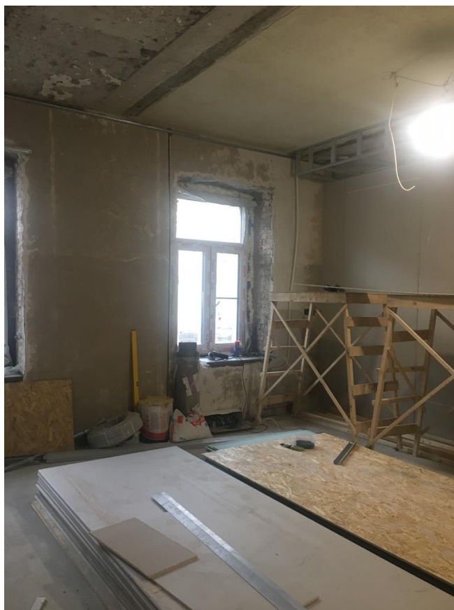
Илл. 11. Объект культурного наследия регионального значения «Дом П.Ф. Скрипицына», наб. Мойки, 30, кв. 2. Вид квартиры.
