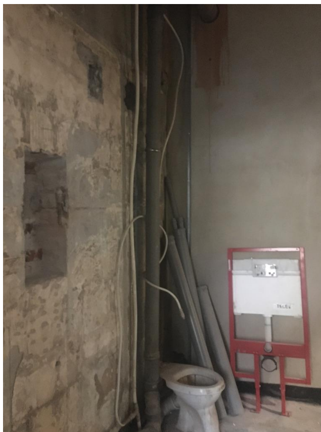
Илл. 8. Объект культурного наследия регионального значения «Дом П.Ф. Скрипицына», наб. Мойки, 30, кв. 2. Вид квартиры.
