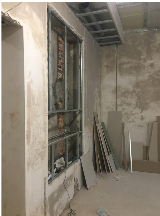
Илл. 9. Объект культурного наследия регионального значения «Дом П.Ф. Скрипицына», наб. Мойки, 30, кв. 2. Вид квартиры.
