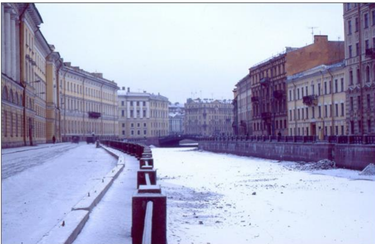
Илл. 12. Трехэтажный дом № 30 на набережной Мойки (на снимке – справа) после проведения работ по капитальному ремонту в 1984 году.
