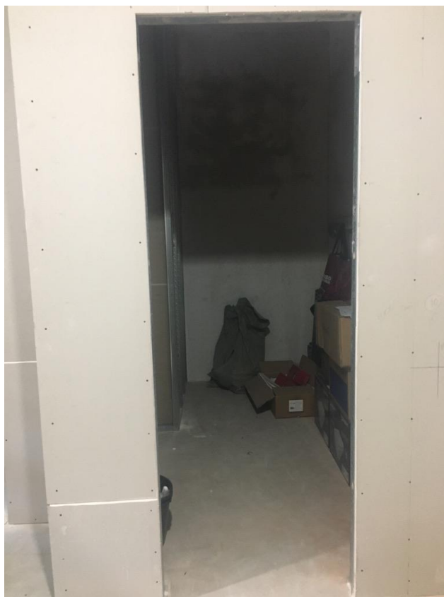
Илл. 15. Объект культурного наследия регионального значения «Дом П.Ф. Скрипицына», наб. Мойки, 30, кв. 2. Вид квартиры.
