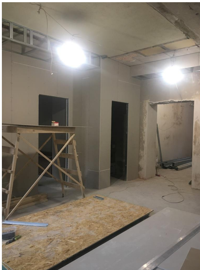
Илл. 12. Объект культурного наследия регионального значения «Дом П.Ф. Скрипицына», наб. Мойки, 30, кв. 2. Вид квартиры.
