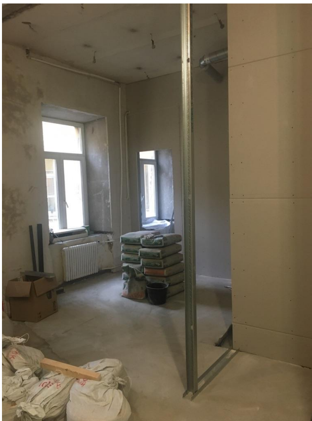
Илл. 4. Объект культурного наследия регионального значения «Дом П.Ф. Скрипицына», наб. Мойки, 30, кв. 2. Вид квартиры.
