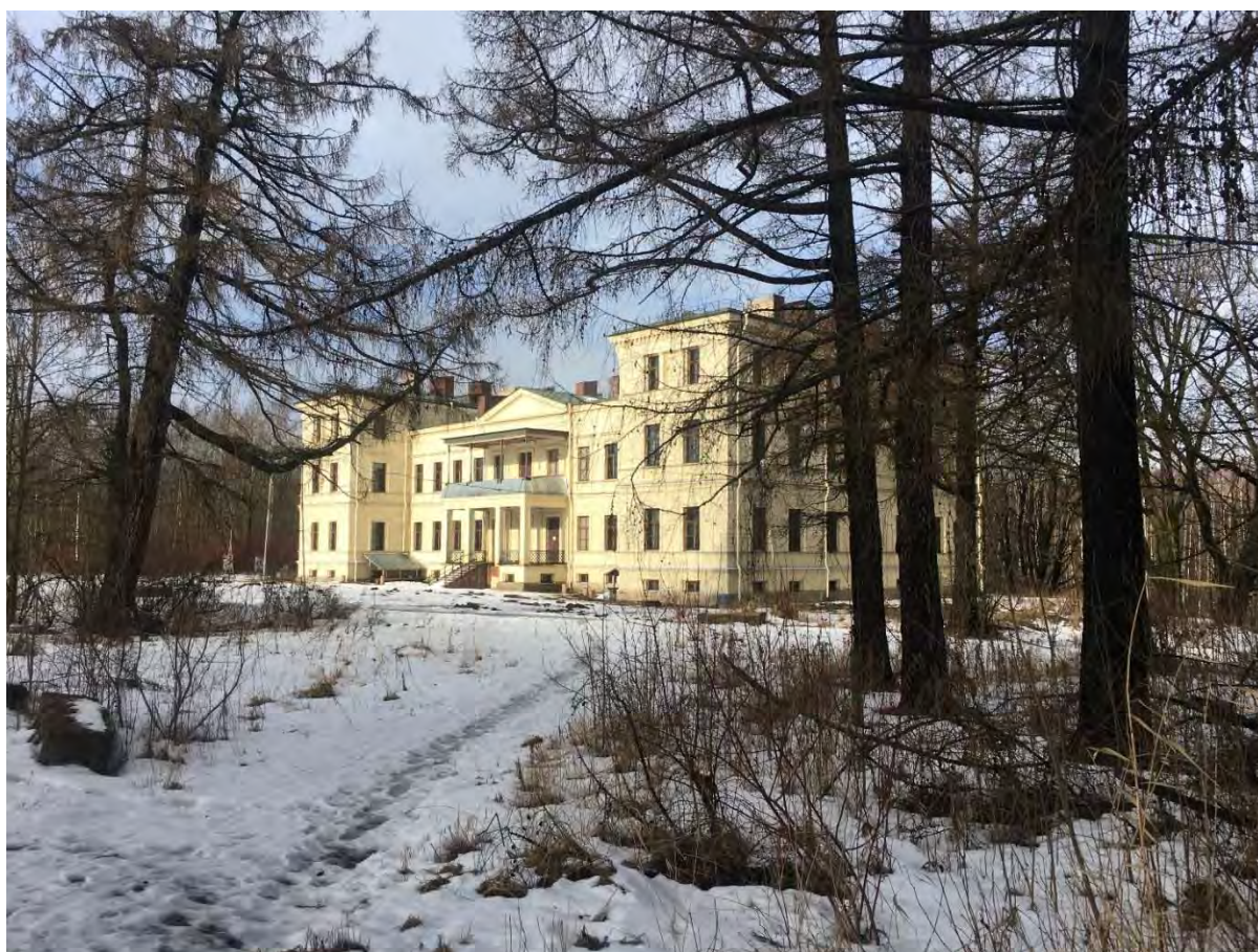
Фото №21. Вид Гофмейстерский корпус.
