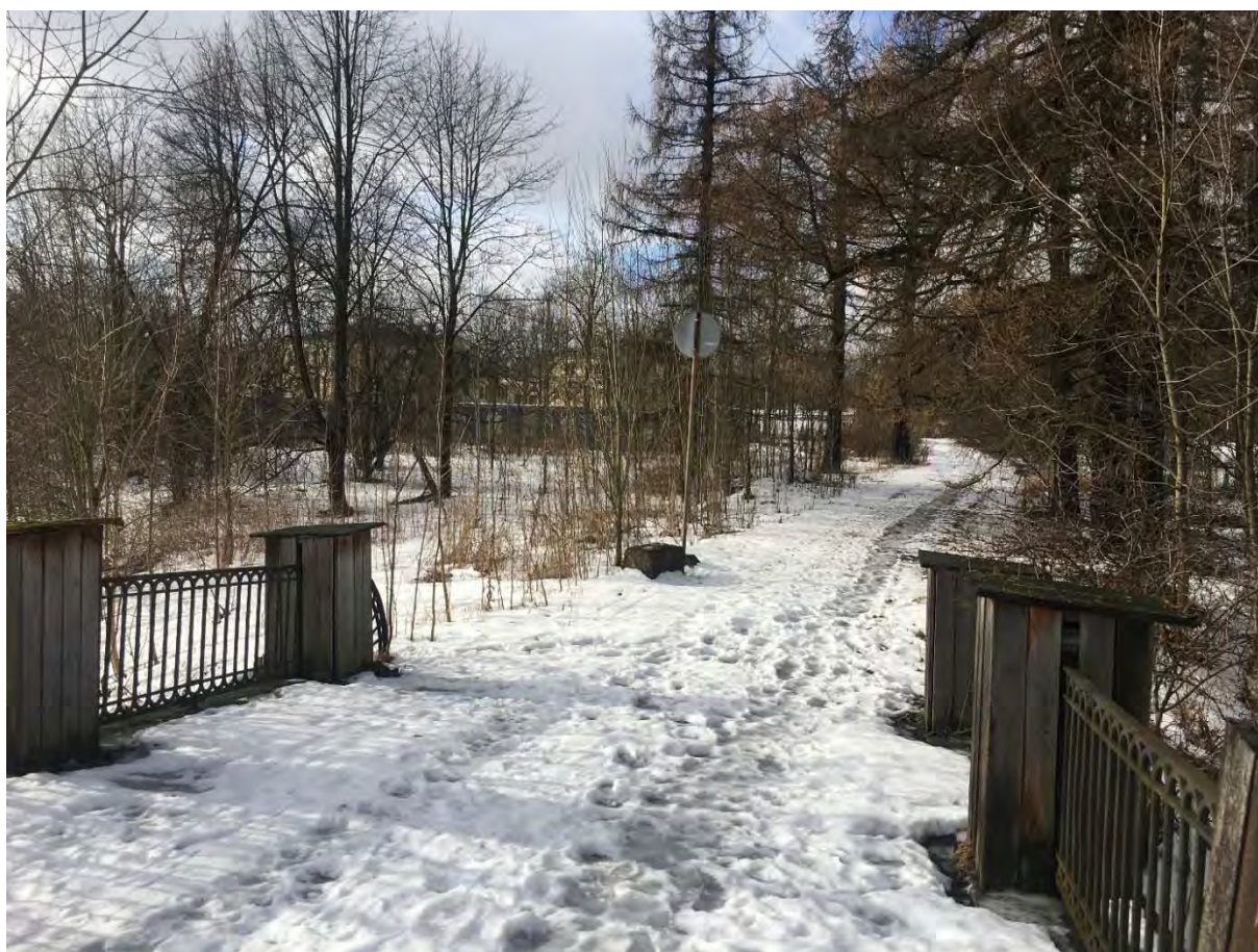
Фото №19. Мост-плотина на Оранжевом пруду, вид на дорогу к Гофмейстерскому корпусу.
