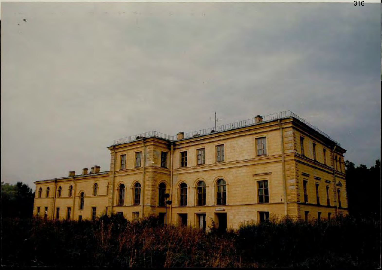
Дворцово-парковый ансамбль Михайловской дачи (Михайловск) XVIII в., 1834-1855; 1857-1864. Фото 42. Кухонный корпус. Южный фасад.
