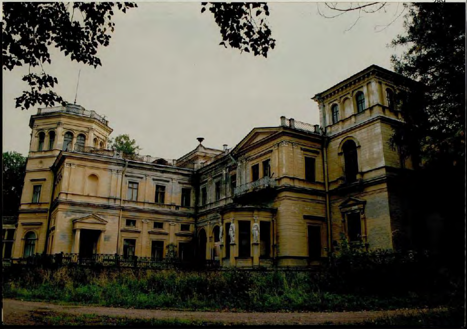
Санкт-петербургское шоссе, 109 Дворцово-парковый ансамбль Михайловской дачи (Михайловки) XVIII в., 1834-1855; 1857-1864. Фото 15. Большой дворец, Северо-западная часть. Справа — башня Парадной лестницы.
