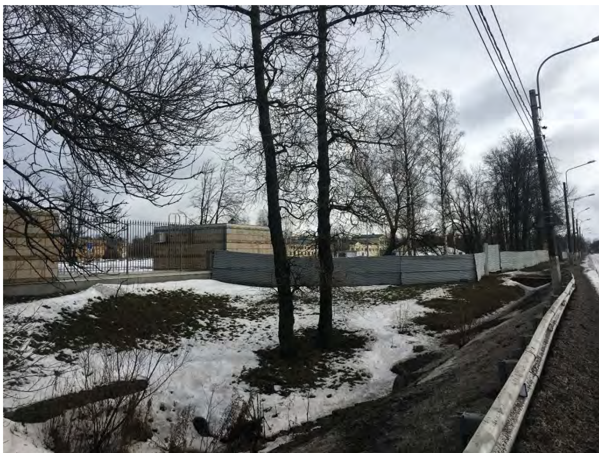
Фото №7. Фрагмент современной ограды СПбГУ вдоль Санкт-Петербургского шоссе, временное строительное ограждение.
