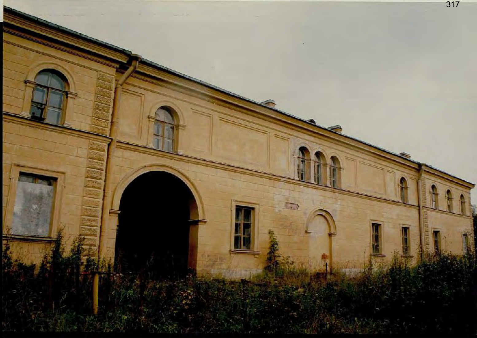
Дворцово-парковый ансамбль Михайловской дачи (Михайловки) XVIII в., 1834-1855 ; 1857-1864. Фото 43. Кухонный корпус. Западный фасад. Фото О.А.Шмелевой, 2004 г.
