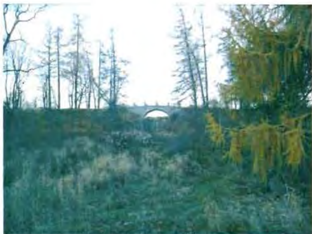
Мост-плотина. Вид от Нижней дороги. Фотография. 2015
