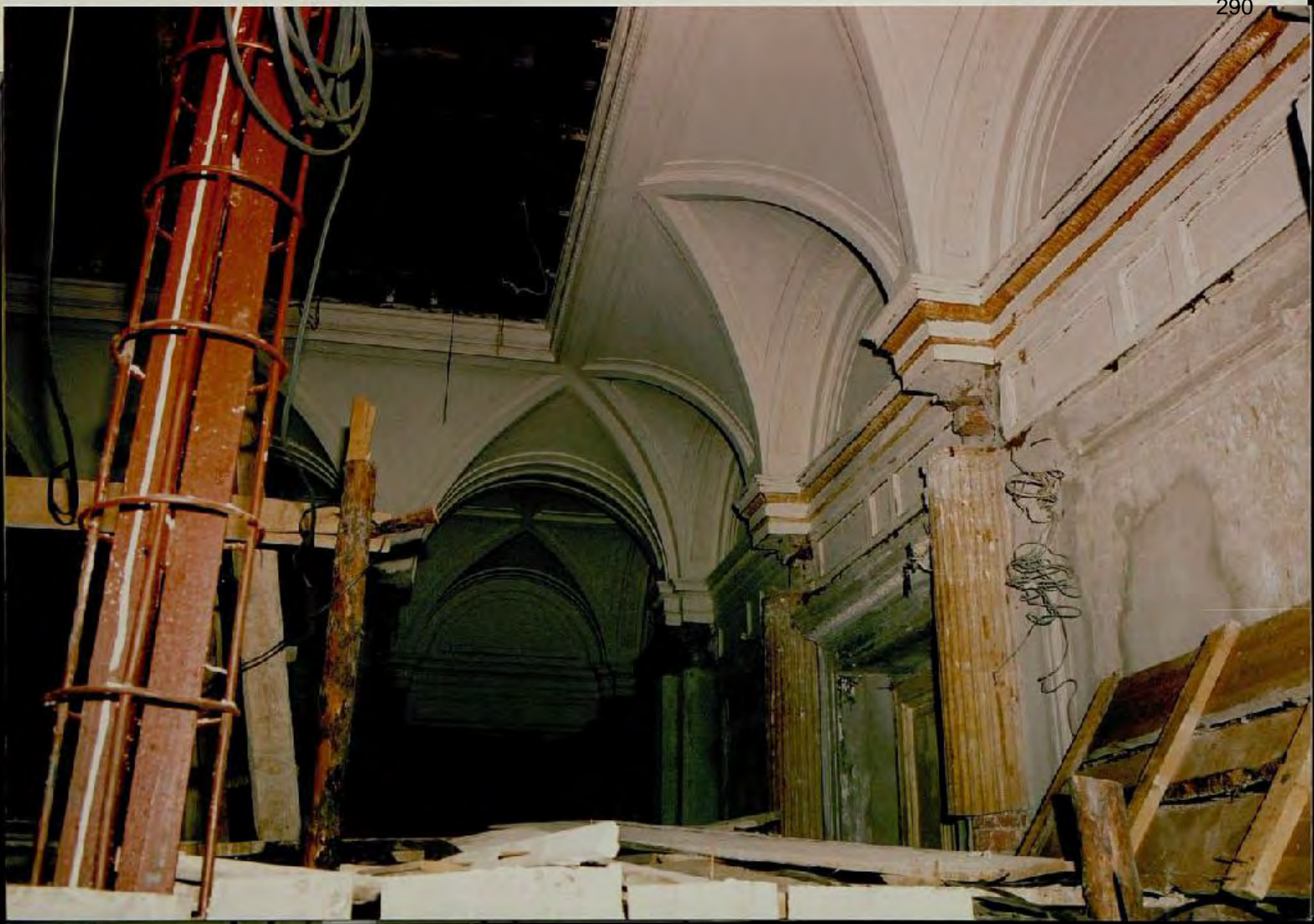
Санкт-Петербург, Россия, 2004 г. Дворцово-парковый ансамбль Михайловской дачи (Михайловка) XVIII в., 1834-1855; 1857-1864. Фото 16. Большой дворец, Парадный вестибюль. Верхняя часть стен и перекрытие. Вид с обходной галереи.
