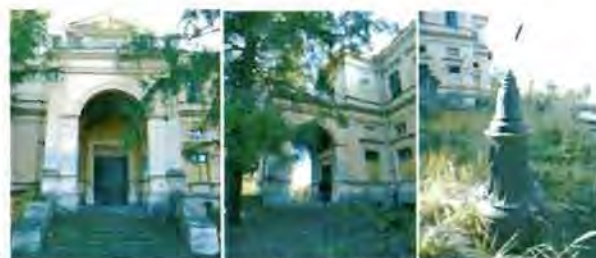
Главный подъезд Большого дворца. Тумба фонаря. Фотография, 2015
