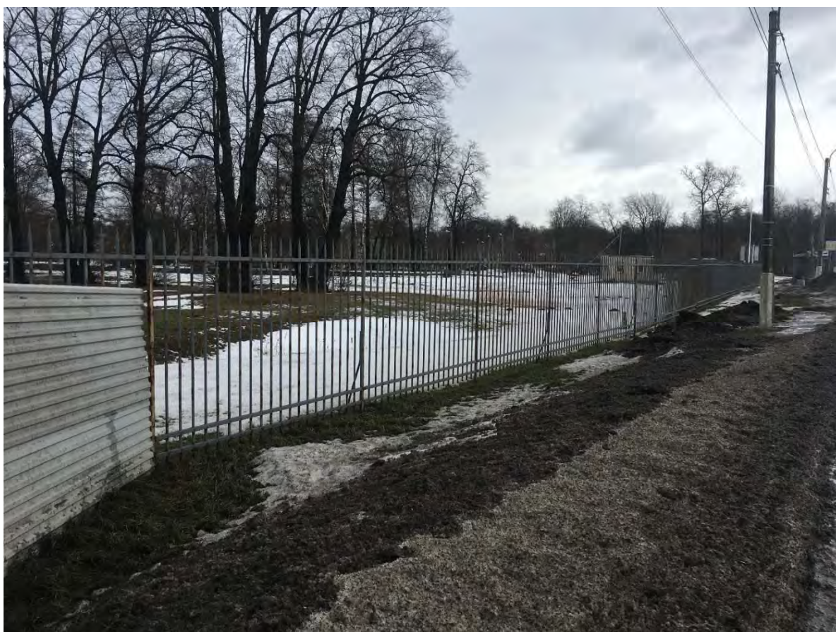
Фото №8. Восточная часть участка СПбГУ вдоль Санкт-Петербургского шоссе, временное строительное ограждение.
