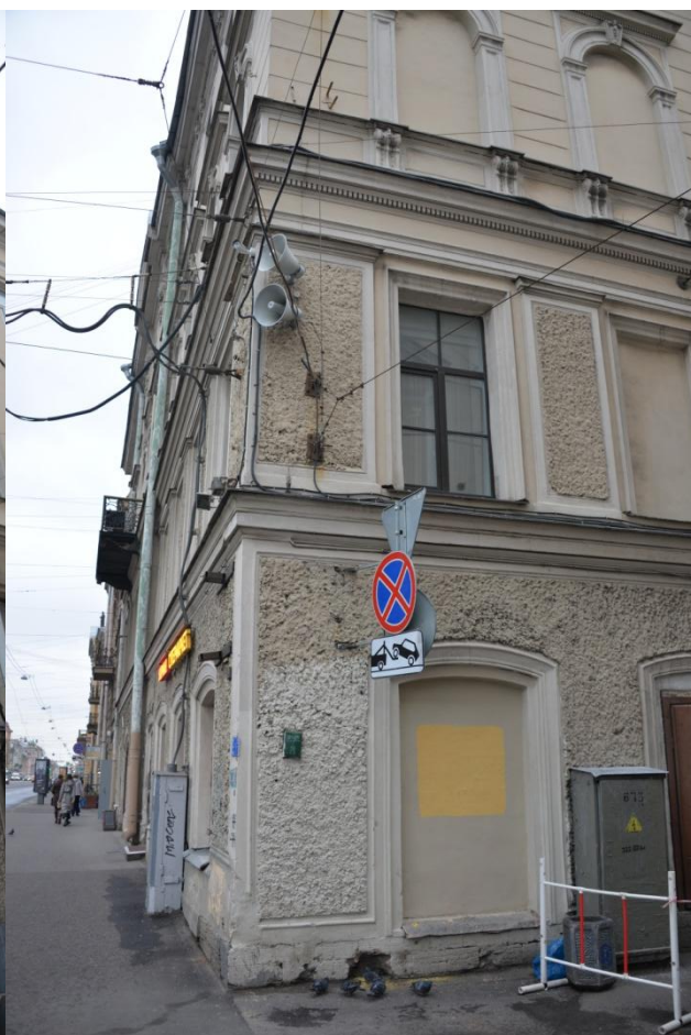
4. Фрагмент фасада объекта культурного наследия регионального значения «Дом, в котором жил в 1909-1915 гг. Маковский Константин Егорович»
