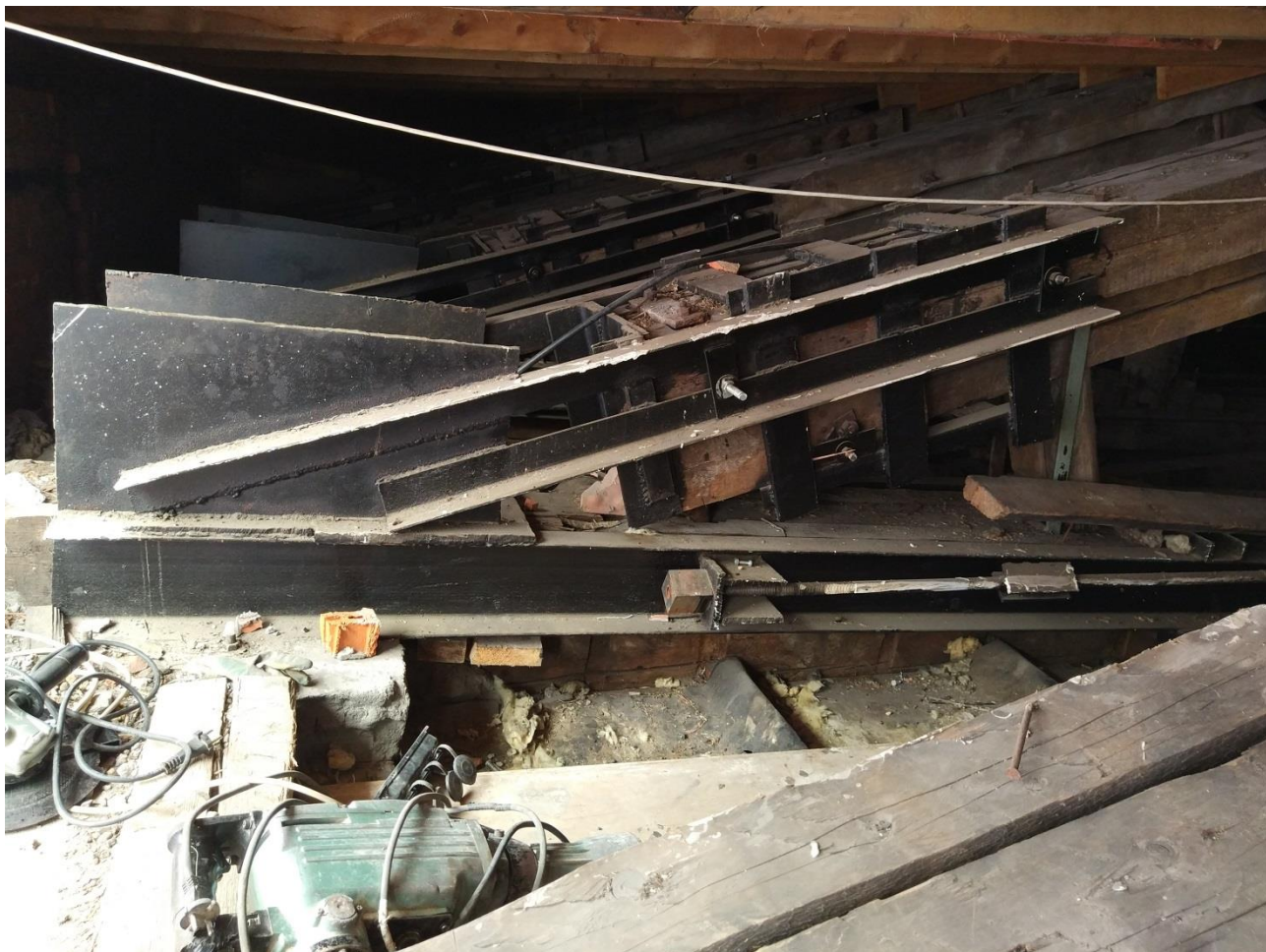
14. Выявленный объект культурного наследия «Дом Ш.З. Иоффа с кинематографом» по адресу: г.Санкт-Петербург, Лермонтовский проспект, дом 14, литера А Стропильные фермы покрытия Дата съемки: 02 ноября 2020 г.
