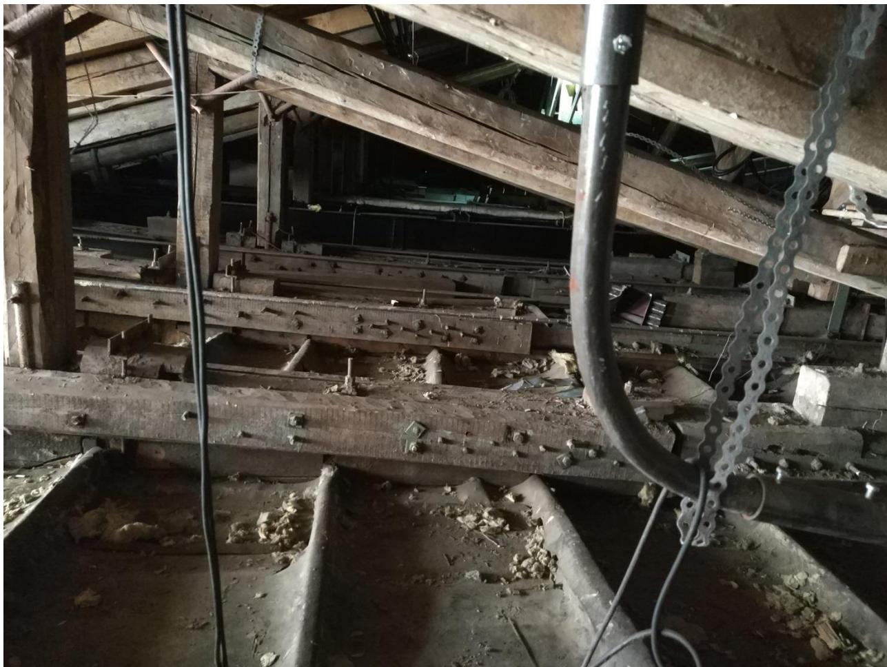
16. Выявленный объект культурного наследия «Дом Ш.З. Иоффа с кинематографом» по адресу: г.Санкт-Петербург, Лермонтовский проспект, дом 14, литера А Стропильные фермы покрытия Дата съемки: 02 ноября 2020 г.
