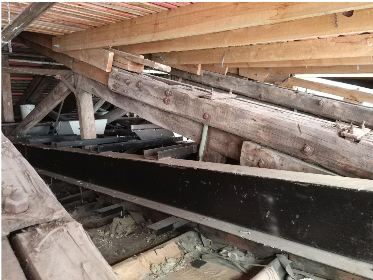
15. Выявленный объект культурного наследия «Дом Ш.З. Иоффа с кинематографом» по адресу: г.Санкт-Петербург, Лермонтовский проспект, дом 14, литера А Стропильные фермы покрытия Дата съемки: 02 ноября 2020 г.
