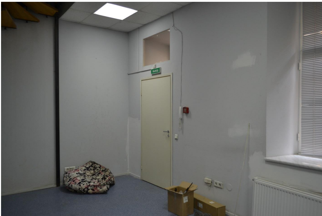
Фото 10. Часть помещения №5(комната). Общий вид второй выход (во двор-колодец).
