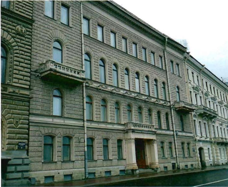
1, 2. Северо-западный фасад здания
