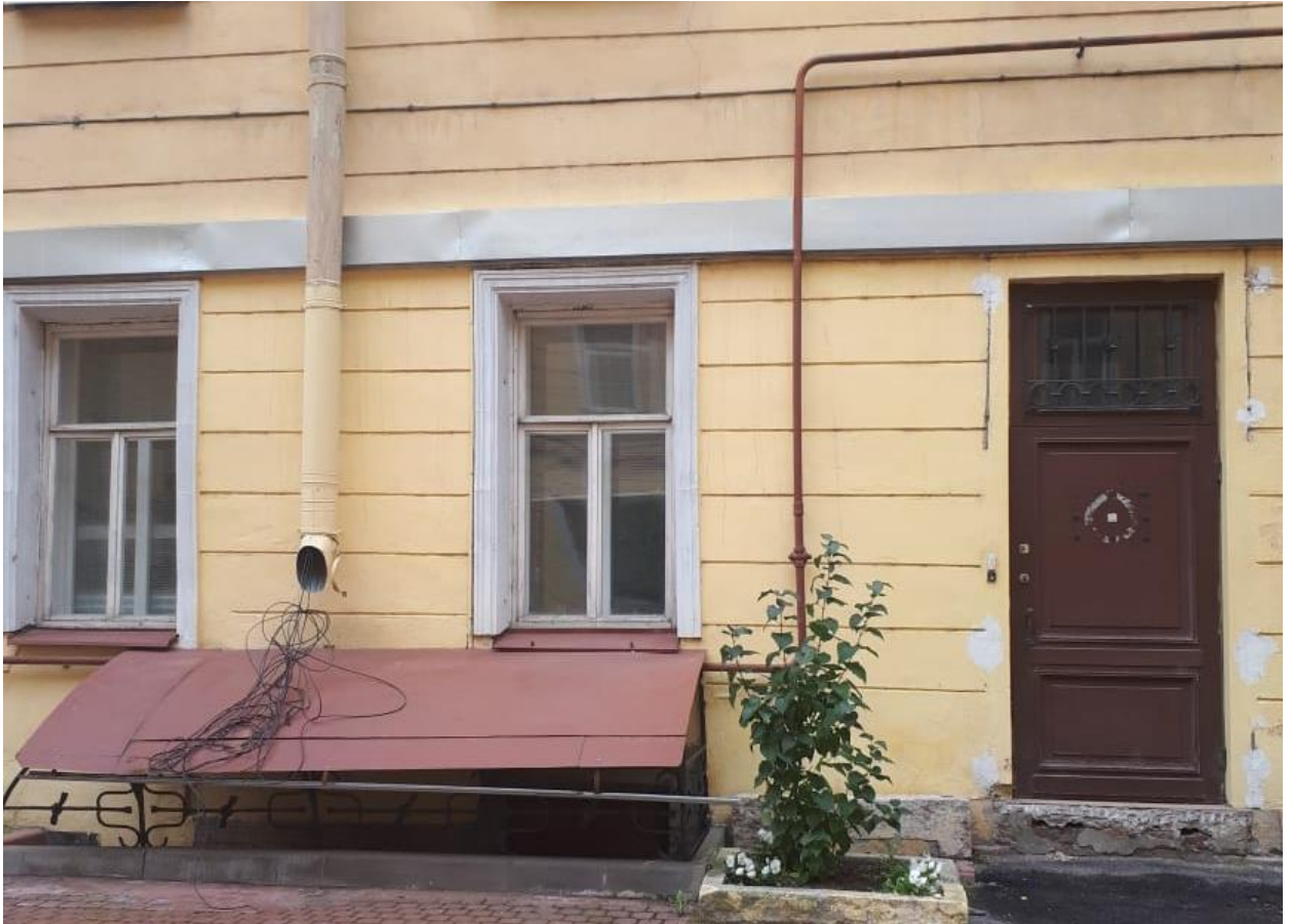
Фото 3. Дворовой северо-восточный фасад. Дверной проем в помещение №5. Вид с северо-востока.
