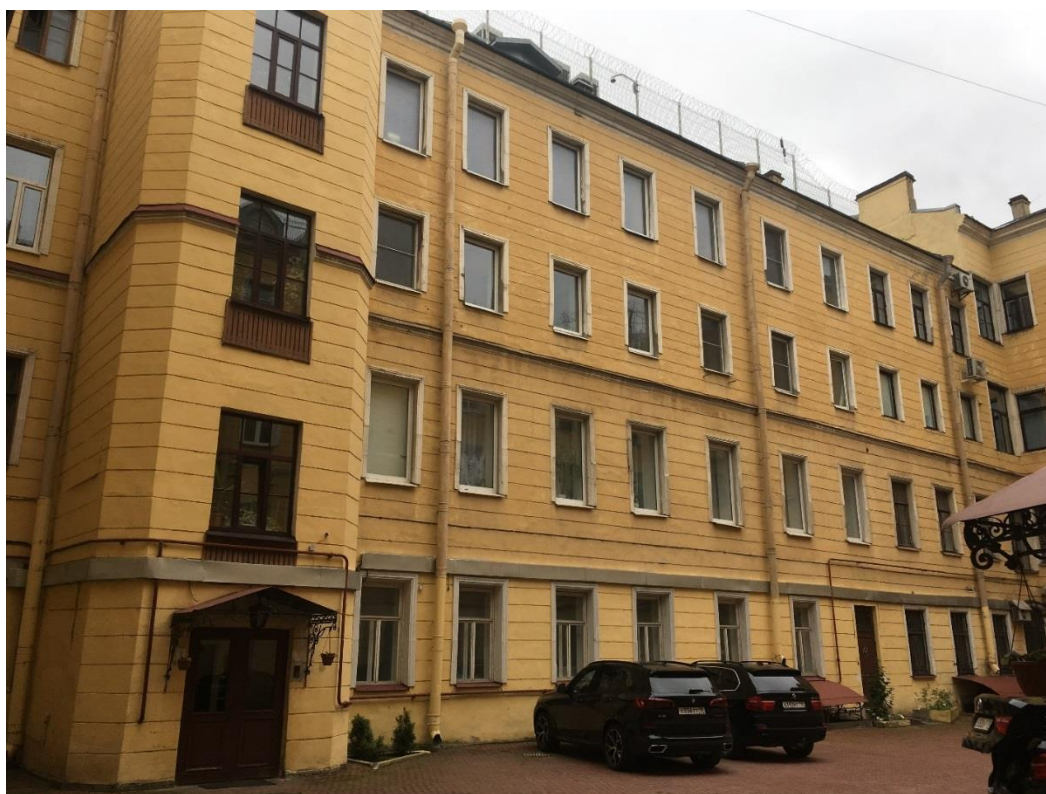
Фото 2. Дворовой северо-восточный фасад. Вид с юго-востока.
