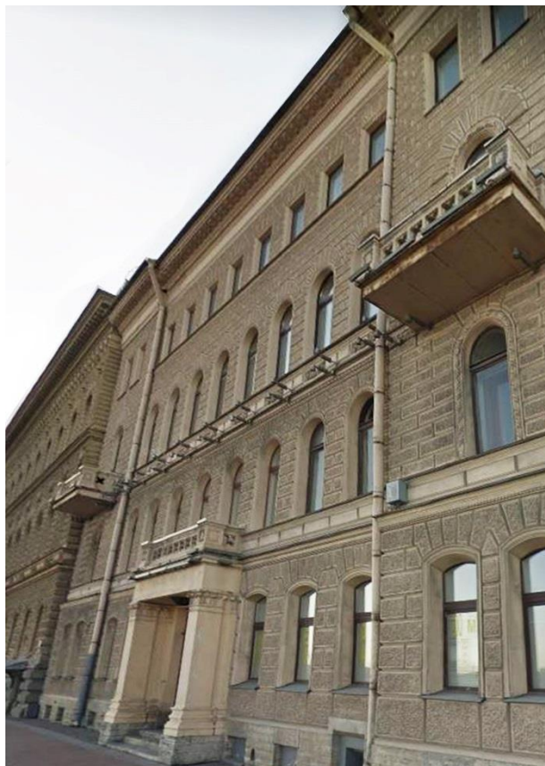
Фото 1. Лицевой фасад по Дворцовой набережной. Вид с северо-запада.
